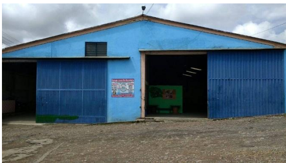
Imagen 3. Fachada de la institución
