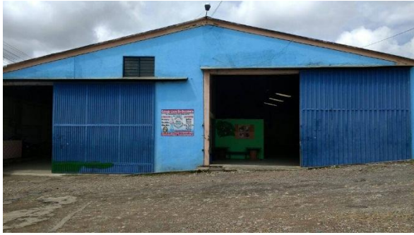
Imagen 19. Fachada de la institución
