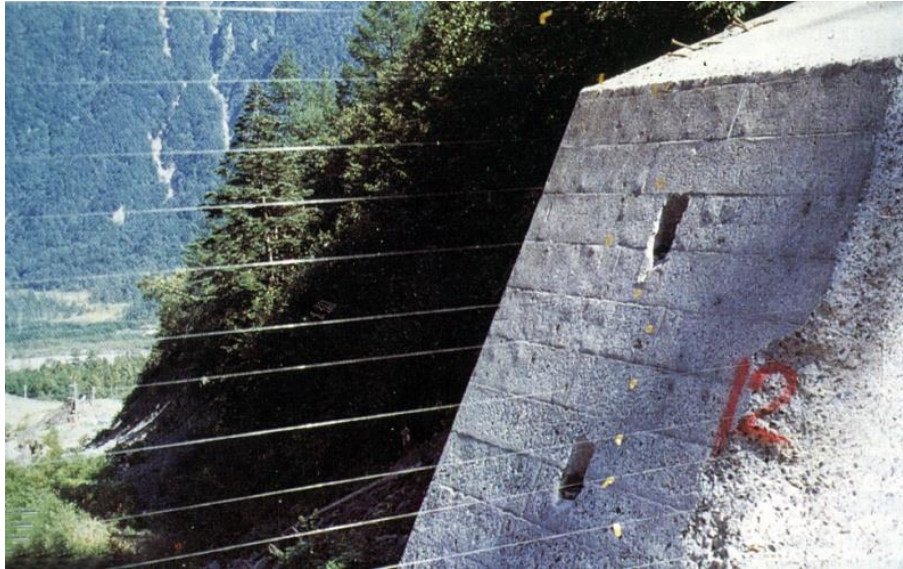
Figura 2.4. Sensores de alambre. Estos sensores pueden detectar la profundidad máxima de acuerdo con el nivel de la más alta de alambre que se ha roto [16].
