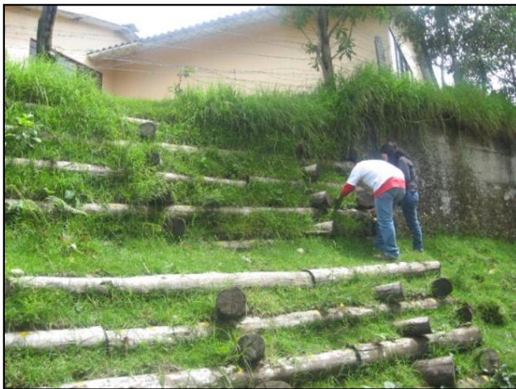
Figura 9. Imagen de la obra construida en San Juan.
