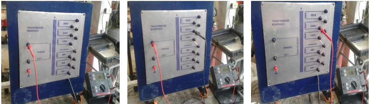
Figura 62. Resistencia de aislamientos en configuración A/T - A/B - B/T
