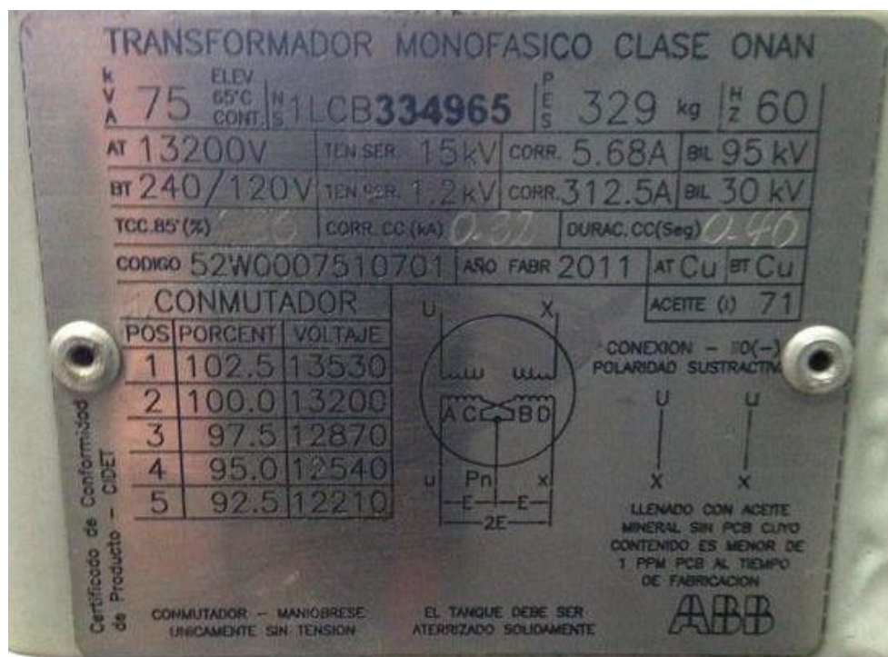
Figura 11. Placa de características de un transformador Monofásico[12]
