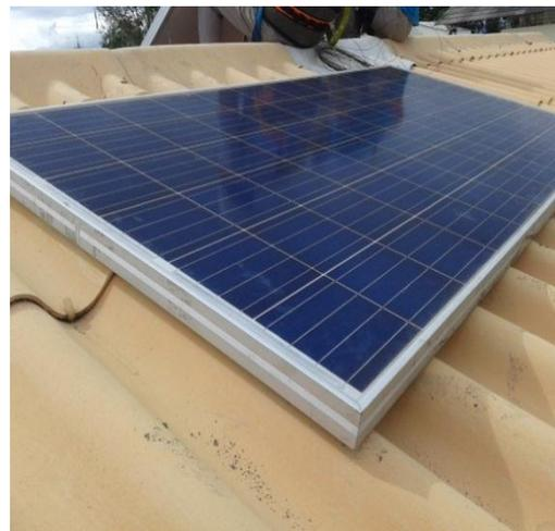
**Figura 4.3. . Módulo fotovoltaico CS6X-310P.**
