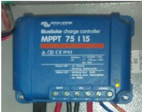
Figura 4.4. Regulador de carga digital PPPT.
