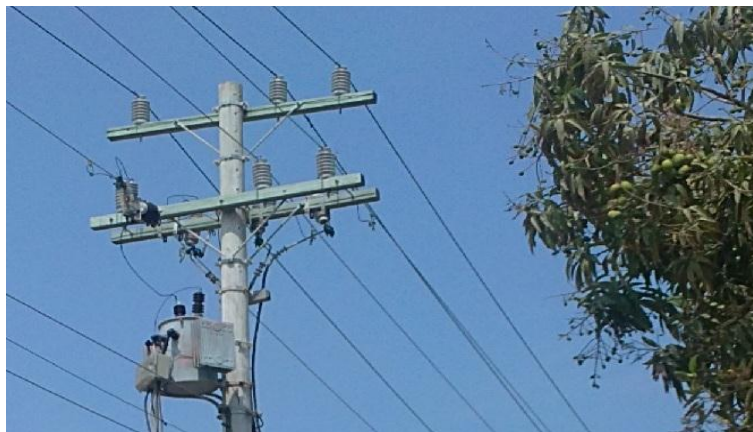
Figura 5. Cables desnudo aleación de aluminio AAAC
