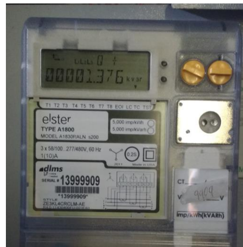
2.12 Figura Medidor A1800 ALPHA METER en funcionamiento
