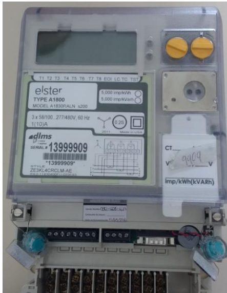
Figura 3.1. Medidor con perfil de carga A1800 ALPHA y TC's Instalados. Fuente: Technical Manual A1800 ALPHA
