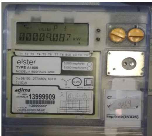
2.12 Figura Medidor A1800 ALPHA METER en funcionamiento
