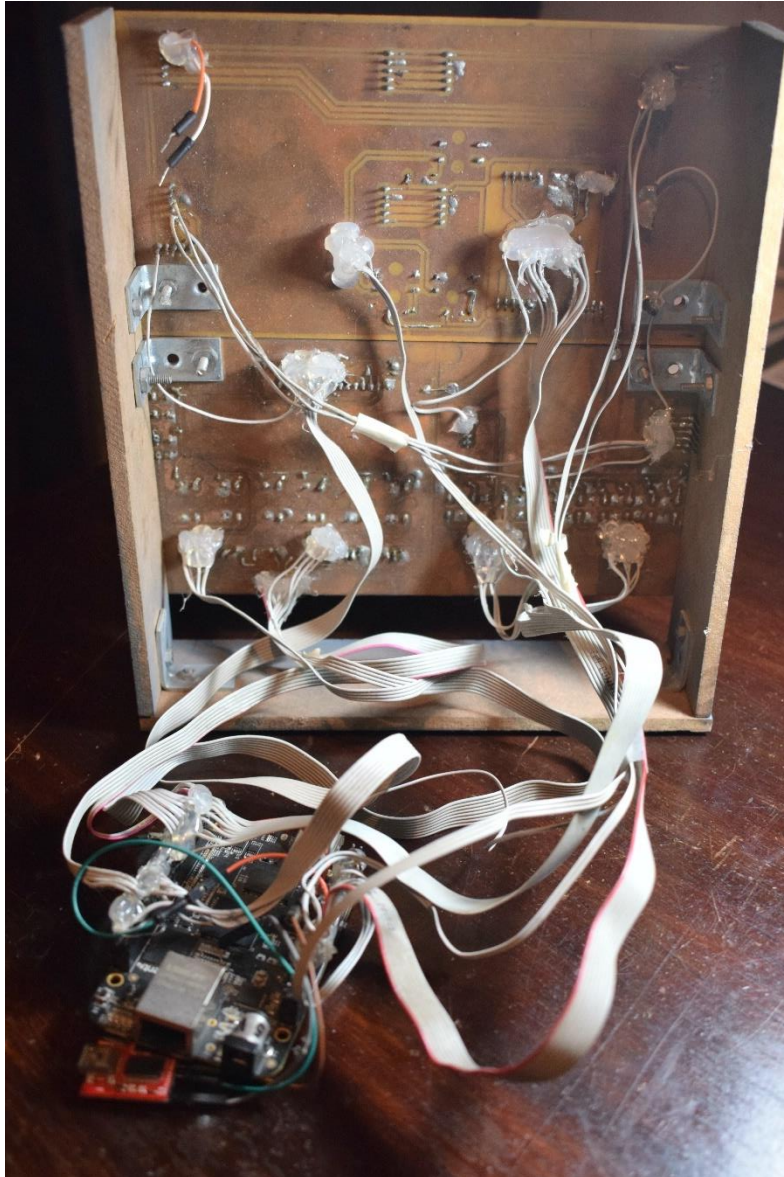
Figura 5.8 cableado del módulo de comunicaciones y la board de desarrollo beaglebone black.
