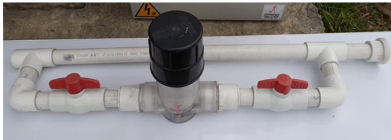
Figura 3.5: Sistema de cloración
