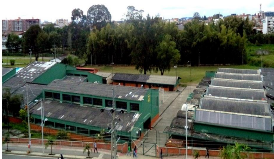
Figura 1. Instalaciones. Institución Educativa Técnico Industrial De Popayán.
