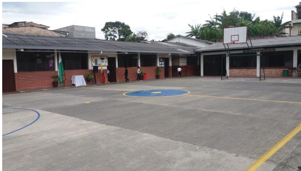
Fotografía 1 Aulas de la escuela sede Bellavista
