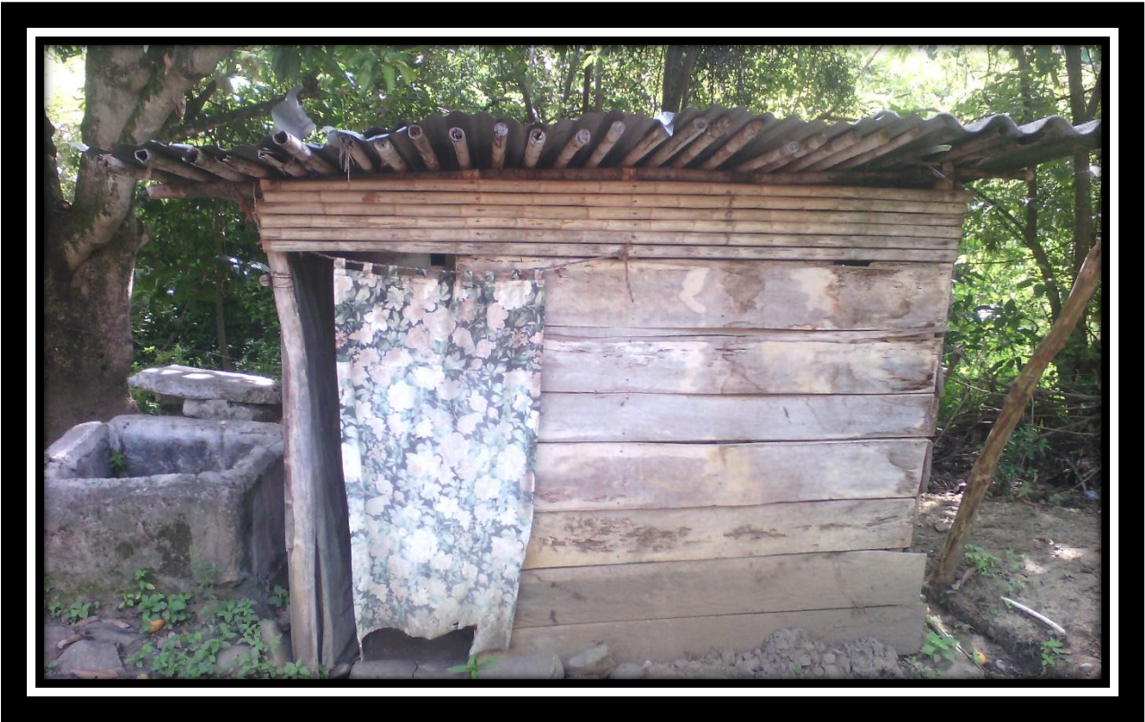
Ilustración 18 Unidad sanitaria vereda Lima
