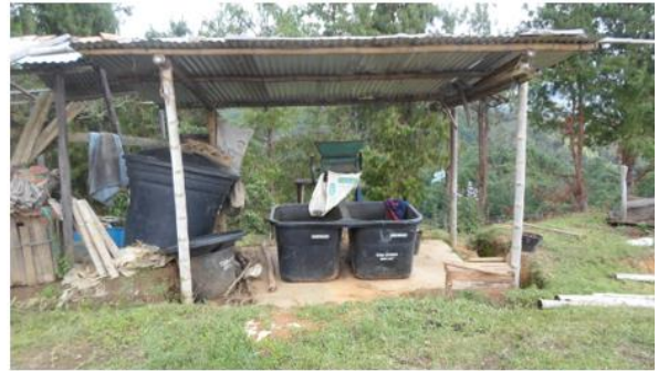
Estado general instalaciones beneficio del café
