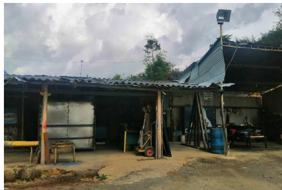
Ilustración 17. Zona de mantenimiento y mecánica
