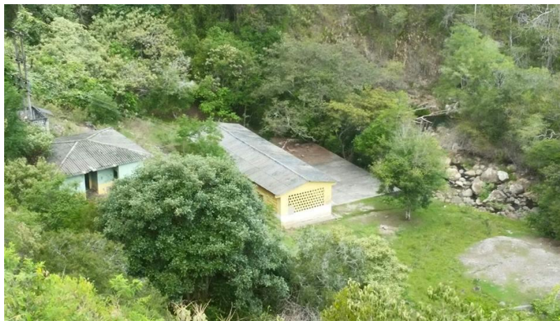
Figura 7. Antiguo acueducto de piedra rica
