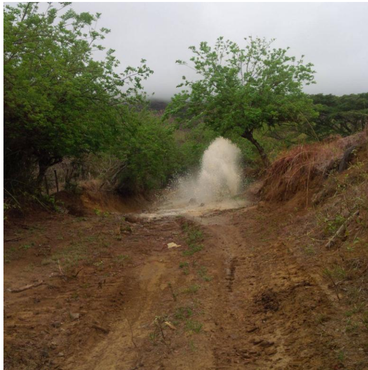
Fuga de agua en un tubo madre de conducción de agua hacia El Bordo.
