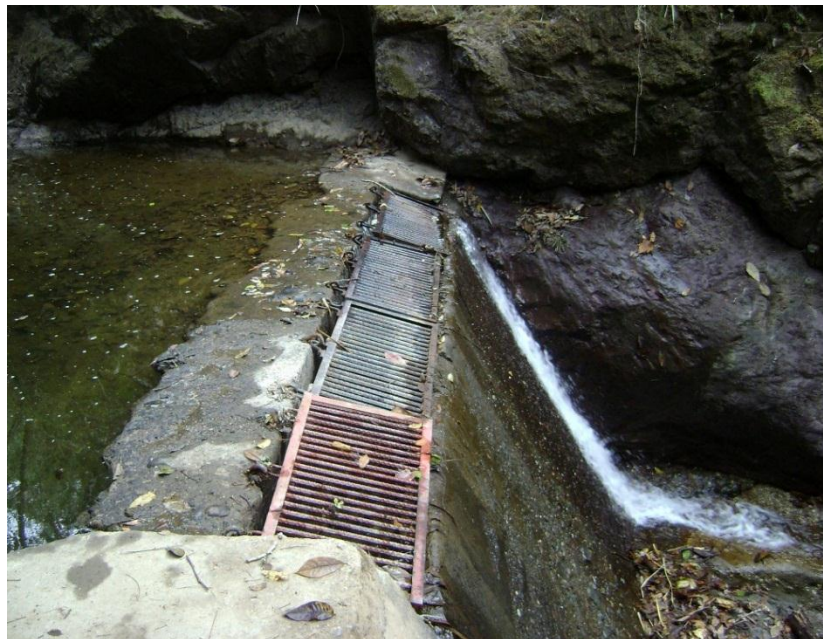
Bocatoma de la Quebrada de los Huevos.
