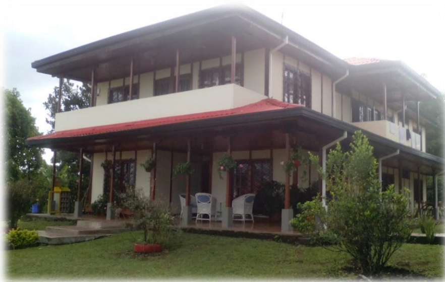
Instalación Hotelera- Villa Liliana.
