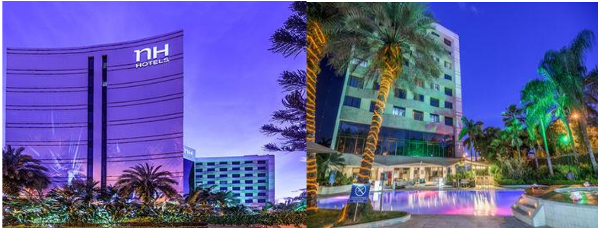
Ilustración 1: Vista Hotel NH Royal Cali
