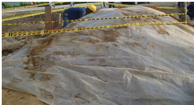
Figura 24. protección de material de préstamo al finalizar la jornada
