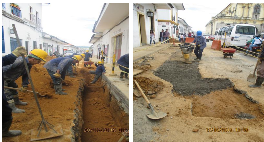
Fuente: Registro fotográfico del contratista
