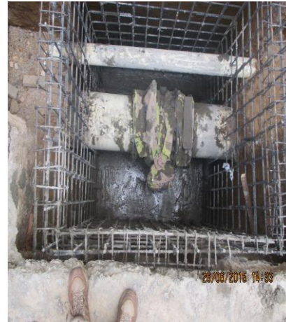
Figura 23. Concreto para cajas de válvulas mariposa de 20"
