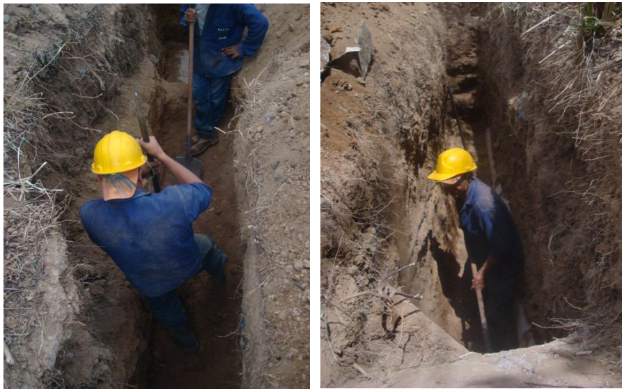
Figura 11. Excavacion de la zanja manualmente ( carrera 9 con calle 28N)
