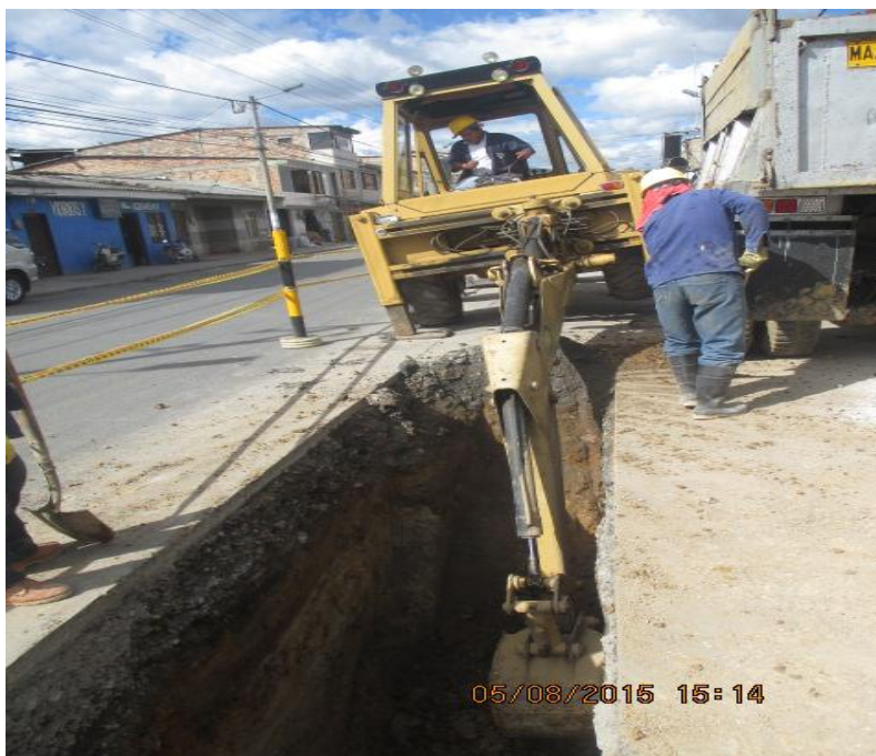
Figura 10. Excavacion de la zanja con maquina ( carrera 6 con calle 25N)
