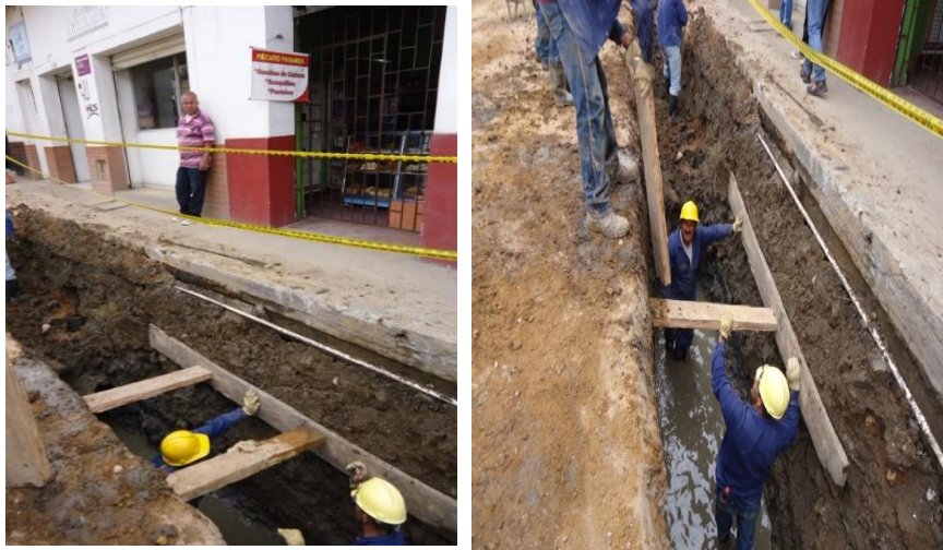
Figura 12. Entibación de la zanja
