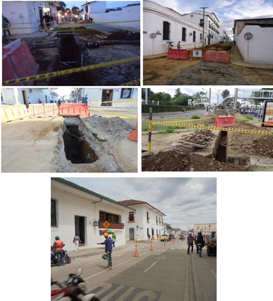
Figura 25. Señalización del sitio durante y después de la jornada
