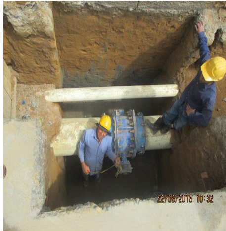
Figura 23. Concreto para cajas de válvulas mariposa de 20"
