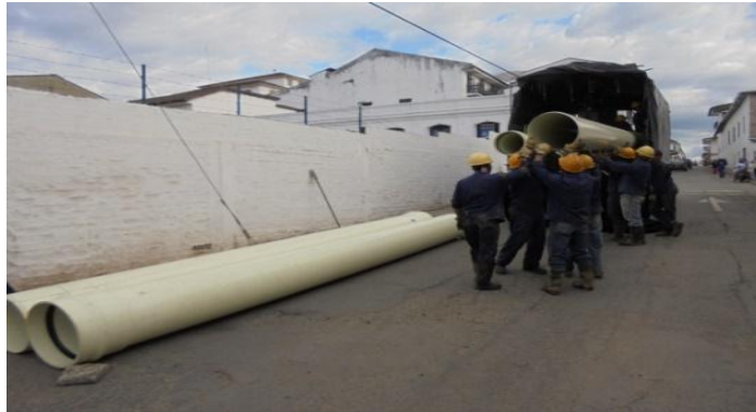
Fuente: Registro fotográfico del contratista
