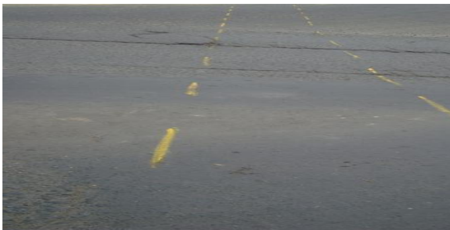
Figura 8. trazado de zanja a excavar Tramo 1 (carrera 6 con calle 25N)
