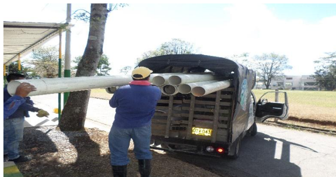
Figura 18. Transporte de tubería
