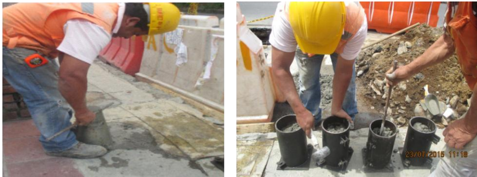
Figura 22. Toma de muestras y ensayos in-situ del concreto
