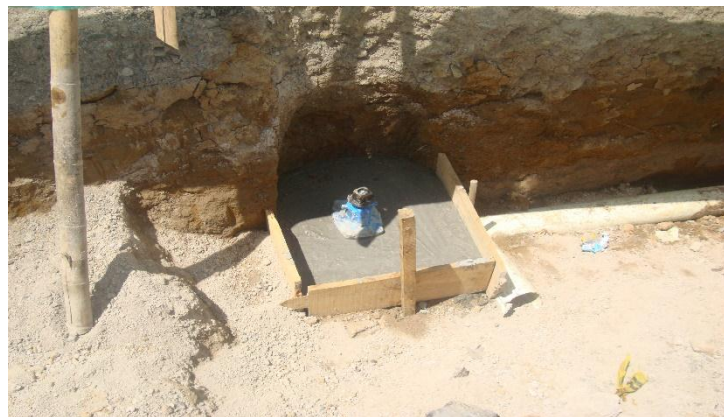
Figura 20. Anclajes para Accesorios
