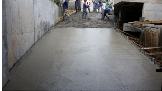
Figura No 69 FUNDICION RAMPA
