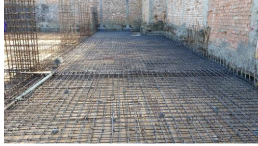
Figura No 58 ACERO LOSA MACIZA
