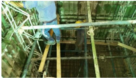
Figura No 75 ENCOFRADO DEL TANQUE DE ALMACENAMIENTO
