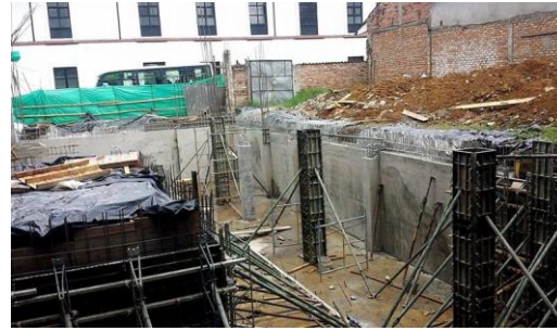
Figura No 27 MURO DE CONTENCIÓN TERMINADO
