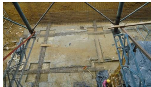
Figura No 19. SOLADO DE LIMPIEZA
