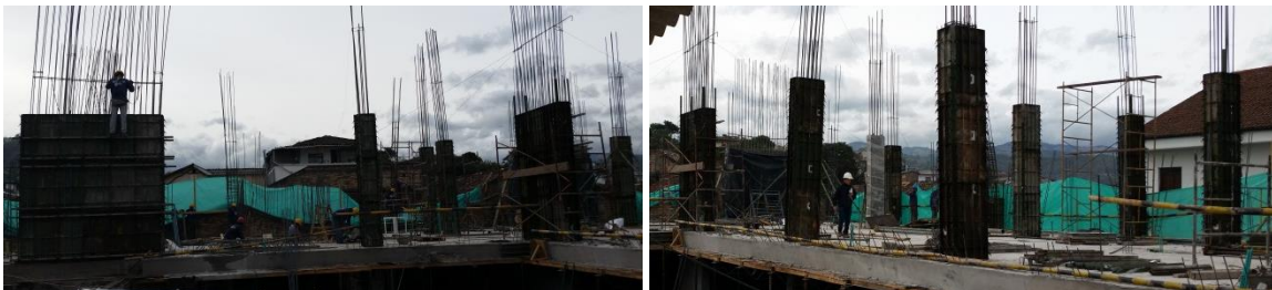
Figura No 49 FORMALETA INSTALADA
