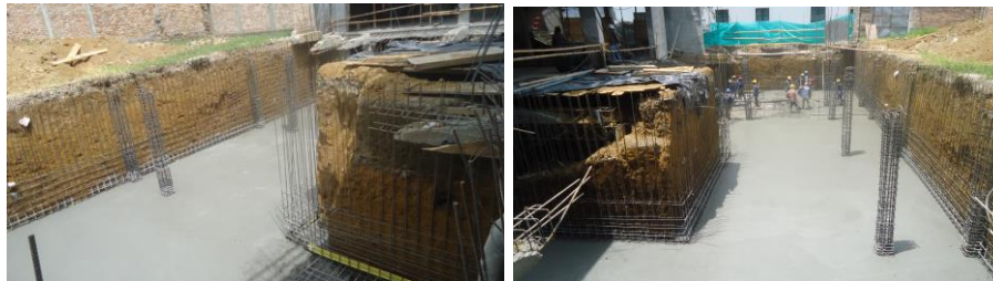
Figura No 24. ACABADO LOSA DE CIMENTACIÓN
