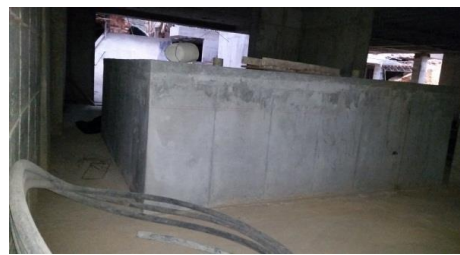
Figura No78 TANQUE TERMINADO
