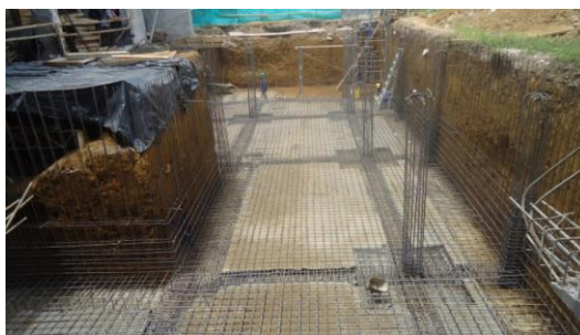
Figura No 22. INSTALACION DE ACERO DE CIMENTACION TERMINADA
