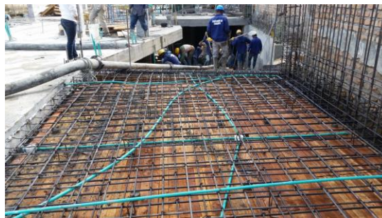
Figura No 67 COLOCACIÓN REFUERZO
