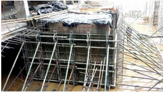
Figura No. 26 FORMAleta MUROS DE CONTENCIÓN
