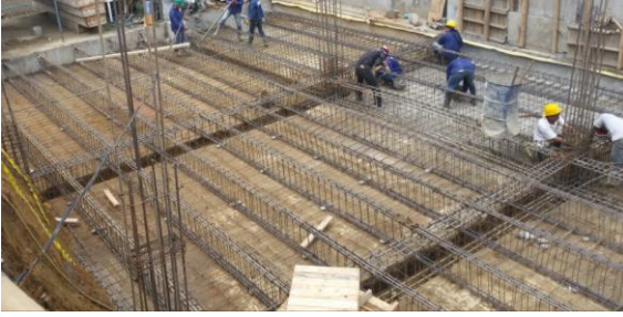
Figura No 57 ACERO LOSA ALIGERADA
