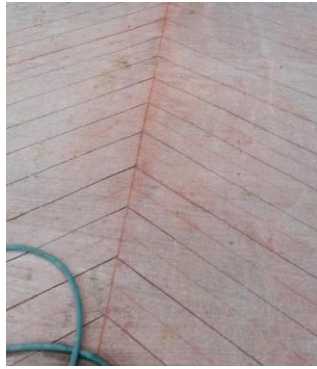
Figura No 72 CORTE CON PULIDORA.
