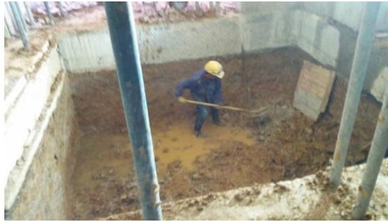
Figura No 74 EXCAVACION MANUAL DEL TANQUE DE ALMACENAMIENTO.
