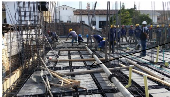
Figura No 61 TRANSPORTE DEL CONCRETO
