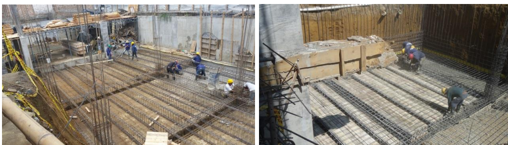
Figura No 21. INSTALACION DE NERVIOS EN LA LOSA ALIGERADA
