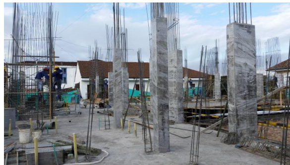
Figura No 9. CURADO CON PLASTICO
