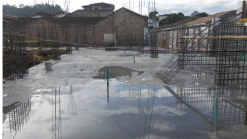
Figura No 64 CURADO DEL CONCRETO
