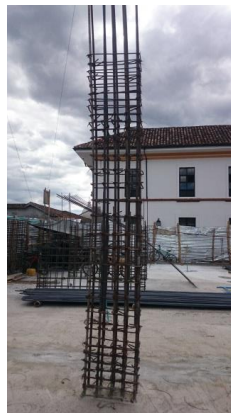
Figura No 47 COLOCACIÓN DE ACERO DE COLUMNA
