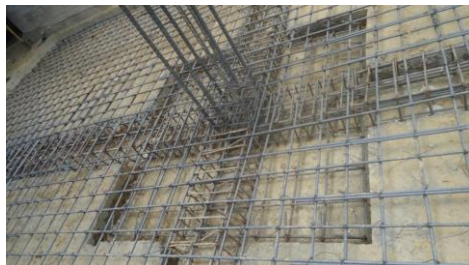
Figura No 20 . ACERO DE ZAPATAS, COLUMNAS, VIGAS Y LOSA MACIZA DE CIMENTACION
