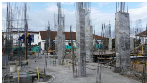
Figura No 52 COLUMNAS FUNDIDAS Y DESENCOFRADAS
