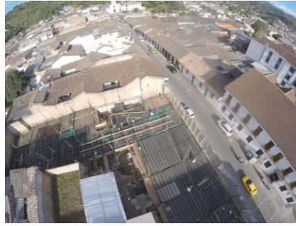
Figura No 62 LOSA DE ENTREPISO LISTO PARA FUNDIR
