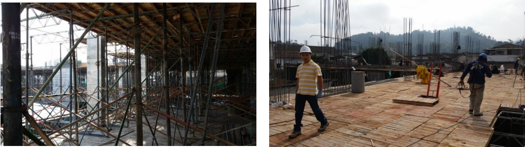
Figura No 55 ENCOFRADO LOSA DE ENTREPISO
