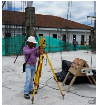
Figura No 48 VERIFICACION DE ALINEAMIENTOS
