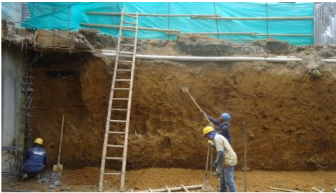
Figura No 18. PERFILADO DEL TERRENO
