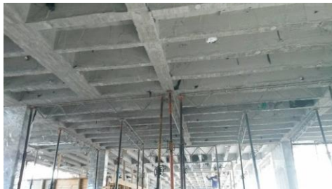
Figura No 65 APOYO DE LA LOSA DESPUES DE SER DESENCOFRADA.
