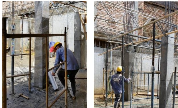
Figura No 51 CURADO CON PLÁSTICO Y AGUA
