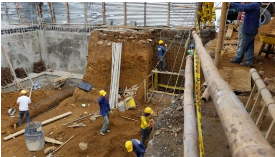
Figura No 11. EXCAVACION Y FUNDICION POR TRAMOS
