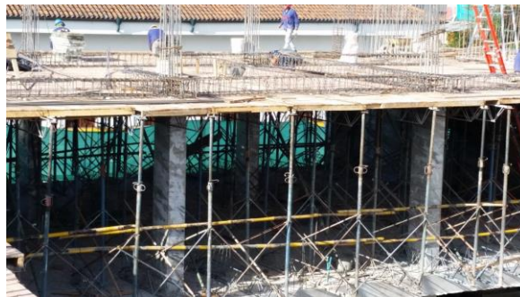
Figura No 56 ENCOFRADO LOSA DE ENTREPISO
