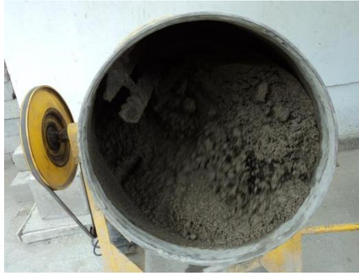
Figura 14. Mezcla de materiales para mezcla de diseño de concreto  $f'_c = 26$  MPa
