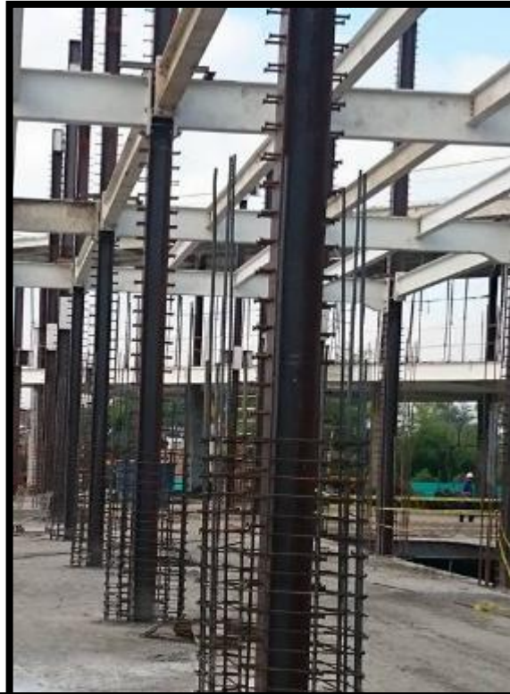
Figura 36. Reforzamiento de la estructura metálica, con barras longitudinales, amarradas con acero transversal
