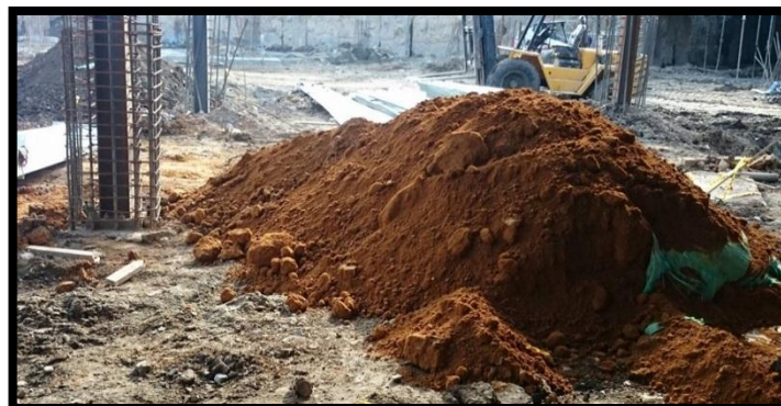
Figura 11. Material de relleno
