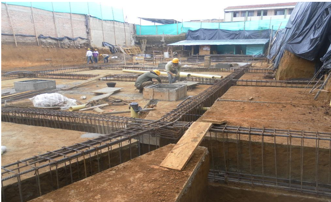
Figura 31.0 Acero de vigas de cimentación instalado en el sitio.
