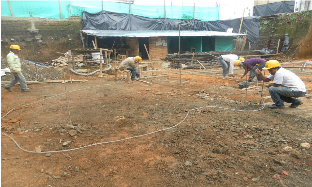
Figura 15.0 Ayudantes en actividad de localización y nivelación de fondo.
