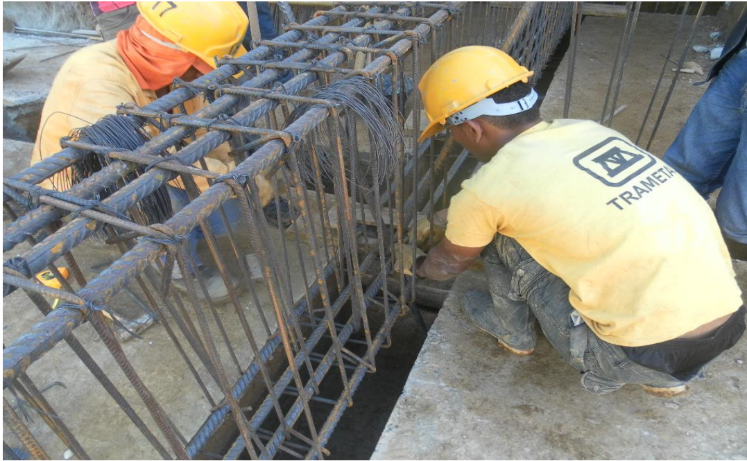
Figura 30.0 Ayudantes amarrando acero de viga de cimentación.
