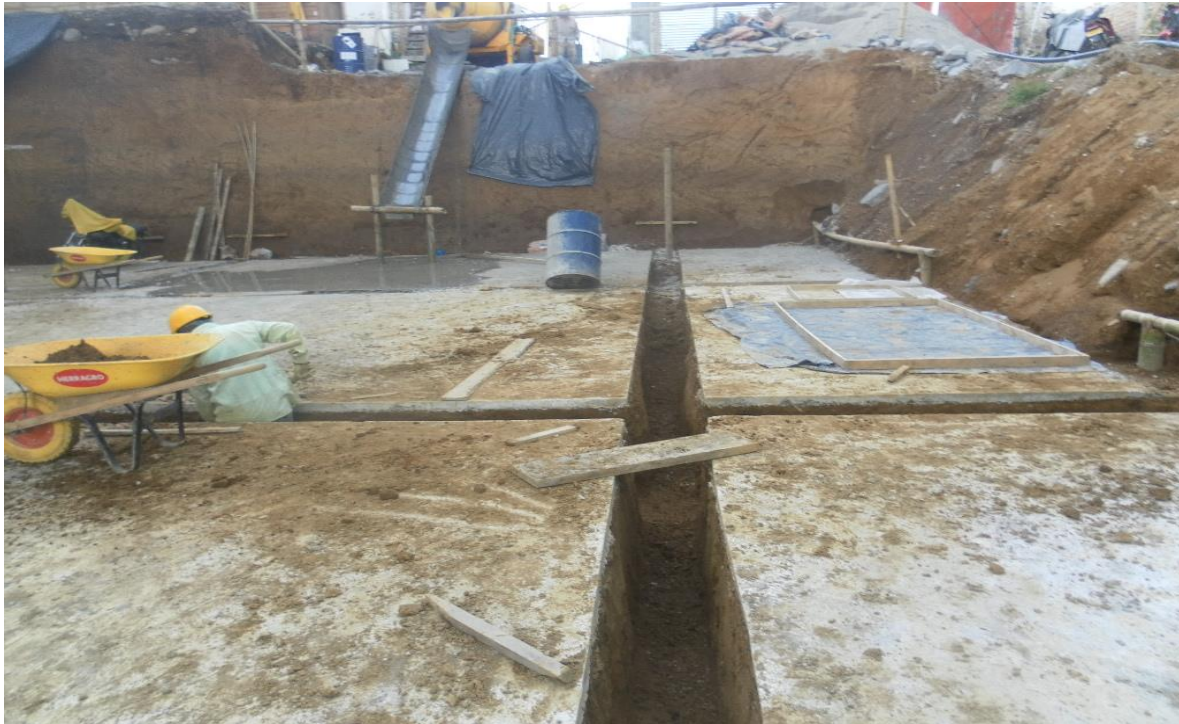
Figura 26.0 Excavación viga de cimentación en medio del solado terminado.
