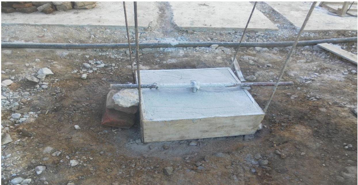
Figura 28.0 Muerto en concreto para flejar acero de diámetros grandes.
