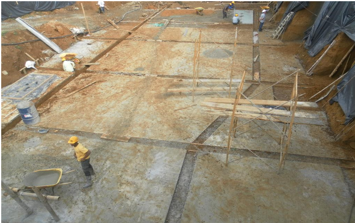
Figura 25.0 Solado de limpieza sin vigas excavadas.
