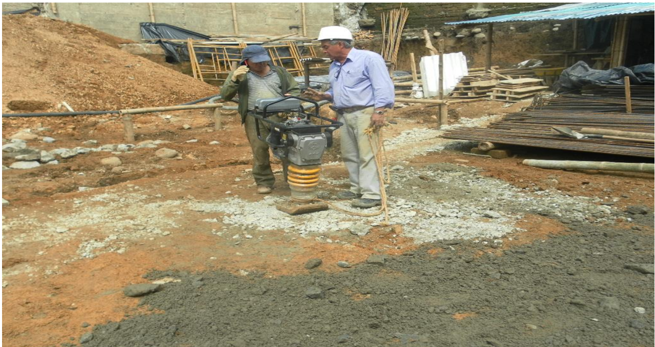
Figura 13.0 Operario con saltarín para compactación recibiendo indicaciones del maestro.
