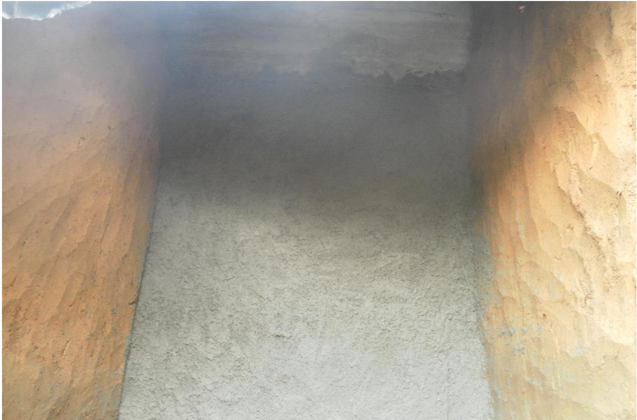
Figura 22.0 Talud champeado completamente.
