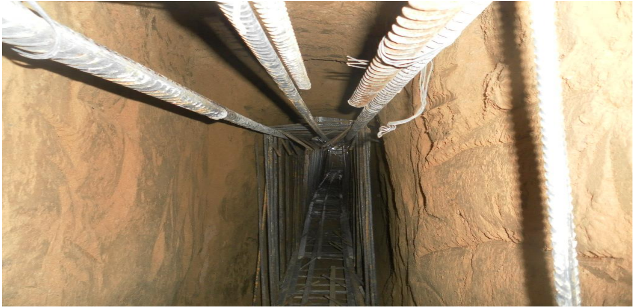
Figura 18.0 Acero de viga de cimentación eje F en túnel.
