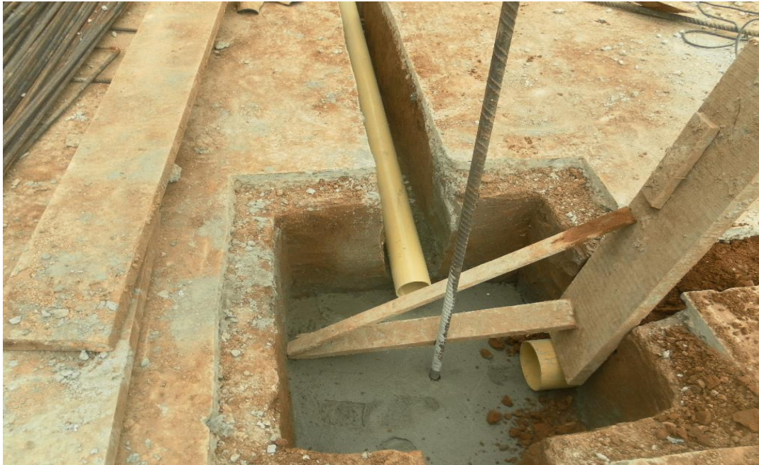
Figura 33.0 Tubería de Pvc llegando a caja hidrosanitaria.
