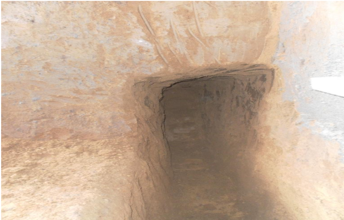
Figura 17.0 Túnel para viga de cimentación eje F.
