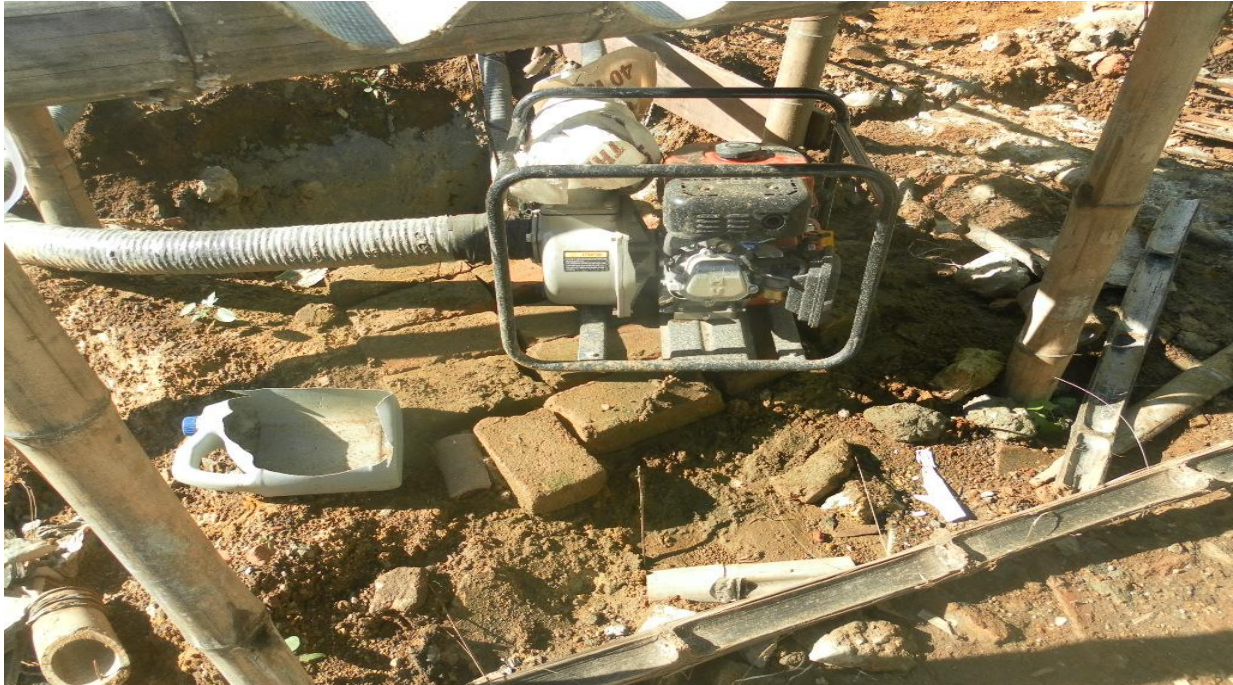
Figura 10.0. Motobomba de gasolina con tubería de 4" de diámetro.
