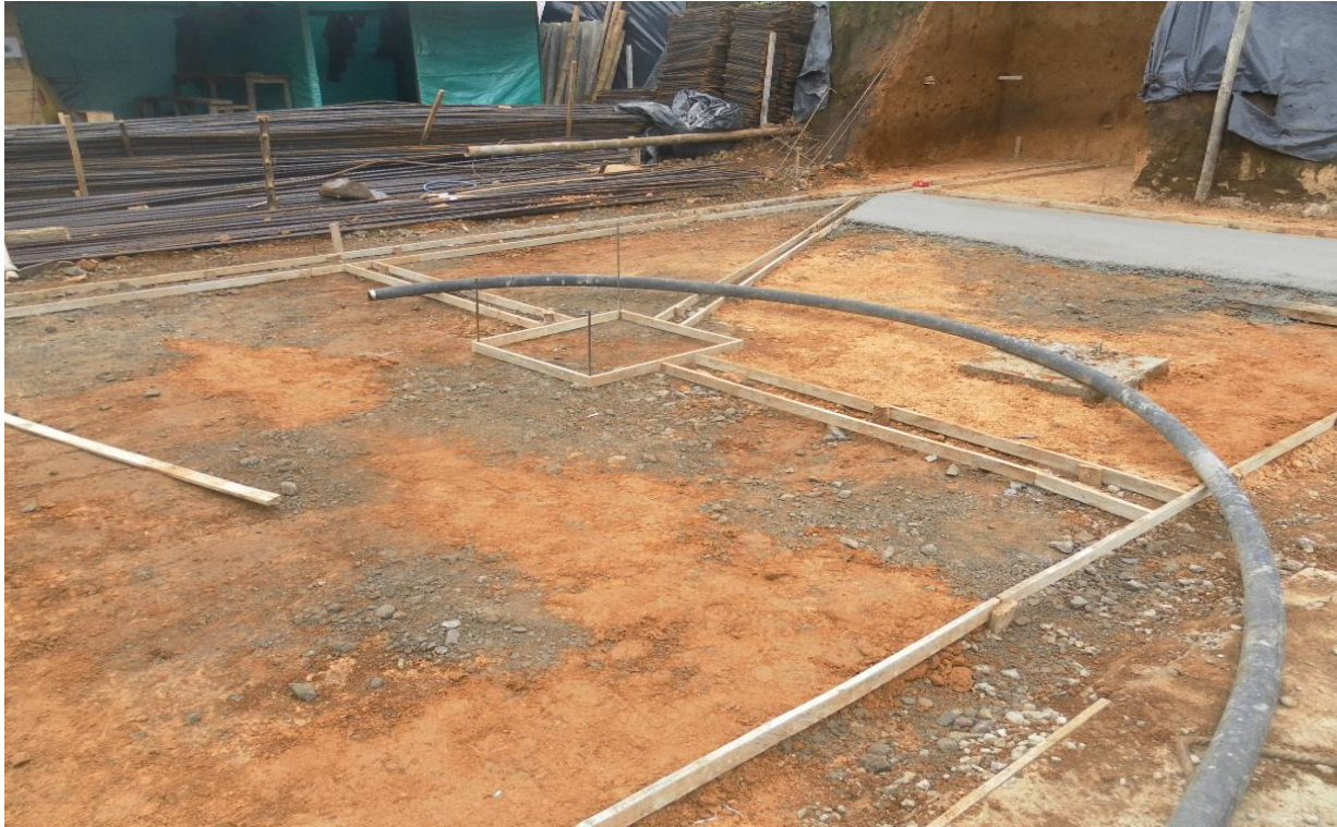
Figura 24.0 Varetas de madera a los bordes de las vigas de cimentación y de las excavaciones para tubería hidrosanitaria.
