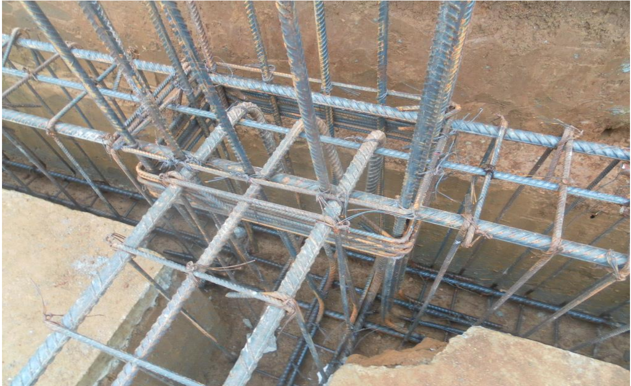
Figura 31.0 Nudo donde se instaló arranques de columna.
