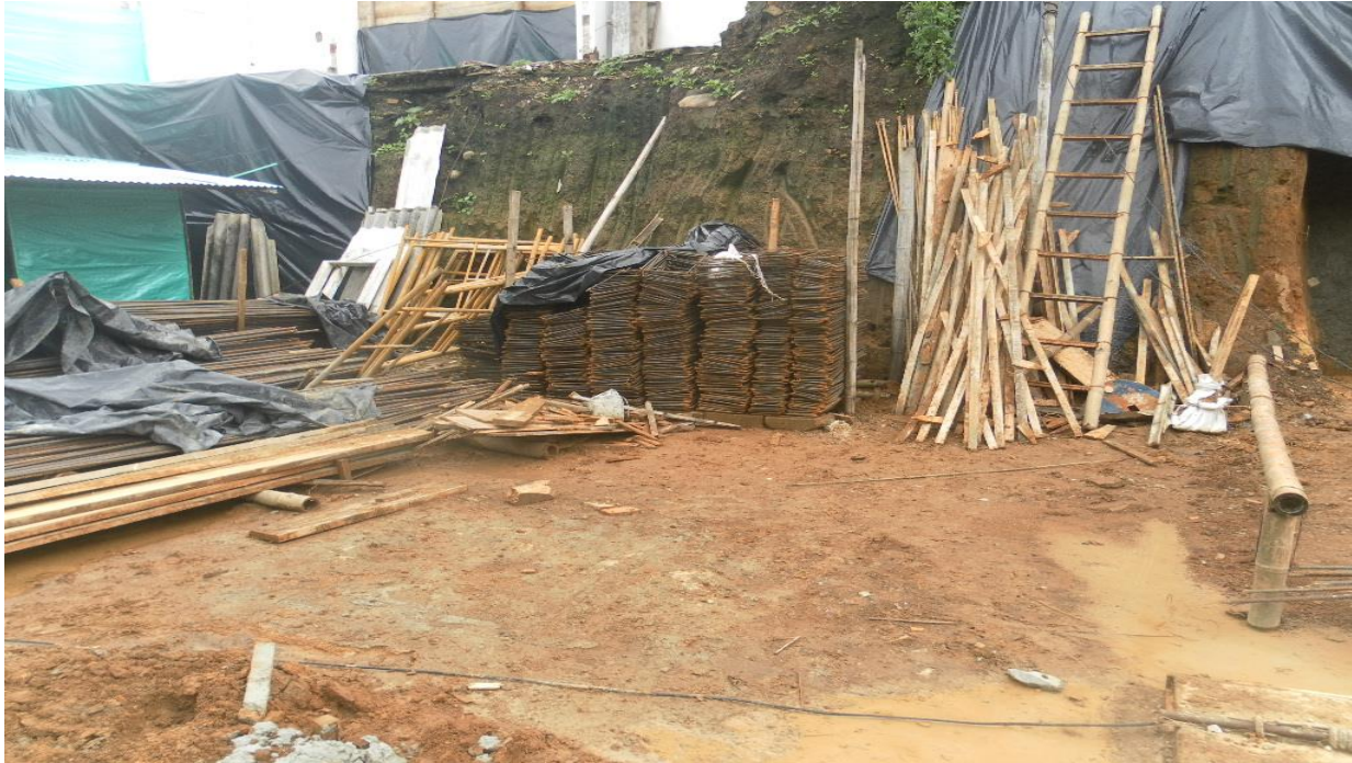
Figura 28.0 Algunos estribos figurados sobre una tarima de ladrillo y con plástico.
