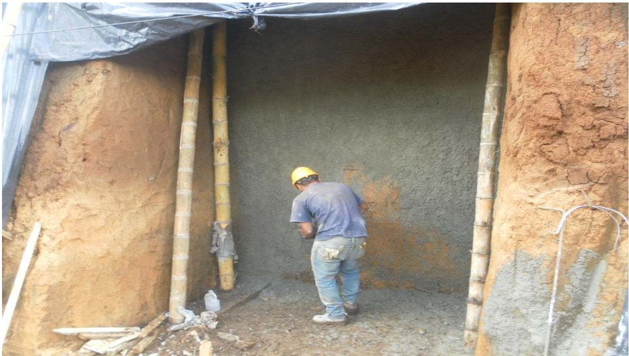
Figura 21.0 Ayudante realizando el champeo de talud.
