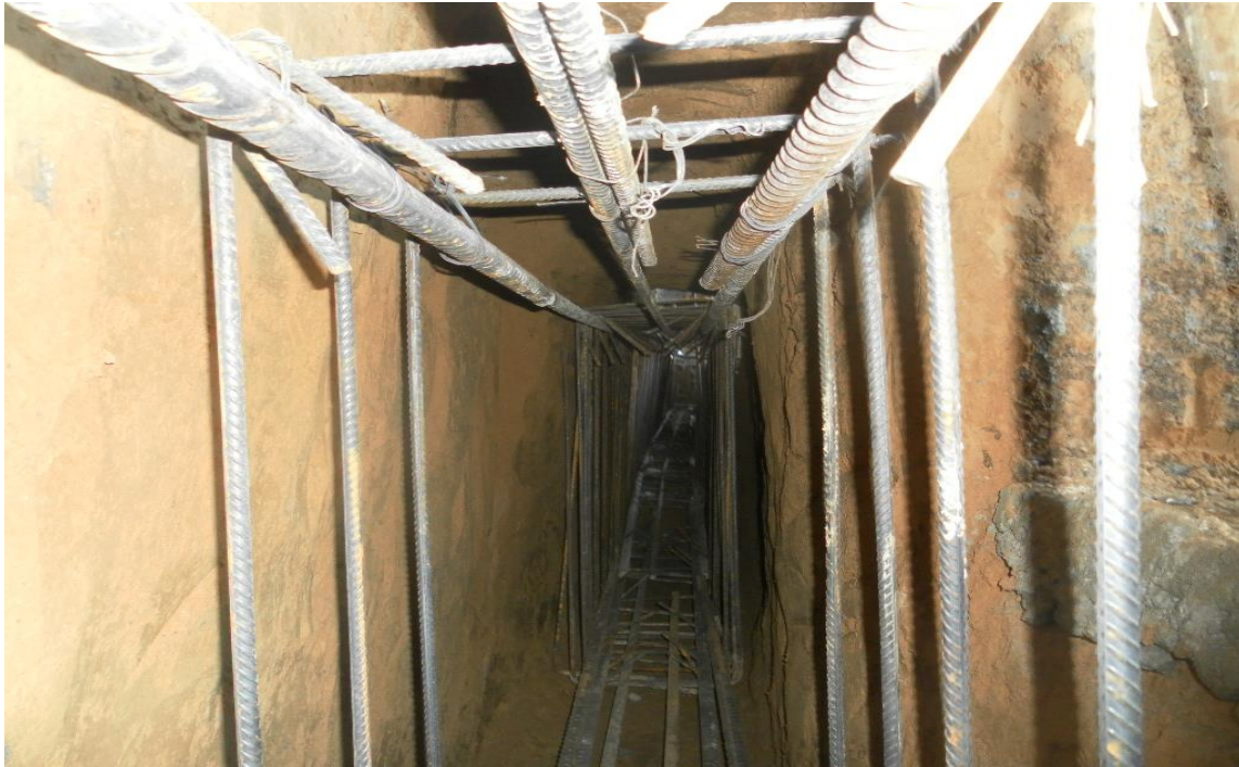
Figura 29. Acero amarrado e instalado en el túnel del eje F
