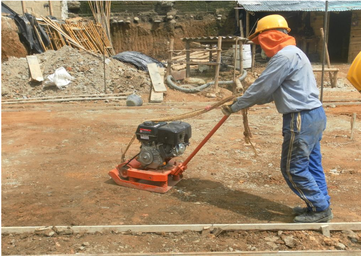
Figura 14.0 Operario con una rana compactando el fondo de la excavación.
