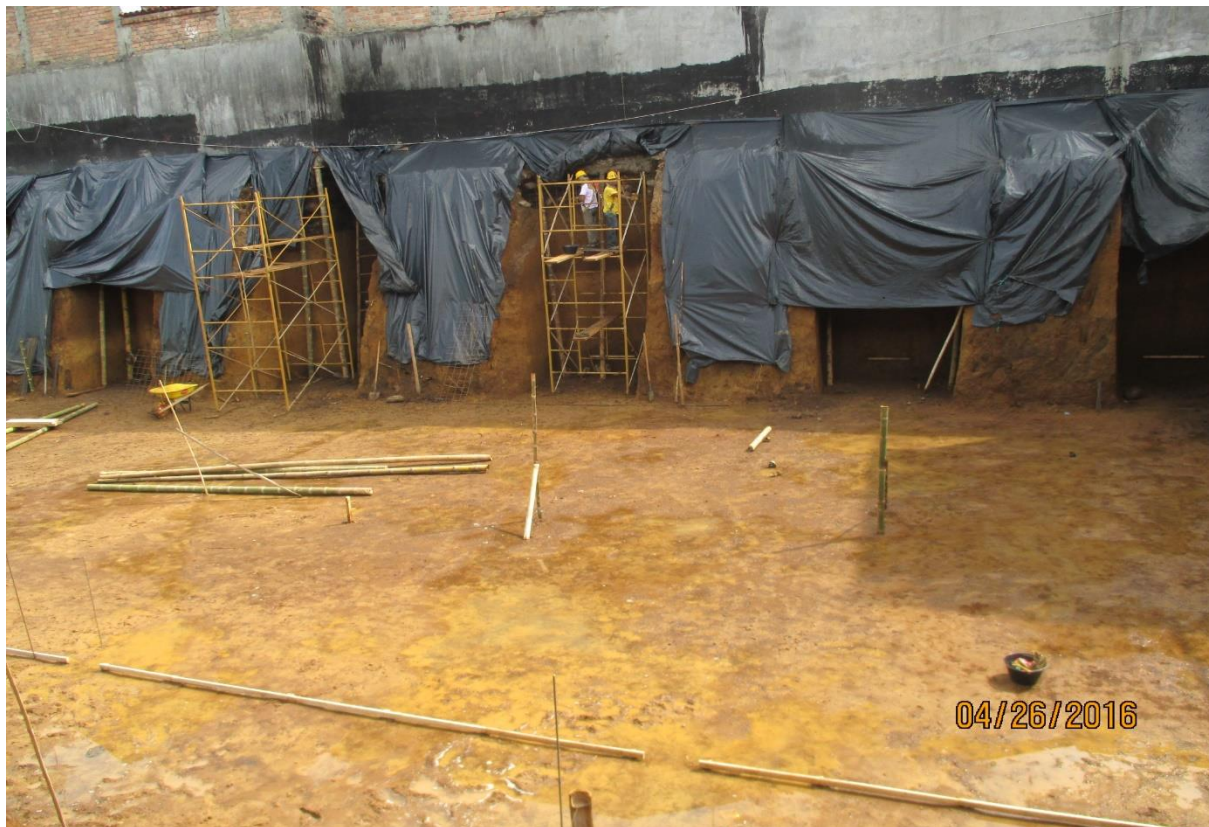
Figura 16.0 Cuñas excavadas en el eje F
