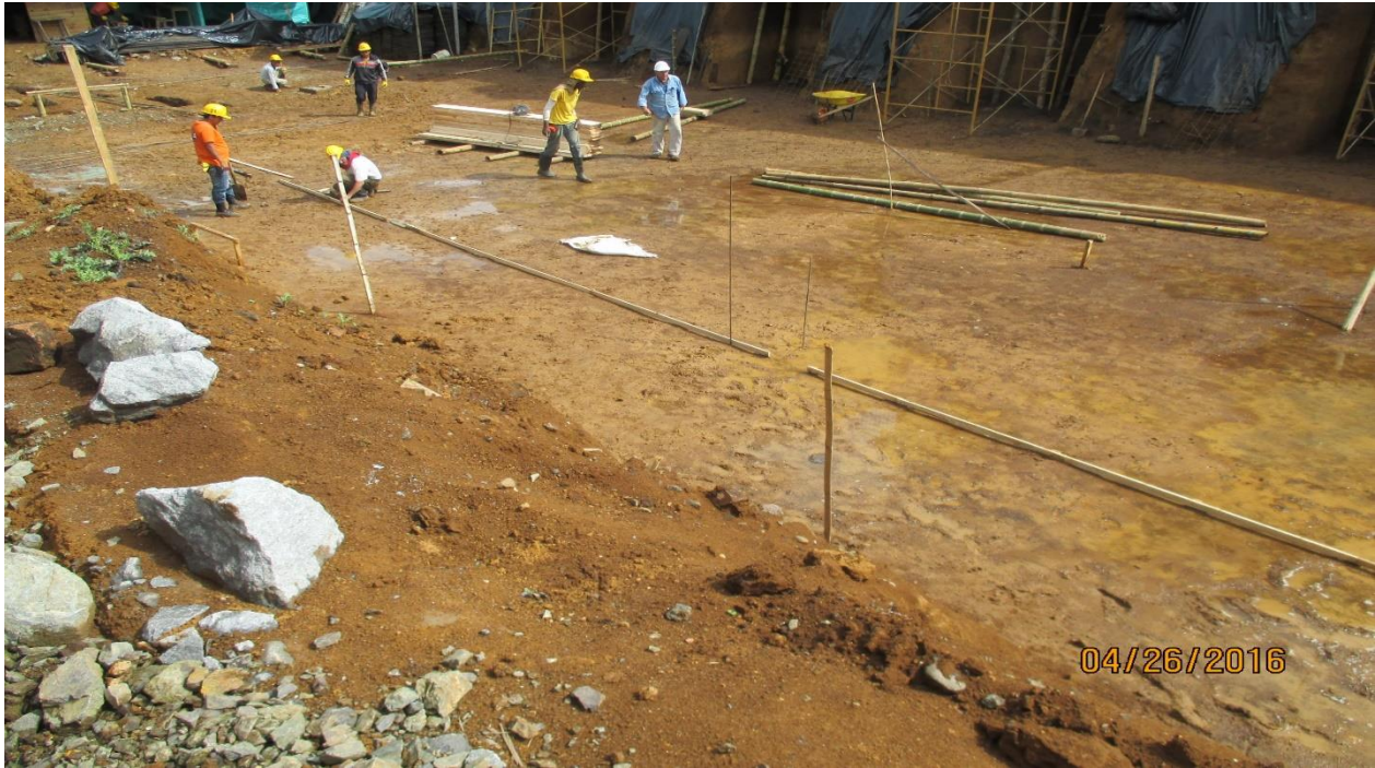
Figura 12.0. Fondo de la excavación, donde se observa el suelo algo saturado.
