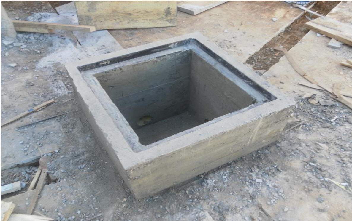
Figura 32.0 Caja hidrosanitaria en concreto de 60cm*60cm
