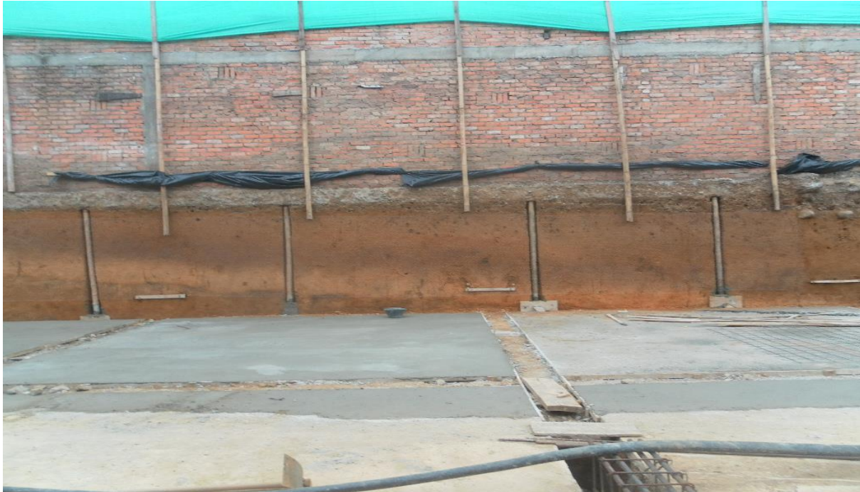
Figura 23.0 Apuntalamiento en guadua de viga de cimentación edificación vecina.
