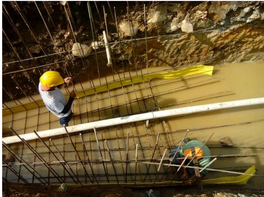
Figura 37. Cinta PVC D-22 instalada en el canal reductor de velocidad.
