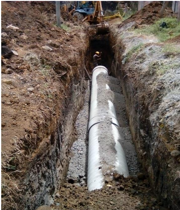
Figura 13. Tramo 218-216, encamado con sub-base granular
