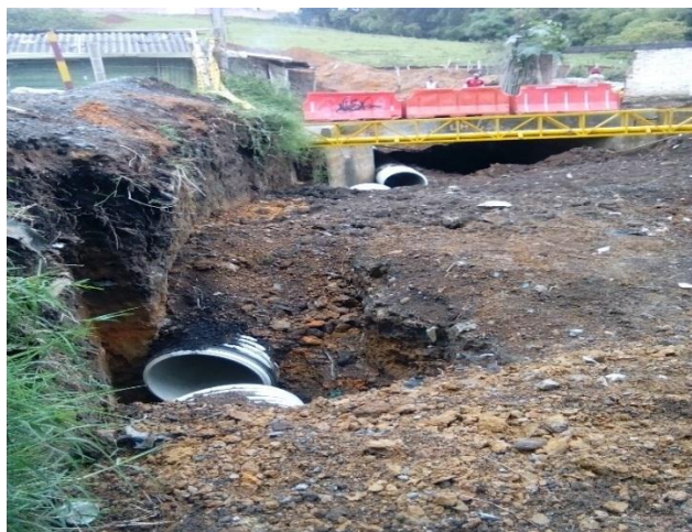
Figura 53. Vista de la conducción de desagüe sin fundición de las cajas.
