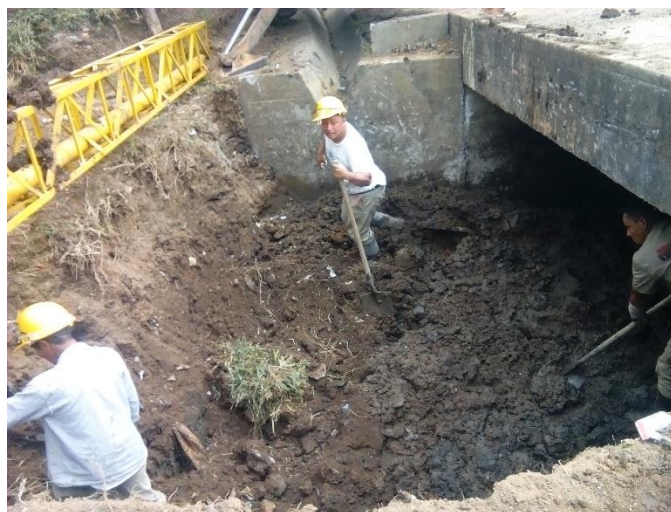
Figura 45. Inicio de limpieza en Box culvert existente.
