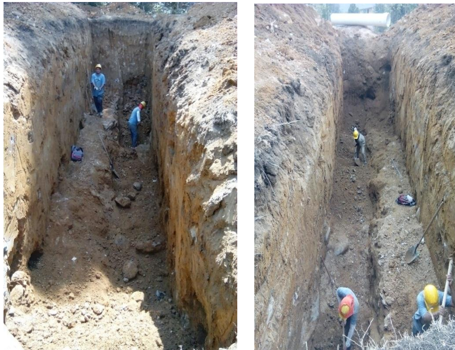
Figura 9. Tramo 212-211, 272-270. Excavación doble, ancho 2,65 m.
