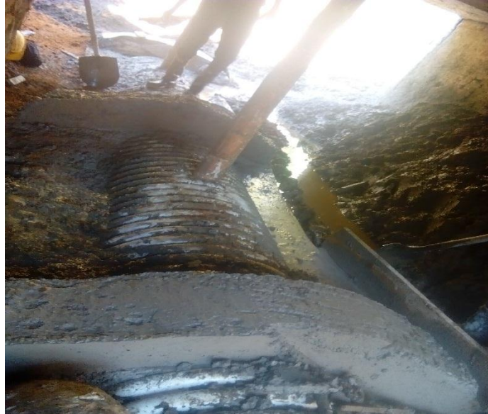
Figura 48. Tres anclajes construidos sobre la línea de tubería pluvial.
