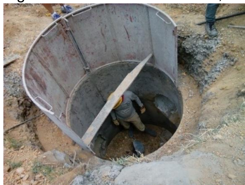
Figura 17. Cámara 218 fundida, empalme tubería 33”.
