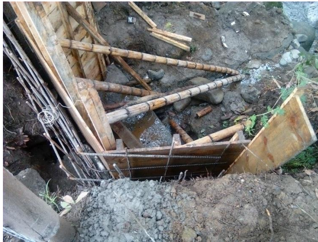
Figura 57. Acero de refuerzo flejado y amarrado.
