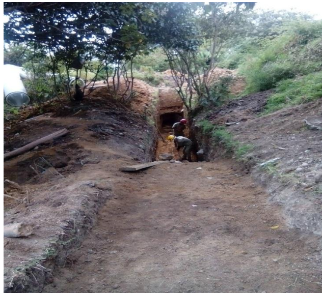
Figura 4. Tramo 224-222, excavación manual.
