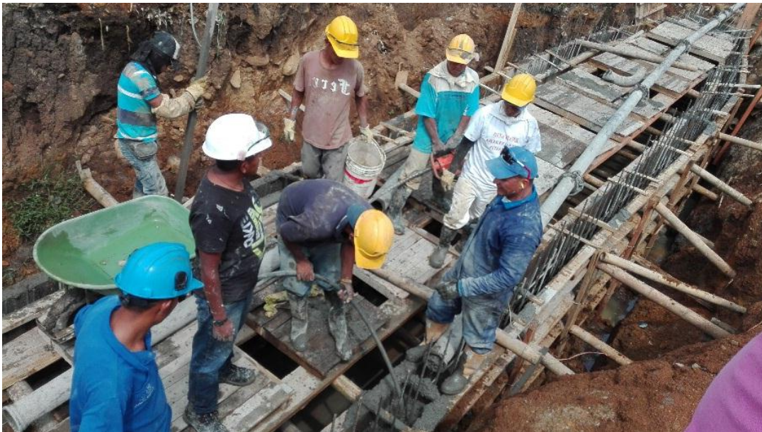
Figura 39. Bombeo y vibrado de concreto premezclado.
