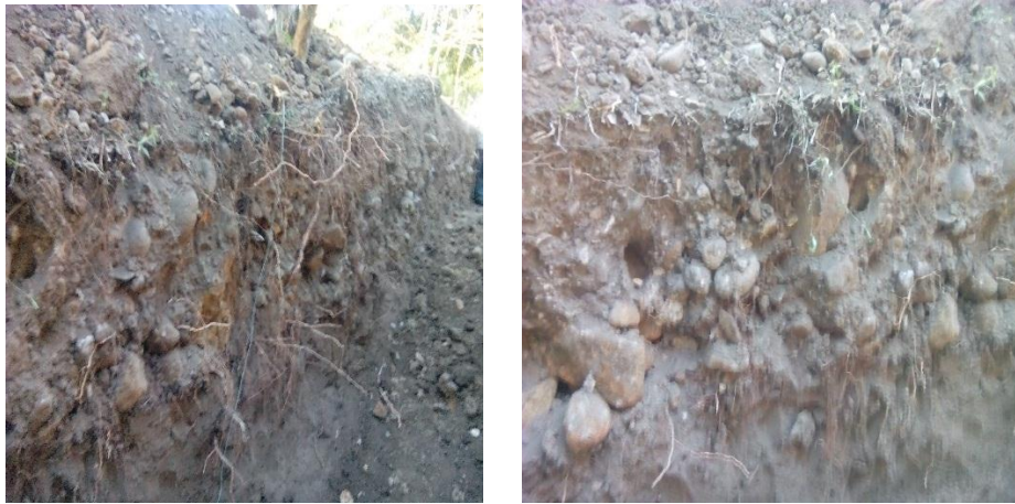
Figura 7. Tramo 224-222, material conglomerado.
