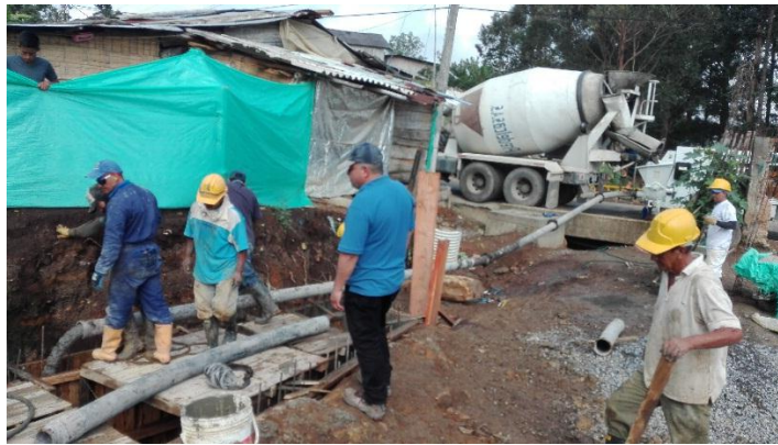
Figura 38. Mixer y tubería para bombeo de concreto premezclado.
