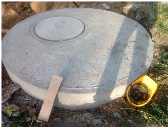
Figura 26. Cámara 178, brocal fundido y terminado.
