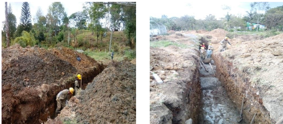
Figura 3. Tramo 220-218 pluvial, ancho de zanja 1,30 m.
