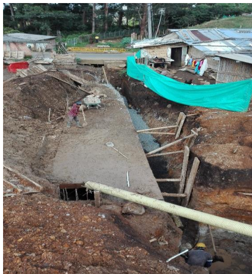
Figura 43. Canal reductor de velocidad terminado y material de retiro.
