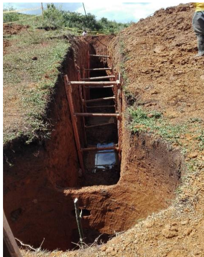
Figura 6. Tramo 248-246, alcantarillado sanitario 8”.
