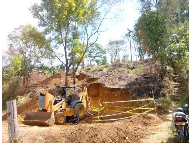
Figura 5. Tramo 216-214, 276-274, excavación a máquina.
