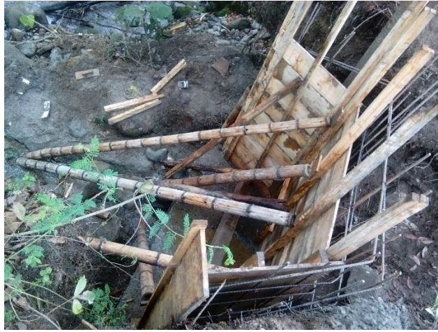
Figura 56. Formaleta de cabezal de entrega.
