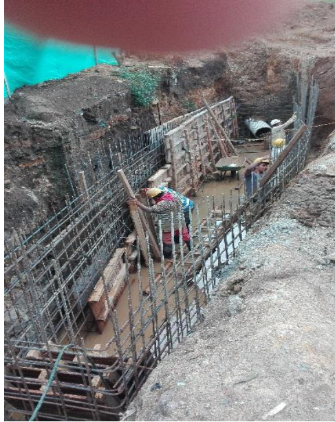
Figura 37. Cinta PVC D-22 instalada en el canal reductor de velocidad.
