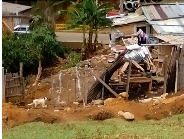
Figura 42. Vista trasera propiedad privada para construcción de canal reductor de velocidad.
