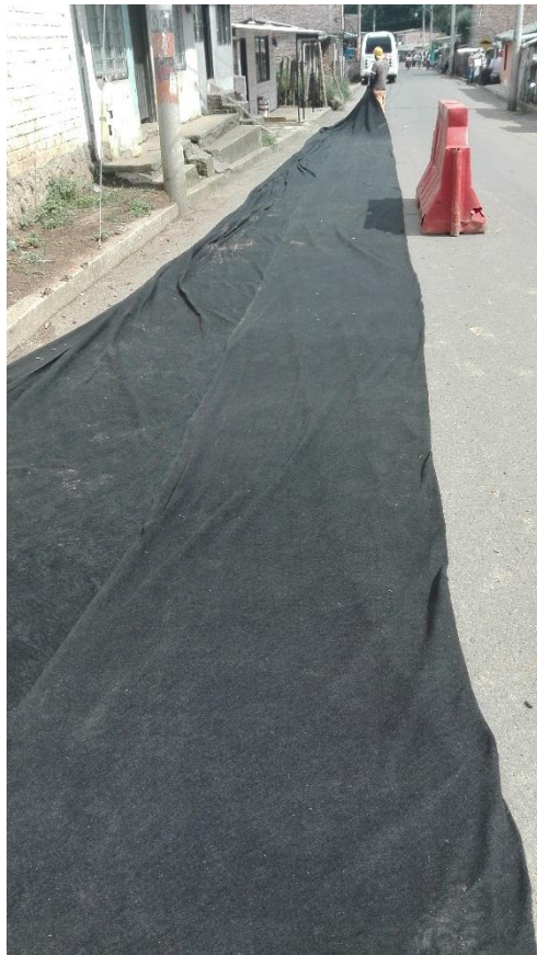
Figura 32. Filtro izquierdo, geo textil NT 1600
