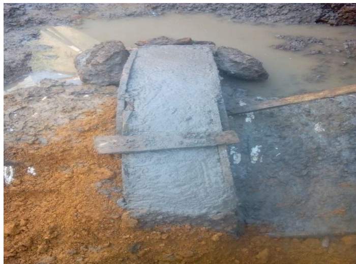
Figura 49. Anclaje formateado, espesor de 0,20 m concreto 1:2:3.
