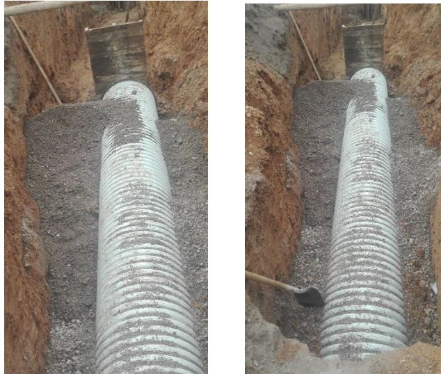
Figura 14. Tramo 126-182, cimentación con gravilla por presencia de nivel freático.
