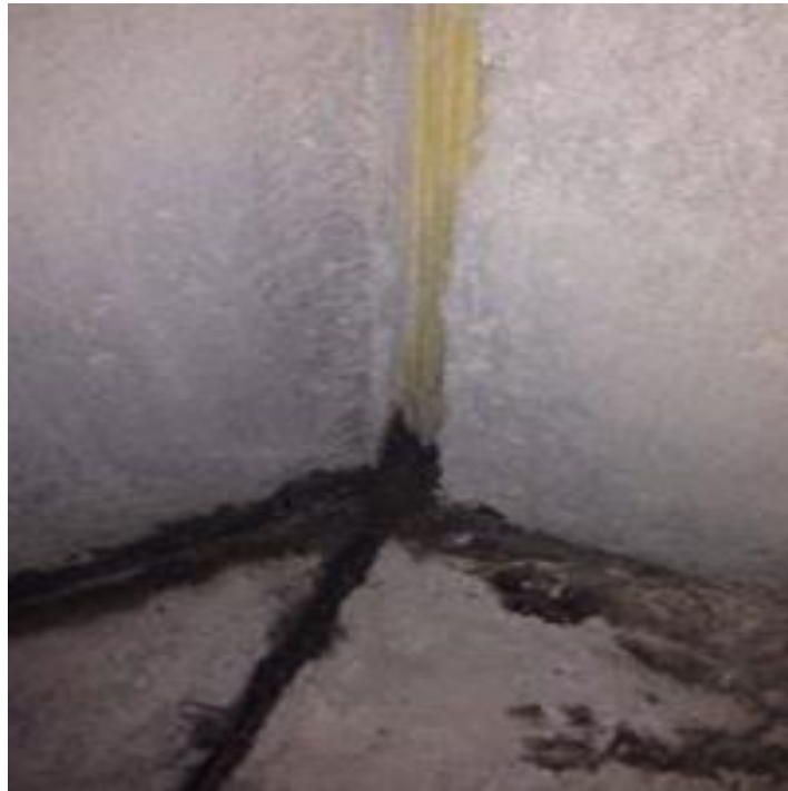
Fig. No 26. Juntas de movimiento y cinta Sika PVC. Fuente Propia.
