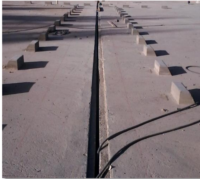
Fig. No. 12. Junta de dilatación en parqueaderos Fuente propia
