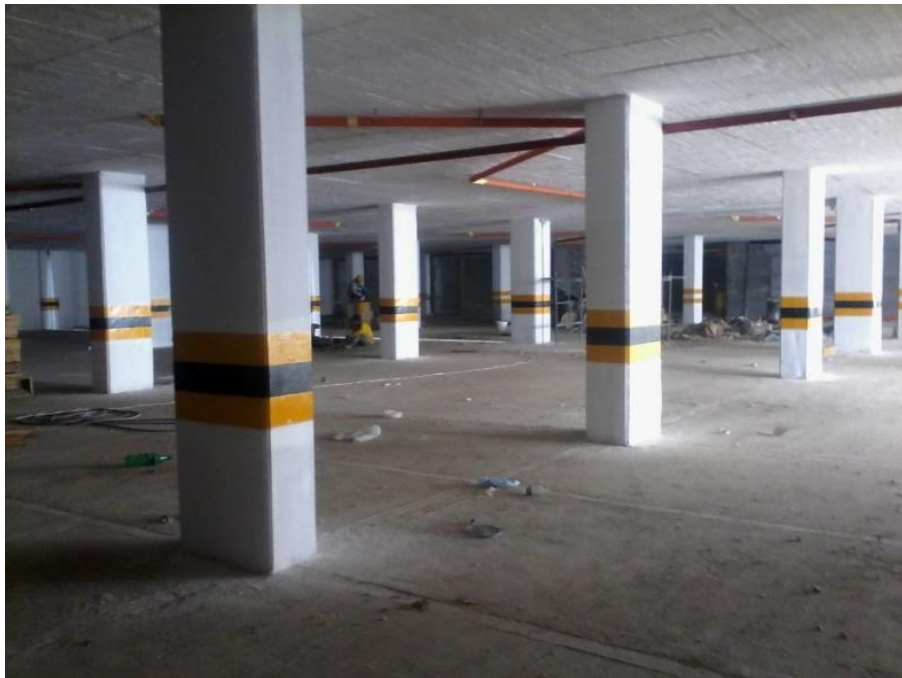
Fig. No. 16. Pintura de cielorraso, muros y demarcación de columnas Fuente propia.
