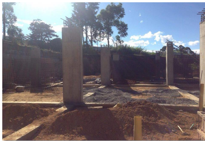
Fig. No 13. Parqueadero sótano módulo 4. Fuente propia
