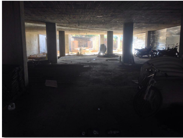
Fig. No. 14. Parqueadero sótano módulo 3. Fuente propia.
