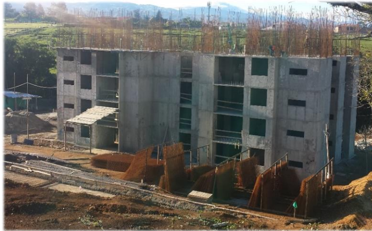
Figura 5-4. Torre A al inicio del mes de diciembre de 2015. Fuente: Propia.
