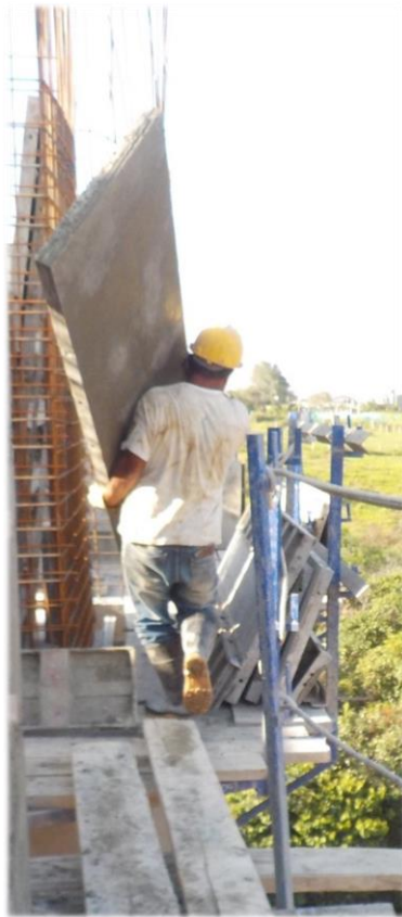
Figura 5-10. Transporte de formaleta por pasarela. Fuente: Propia.
