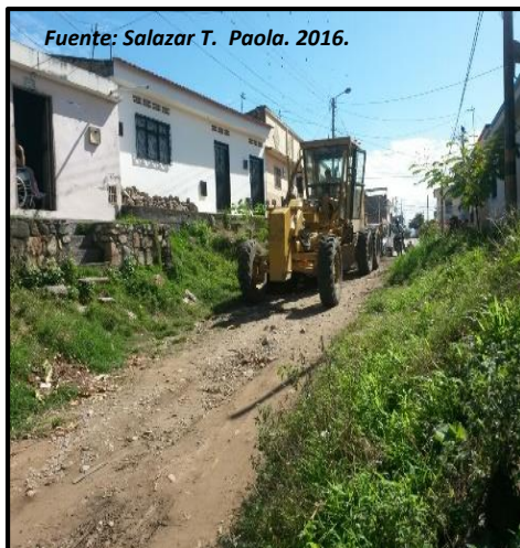
Ilustración 74. Mantenimiento Vía Barrio Obrero - Motoniveladora.
