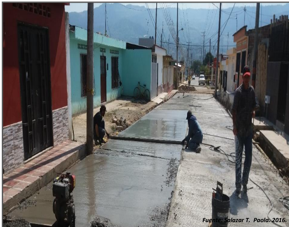
Ilustración 35. Utilización de Regla Vibratoria
