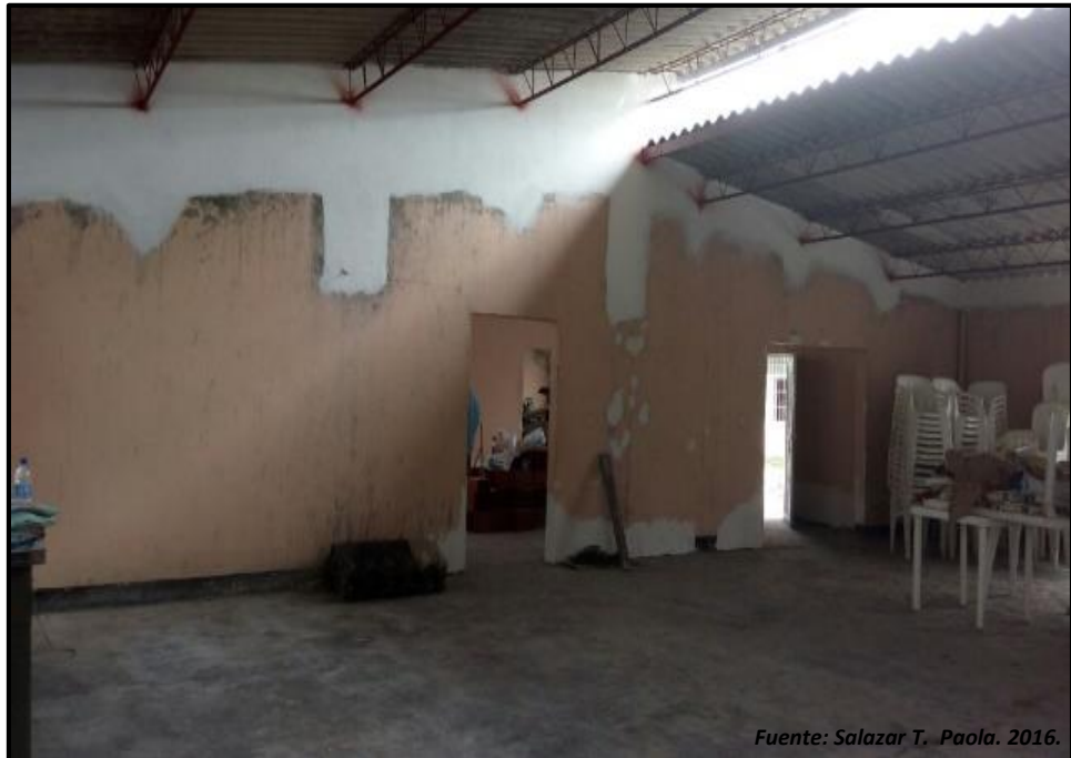
Ilustración 7. Construcción de Muro
