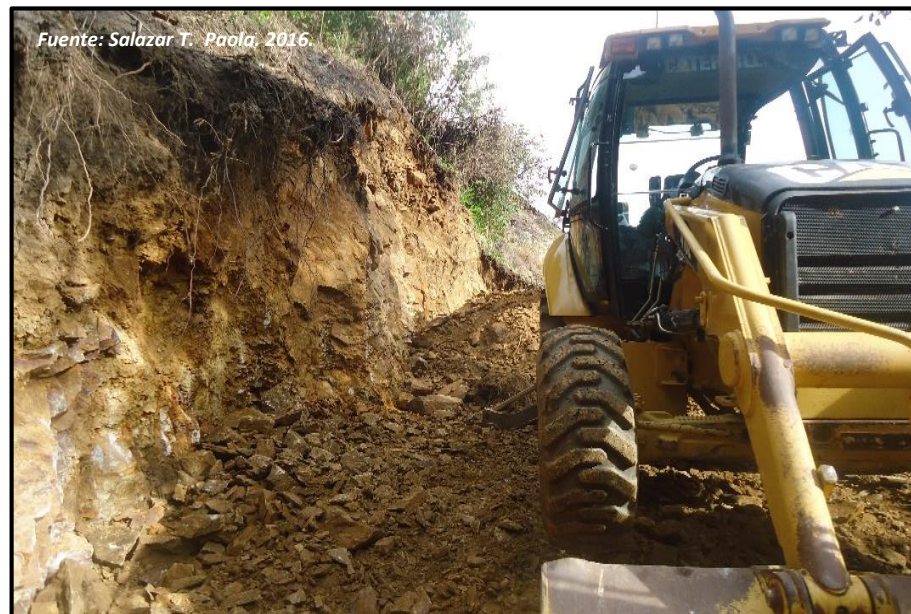
Ilustración 83. Ampliación y Limpieza Vía Palestina – El Carmelo
