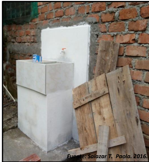
Ilustración 8. Construcción Lavadero
