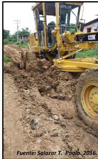
Ilustración 71. Inicio Mantenimiento Vía
