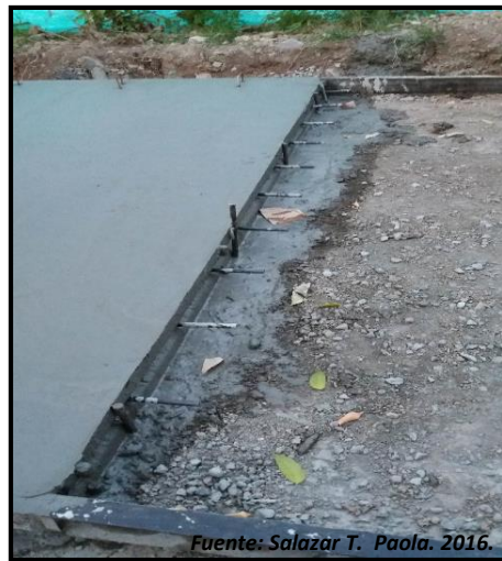
Ilustración 90. Acero de Transferencia Longitudinal
