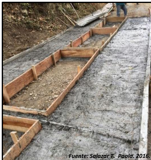
Ilustración 37. Construcción de 100 ML de Placa Huella Vereda La Lindosa
