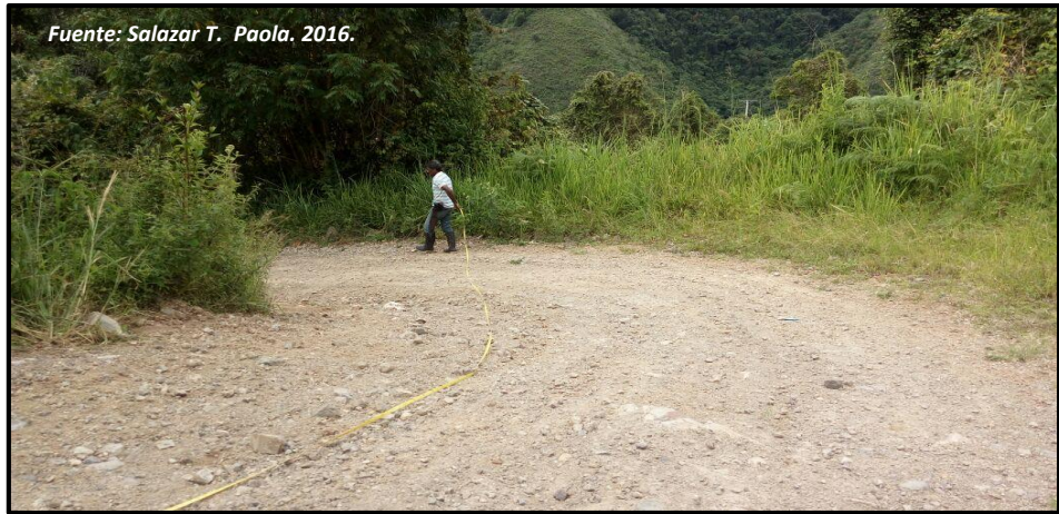
Ilustración 59. Tramo en mal estado.
