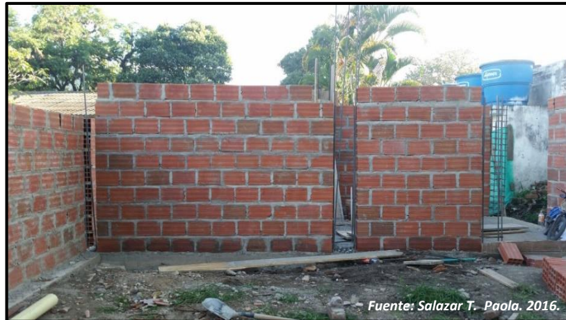
Ilustración 36. Construcción de Aula Escolar - I.E. San Sebastián.
