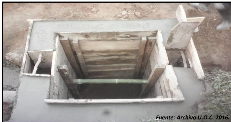
Ilustración 4. Construcción Alcantarillas CONV. 045 de 2015
