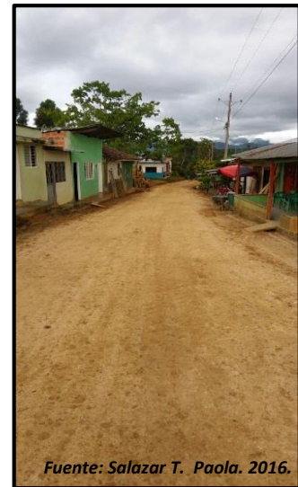
Ilustración 73. Terminación Mantenimiento Vía
