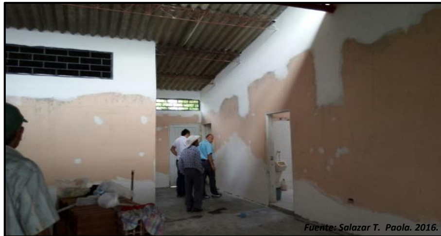
Ilustración 12. Supervisión Mantenimiento Hogar Centro Día - Revisión Puntos Hidráulicos
