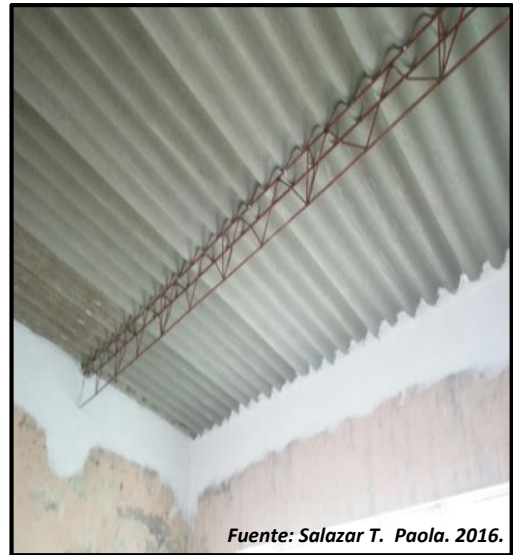
Ilustración 9. Instalación Teja Asbesto Cemento
