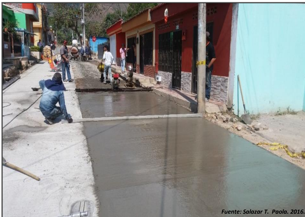
Ilustración 37. Pavimentación Contrato 444 de 2015 – Barrio “El Altico”
