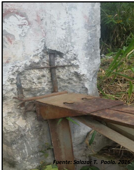
Ilustración 50. Puente Asegurado a Columna - FALLA.
