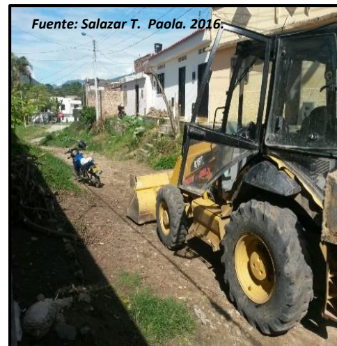
Ilustración 75. Mantenimiento Vía Barrio Obrero - Retroexcavadora.
