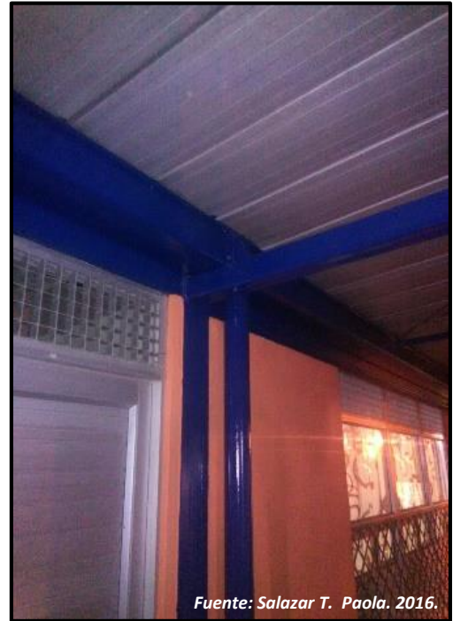
Ilustración 16. Pintura de Bajantes y Vigas Metálicas - Casa de la Cultura
