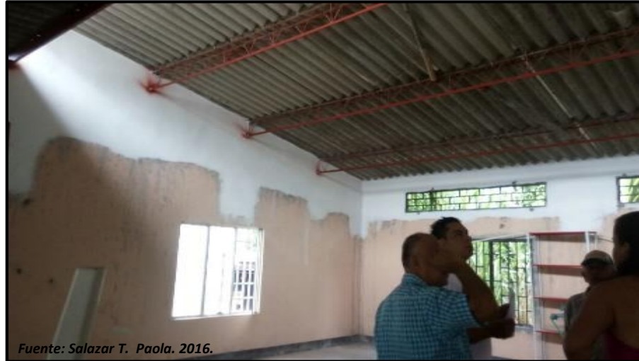
Ilustración 11. Supervisión Mantenimiento Hogar Centro Día - Instalación de Techo
