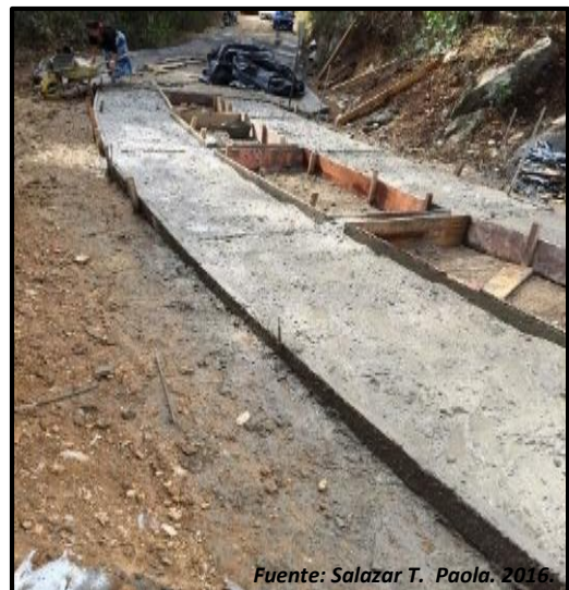
Ilustración 38. Construcción de 100 ML de Placa Huella Vereda La Lindosa
