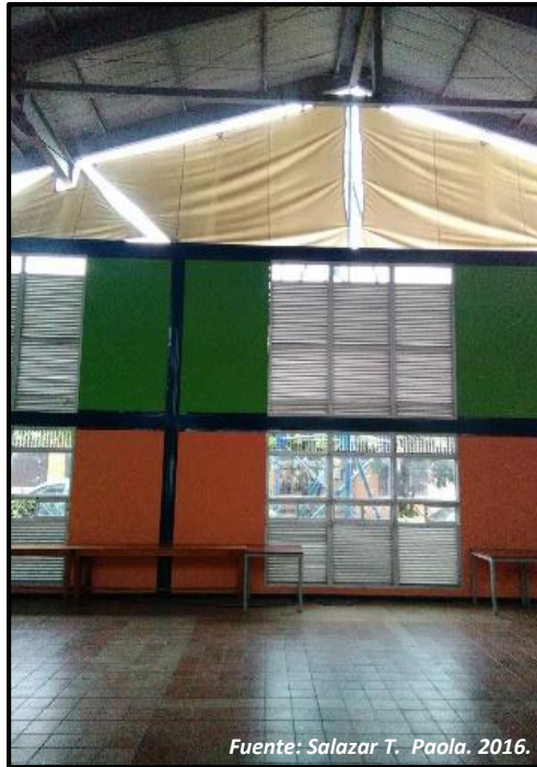
Ilustración 15. Mantenimiento Aula Múltiple - Casa de la Cultura
