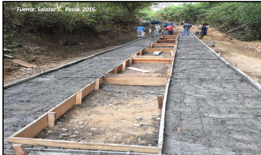
Ilustración 39. Construcción Placa Huella Vereda "San Isidro"
