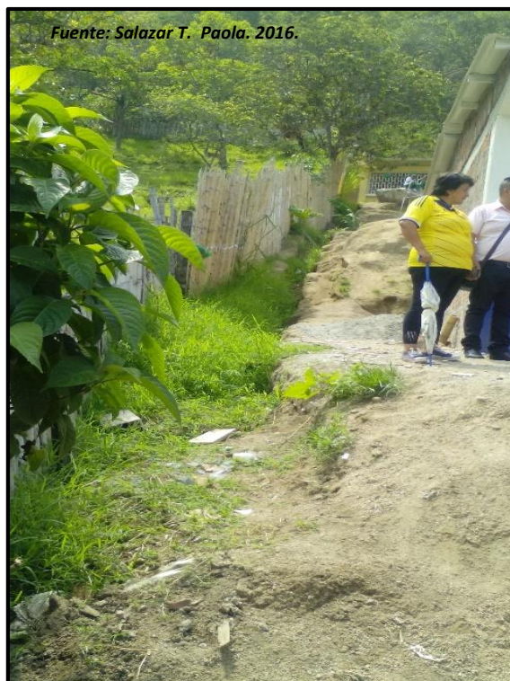
Ilustración 44. Canal de Aguas Lluvias Construido por Padres de Familia de la Institución Educativa.
