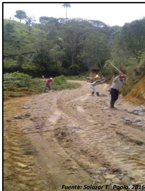
Ilustración 35. Mantenimiento vía Vereda Dos Aguas
