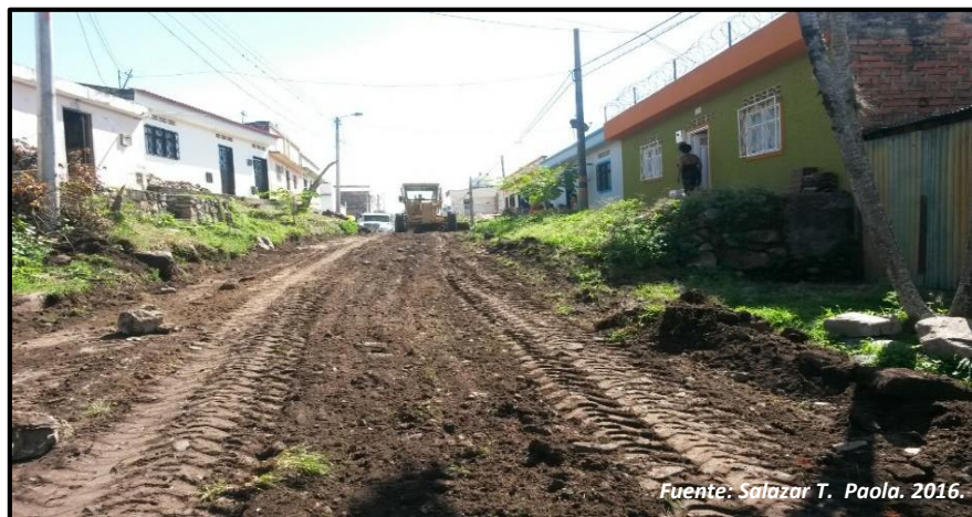
Ilustración 76. Mantenimiento Vía Barrio Obrero
