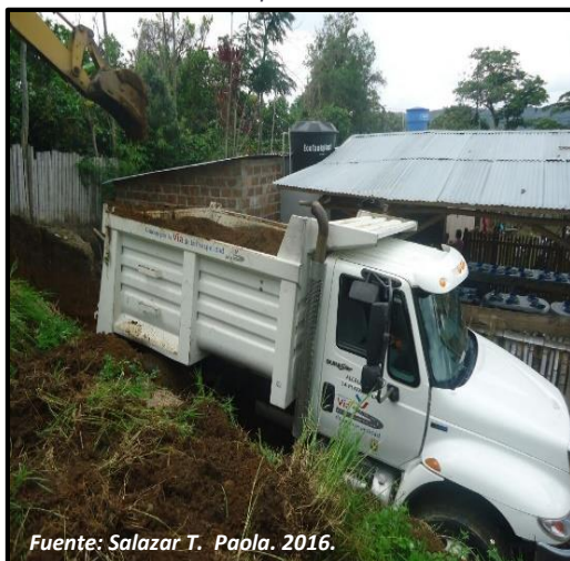
Ilustración 81. Cargue de Material Sobrante - Explanación.
