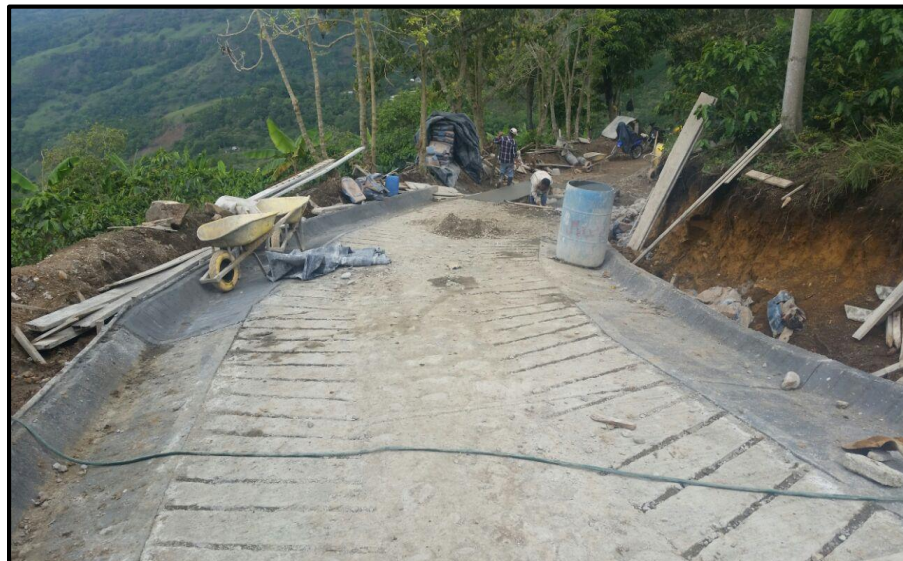
Ilustración 40. Construcción Placa Huella Vereda "San Isidro"
