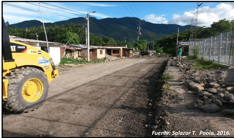
Ilustración 69. Mantenimiento vía Barrio "La Libertad"
