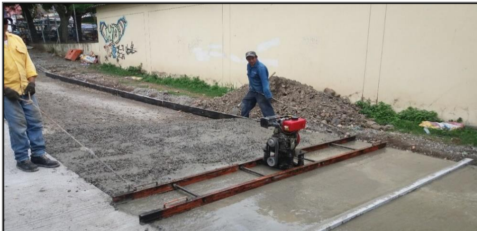
Ilustración 31. Pavimentación Contrato 444 de 2015 – Barrio "El Altico"
