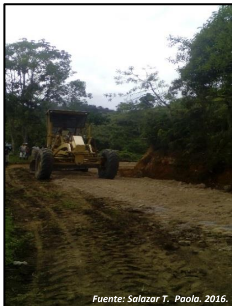
Ilustración 34. Mantenimiento de Vía Vereda Dos Aguas
