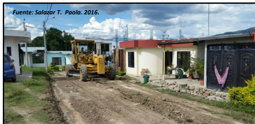
Ilustración 77. Mejoramiento vía Barrio "Los Transportadores" - Motoniveladora
