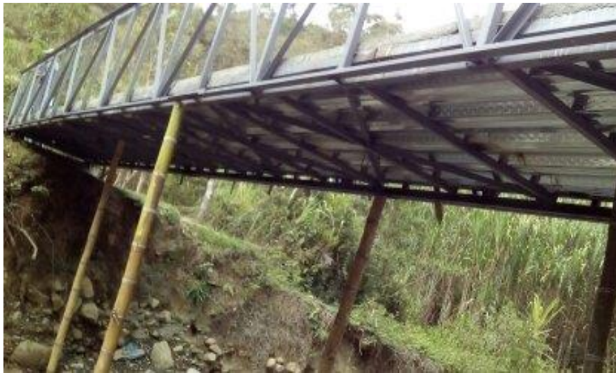
Imagen 14. Fuente propia. Lámina colaborante instalada
