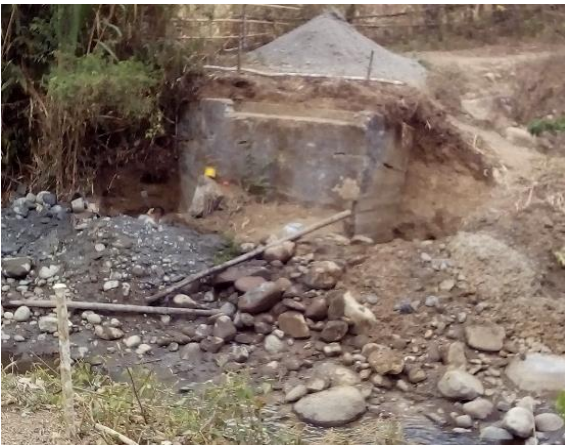
Imagen 7. Fuente propia. Estribo existente del puente anterior (derecho) río San Pedro
