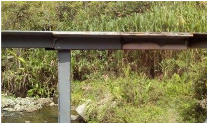
Imagen 13. Fuente propia. Uniones reforzadas
