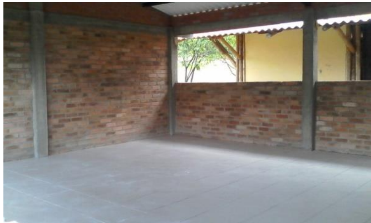
Imagen 28. Fuente propia. Piso y parte interior aula escolar IEA la Depresión
