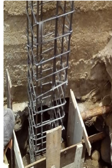
Imagen 10. Fuente propia. Refuerzo de columna
