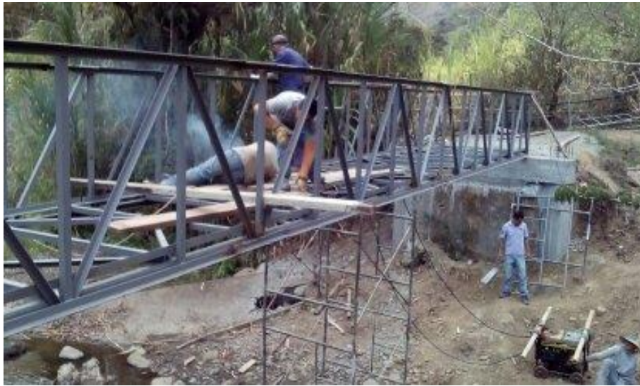
Imagen 12. Fuente propia. Montaje estructura puente río San Pedro
