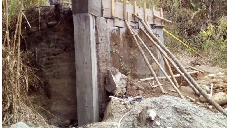
Imagen 11. Fuente propia. Columna y viga puente río San Pedro
