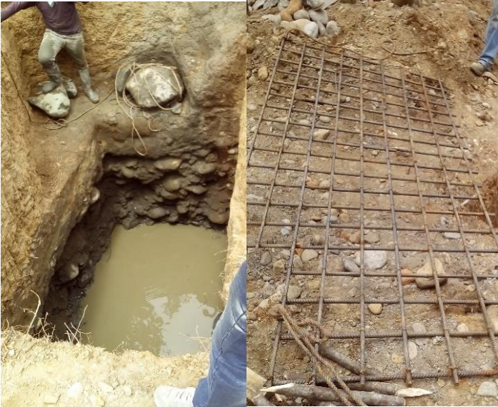
Imagen 9. Fuente propia. Excavación y acero de refuerzo para zapata corrida.
