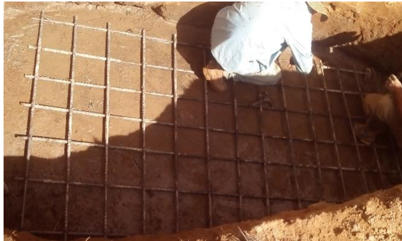
Imagen 17. Fuente propia. Refuerzo zapatas puente quebrada Cutanga
