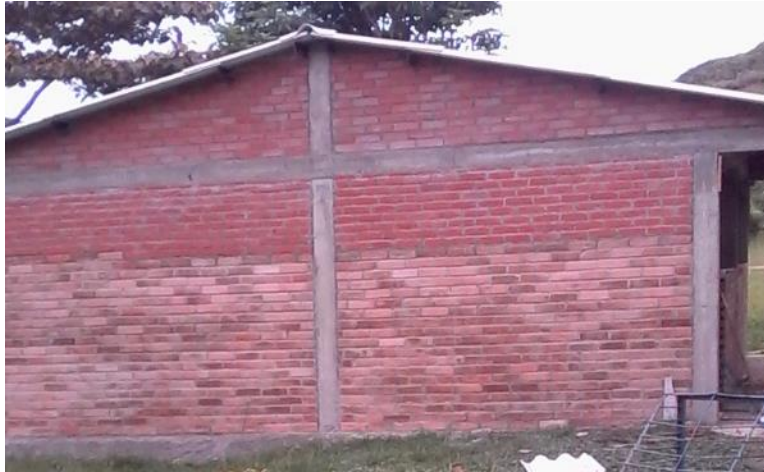
Imagen 27. Fuente propia. Aula escolar IEA la Depresión
