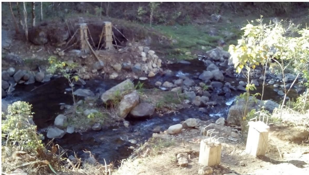
imagen 19. Fuente propia. Columnas puente peatonal Quebrada Cutanga, Veredas el Salero- Santa Marta
