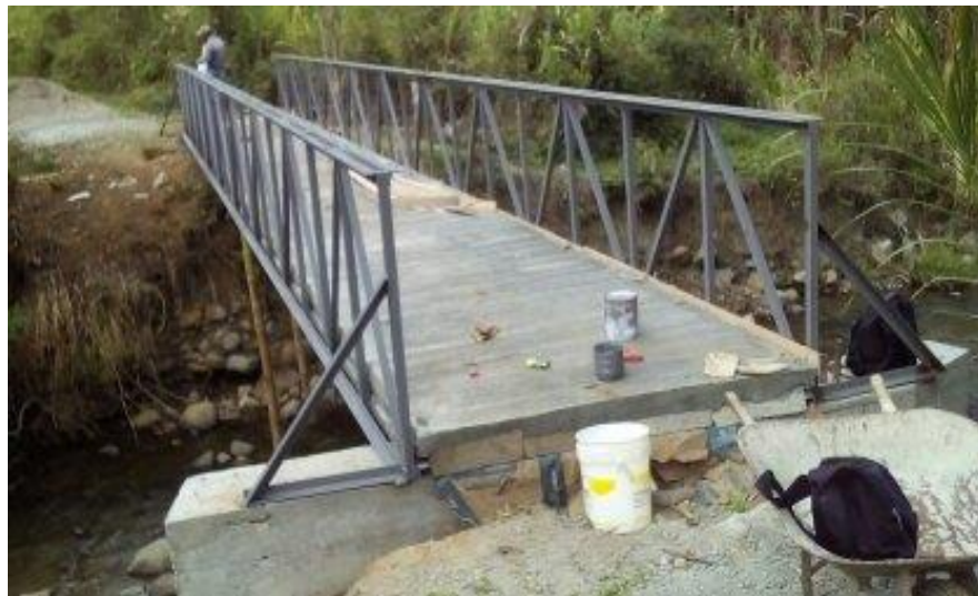
Imagen 15. Fuente propia. Losa fundida puente río San Pedro
