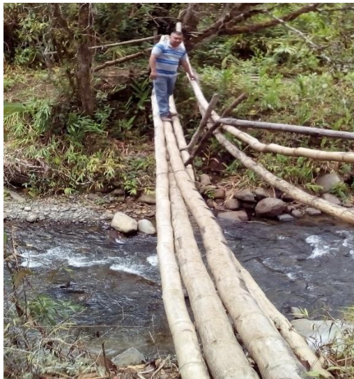
Imagen 5. Fuente propia. Puente de guadua río San Pedro camino el Vereda el Llano – Palo grande
