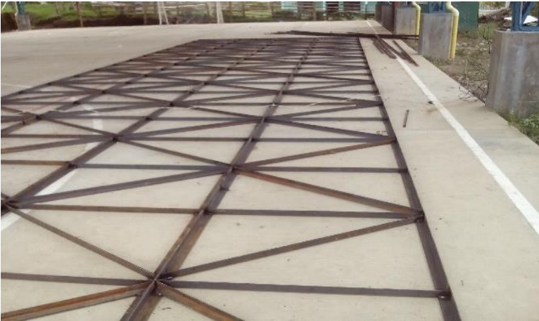
Imagen 21. Fuente propia. Estructuras para puente Quebrada Cutanga.
