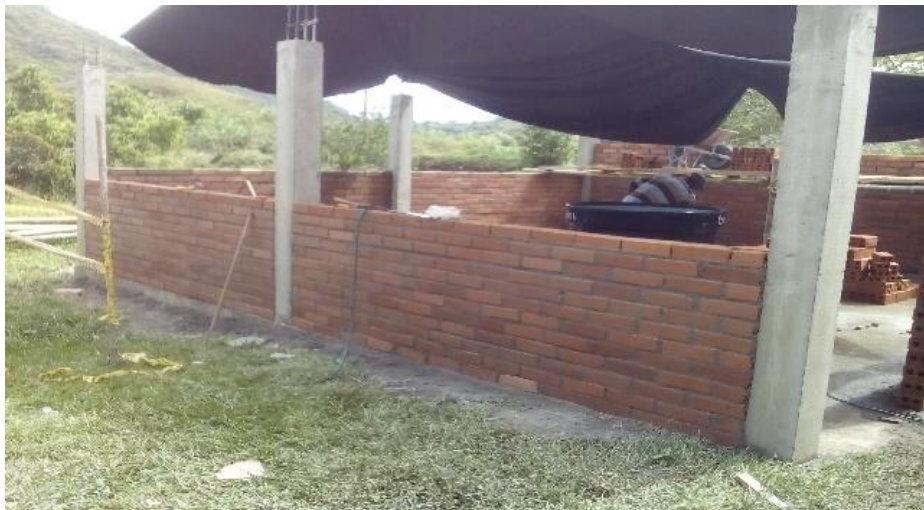
Imagen 6. Fuente propia. Aula escolar IEA la Depresión
