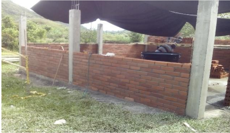
Imagen 26. Fuente propia. Aula escolar IEA la Depresión
