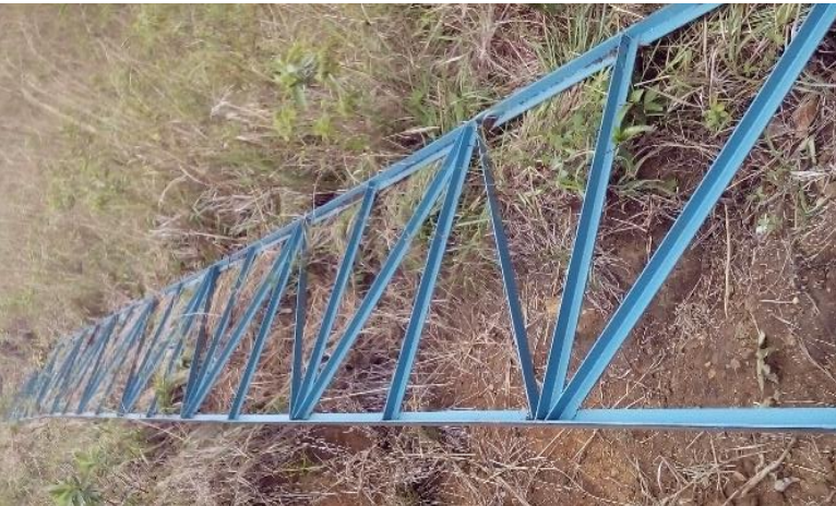
Imagen 22. Fuente propia. Estructura transportada para la obra
