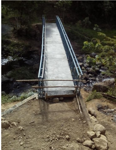
Imagen 25. Fuente propia. Vista puente quebrada Cutanga.
