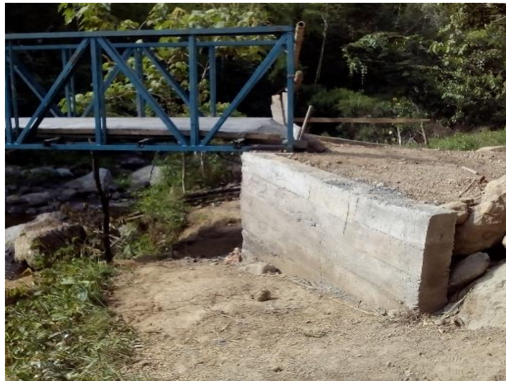
Imagen 24. Fuente propia. Acceso derecho
