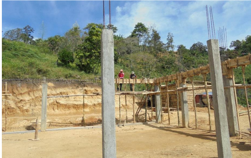
Imagen 29. Fuente propia. Casa cultural en construcción Resguardo Indígena El Oso
