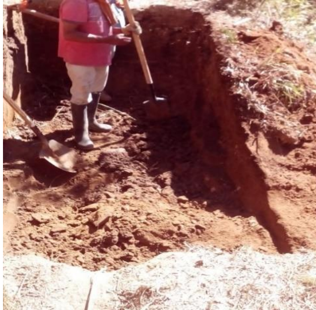
Imagen 16 Fuente propia. Excavación puente quebrada Cutanga
