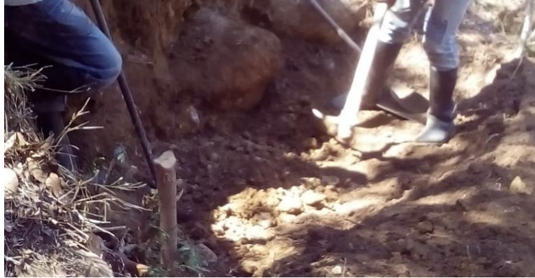
Imagen 18. Fuente propia. Excavación lado izquierdo puente peatonal Veredas el Salero-Santa Marta
