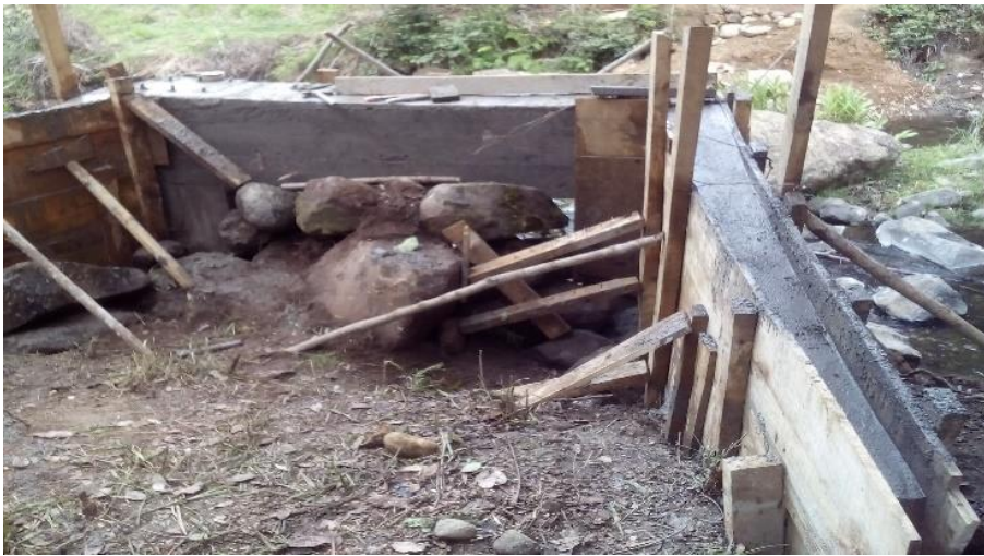
Imagen 20. Fuente propia. Muros de acceso lado derecho puente quebrada Cutanga
