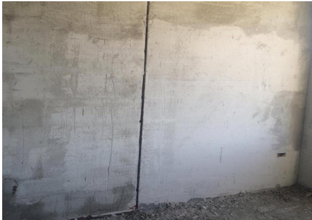
Figura No.33 Muros con relleno.
