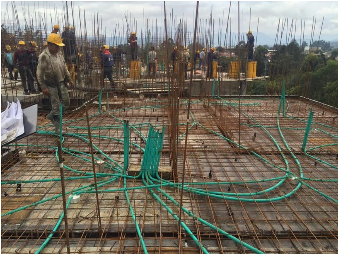
Figura No.25 Preparación de losa para fundición
