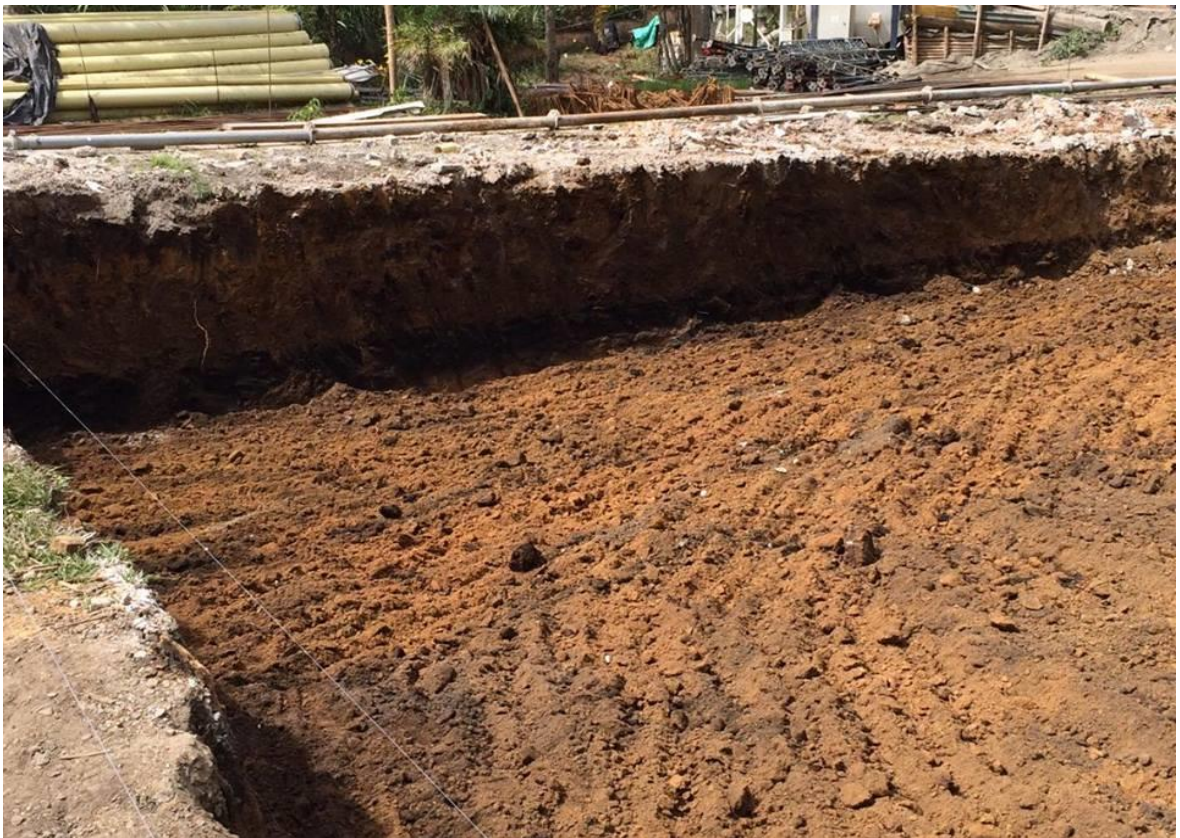
Figura No.7 Adecuación del terreno.
