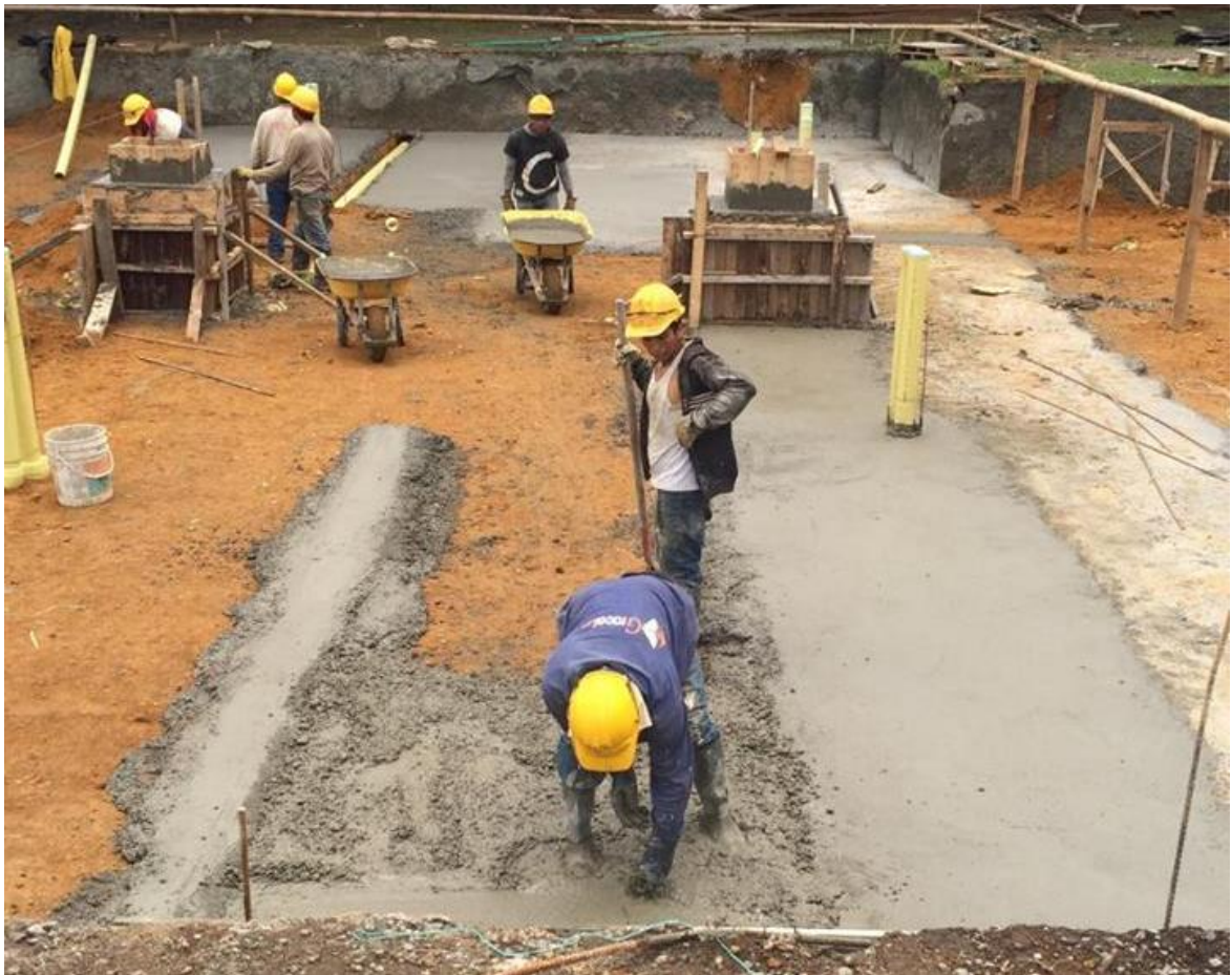
Figura No.8 Champeo de taludes y solado de limpieza
