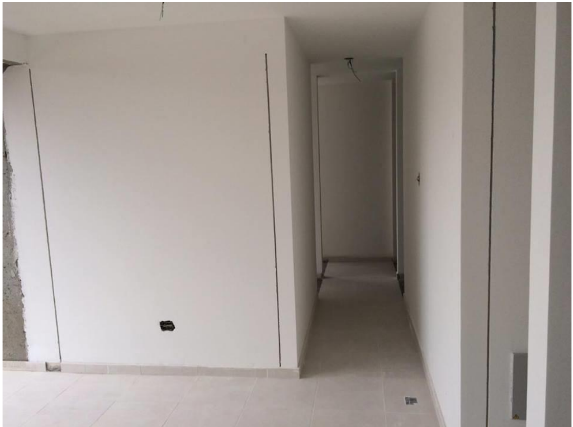
Figura No.34 Muros en estuco y primera mano
