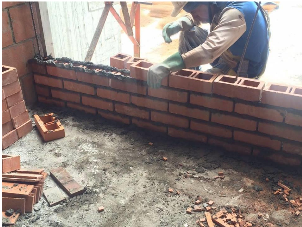
Figura No.28 Mampostería estructural.
