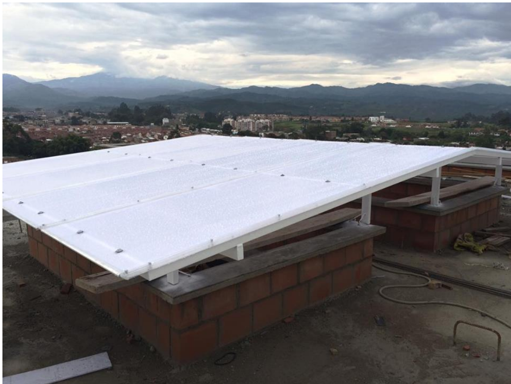
Figura No.29 Alfajía de cubierta.
