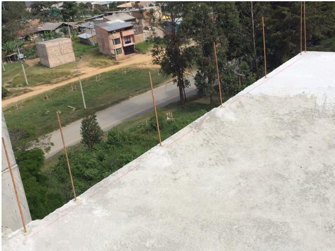
Figura No.27 Localización y colocación de dovelas.
