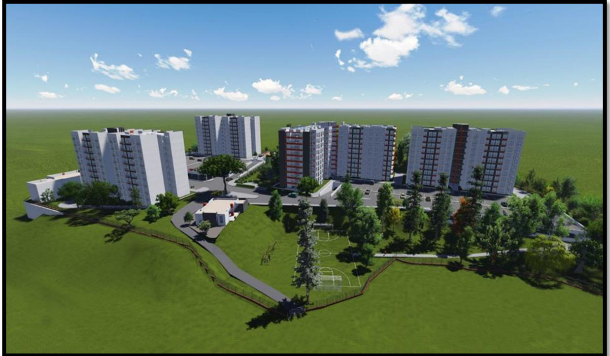
Figura No.1 CONDOMINIO TORRES DE MILANO
