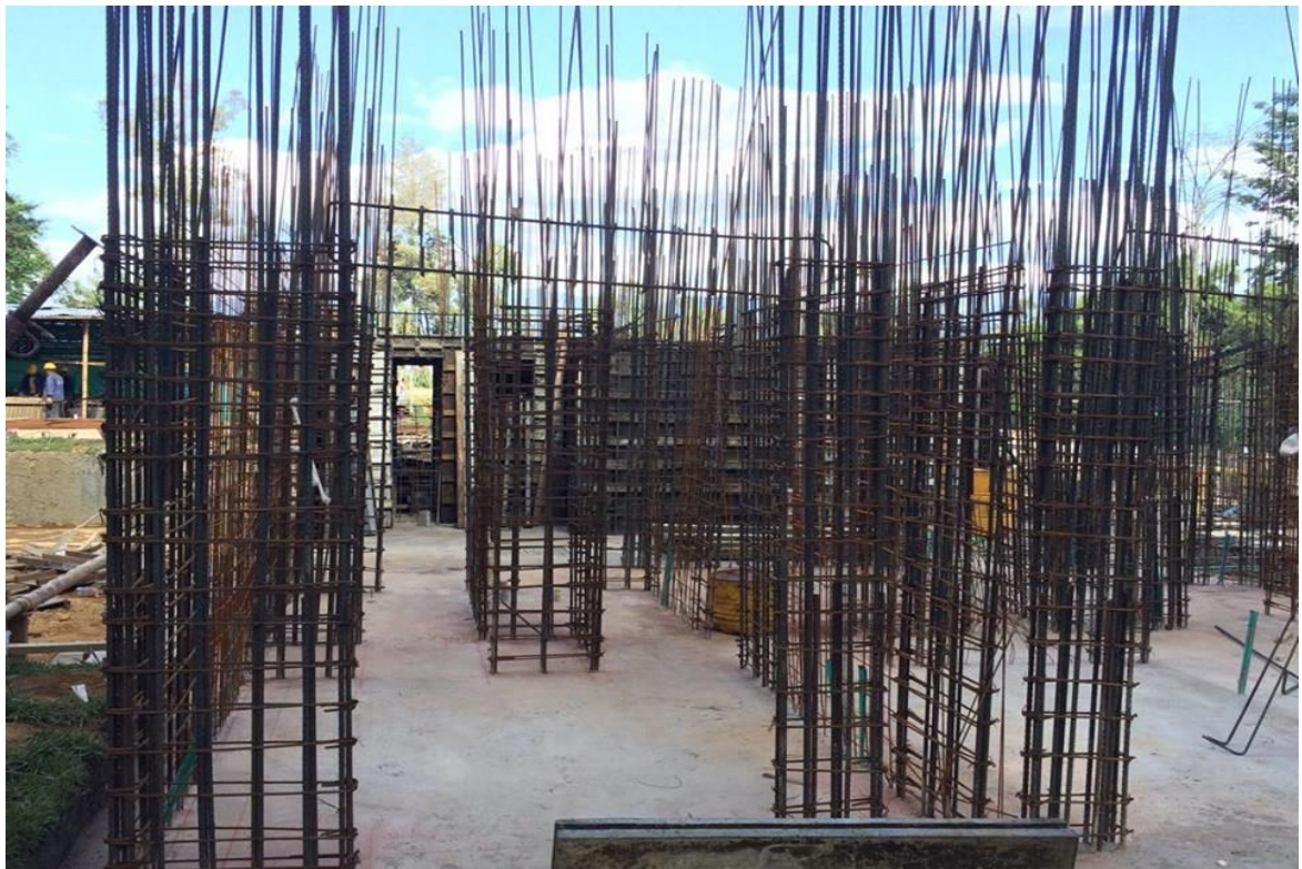
Figura No. 19 Refuerzo de muros estructurales
