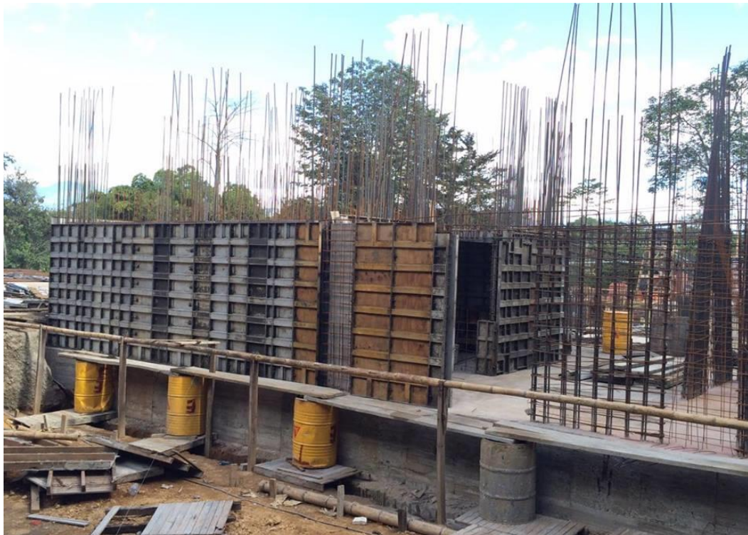
Figura No.24 Formaleta de muros.
