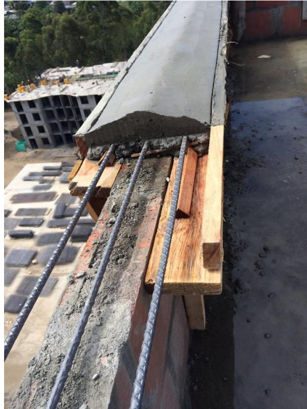
Figura No.30 Acero de refuerzo de la alfajía.
