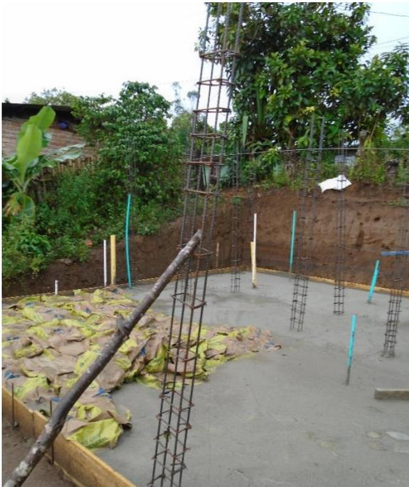
**Ilustración 20. Fundición y encofrado de columnas**
