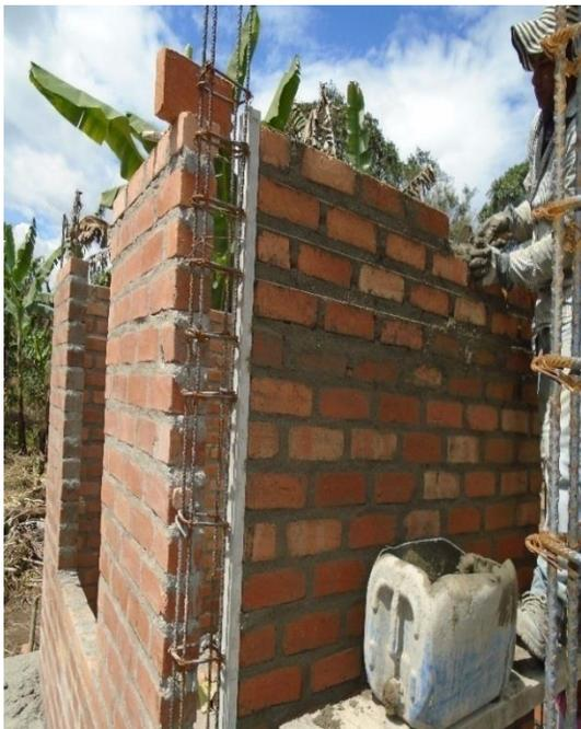
**Ilustración 16. Verificación plomo y limpieza de los muros**
