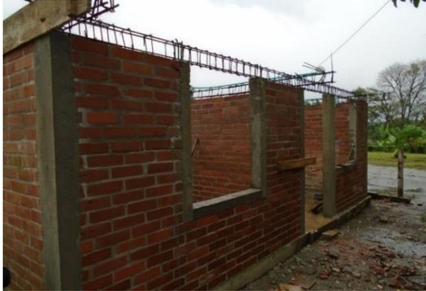
La formaleta de estas vigas fue en madera, con tablonces de 3 x 0.25 x 0.02 metros, correspondientes al largo, ancho y espesor respectivamente. Con estas dimensiones se garantiza que las columnas queden de 0.20 x 0.12 metros y su respectivo recubrimiento.
