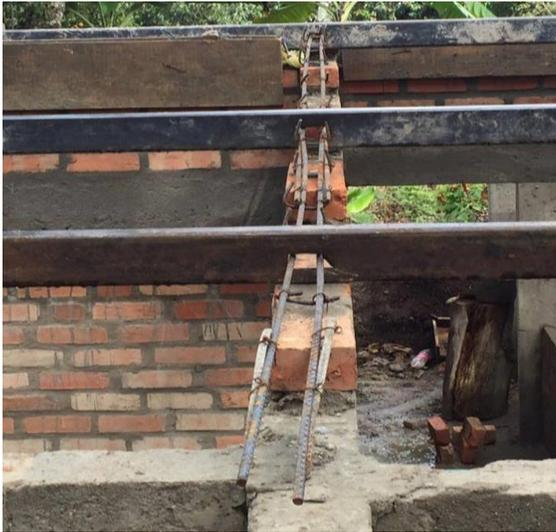
**Ilustración 27. Terminado de vigas cinta**
