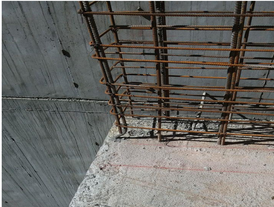
Figura N° 5: Elemento localizado y replantado.
