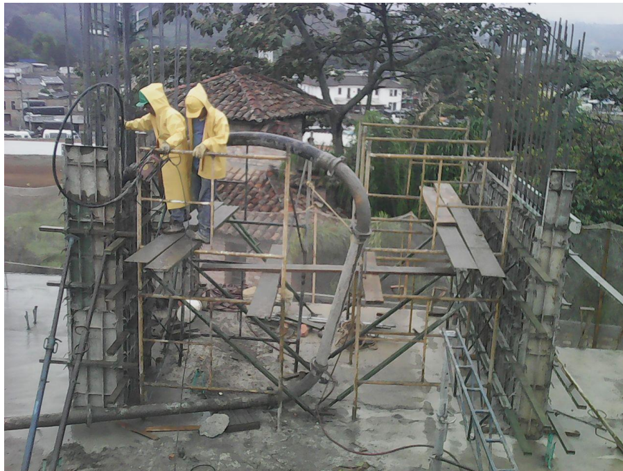
Figura N° 59: Fundición de elementos verticales
