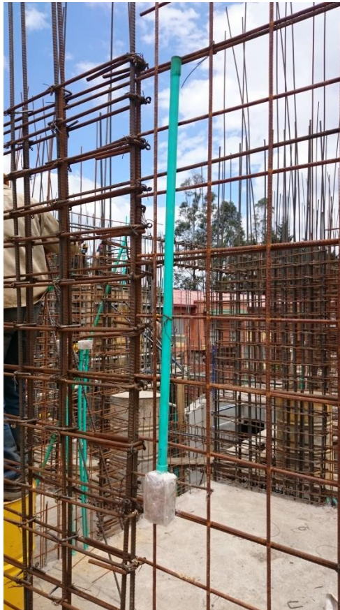
Figura N° 20: Tubería eléctrica para interruptores en pantallas.
