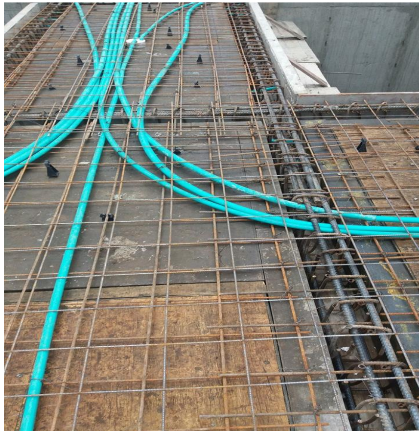
Figura N° 45: Acero en los pasillos.
