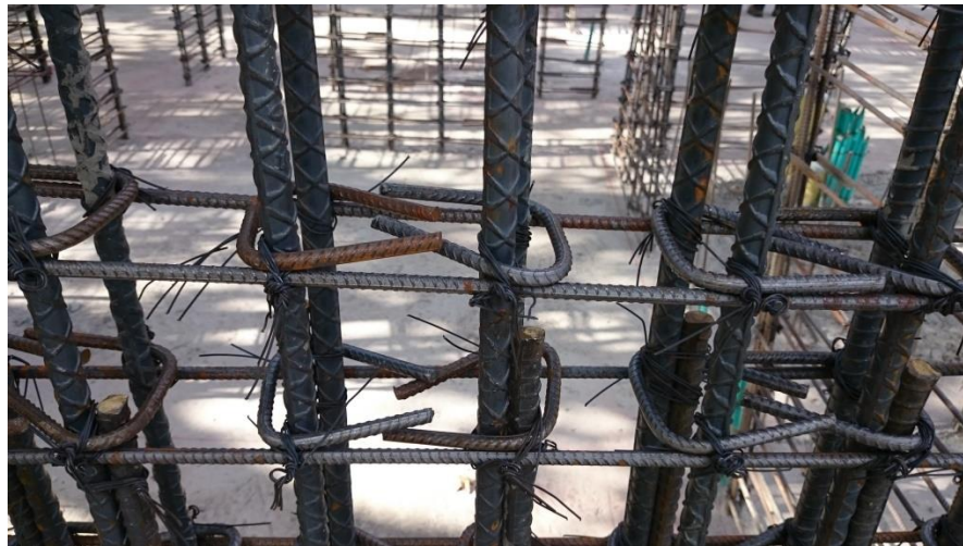
Figura N° 14: Elemento de borde con ganchos.
