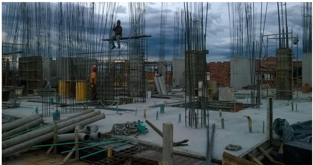
Figura N° 47: Estructura Proyecto VENEZIA en ejecución.
