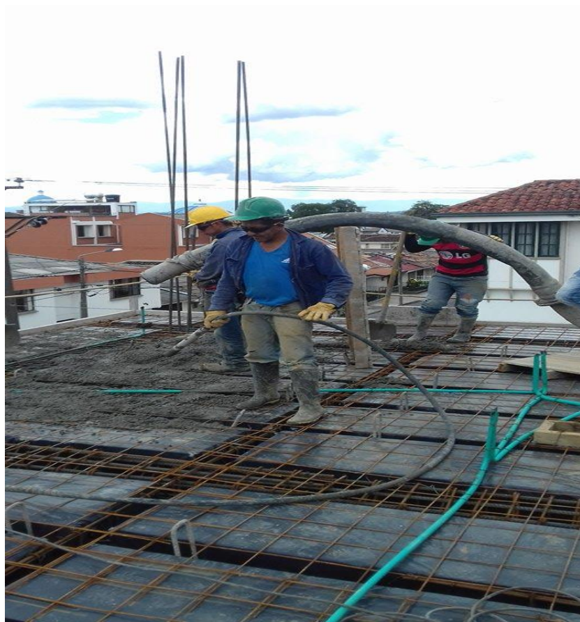
Figura N° 74: Malla electro soldada, refuerzo losa de compresión piso 3.
