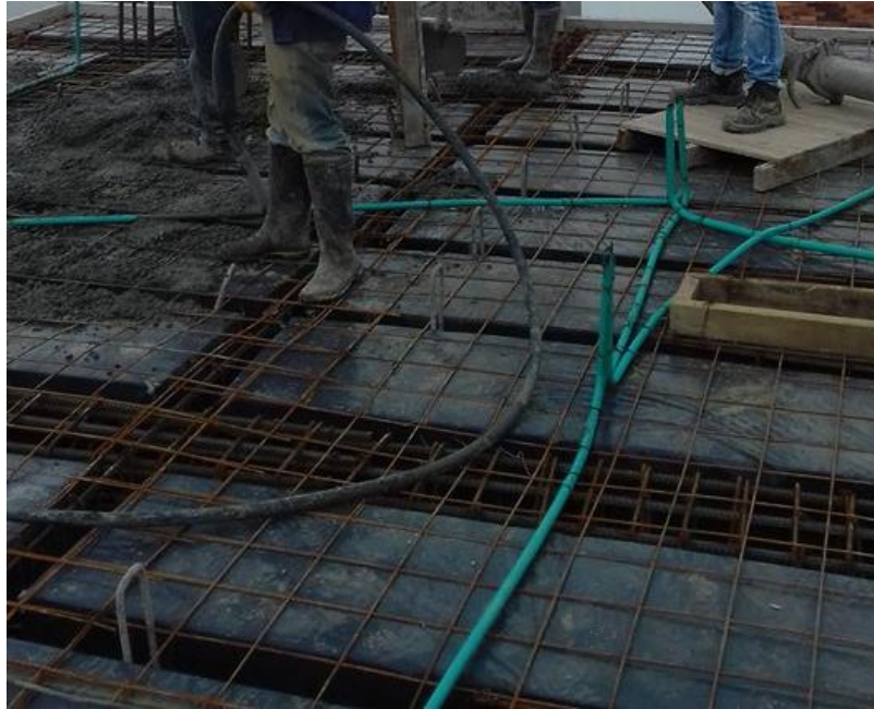
Figura N° 75: Tuberías de instalaciones eléctricas en losa.
