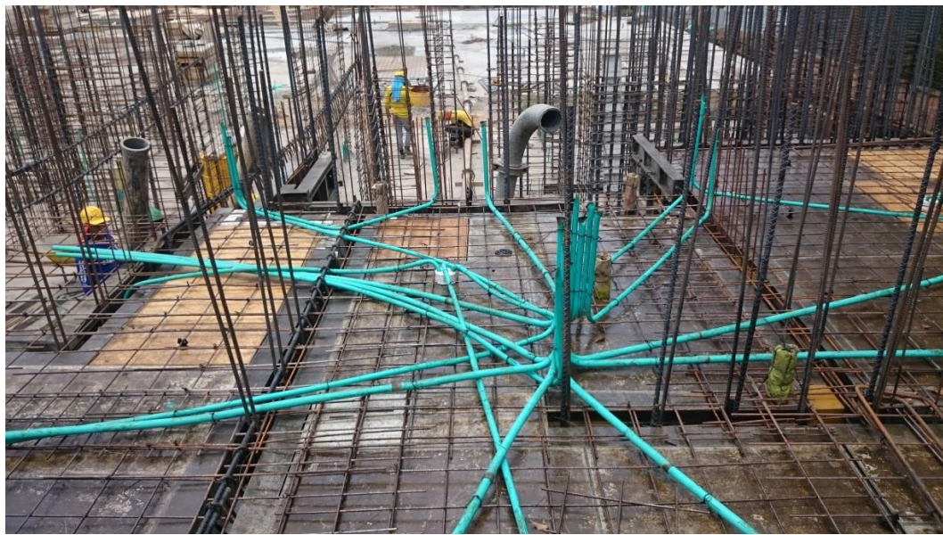
Figura N° 39: Tubería de instalaciones eléctricas losa de entrepiso.
