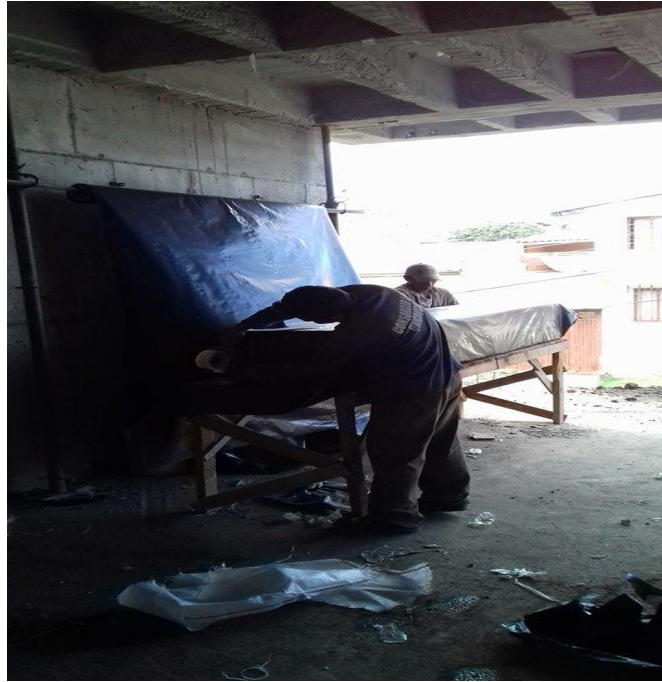
Figura N° 72: Arreglo de casetones.
