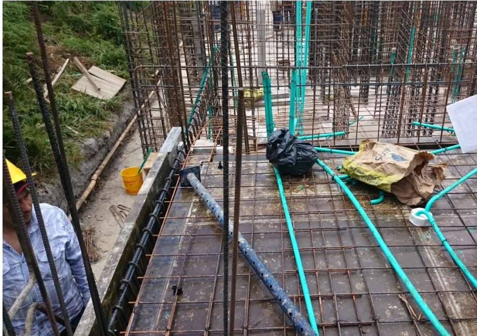
Figura N° 37: Malla inferior losa de entrepiso.
