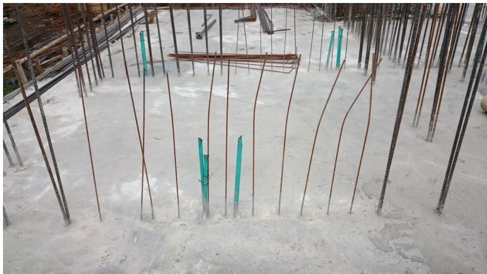
Figura N° 16: Grafil arranque de malla.
