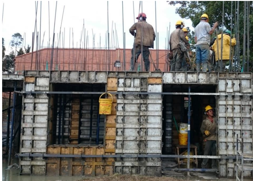
Figura N° 34: Figura FORSA, TORRES DE MILANO 1.
