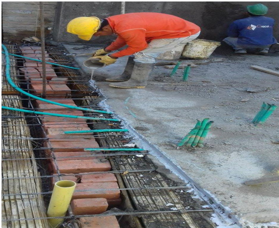
Figura N° 77: Aplicación SIKADUR 32 Primer.
