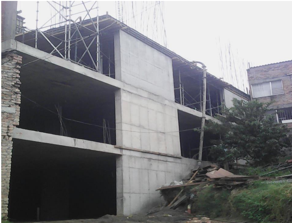
Figura N° 64: Entarimado estructura piso 1.
