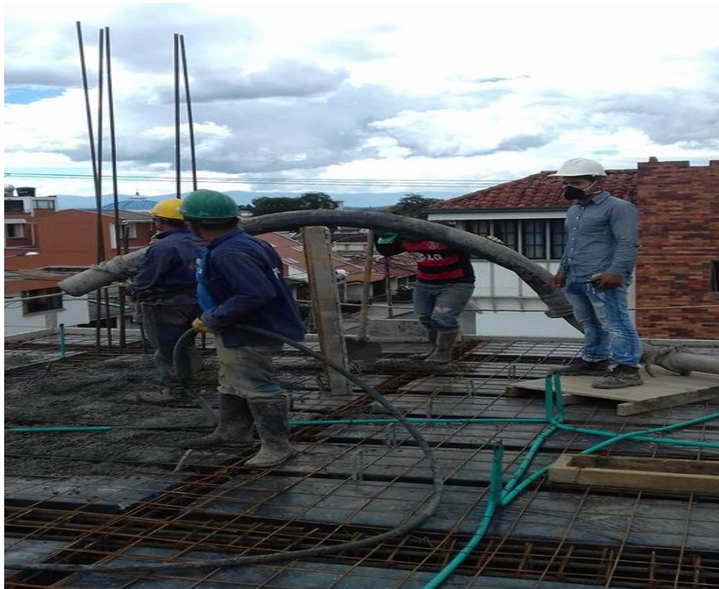
Figura N° 78: Fundición losa aligerada piso 3.
