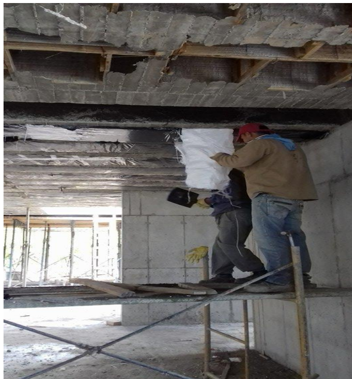
Figura N° 71: Recuperación de los casetones de Icopor.
