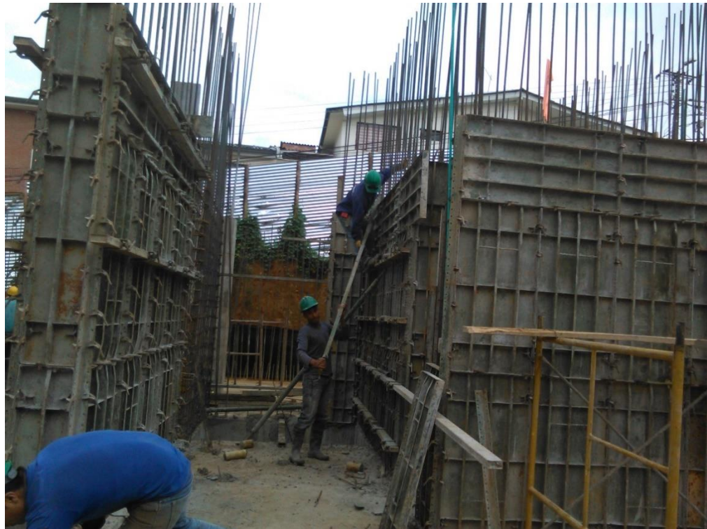
Figura N° 55: Formaleta de pantallas.
