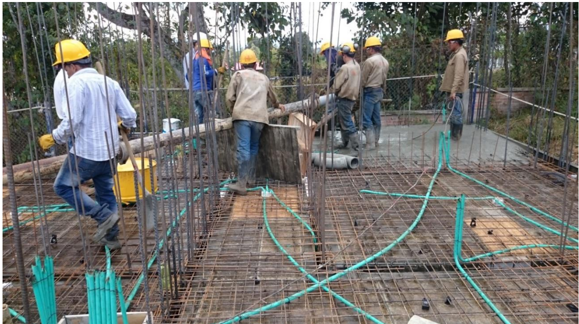
Figura N° 42: Fundición, malla superior instalada.
