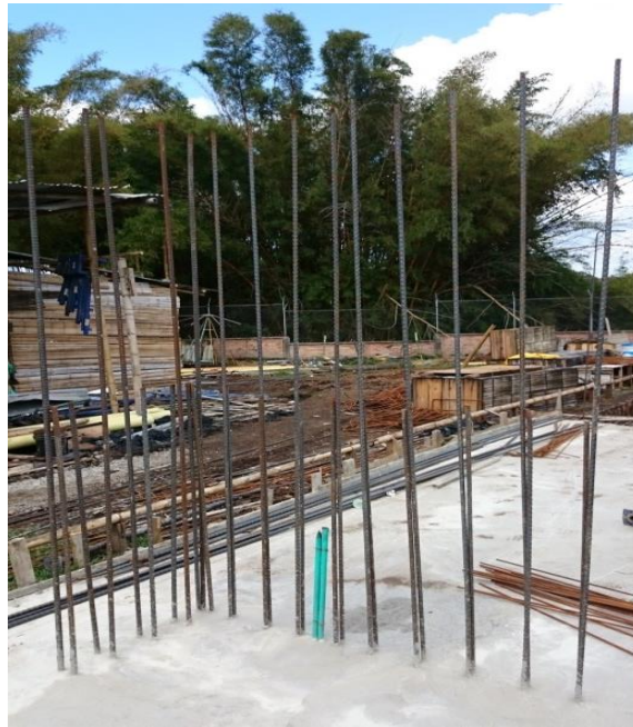
Figura N°7: Acero de arranque elementos de borde.
