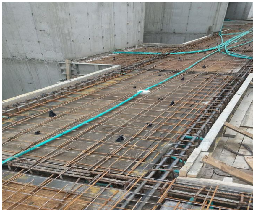
Figura N° 46: Pasillo preparado para ser fundido.
