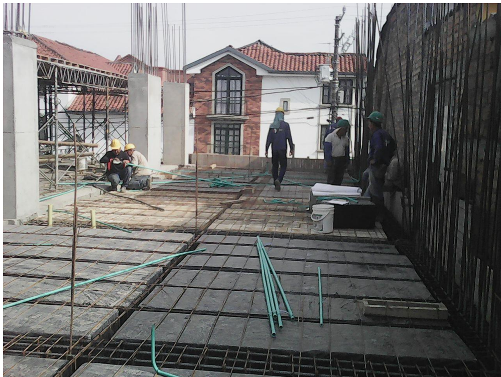
Figura N° 73: Grafiles, refuerzo losa de compresión piso 2.
