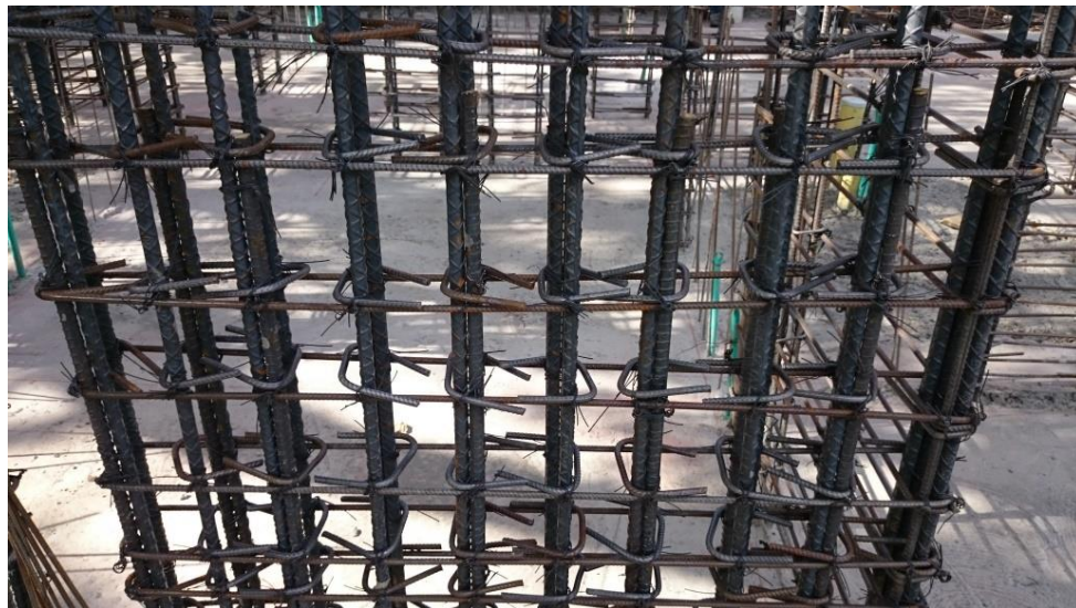
Figura N° 12: Elemento de borde con estribos.
