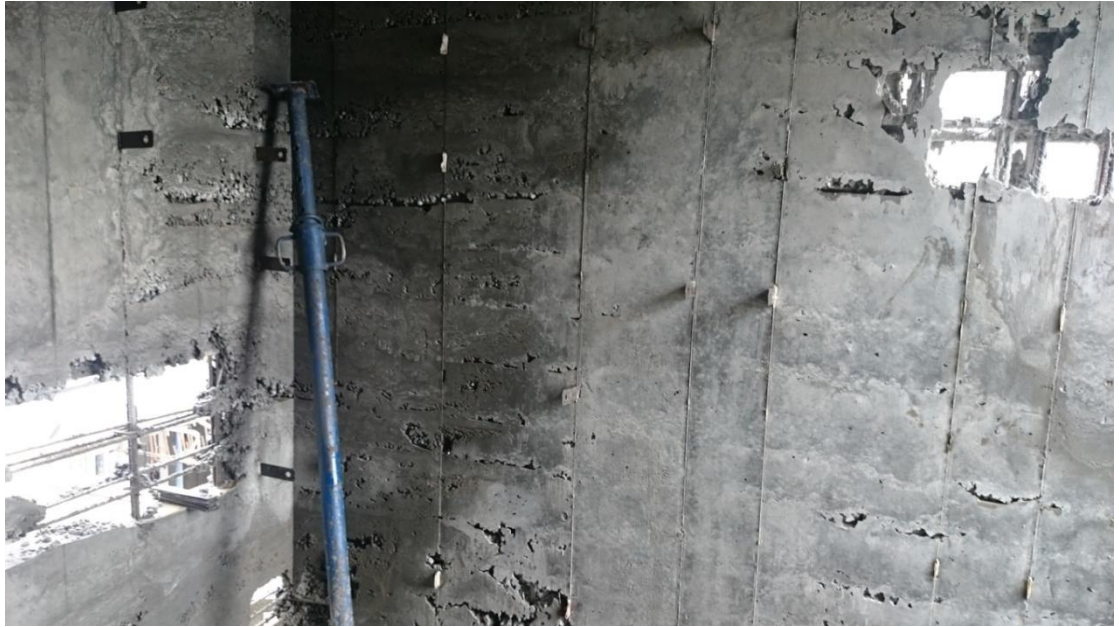
Figura N° 43: Error en fundición 1.
