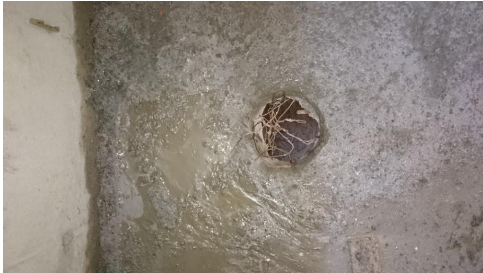
Figura N° 40: Pase circular para sifón.
