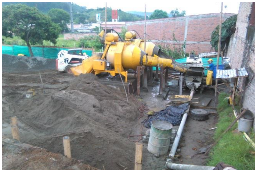
Figura N° 62: Mezcladoras, bomba estacionaria y tubería.
