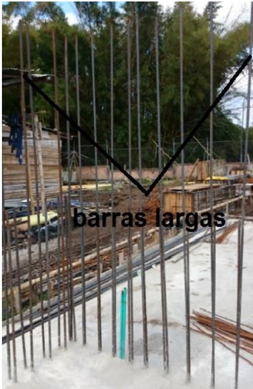
Figura N° 9: Barras largas elemento.
