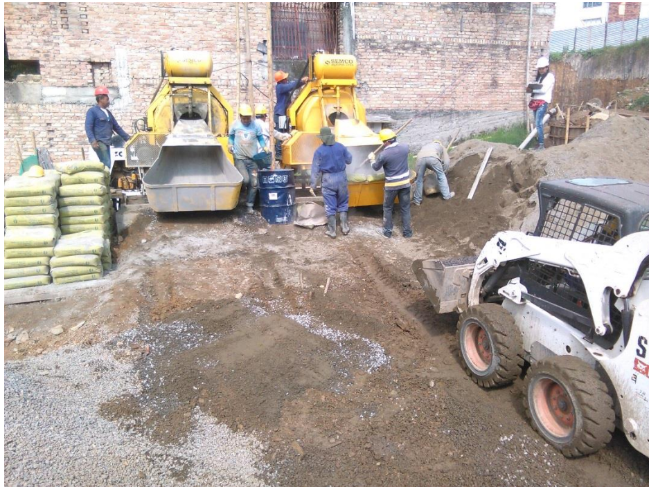
Figura N° 60: Dosificación de concreto.
