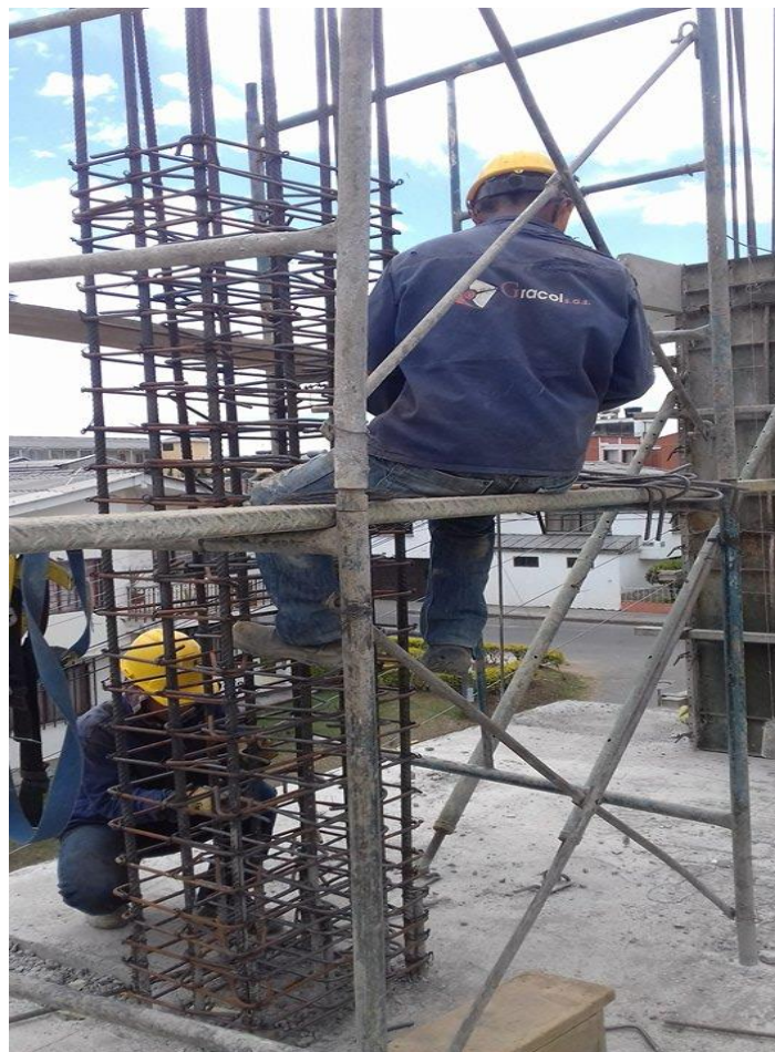
Figuras N° 52: Amarre de aceros en columnas.
