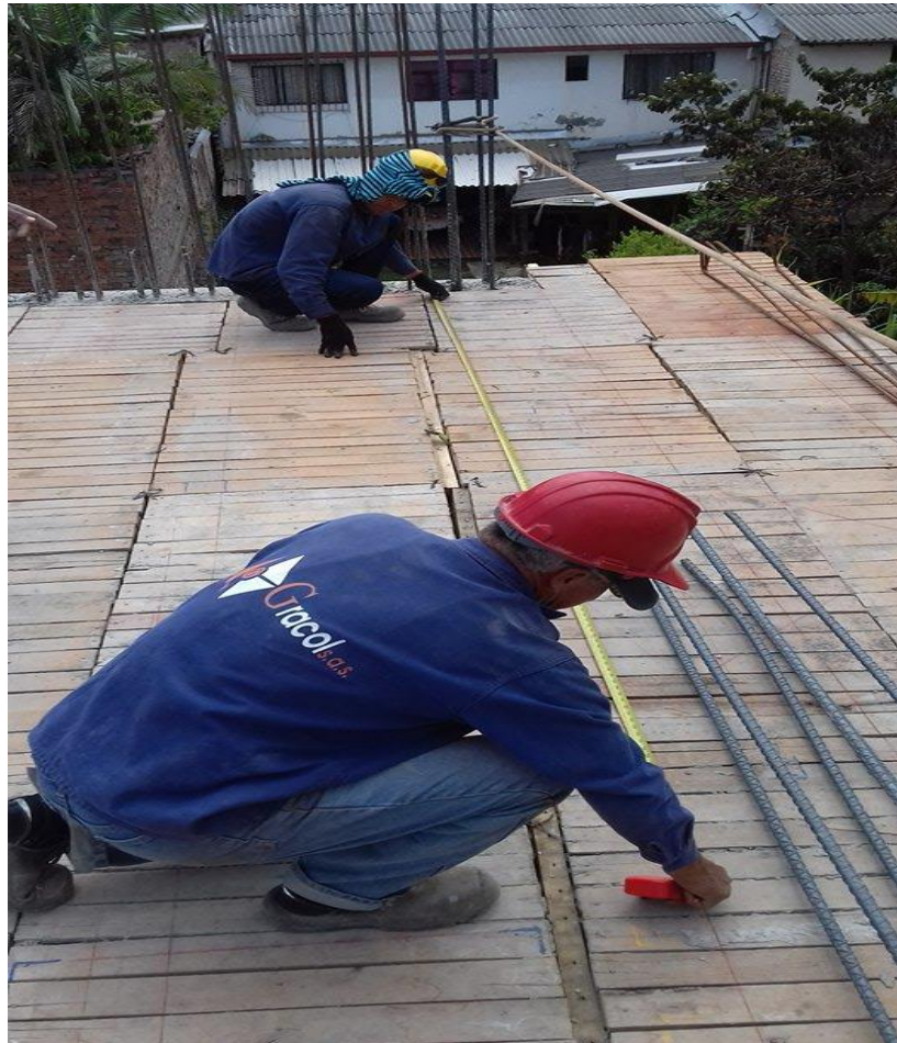
Figura N° 65: Localización y replanteo de los elementos de la losa aligerada.
