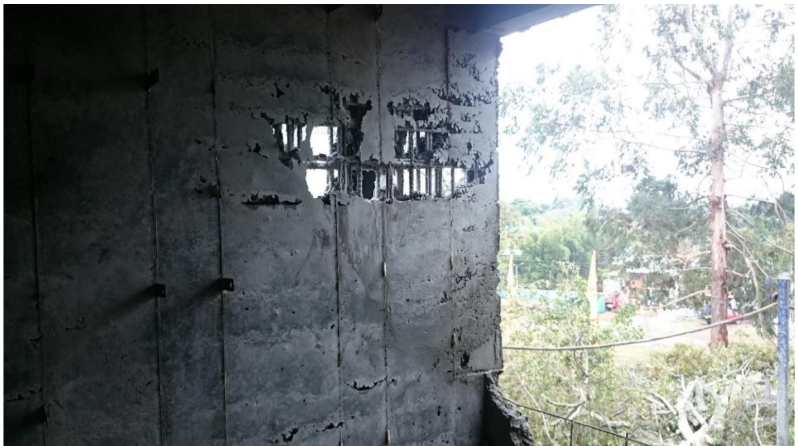
Figura N° 44: Error en fundición 2.
