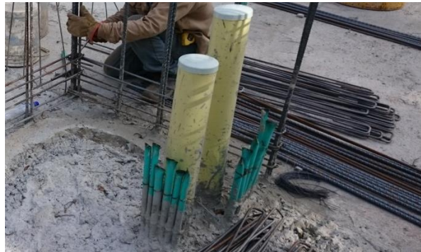
Figura N° 18: Tubería instalada en la losa de cimentación.
