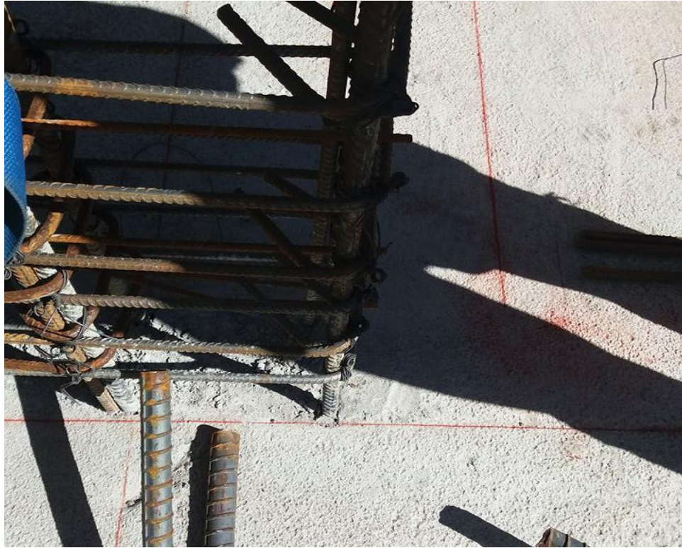
Figura N° 49: Replanteo y trazos para localización de elementos verticales.
