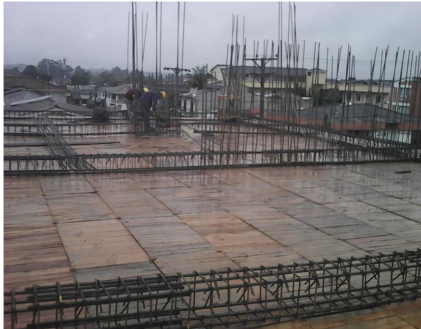
Figura N° 68: Acero para vigas y viguetas de la losa aligerada
