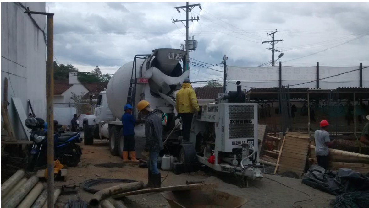
Imagen 42. Camión mezclador de GeoAcopio enviado el premezclado a la bombeadora de concreto.
