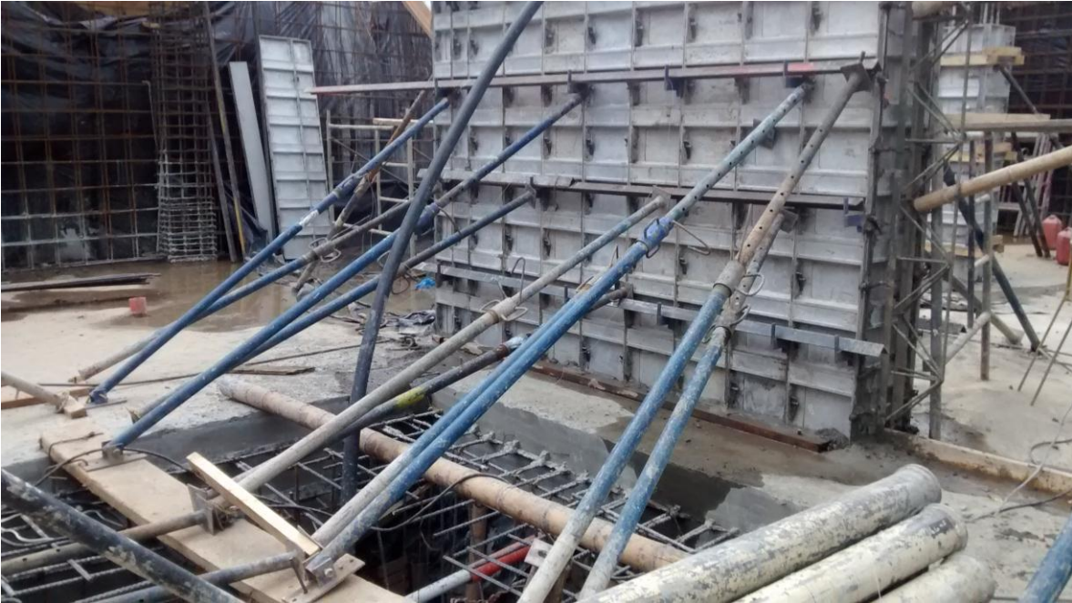
Imagen 52. Apuntalamiento del encofrado de pantallas.
