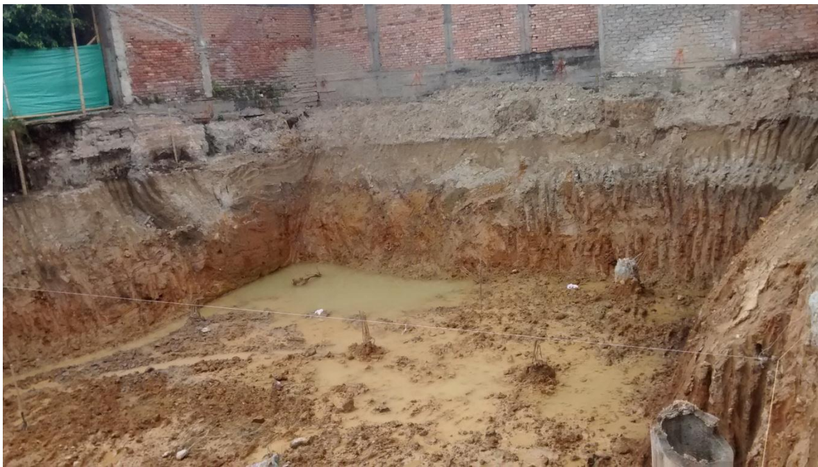
Imagen 14. Fin de la excavación parte trasera del sótano, con aguas freáticas bombeadas casi en su totalidad.
