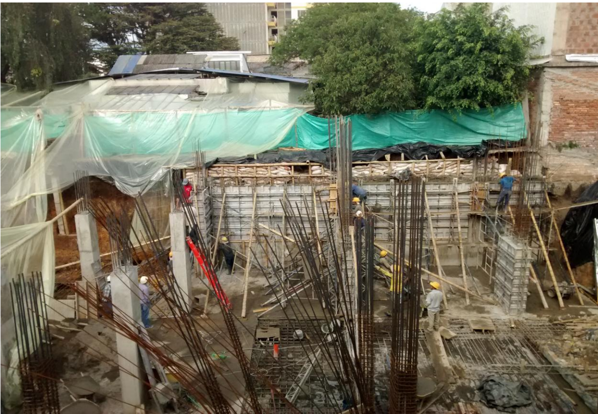
Imagen 72. Muro de saco-suelo construido detrás de pantalla de contención.
