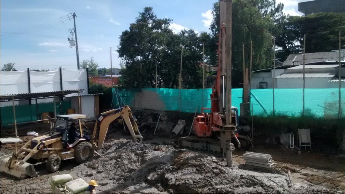
Imagen 2. Excavación y vaciado de pilotes.
