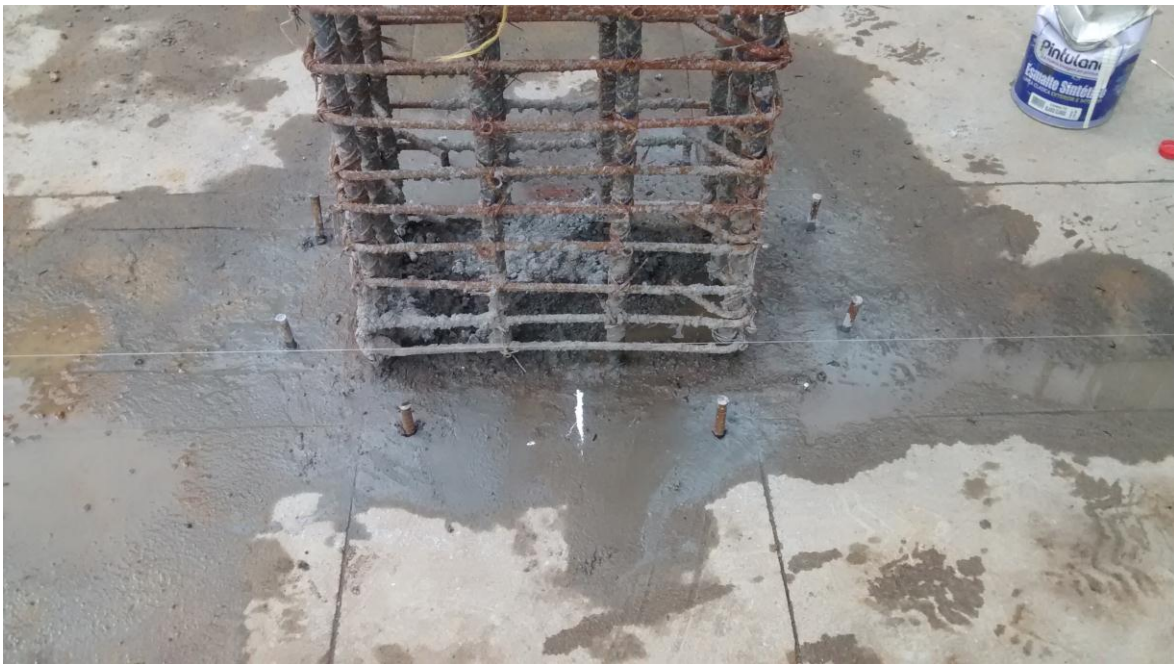
Imagen 45. Colocación de pines alrededor del castillo de refuerzo de la columna.
