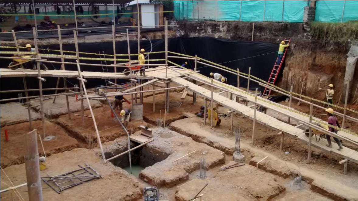
Imagen 25. Excavaciones de las zanjas para vigas de cimentación. En el centro se encuentra la excavación para el pozo evector.
