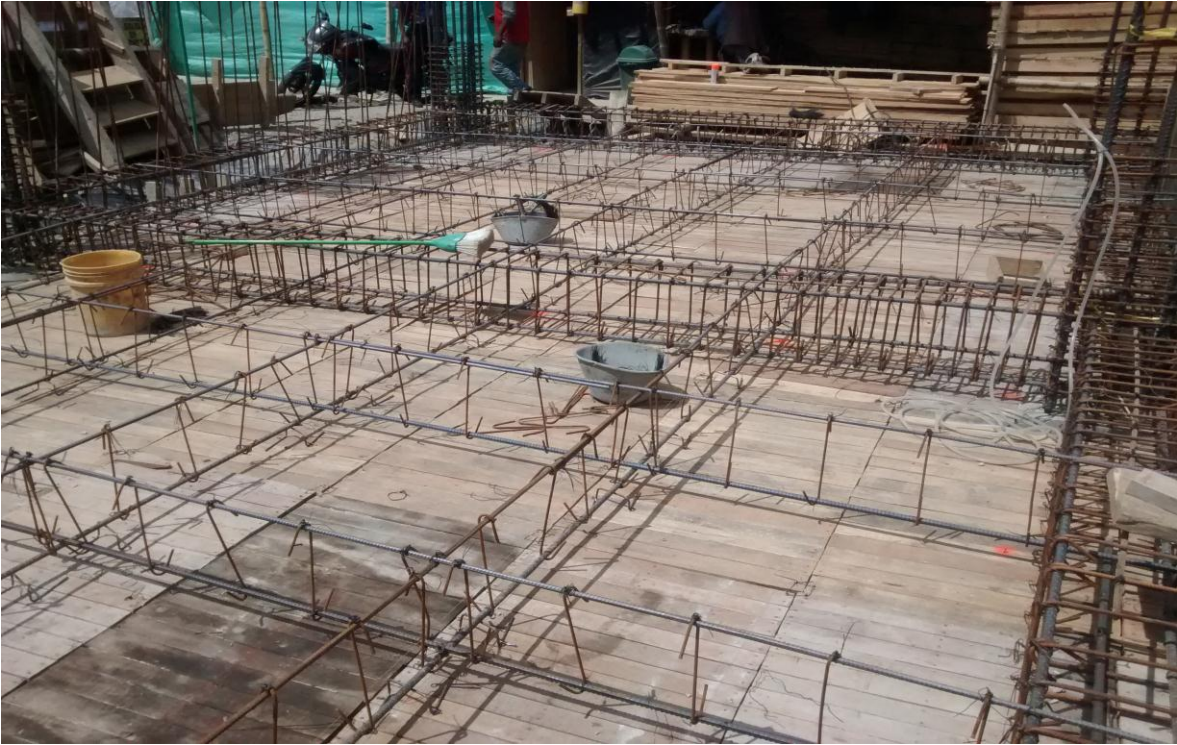
Imagen 63. Armado de refuerzo de la losa aligerada del primer piso
