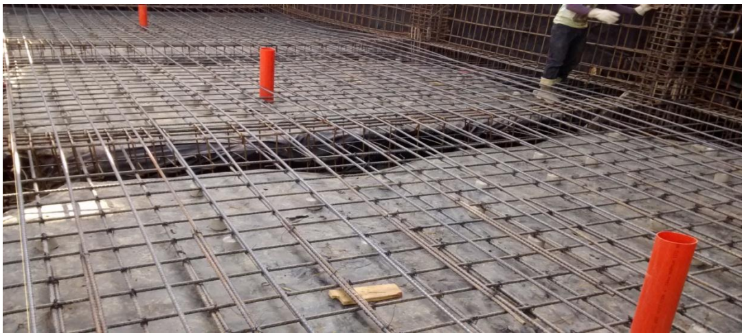
Imagen 34. Mala colocación del refuerzo de la losa de cimentación, pasando por encima de las vigas de amarre.
