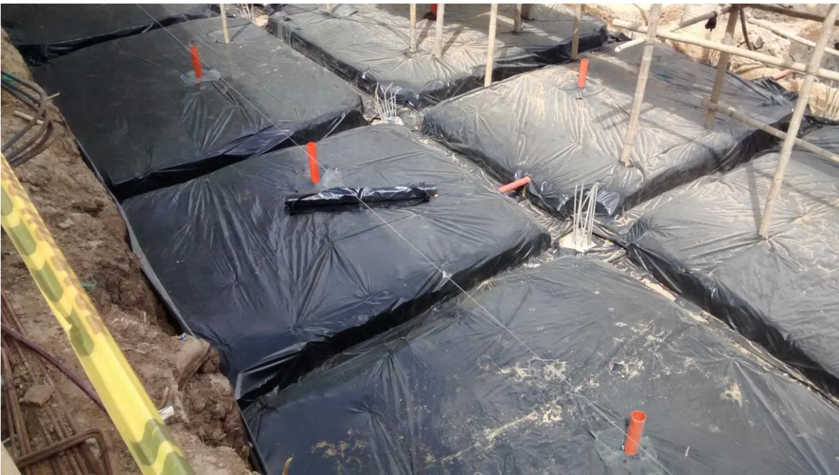
Imagen 26. Protección del subsuelo de fundación con plástico.
