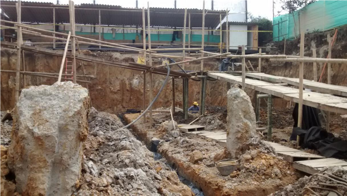
Imagen 16. Pilotes sobresaliendo del fondo de excavación.
