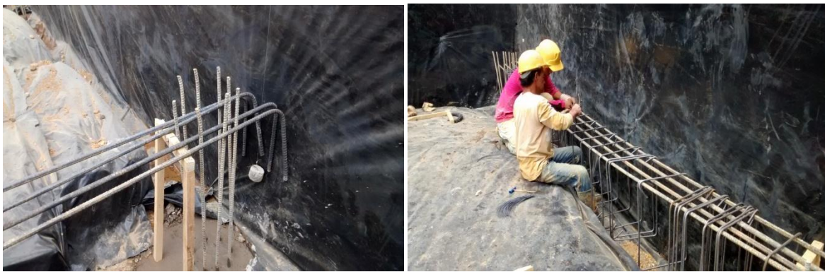
Imagen 28. Armado del refuerzo de vigas de cimentación. A la izquierda, montaje del refuerzo superior con el apoyo llamado coloquialmente "burro". A la derecha, montaje de estribos.
