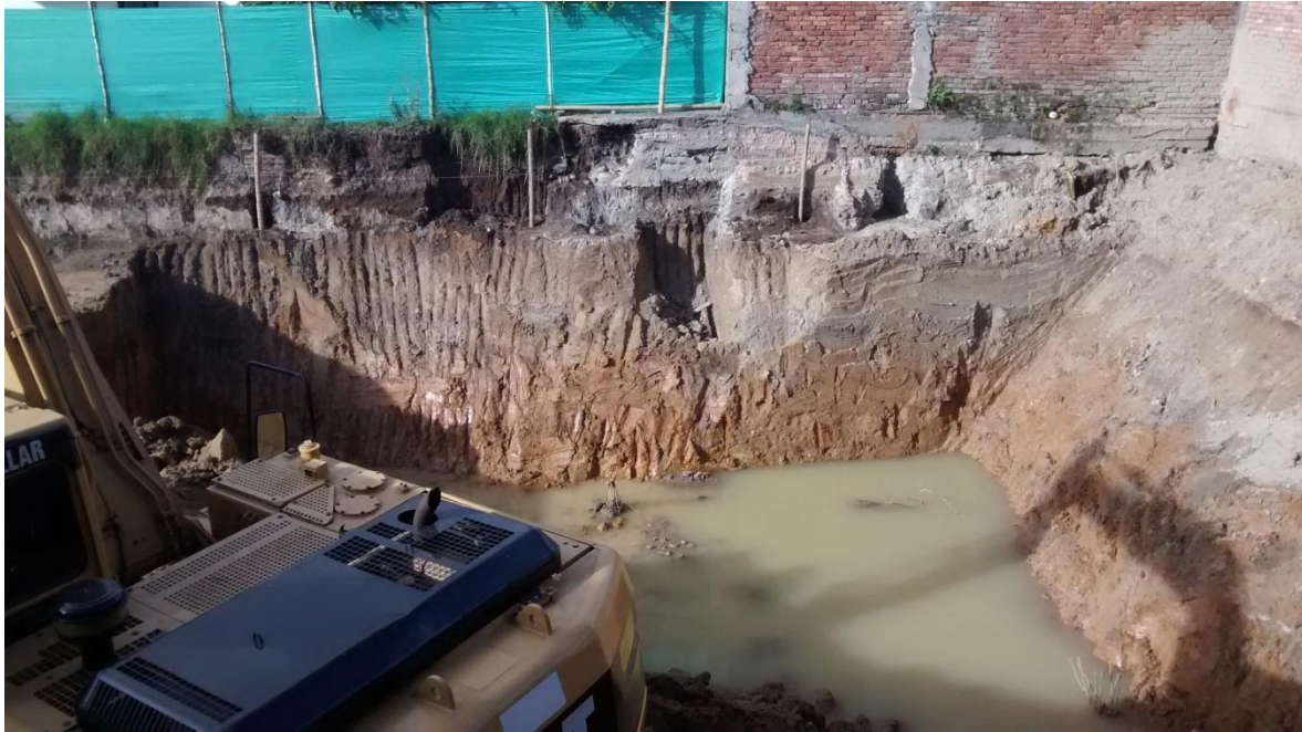
Imagen 13. Taludes de la excavación, la cual se empieza a inundar con aguas del nivel freático.
