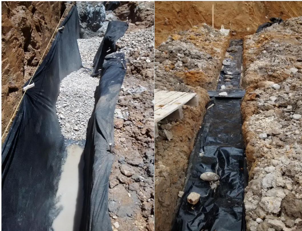
Imagen 19. Drenajes construidos con material granular y geotextil.
