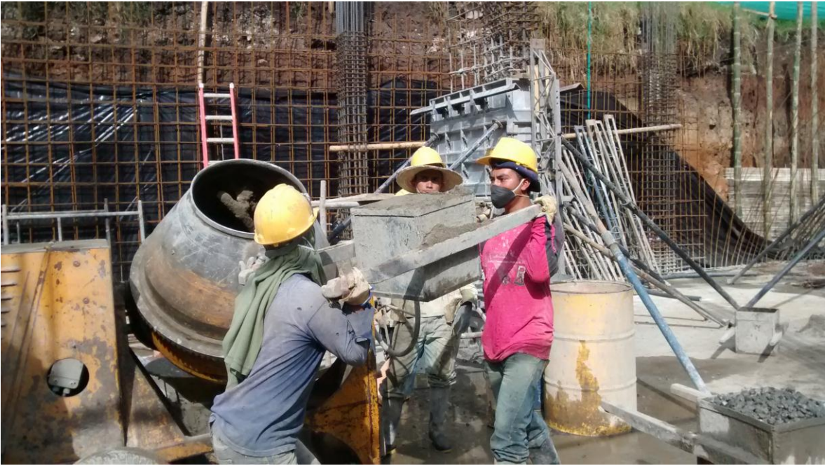
Imagen 50. Transporte de arena por "cajonados".
