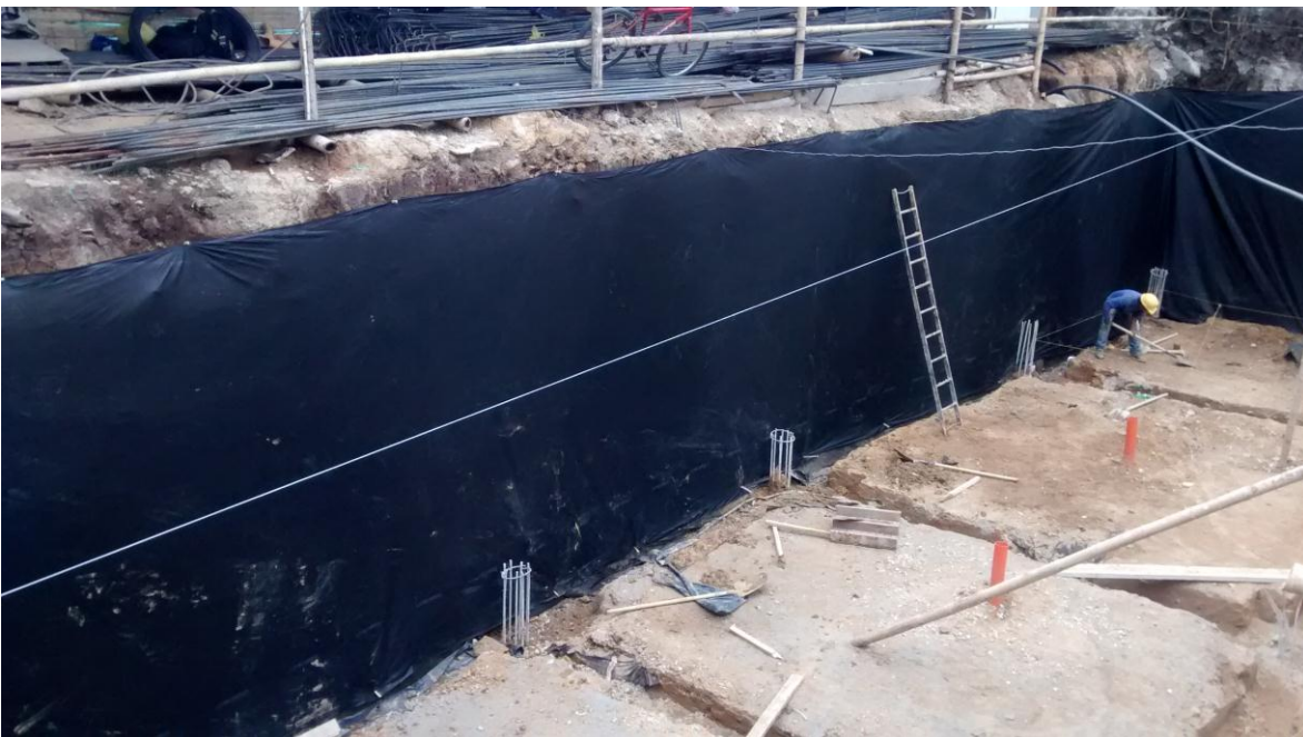
Imagen 24. Protección de los taludes de la excavación con geotextil.
