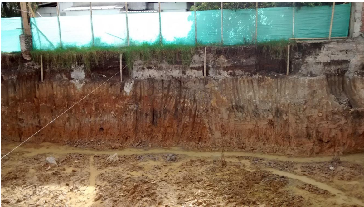
Imagen 15. Excavación en los linderos libres del sótano.
