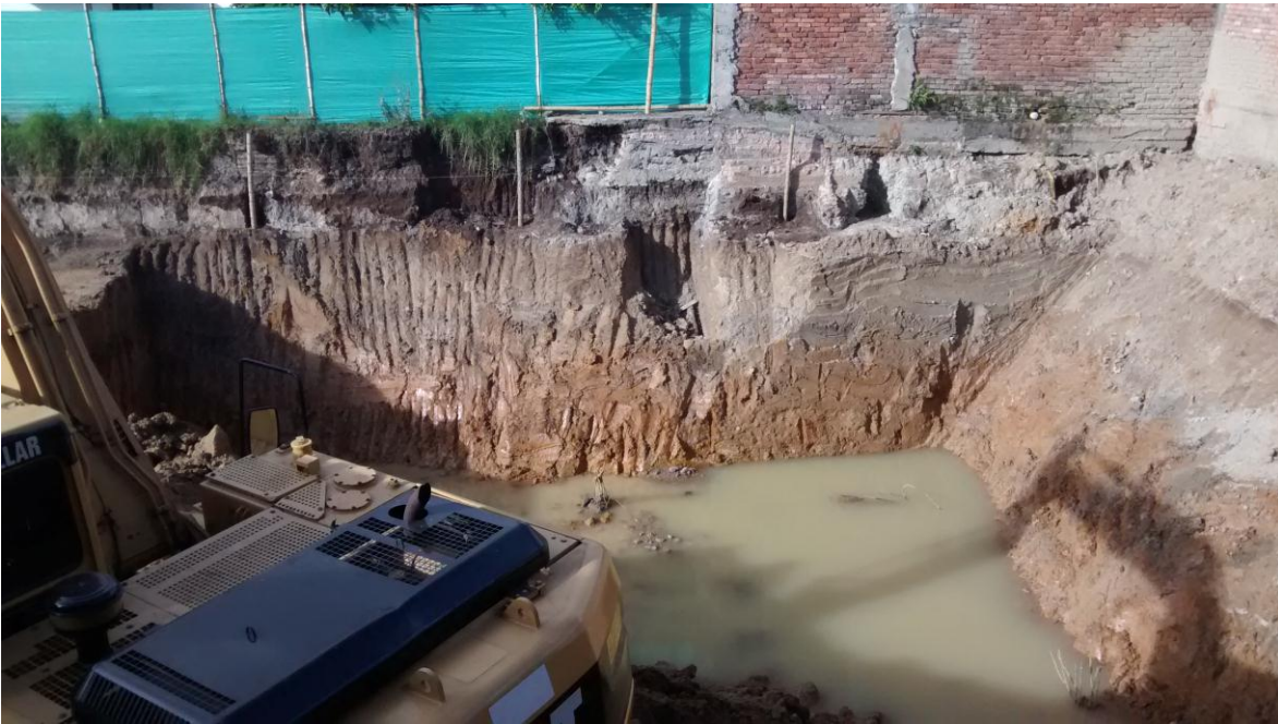
Imagen 6. Taludes en excavación
