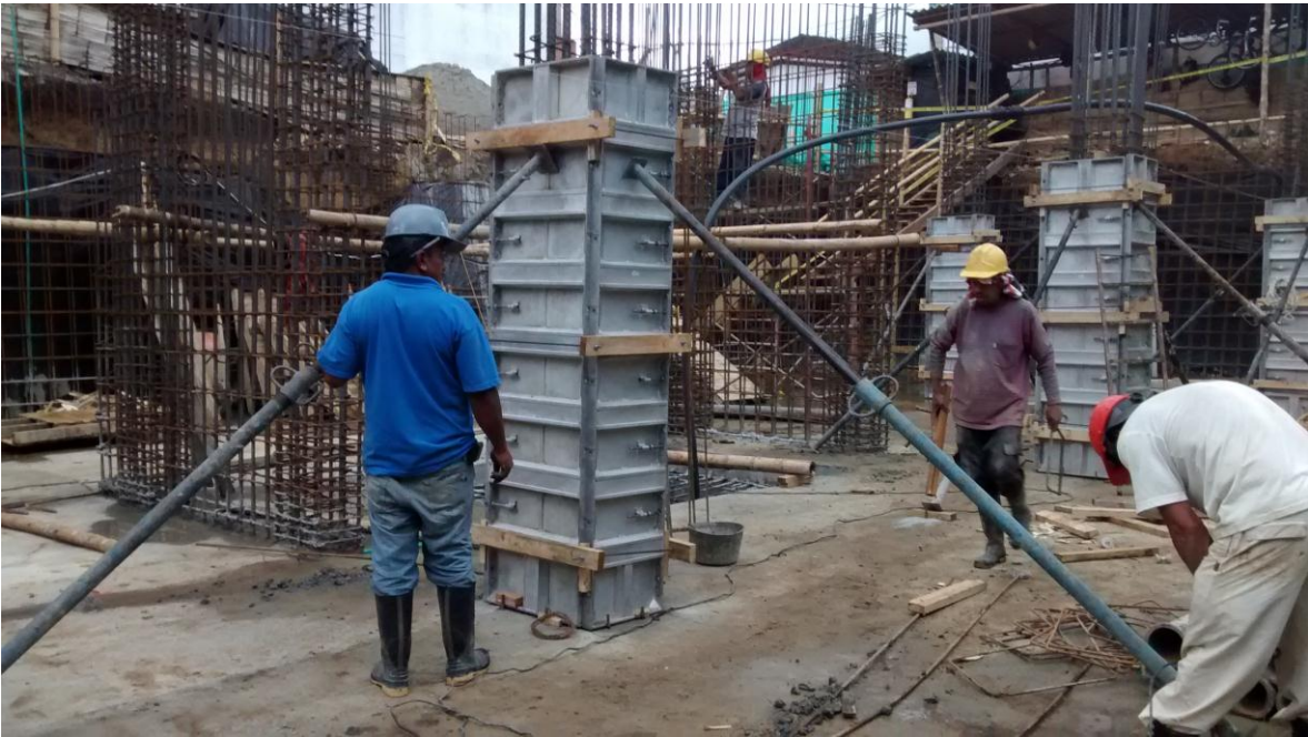
Imagen 47. Apuntalamiento de formaletas con gatos.
