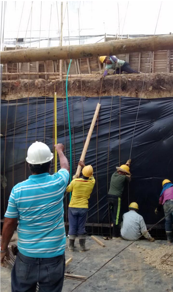
Imagen 36. Comprobación de verticalidad del refuerzo de pantalla.
