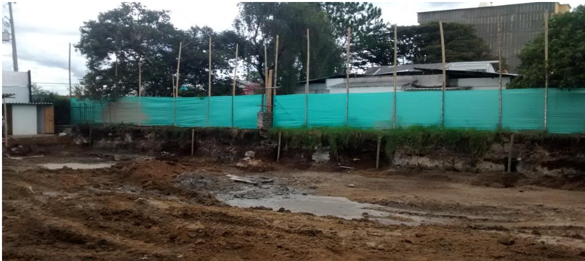
Imagen 10. Estado del terreno el día del inicio de la excavación con 80 cm menos de suelo debido a excavación previa al vaciado de pilotes. Para la localización de los linderos se ubicaron varios tacos de guadua unidos con nylon, que forman un cerco que delimita hasta donde se debe hacer la excavación.
