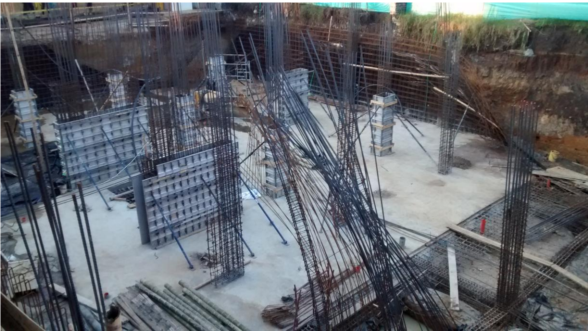
Imagen 53. Losa de cimentación fundida hasta el eje 5.
