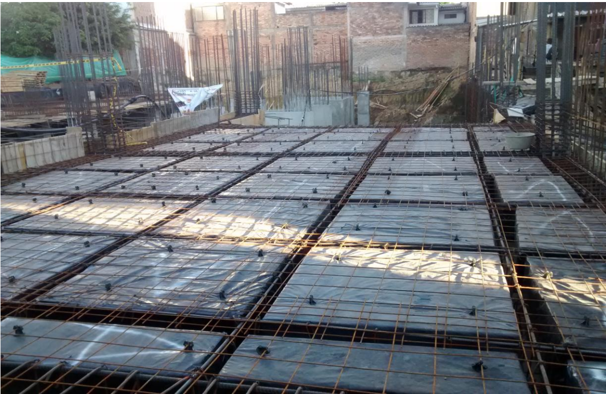
Imagen 66. Losa aligerada de acceso a la rampa, lista para el vaciado con concreto,
