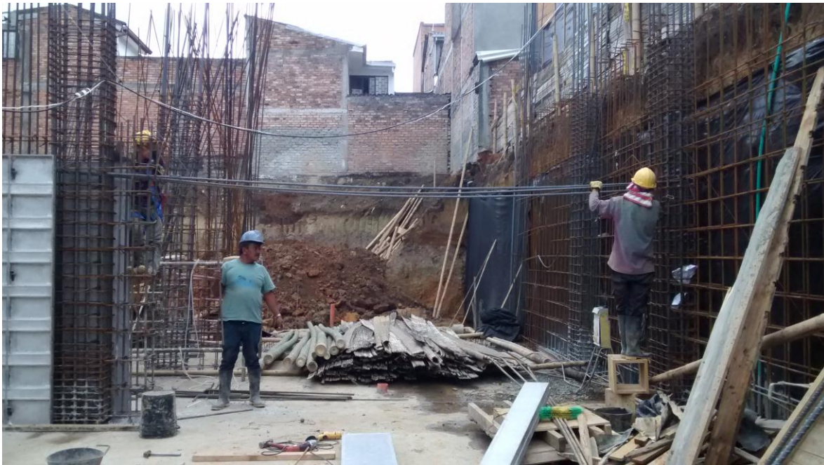
Imagen 55. Armado de refuerzo de vigas de la rampa.
