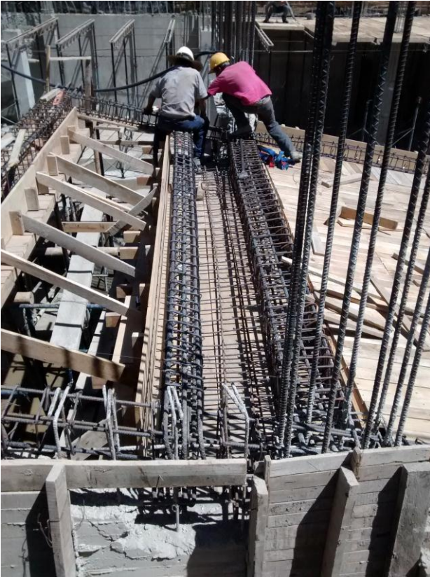
Imagen 57. Construcción de viga-canal en rampa.
