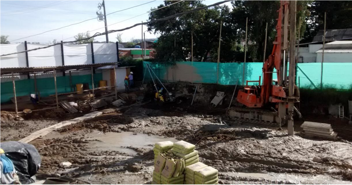
Imagen 1. Excavación y vaciado de pilotes.
