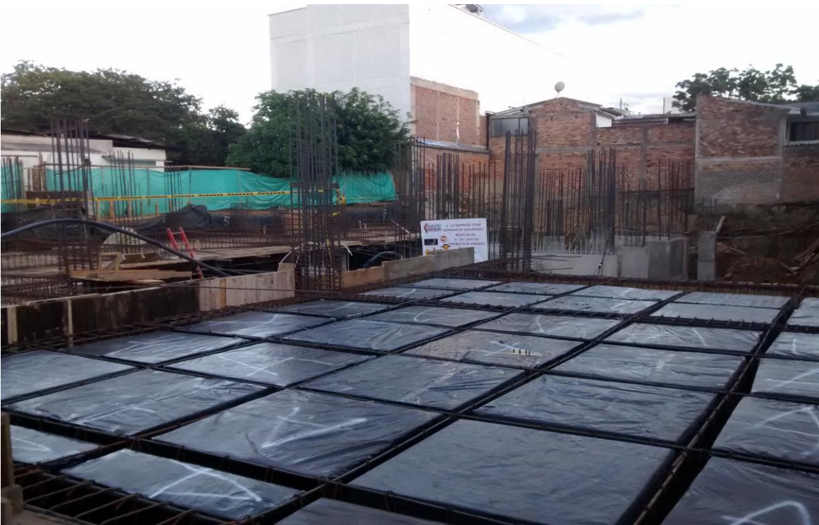
Imagen 64. Losa aligerada con casetones de icopor puestos en su sitio.
