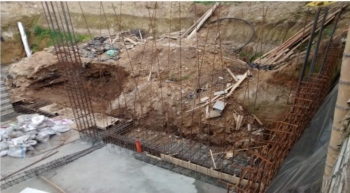
Imagen 58. Inicio de refuerzo de la rampa.
