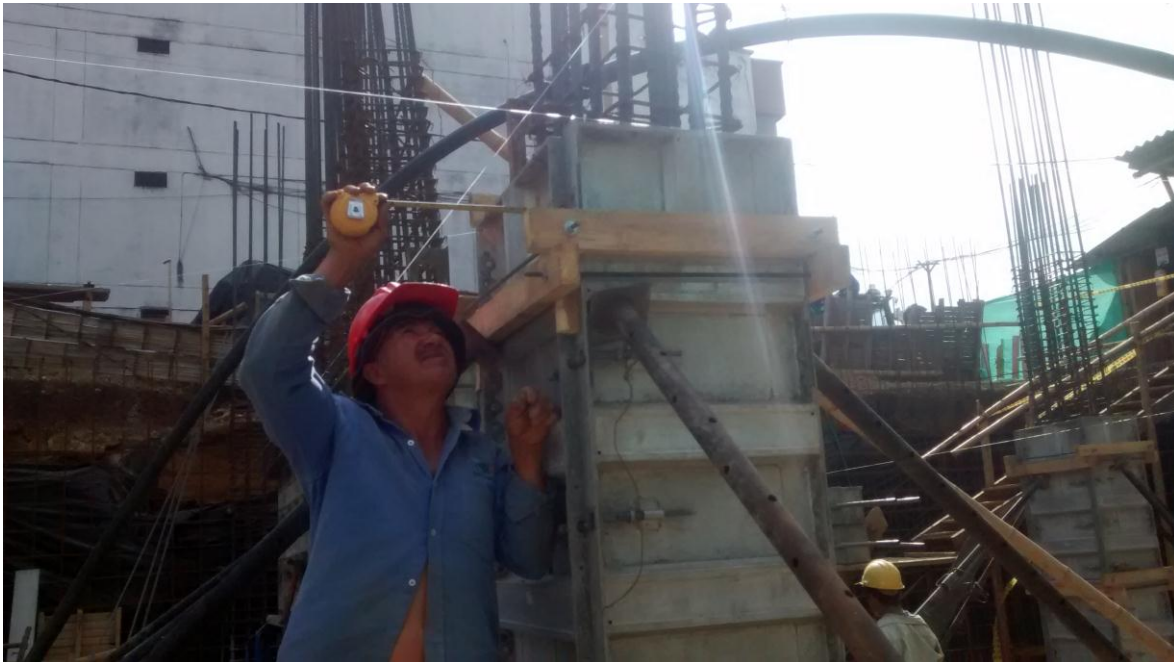
Imagen 48. Comprobación del alineamiento de las columnas de una misma fila midiendo con el metro la distancia de la cara de la columna al hilo extendido.
