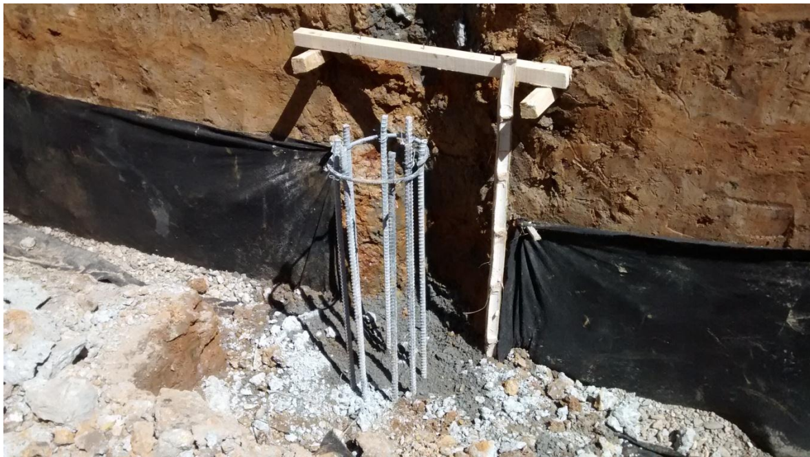
Imagen 21. Pilote descabezado junto con caballete para replanteo de ejes de vigas.
