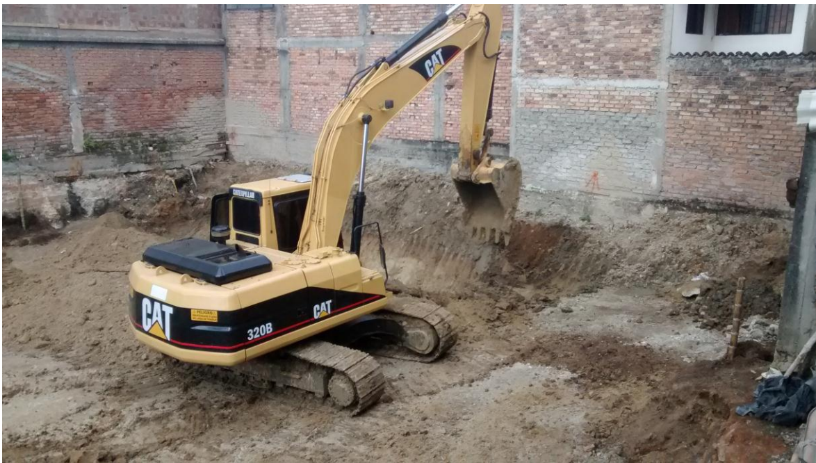
Imagen 12. Inicio de excavación en sótano.
