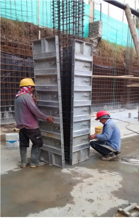
Imagen 46. Colocación de formaleta Forsa.
