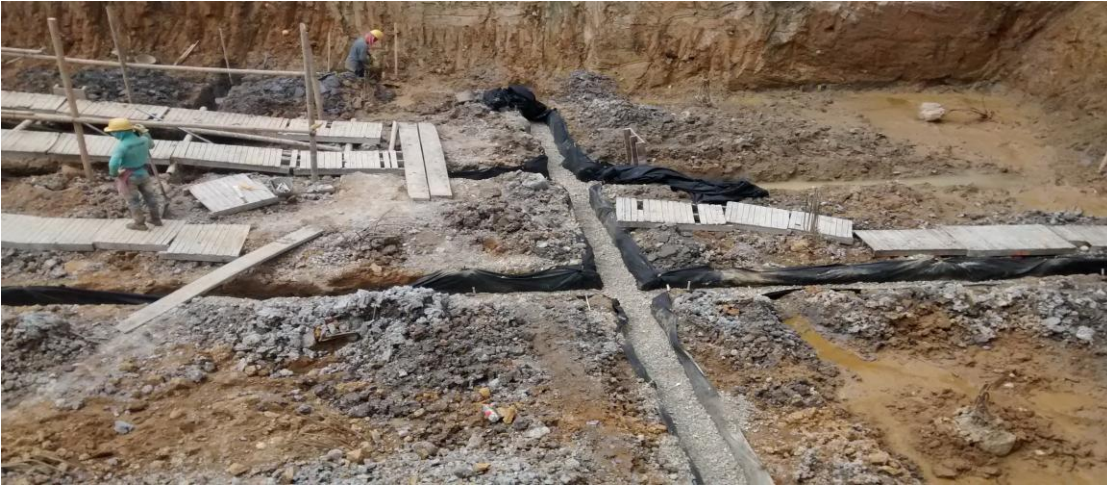
Imagen 18. Drenajes construidos con material granular y geotextil.
