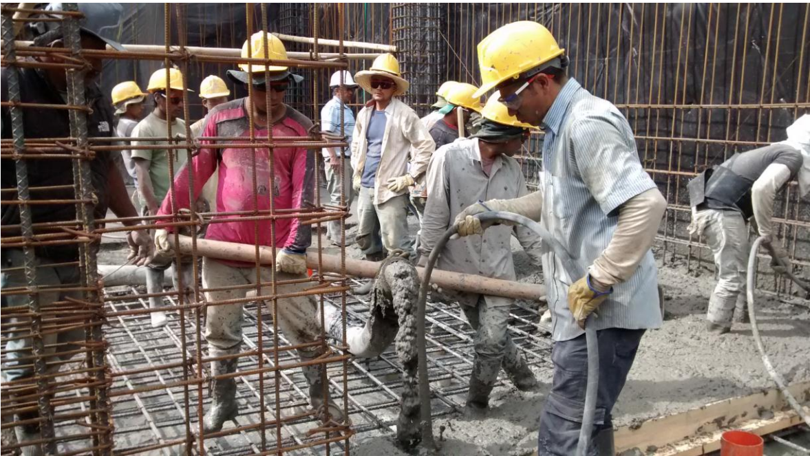
Imagen 44. Fundición de la losa.
