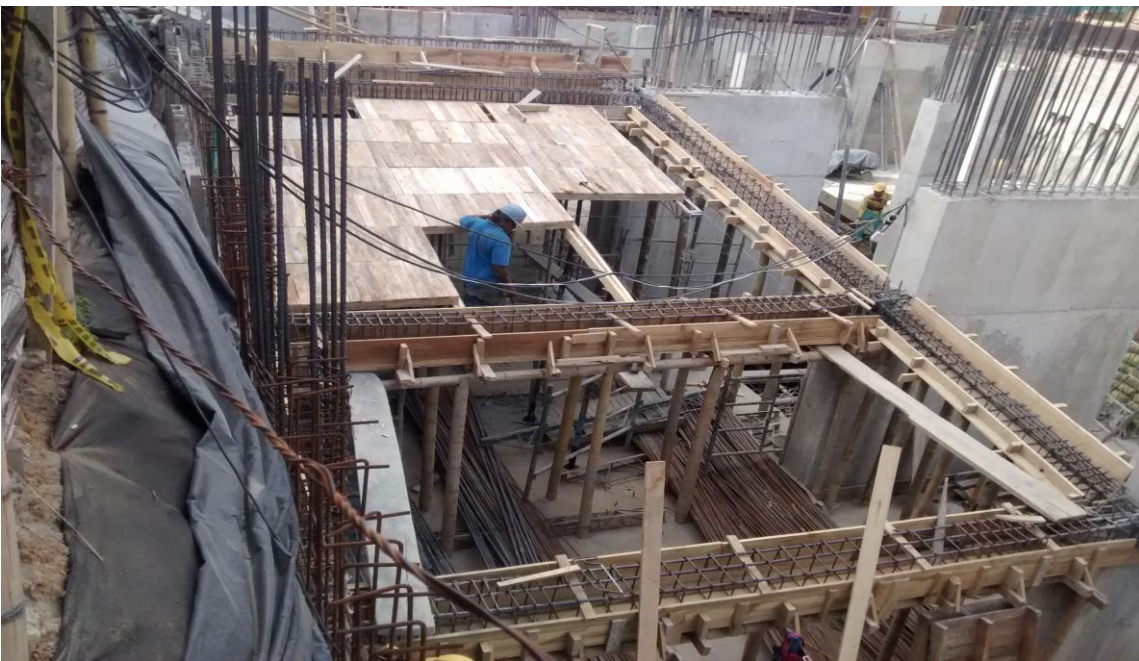
Imagen 60. Encofrado de las vigas y la losa de la rampa.
