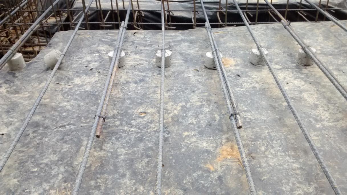
Imagen 33. Traslapos alternados en refuerzo de losa de cimentación.
