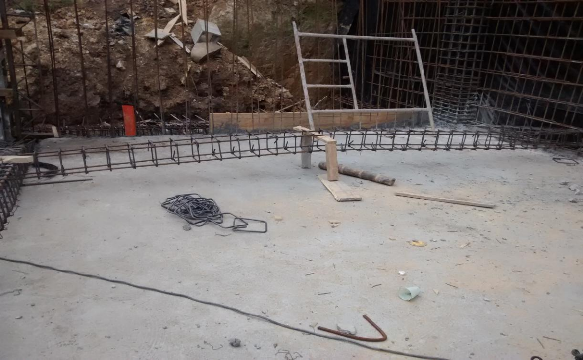
Imagen 59. Armado de vigueta auxiliar para encausar más abajo el refuerzo de inicio de la rampa. Atrás se visualiza el mencionado refuerzo de inicio.
