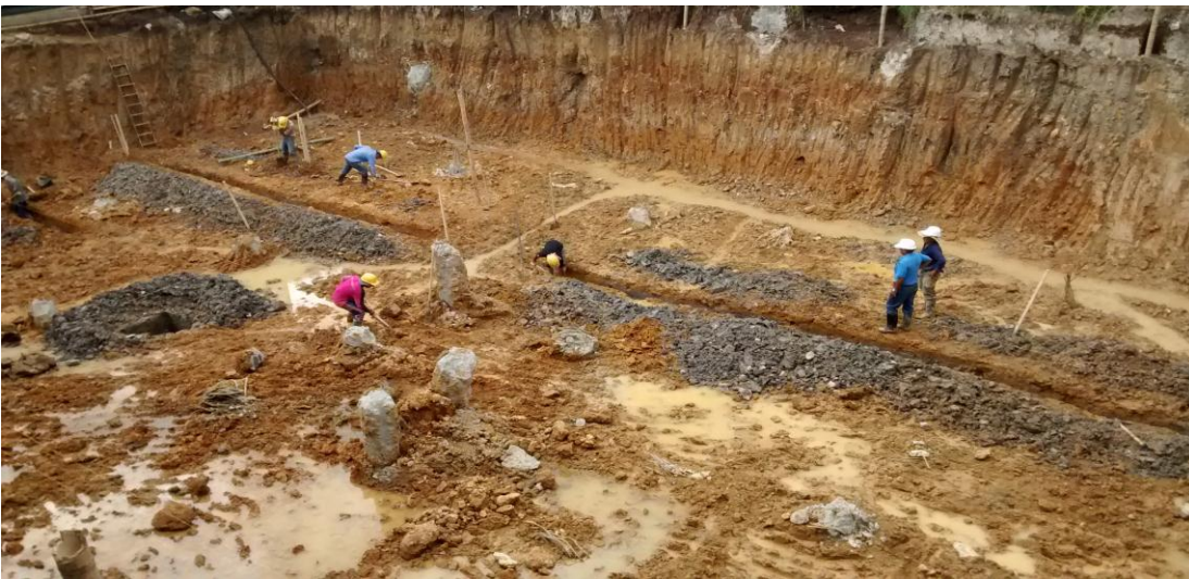
Imagen 17. Excavación de drenajes.
