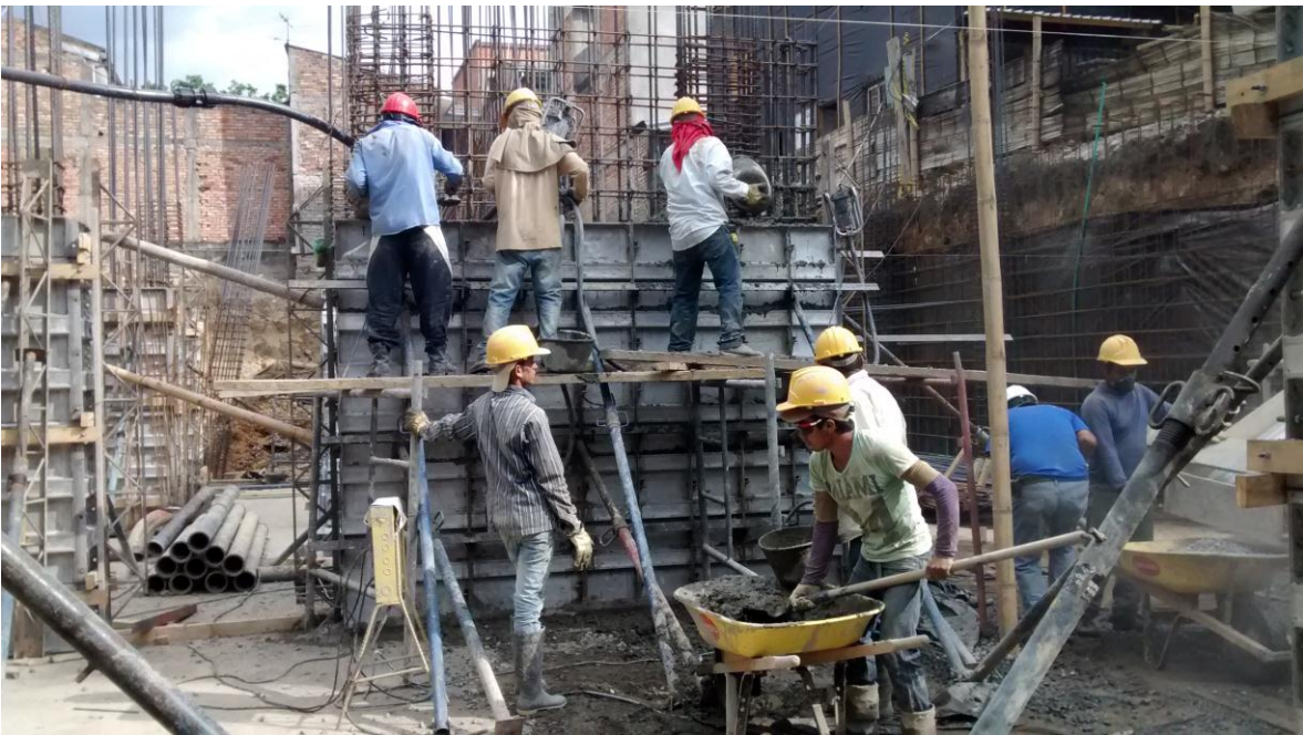
Imagen 51. Colocación del concreto en una pantalla.
