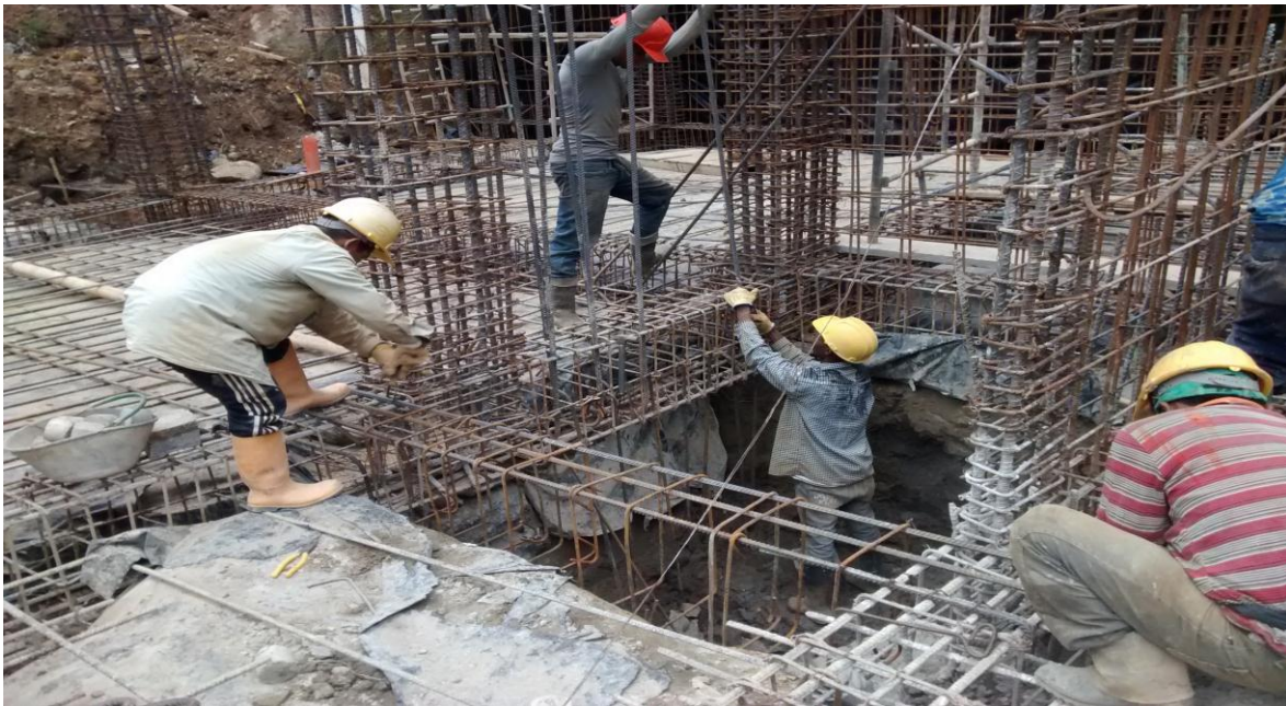
Imagen 40. Construcción de viga de carga en el único lado del foso de ascensor que no contaba con este elemento estructural.
