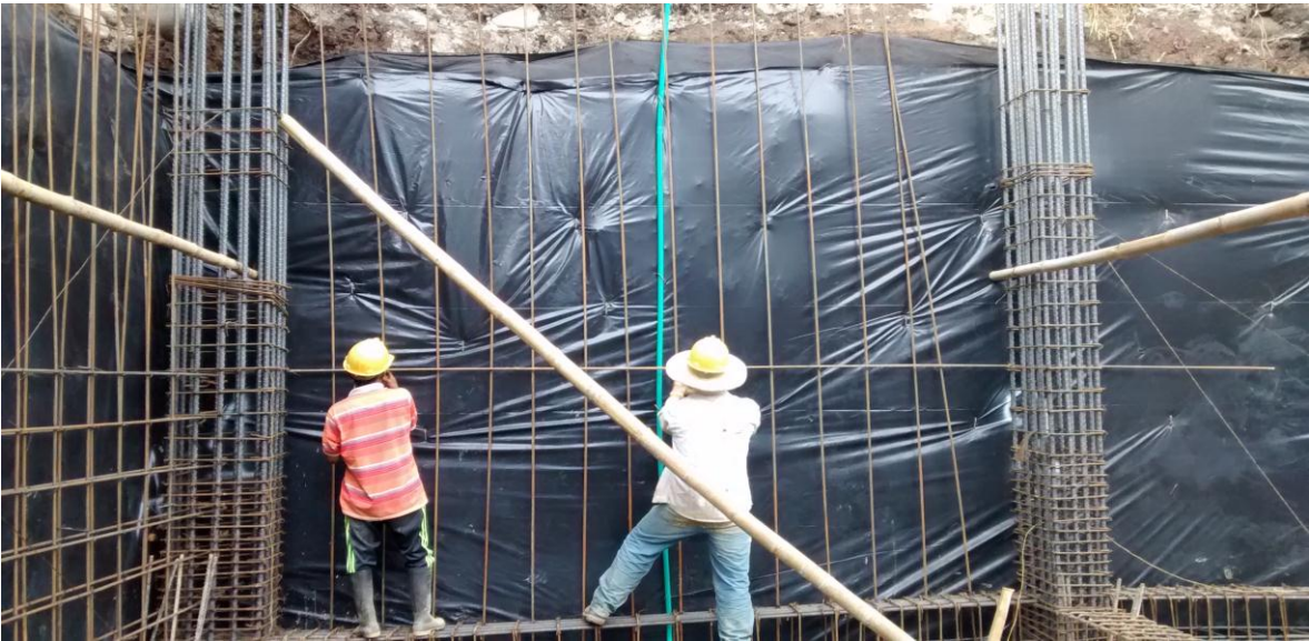
Imagen 38. Inicio de colocación de refuerzo horizontal en pantallas de contención.
