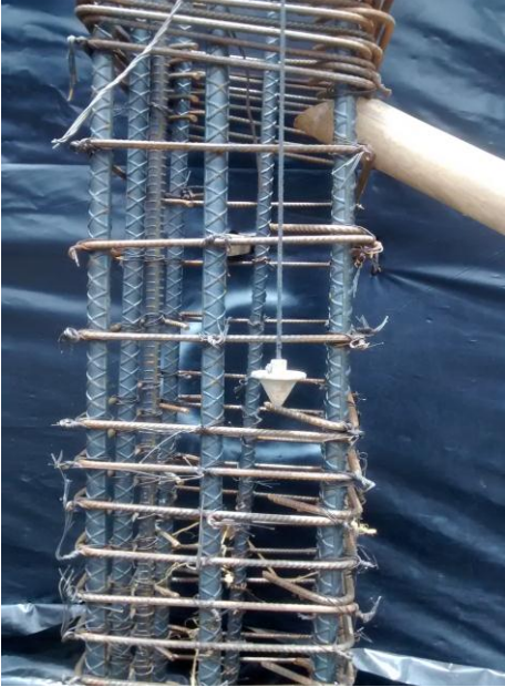
Imagen 32. Comprobación de verticalidad de columna
