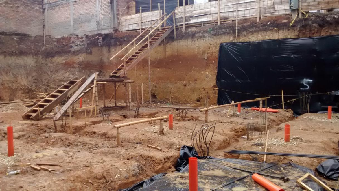
Imagen 27. Replanteo de ejes de vigas de cimentación por medio de caballetes.
