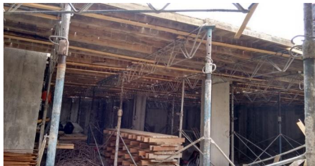
Ilustración 24. Formaleta para la elaboración de la losa
