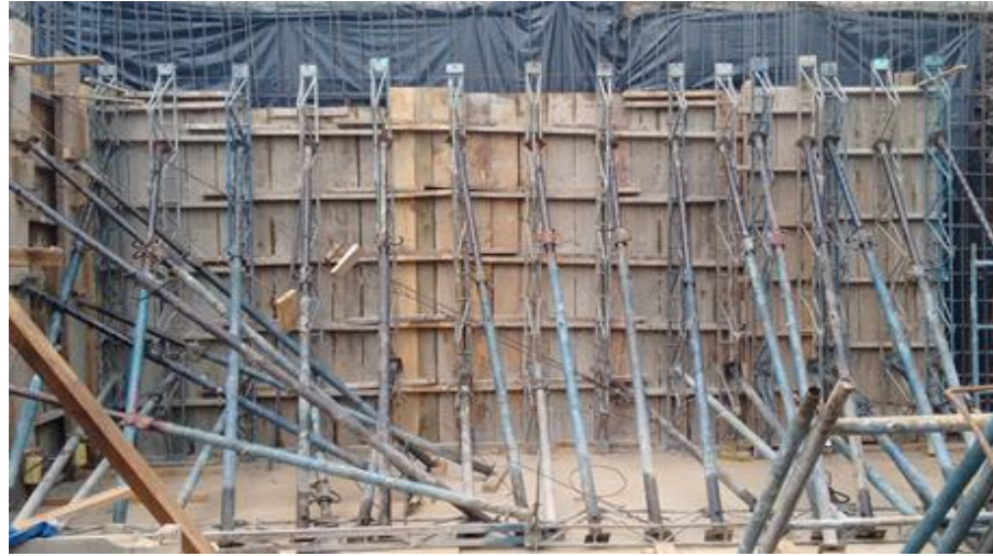
Ilustración 19. Encofrado de pantallas
