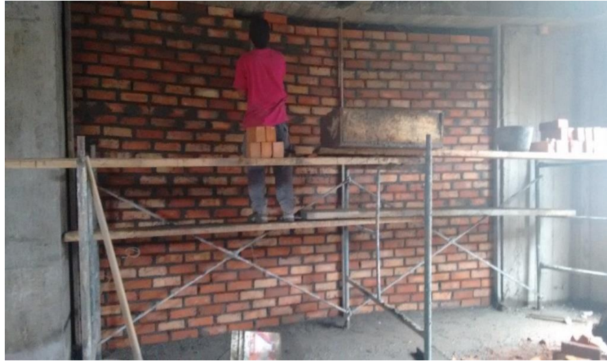
Ilustración 39. Muro tipo sogá con ladrillo común
