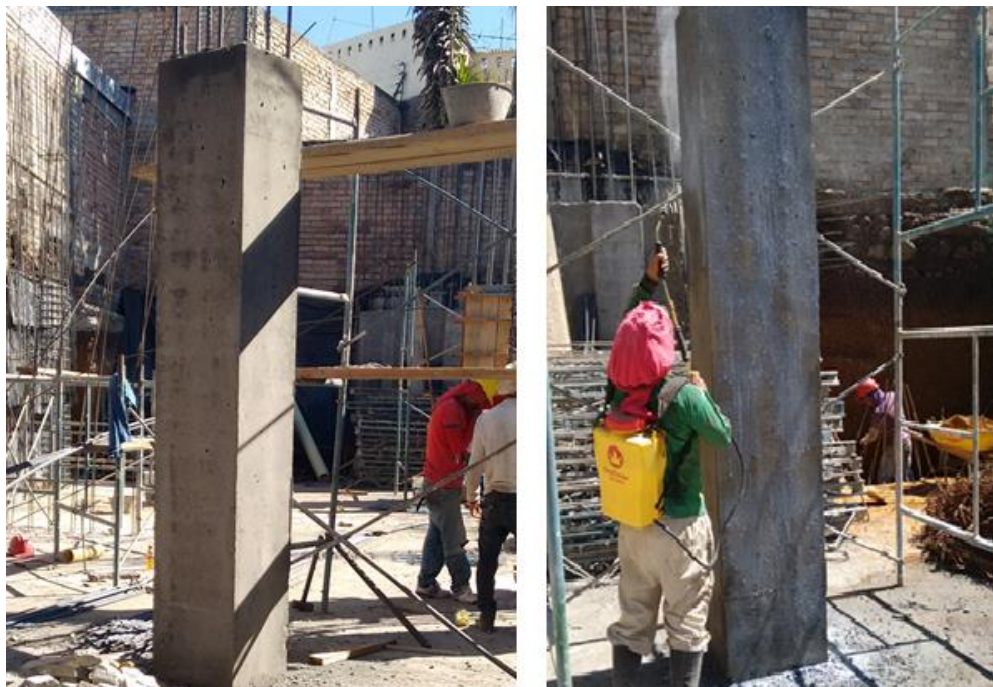
Ilustración 16. Aplicación de Antisol para la comuna
