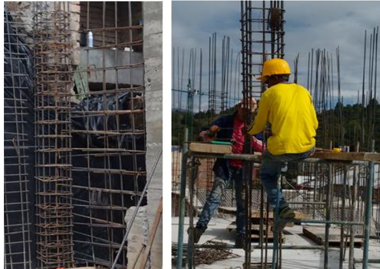
Ilustración 12. Refuerzo de las columnas
