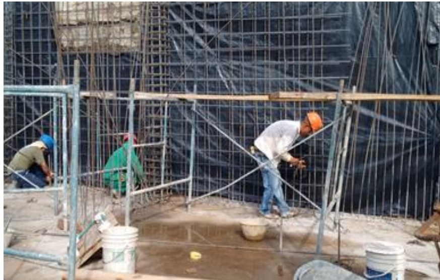
Ilustración 18. Refuerzo de las pantallas
