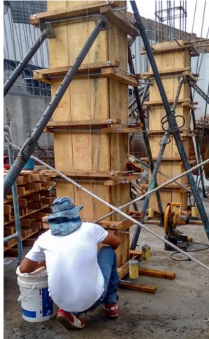
Ilustración 33. columnas listas para fundir
