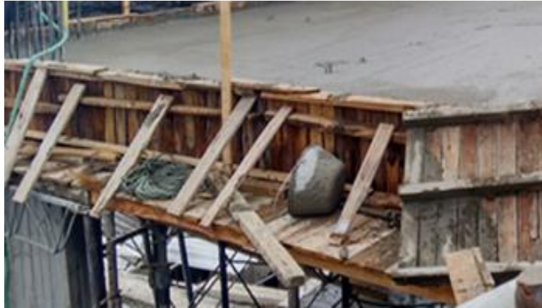
Ilustración 26. Fundición de la losa
