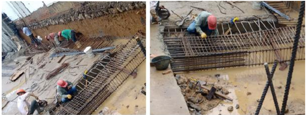
Ilustración 8. Elaboración de vigas
