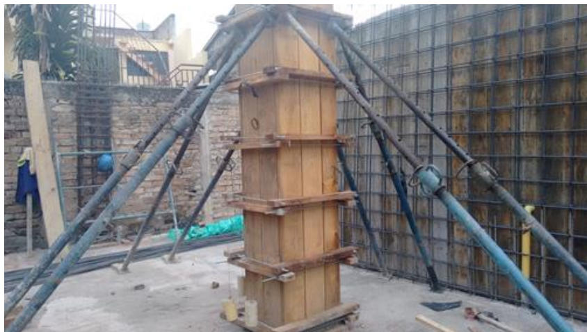
Ilustración 15. Columna lista para fundir
