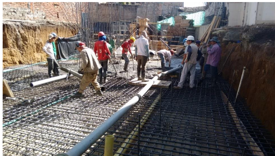
Ilustración 10. Fundición de la losa de cimentación
