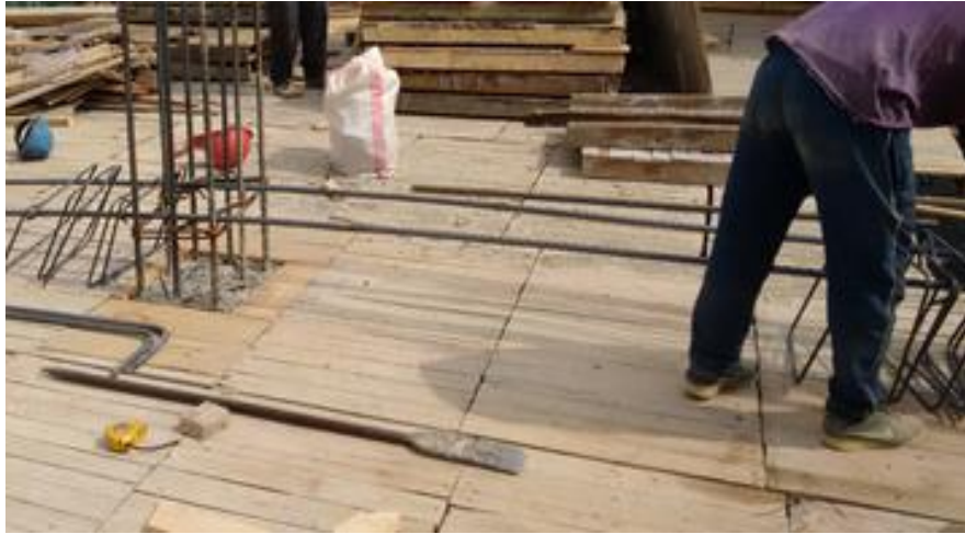
Ilustración 29. Ubicación de los estribos en la viga
