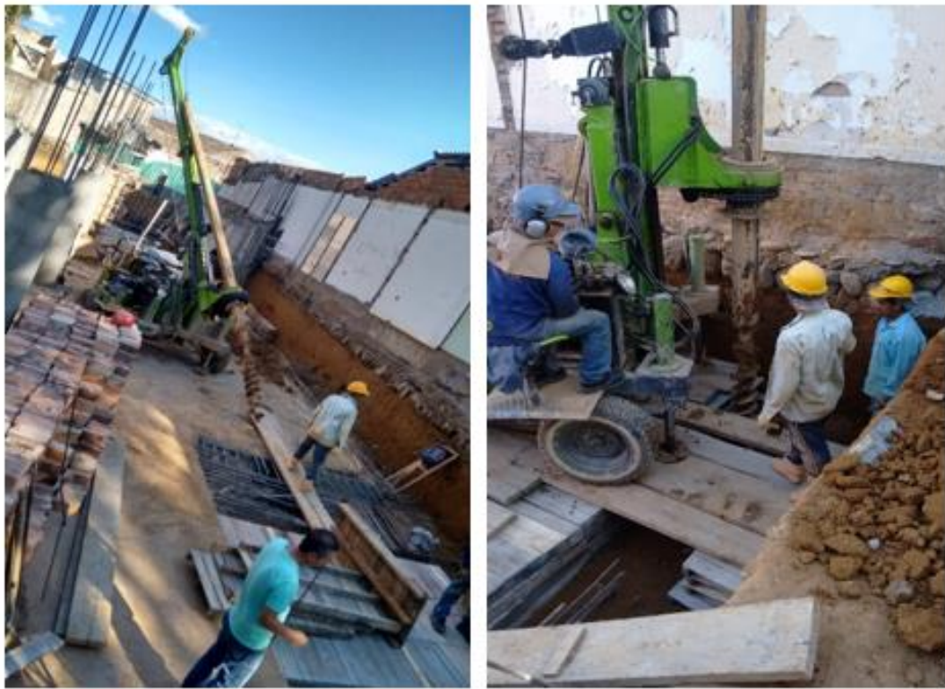
Ilustración 6. perforación de pilotes
