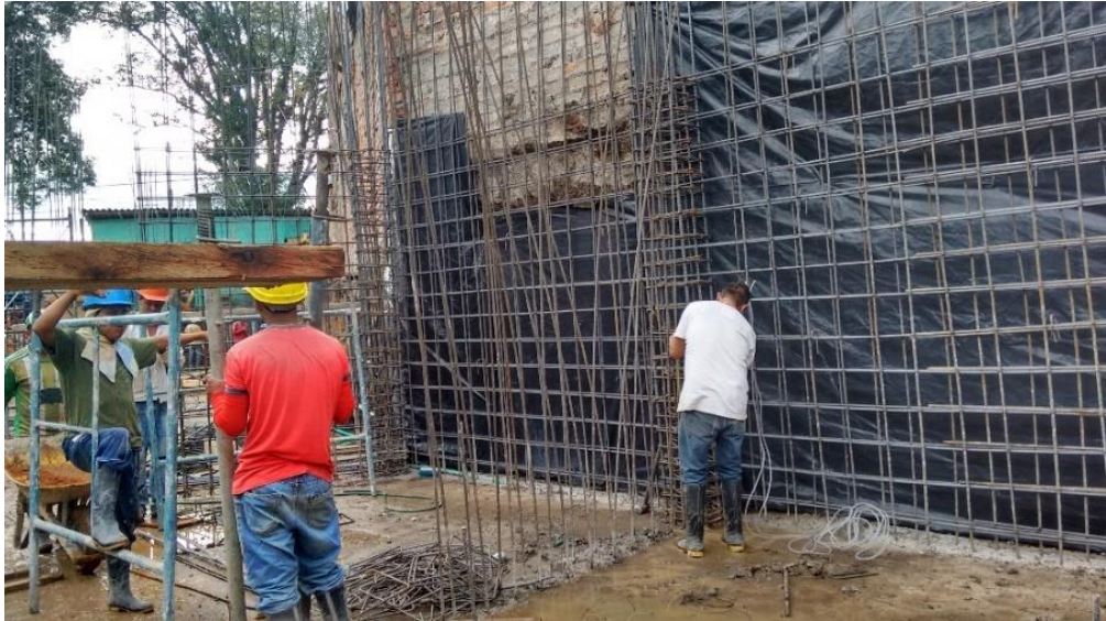
Ilustración 36. Elaboración de pantallas del sótano
