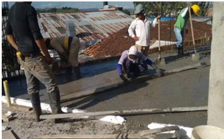
Ilustración 27. Nivelación y fundición de la losa
