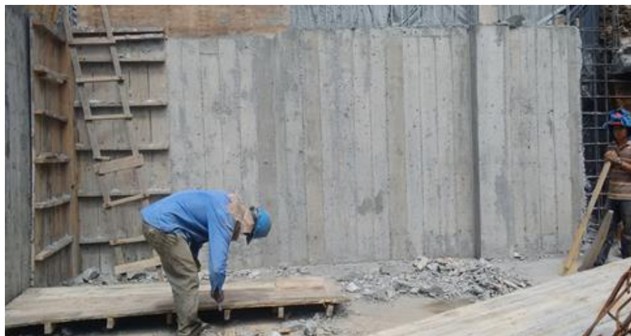
Ilustración 20. Desencofrado de las pantallas
