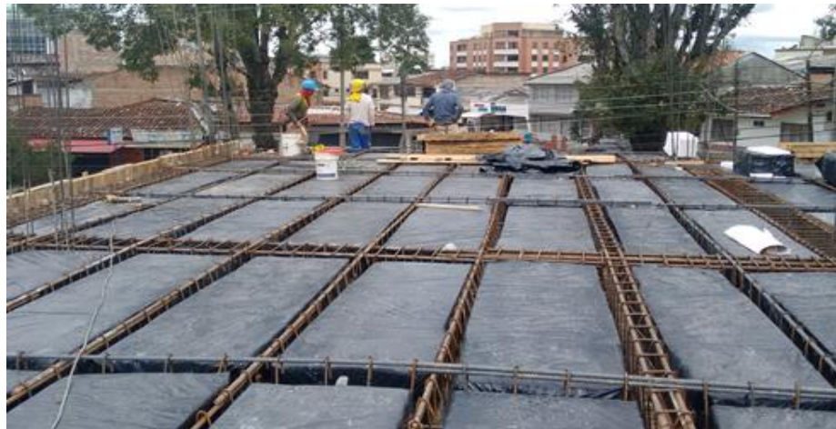
Ilustración 25. Distribución de casetones para la fundición de la losa
