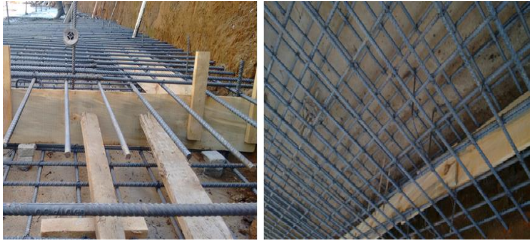
Ilustración 11. Refuerzo de la losa
