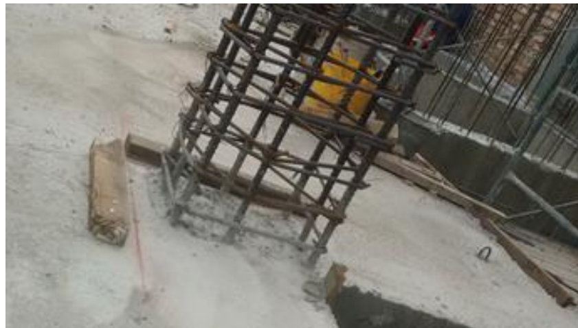
Ilustración 13. Preparación de las columnas para el encofrado
