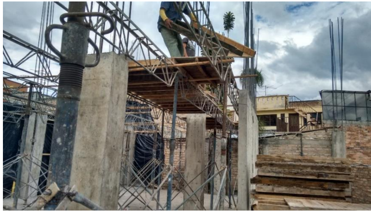
Ilustración 37. Formaleta para la losa
