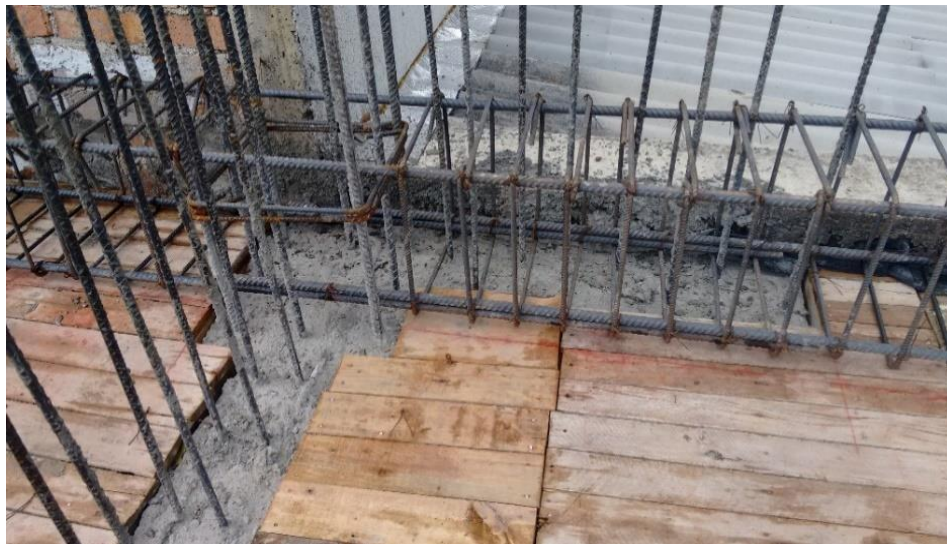
Ilustración 30. Refuerzo de la viga
