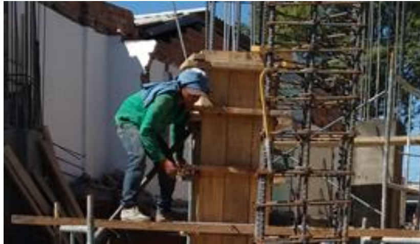
Ilustración 14. Fijación de la formaleta con travesaños
