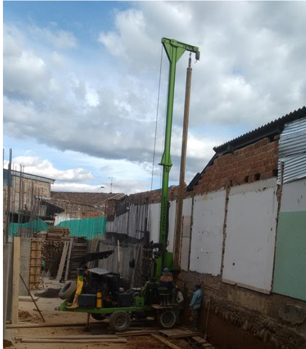
Ilustración 32. Refuerzo de la viga
