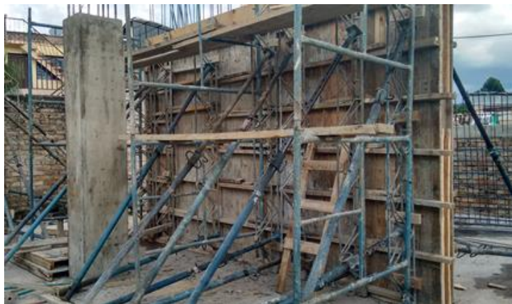
Ilustración 21. Pantalla lista para fundir
