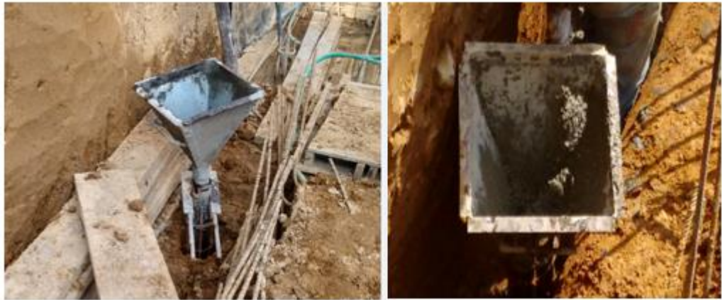
Ilustración 7. Fundición de los pilotes
