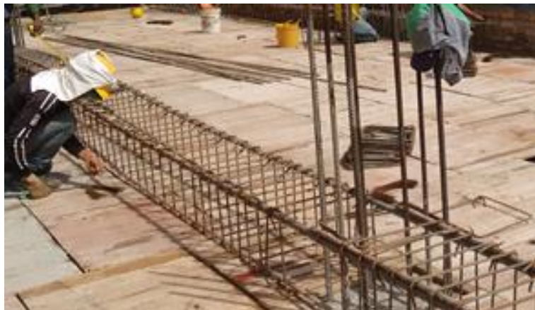
Ilustración 28. Elaboración de vigas
