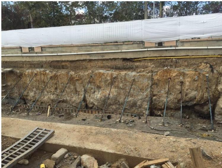
Figura 15. Apuntalamiento de pantallas y barretes antes de fundir viga cinturón. Fuente: Fotografía propia.
