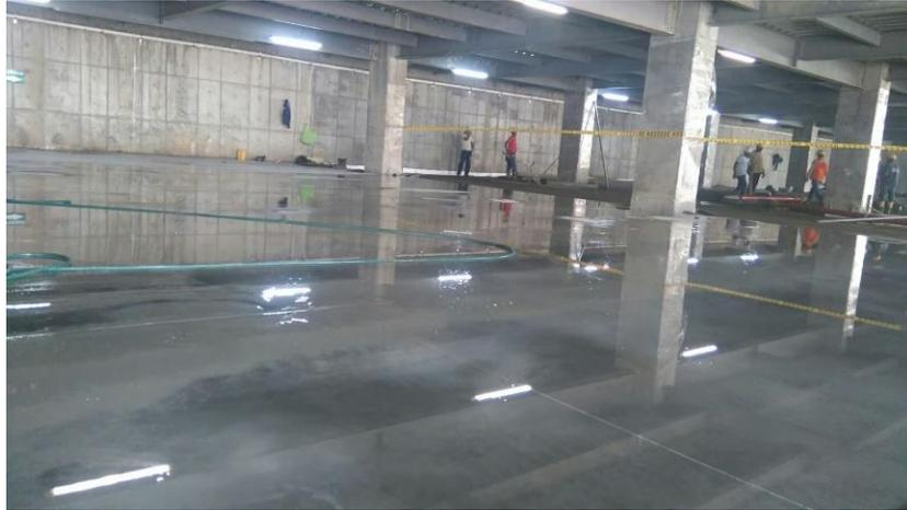
Figura 50. Curado de la losa de pavimento. Fuente: Fotografía propia.
