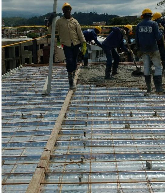
Figura 59. Fundición de losa de entrepiso con separadores en bloques de concreto. Fuente: Fotografía propia.
