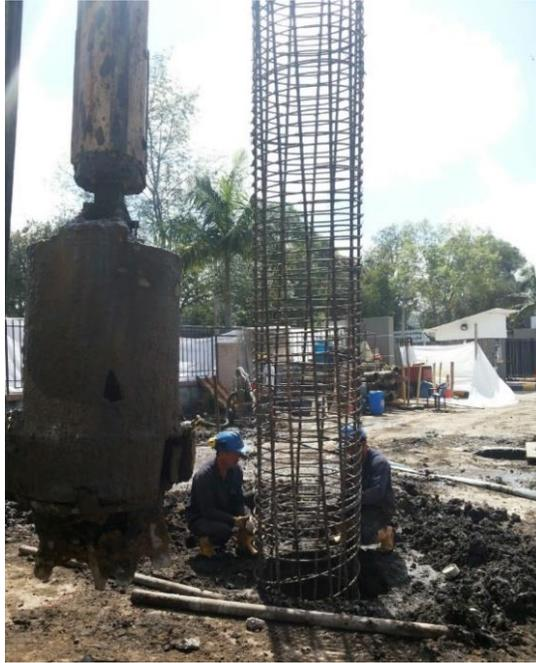
Figura 17. Instalación del castillo de refuerzo. Fuente: Fotografía propia.
