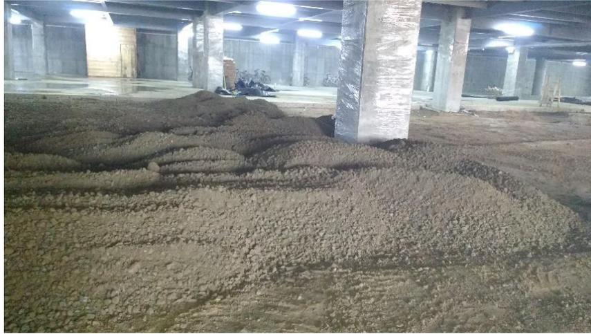
Figura 37. Material para base granular, Fuente: Fotografía propia.
