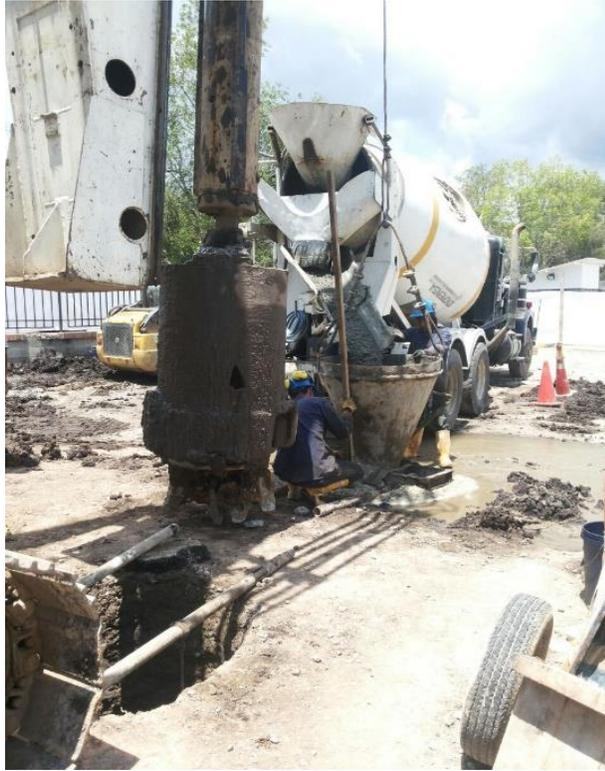
Figura 22. Fundición de pilote in situ con tubería y concreto tremie. Fuente: Fotografía propia.
