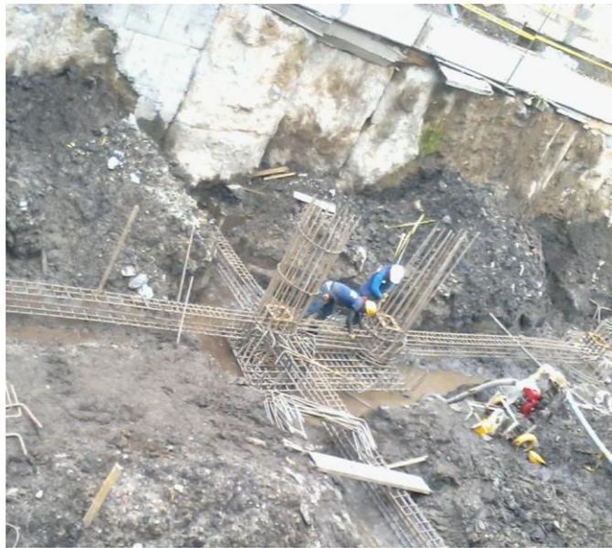
Figura 27. Armado de acero de refuerzo dado y viga de cimentación. Fuente: Fotografía propia.
