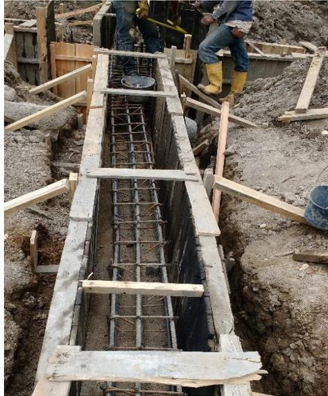
Figura 57. Recubrimientos de viga de cimentación. Fuente: Fotografía propia.
