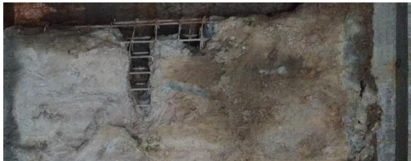
Figura 60. Elemento estructural que no cumple con el recubrimiento mínimo y con acero expuesto. Fuente: Fotografía propia.
