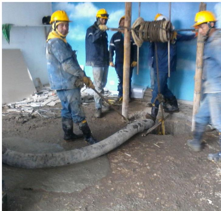
Figura 25. Fundición pilote manual. Fuente: Fotografía propia
