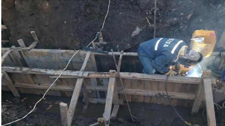
Figura 55. Soldadura de barras que no cumplen con el traslapeo mínimo requerido.
