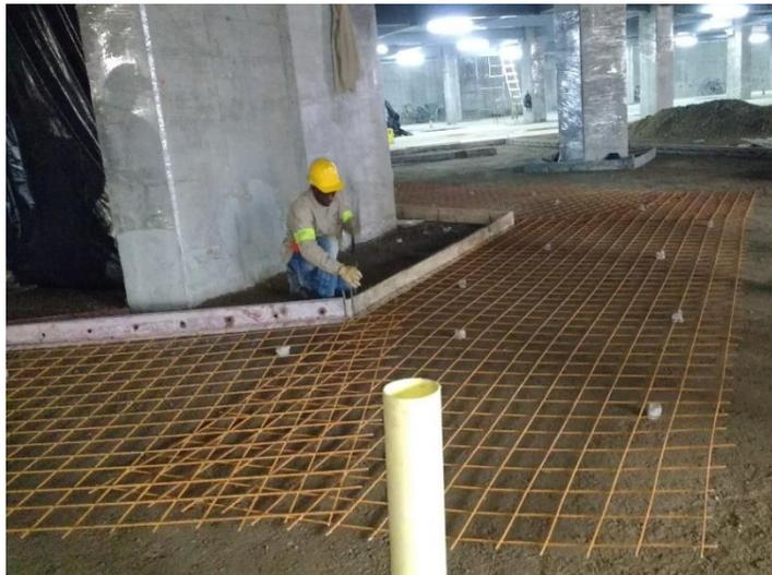
Figura 40. Instalación de malla electro soldada, refuerzo para pavimento. Fuente: Fotografía propia.
