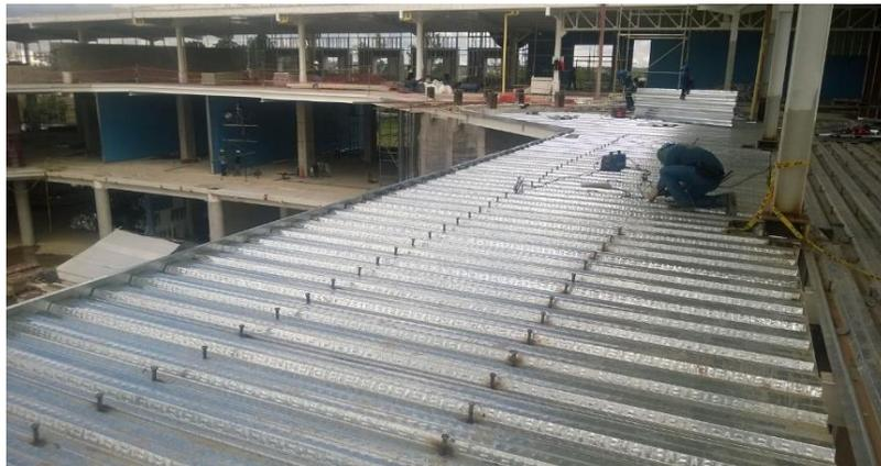
Figura 31. Instalación de conectores de cortante. Fuente: Fotografía propia.
