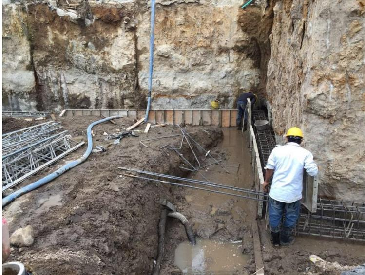
Figura 14. Encofrado viga cinturón. Fuente: Fotografía propia.
