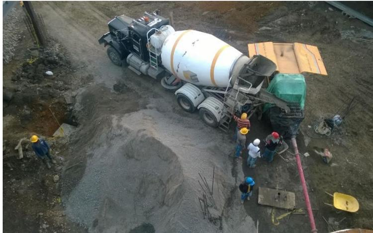
Figura 43. Descarga del camión mixer. Fuente: Fotografía propia.
