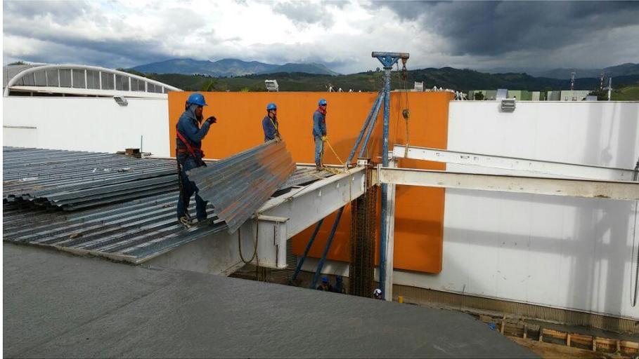
Figura 32. Instalación de steel deck. Fuente: Fotografía propia.
