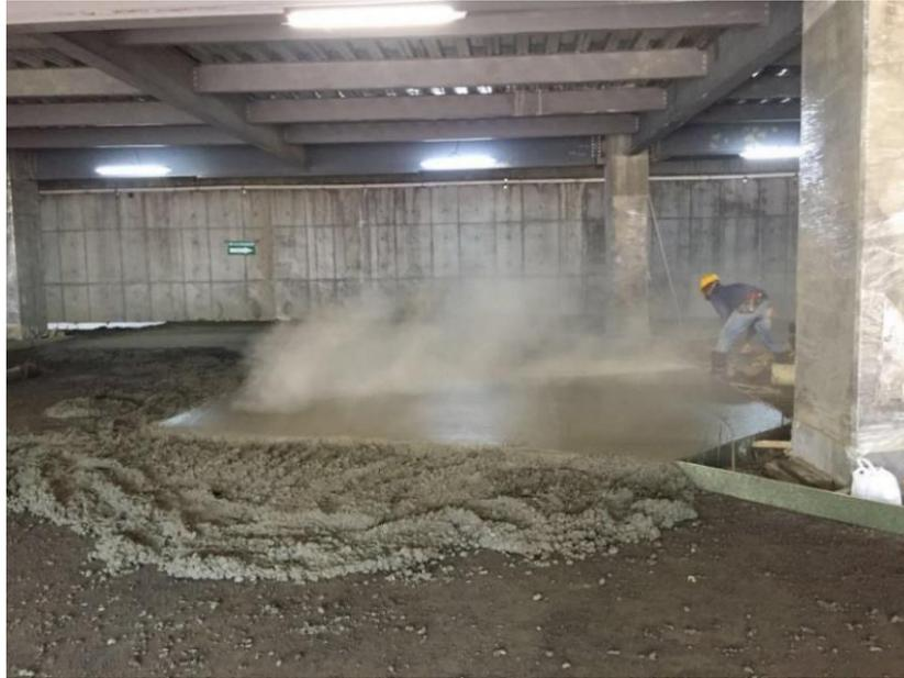
Figura 48. Aplicación del endurecedor Sika-Floor. Fuente: Fotografía propia.
