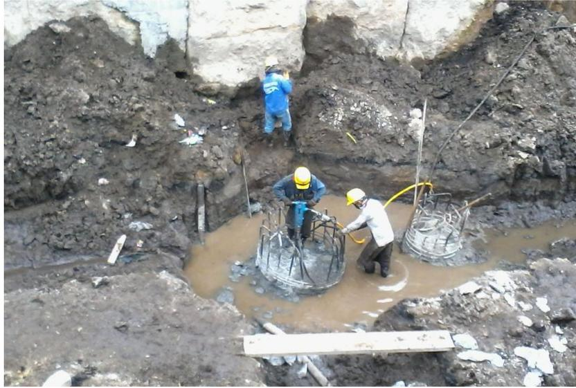
Figura 26. Demolición de pilotes. Fuente: Fotografía propia.
