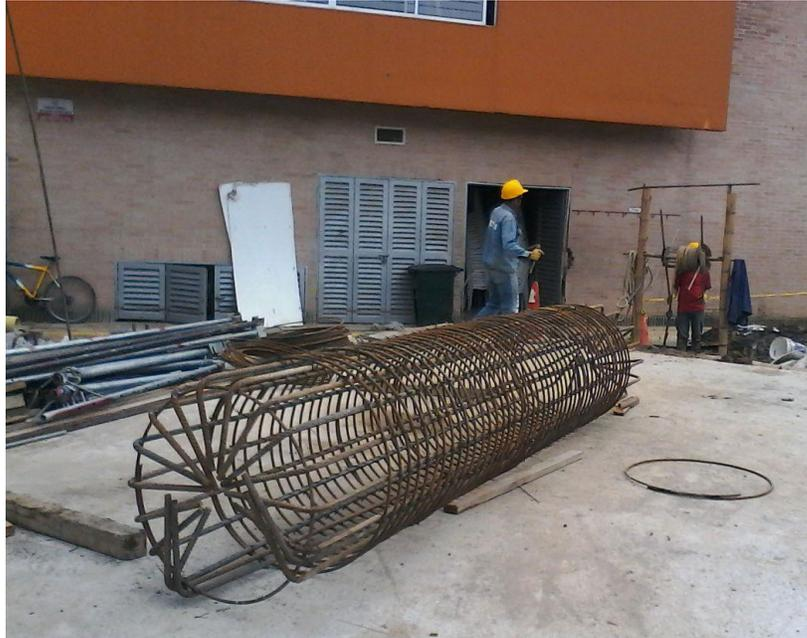
Figura 24. Castillo de refuerzo pilote excavado a manualmente. Fuente: Fotografía propia.
