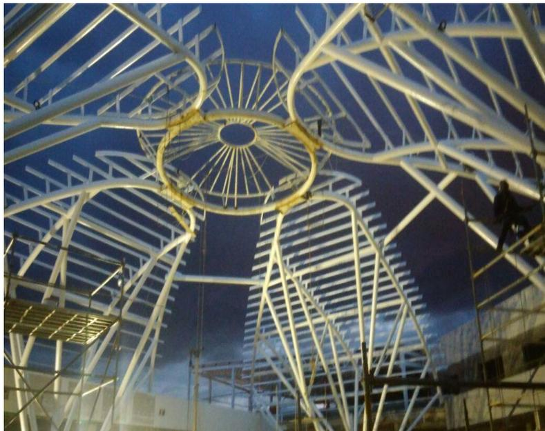
Figura 6. Montaje de estructura de cubierta plazoleta central. Fuente: Fotografía propia.
