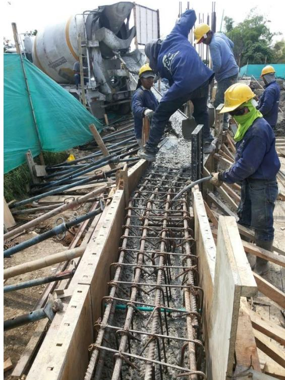
Figura 13. Fundición viga corona descarga directa. Fuente: Fotografía propia.
