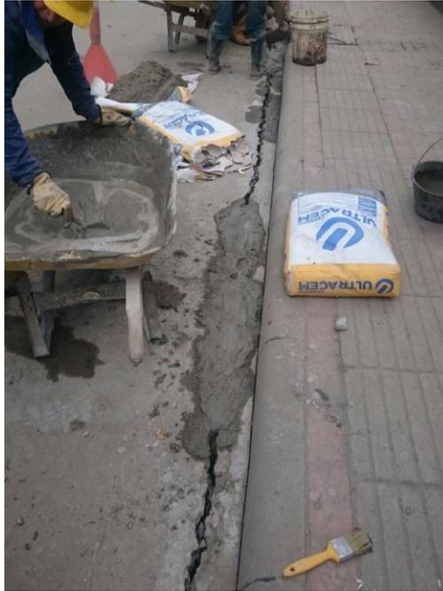
Figura 10. Grieta entre la Carrera 15 y el cordón de pantallas y barretes. Fuente: Fotografía propia.
