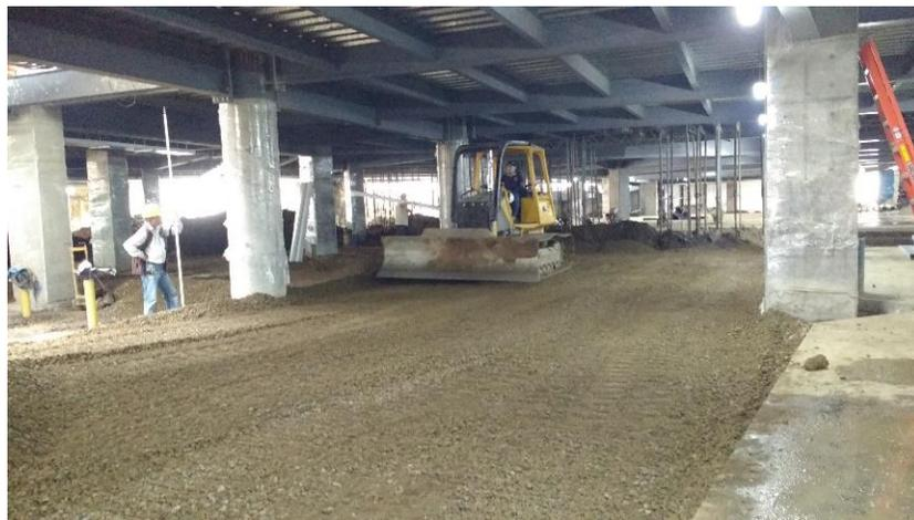
Figura 38. Seriado y nivelación de la base con motoniveladora. Fuente: Fotografía propia.
