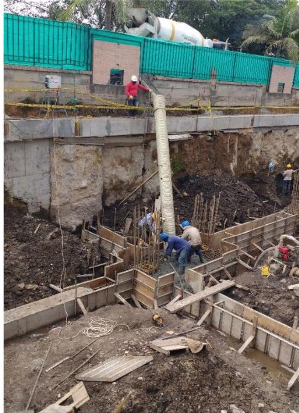
Figura 28. Fundición de zapata cabezal con ayuda de un tubo. Fuente: Fotografía propia.
