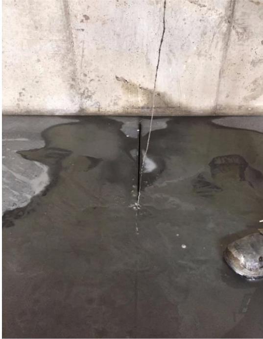
Figura 52. Chequeo profundidad de corte. Fuente: Fotografía propia.
