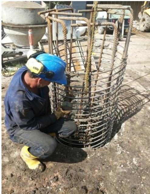
Figura 18. Asegurado del castillo de refuerzo. Fuente: Fotografía propia.
