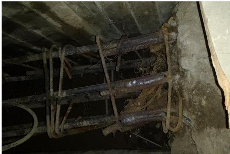
Figura 56. Cordón de soldadura en acero de refuerzo de vigas de cimentación que no cumplió con el traslapeo mínimo requerido. Fuente: Fotografía propia.
