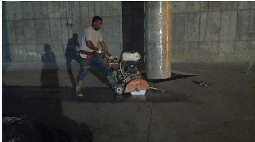
Figura 51. Corte juntas de dilatación. Fuente: Fotografía propia.
