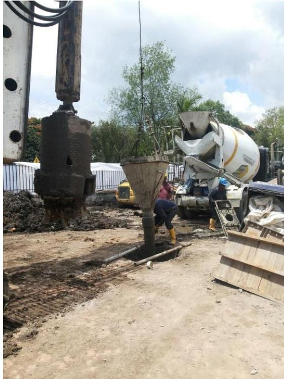
Figura 21. Ubicación de la tolva y tubería la tubería tremie. Fuente: Fotografía propia.
