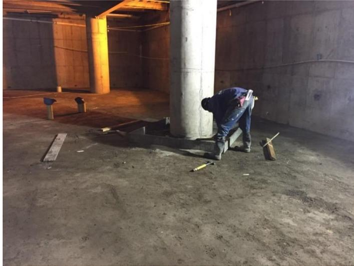
Figura 39. Formateado de losa para pavimento. Fuente: Fotografía propia.
