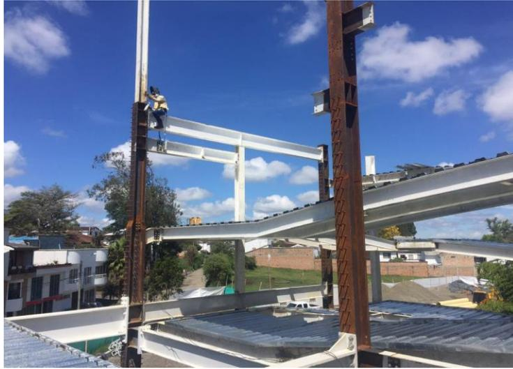
Figura 30. Izaje de vigas y viguetas. Fuente: Fotografía propia.
