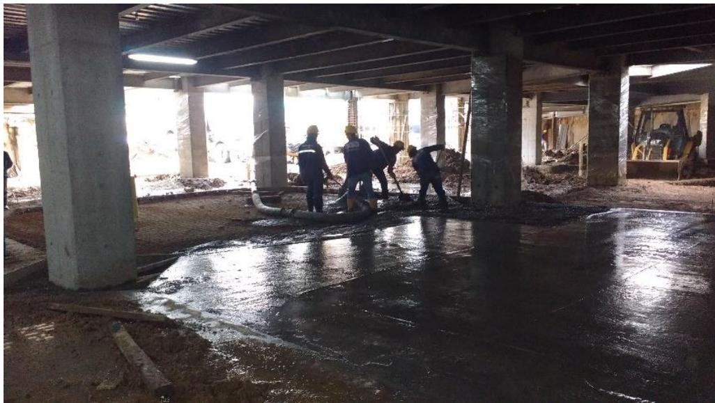
Figura 46. Fundición de pavimento con bomba. Fuente: Fotografía propia.
