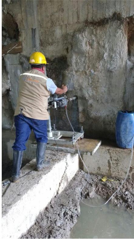
Figura 62. Extracción de núcleo en barrete. Fuente: Fotografía propia.
