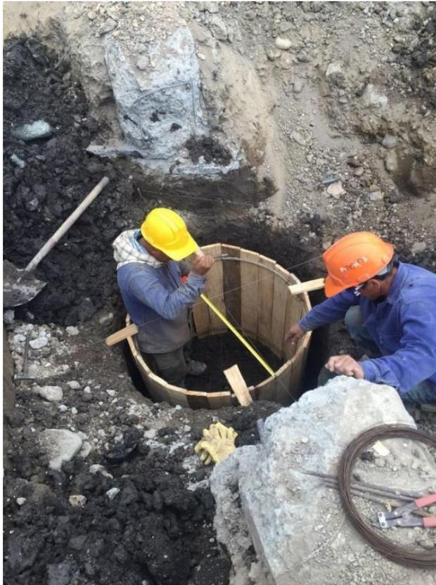
Figura 23. Formaleta para anillos pilote manual. Fuente: Fotografía propia.
