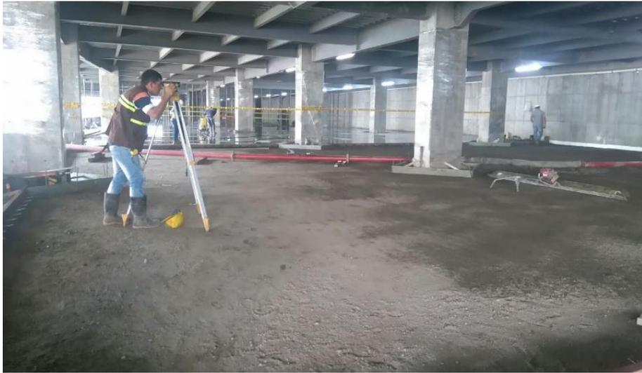
Figura 47. Nivelación fundición de pavimento. Fuente: Fotografía propia.
