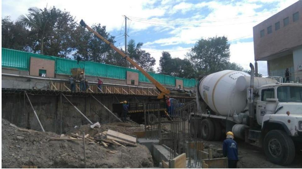
Figura 12. Fundición viga corona con camión grúa. Fuente: Fotografía propia.
