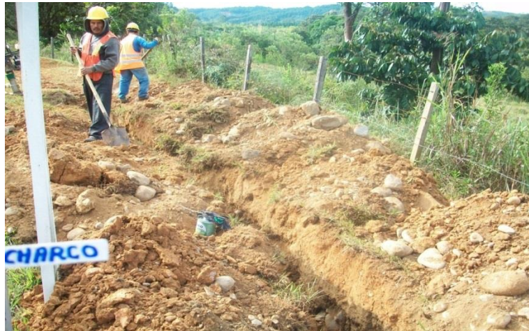
Imagen 26. Excavación en conglomerado, sector Bajo Charco.
