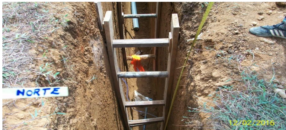
Imagen 42. Entibación del terreno
