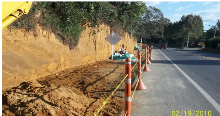
Imagen 39. Talud intervenido, sector K5+400.
