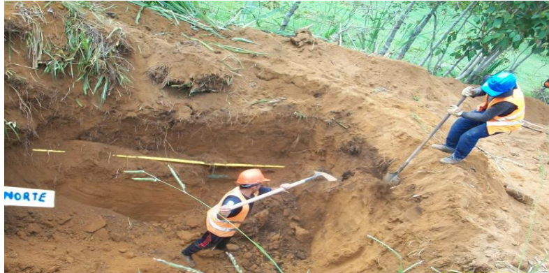
Imagen 43. Excavación para equipo de tunelaje, sector intersección vía Totoró.
