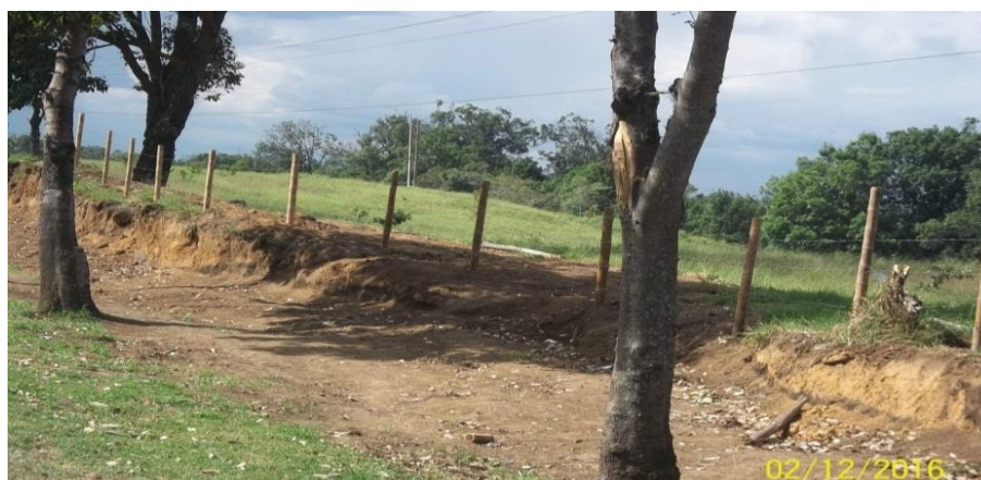
Imagen 34. Reposición cerco en guadua.
