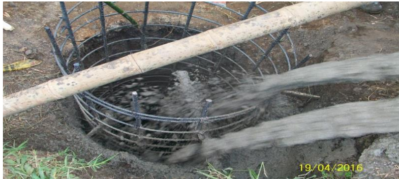
Imagen 47. Fundición del caisson con concreto premezclado.
