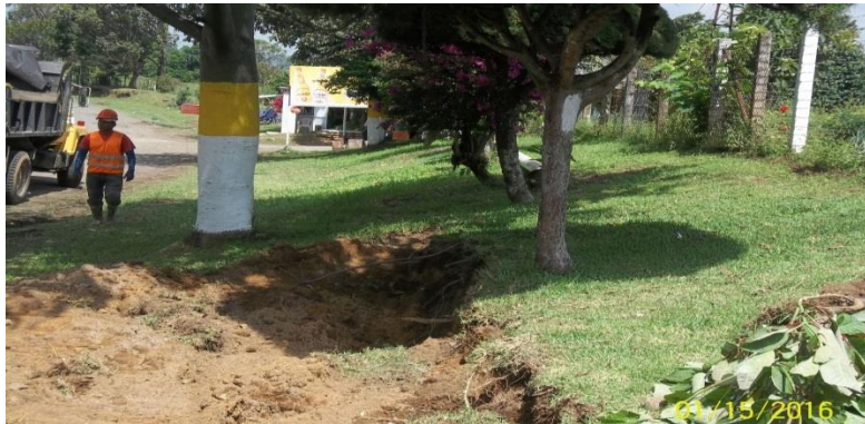
Imagen 17. Afectación del Suelo.
