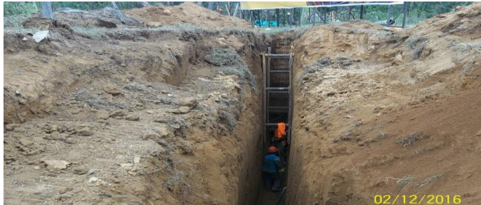
Imagen 41. Entibación del terreno, sector Manjar Payanés.
