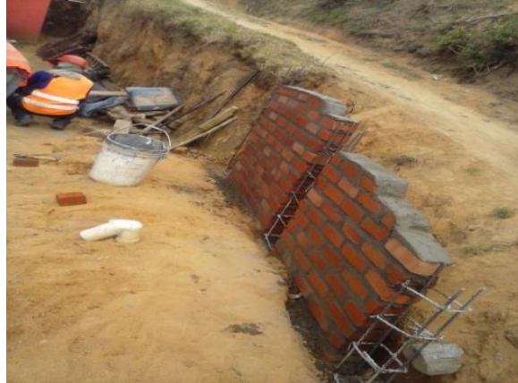
Imagen 35. Muro de contención, sector Calibio.
