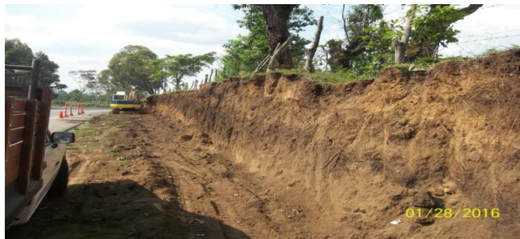
Imagen 36. Movimiento de tierra, corte de Talud, sector Km 4+400.
