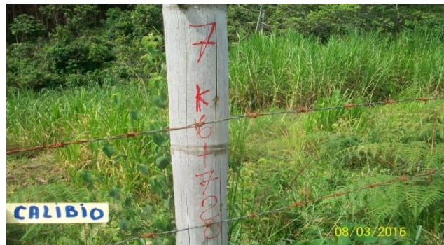
Imagen 10. Replanteo abscisado tramo vereda Calibio Km 6+720.
