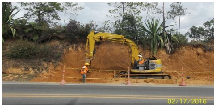
Imagen 38. Intervención talud, sector Km 5+400.
