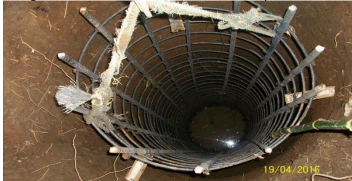
Imagen 46. Instalación de la armadura para la fundición del caisson.
