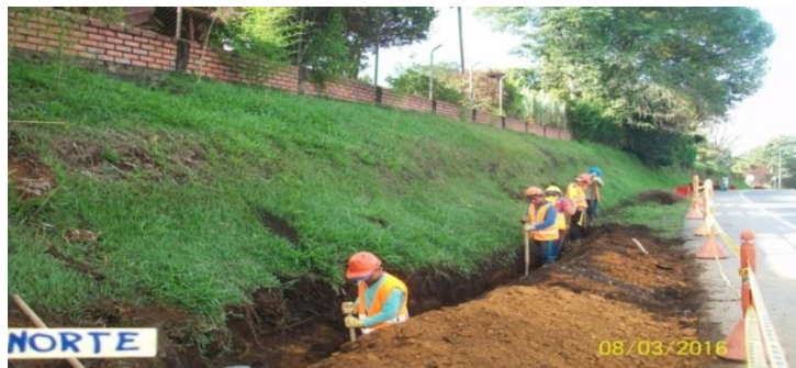
Fuente: Mauricio Mera, inspector de interventoría.
