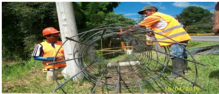
Imagen 45. Construcción de la armadura para la cimentación del viaducto
