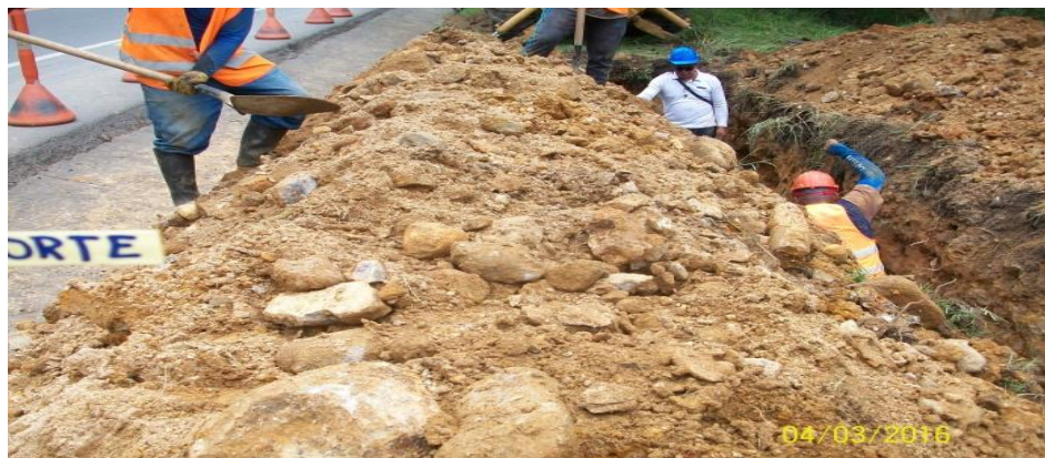
Fuente: Mauricio Mera, inspector de interventoría
