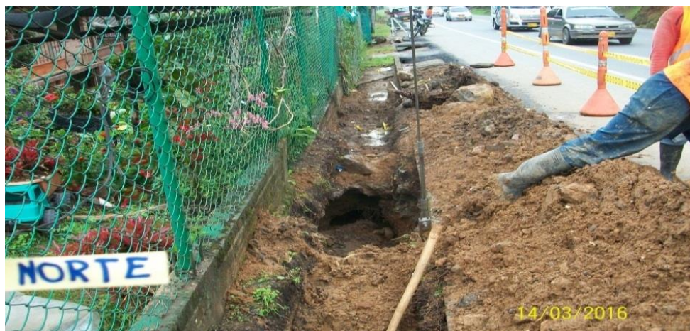
Imagen 18. Retiro y reemplazo de material de relleno sector Rio blanco.
