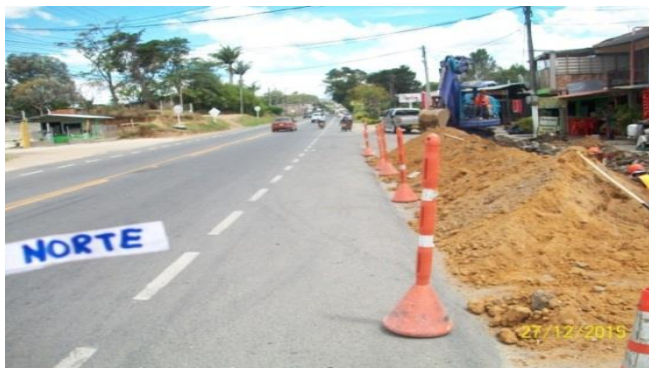
Imagen 11. Delineador tubular sin cinta plástica de demarcación
