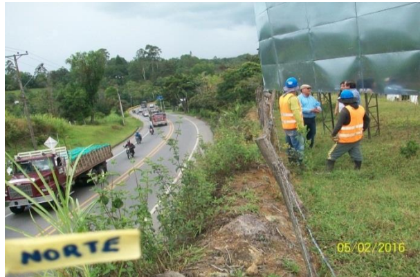
Fuente: Mauricio Mera, inspector de interventoría
