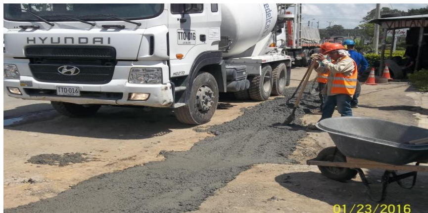
Imagen 33. Reposición en concreto 300 PSI, sector Rio blanco.
