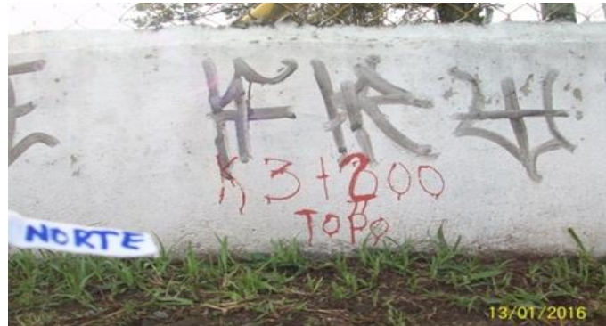
Imagen 9. Replanteo abscisado Rio blanco Km 3+200
