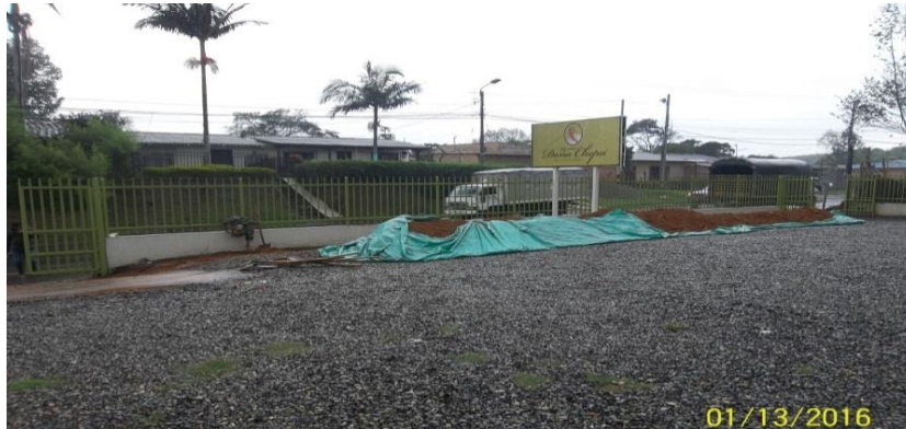
Imagen 19. Separación del material de excavación con el material del lugar.
