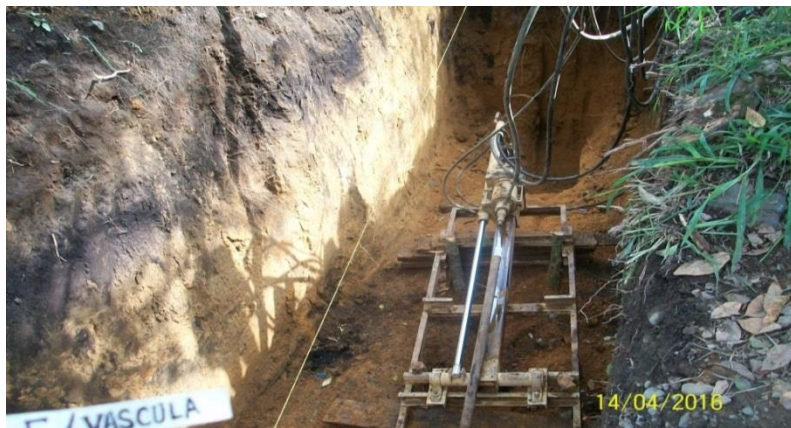
Imagen 44. Equipo de tunelaje, sector vereda Chozas.
