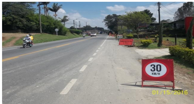
Imagen 13. Distanciamiento apropiado de las señales informativas SIO-01
