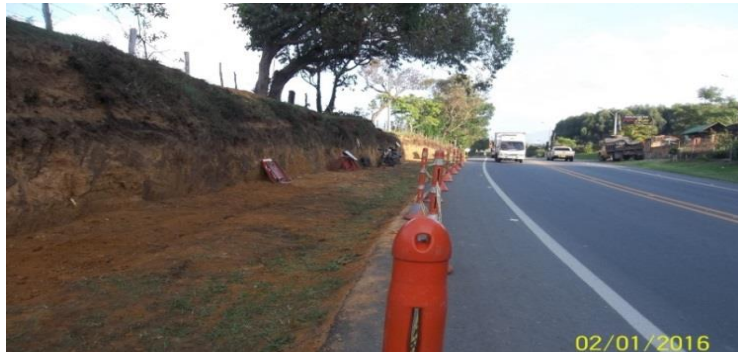
Imagen 37. Talud intervenido, sector Km 4+400.
