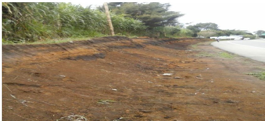
Imagen 40. Perfilación de talud para posterior empradización.
