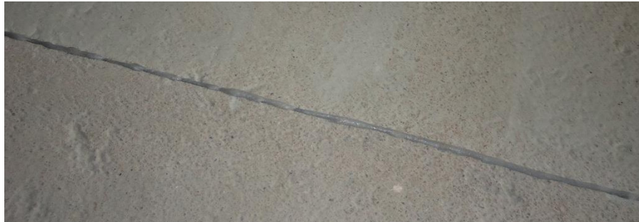
Figura 49. Dilatación del mortero con SikaRod en la junta.
