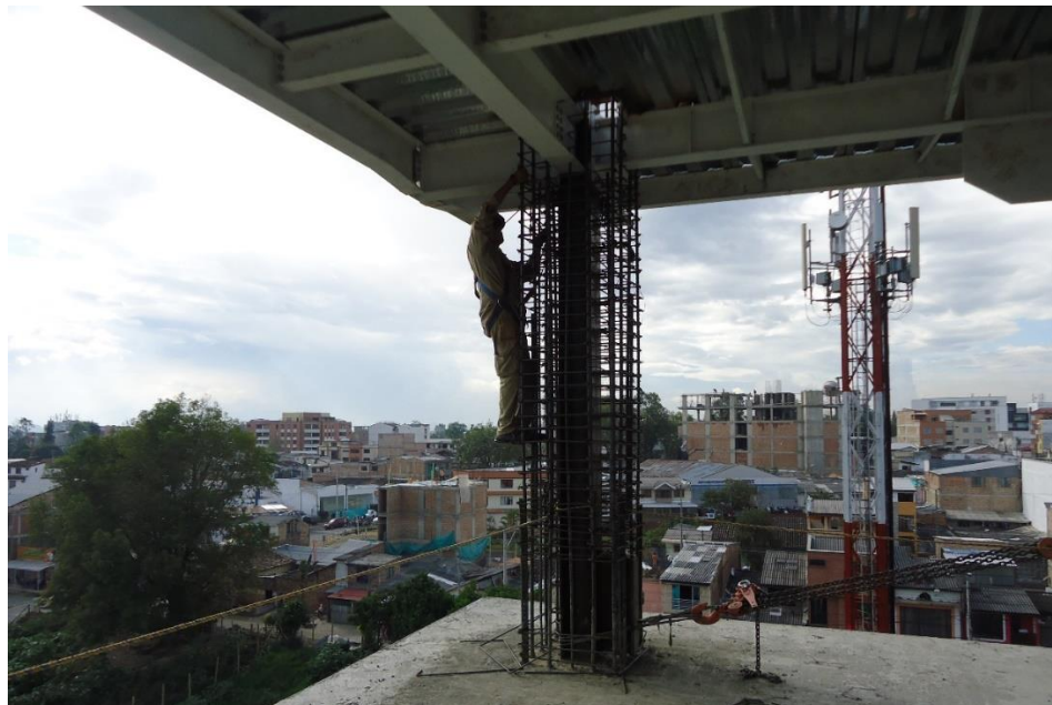
Figura 17. Colocación de acero de refuerzo transversal en columna.
