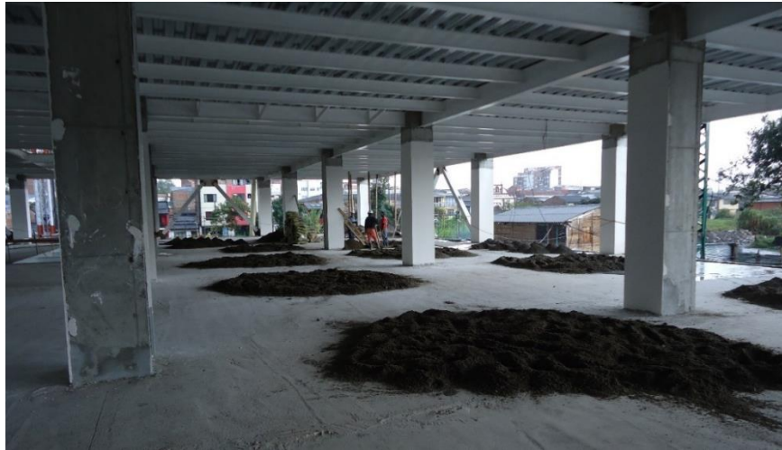
Figura 47. Preparación del material para realizar el mortero de nivelación.
