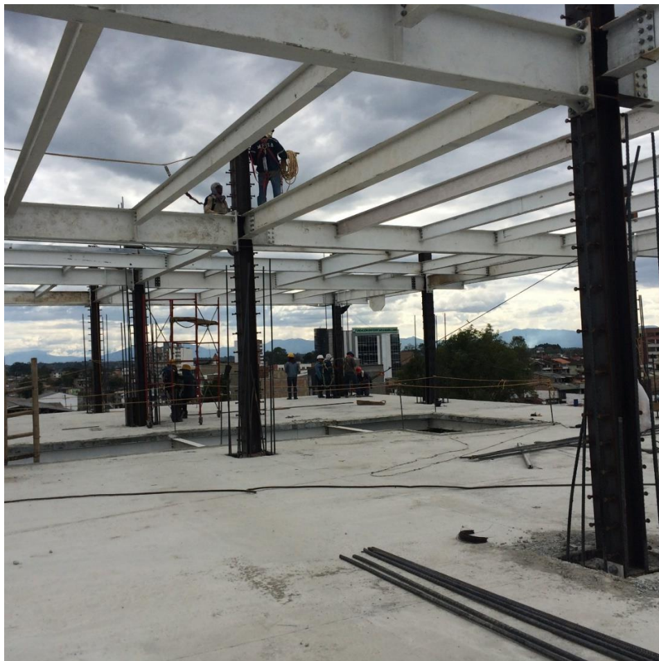
Figura 5. Estado de la obra, 20 Nov 2016.
