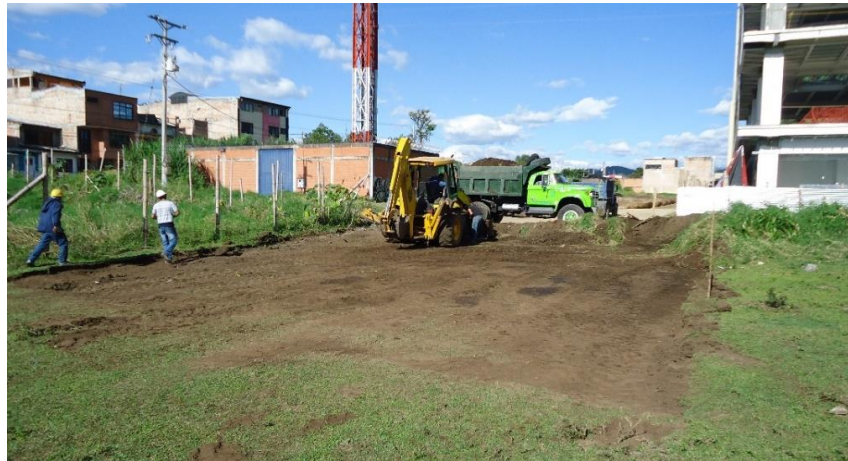
Figura 51. Inicio del descapote del lote.
