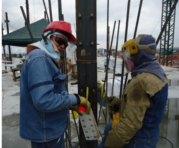
Figura 42. Chequeo de verticalidad mediante plomo.
