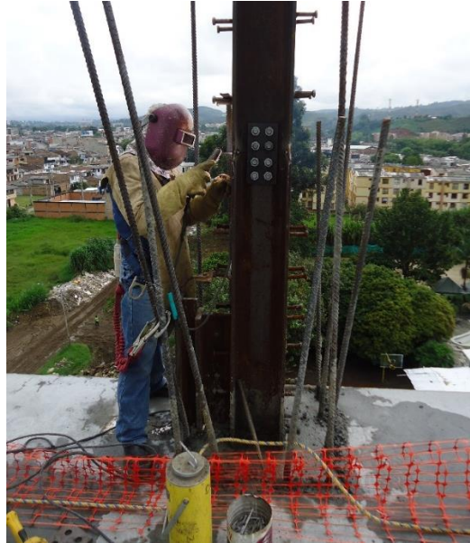
Figura 44. Aplicando soldadura en unión de columnas.
