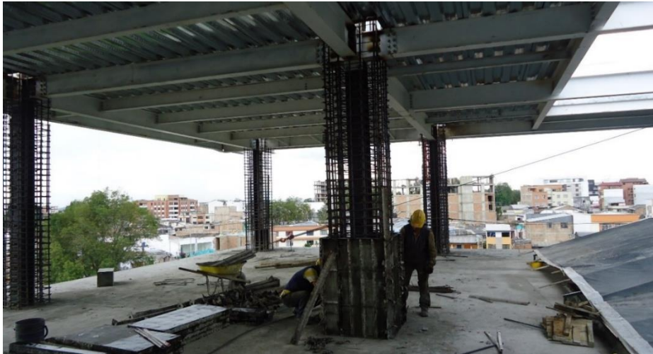
Figura 18. Colocación de la formaleta metálica en columna.
