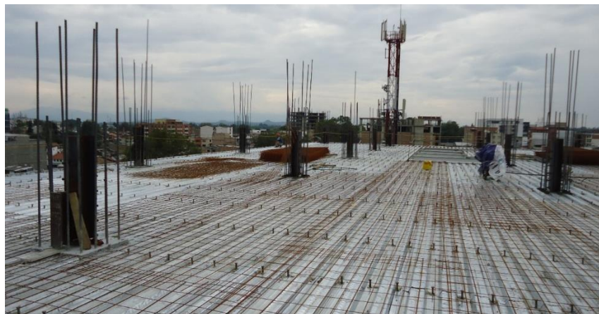
Figura 27. Colocación de malla electrosoldada para losa del sexto piso.
