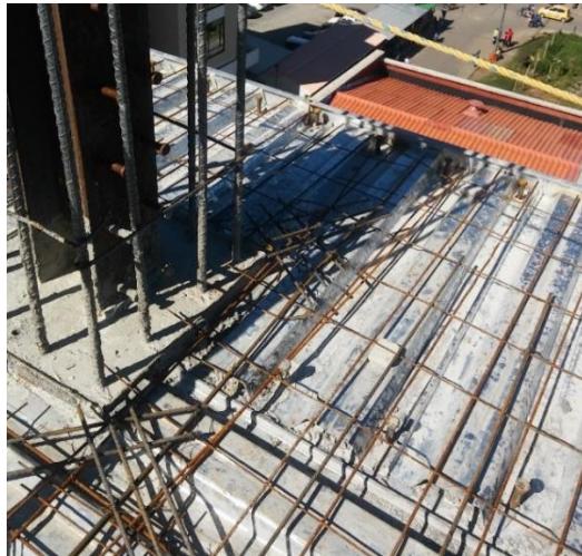
Figura 30. Colocación de refuerzo en las esquinas y voladizo.
