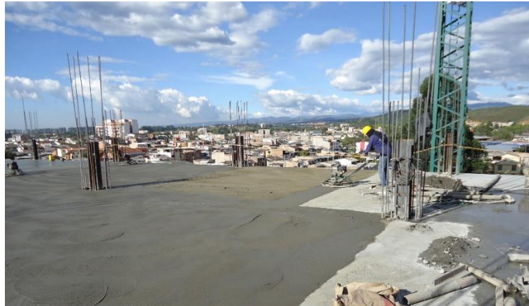
Figura 35. Fundición de la losa de entrepiso día 2.
