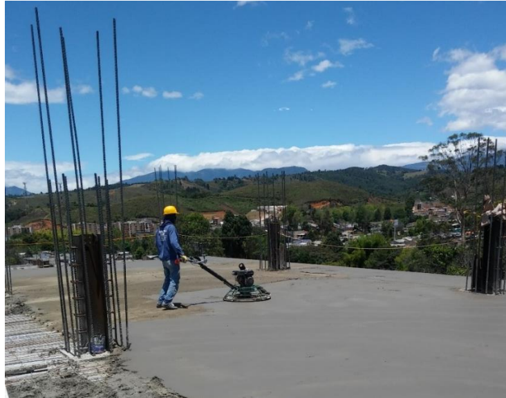
Figura 37. Realizando el acabado sobre la losa.
