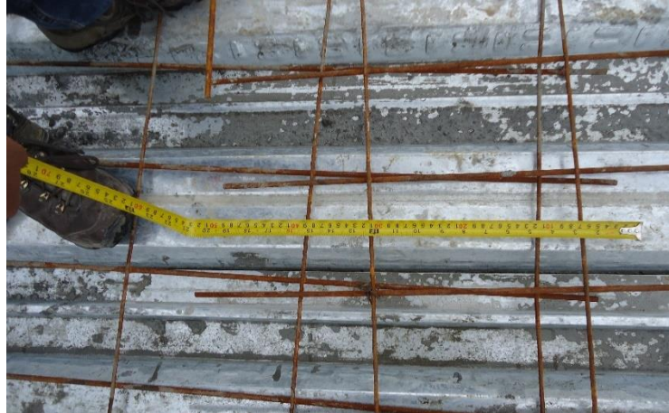
Figura 28. Traslape de malla electrosoldada para losa del sexto piso.
