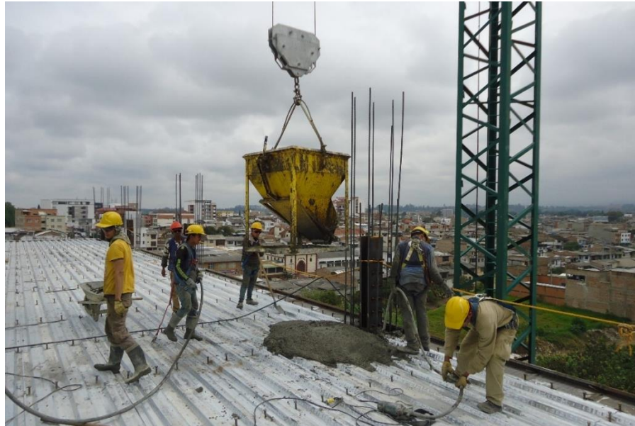
Figura 21. Elevación de concreto por medio de la torre grúa.
