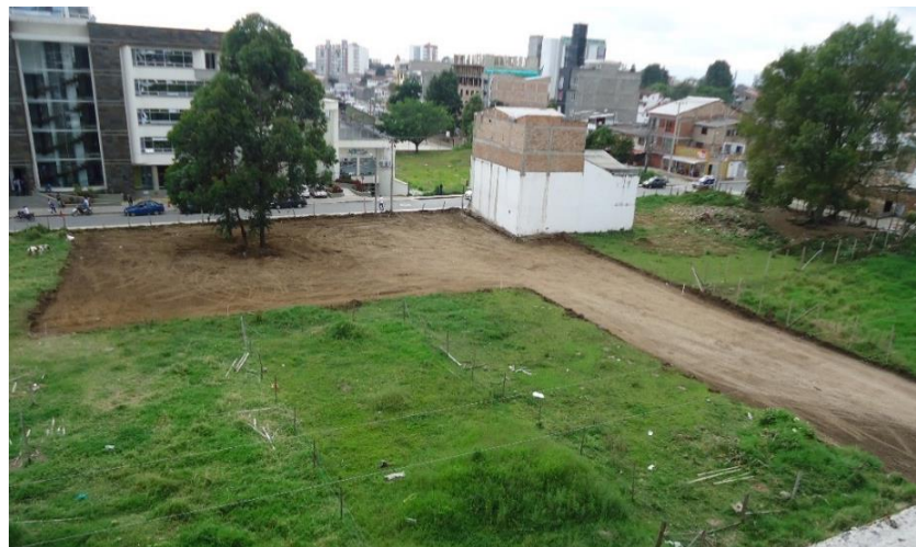
Figura 52. Descapote del lote para parqueadero.
