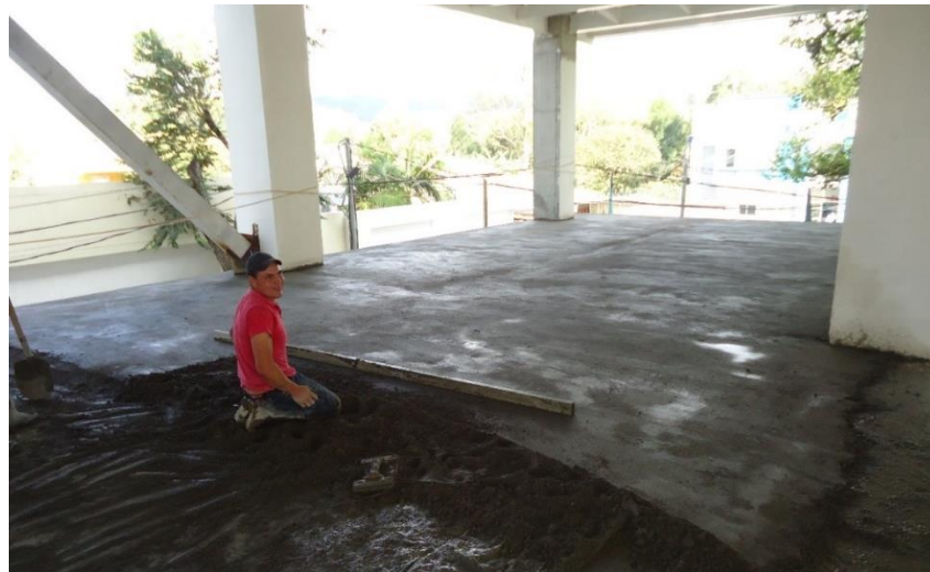
Figura 48. Realización del mortero de nivelación en el segundo piso.
