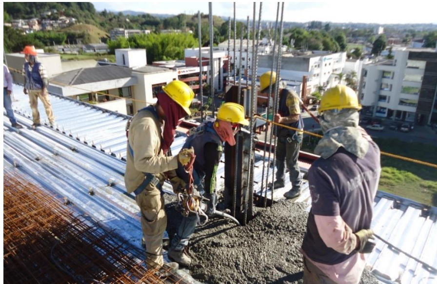
Figura 22. Vibrado del concreto en una columna.
