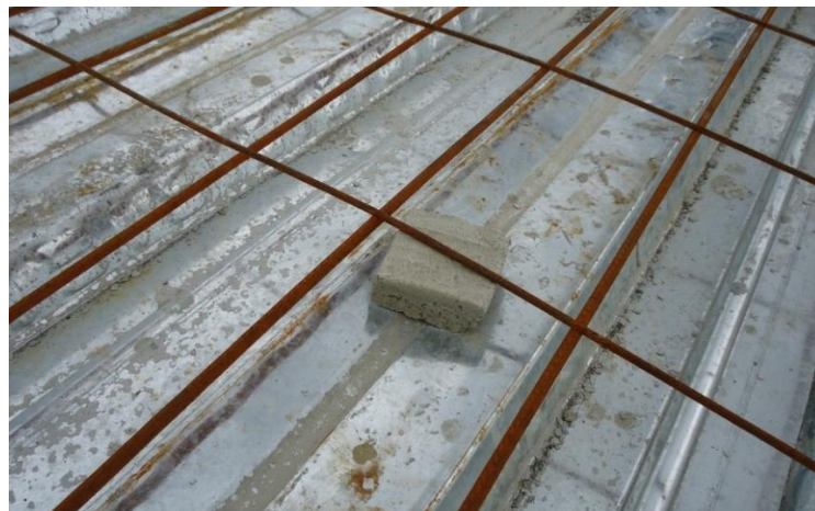
Figura 29. Colocación de panelas de concreto para garantizar recubrimiento.
