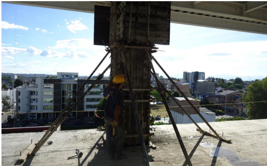
Figura 19. Apuntalamiento de la formaleta metálica.
