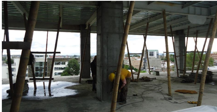
Figura 26. Apuntalamiento de las vigas y viguetas.
