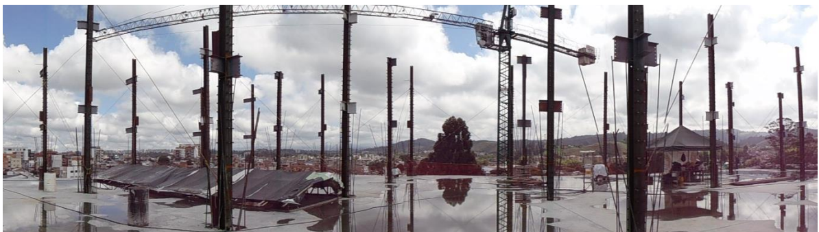
Figura 45. Panorámica del izaje de las columnas del sexto y séptimo piso.
