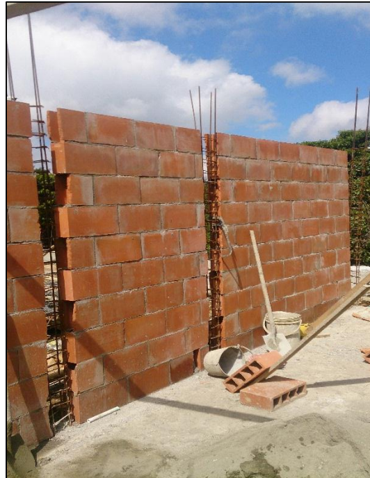
Figura No. 43 Localización y replanteo de la mampostería
