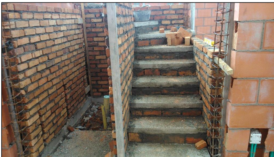
Figura No. 51 Instalación de peldaños.
