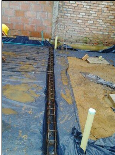
Figura No.21 Instalación de acero para vigas de cimentación.
