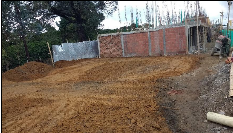
Figura No.12 Adecuación de terreno para inicio de construcción Fuente: propia
