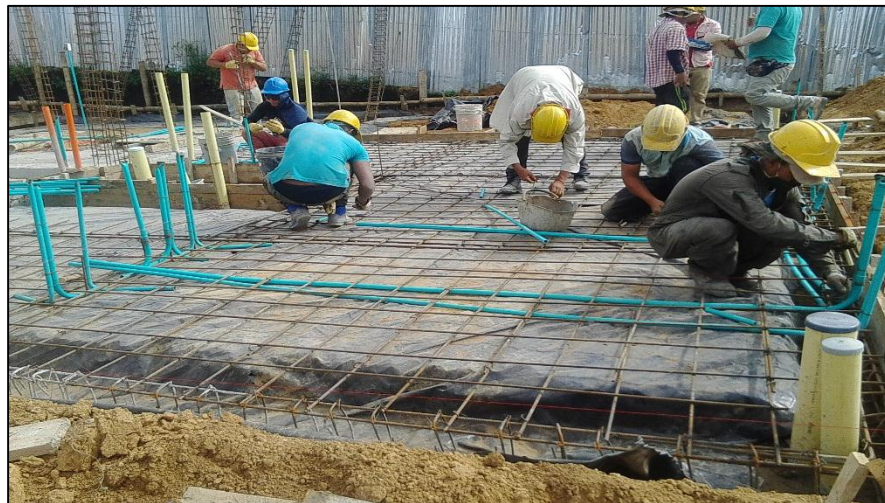
Figura No. 25 Localización del acero de estructural.
