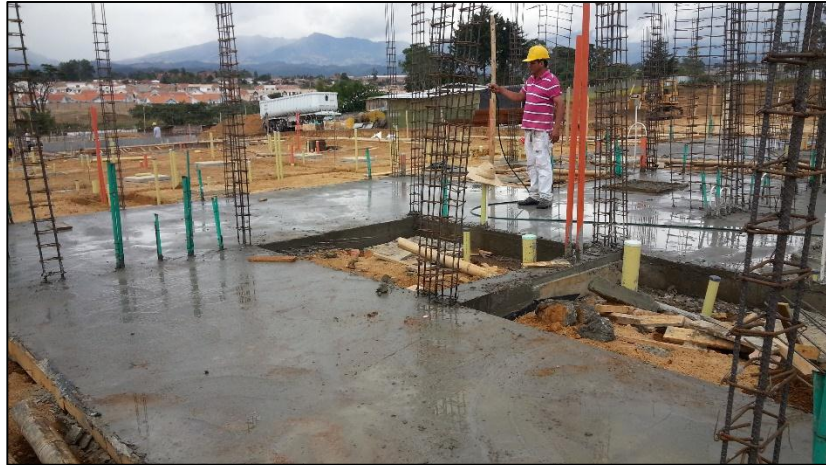
Figura No. 38 Curado de concreto con agua.
