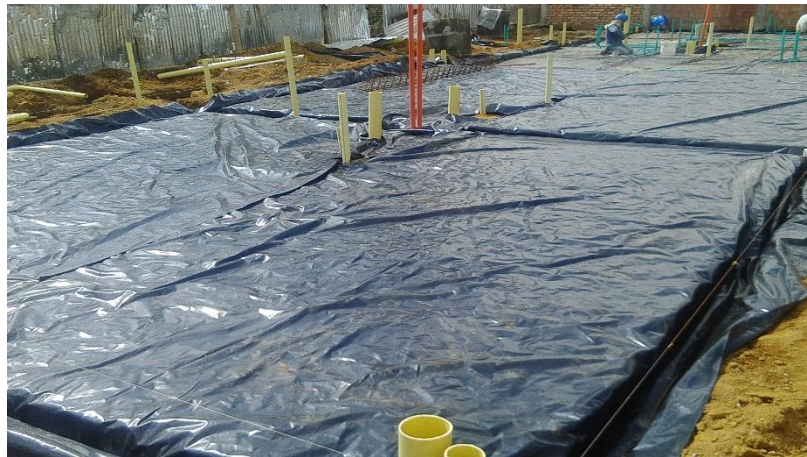
Figura No. 18 Ubicación del plástico negro polisecc.
