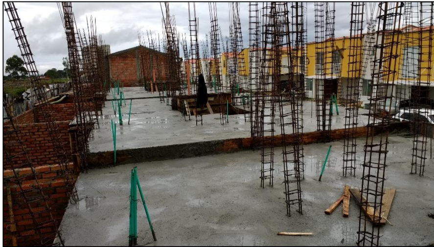
Figura No. 55 Curado del concreto.
