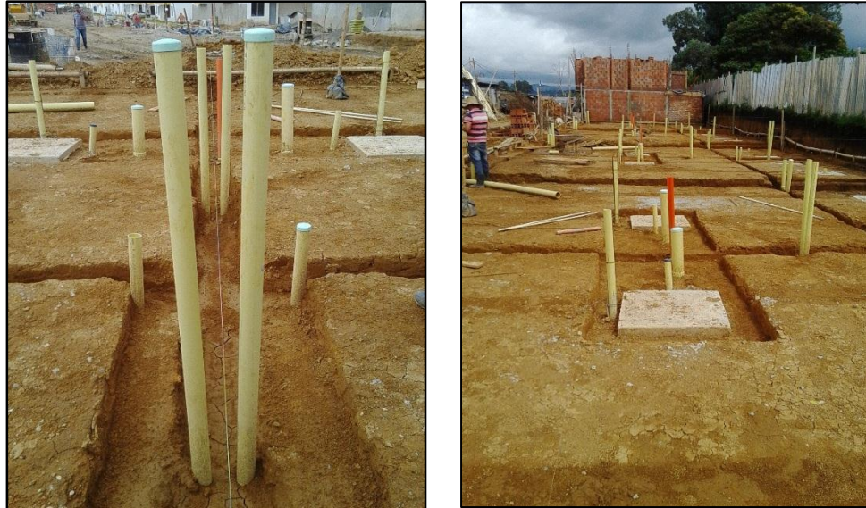
Figura No.15 verificación de posición de tubería y liberación de actividad, Manzana A casas de 1 a 8.
