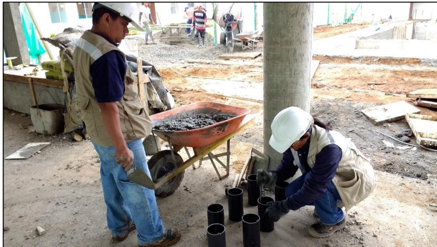
Figura No.41 Cilindros de concreto
