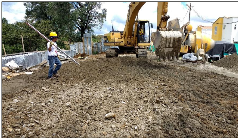
Figura No.10 Adecuación de terreno con retroexcavadora Cat 320 para inicio de construcción- Fuente: propia
