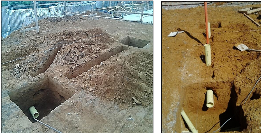
Figura No.13 Excavación de desagües y cajas de inspección Fuente: propia
