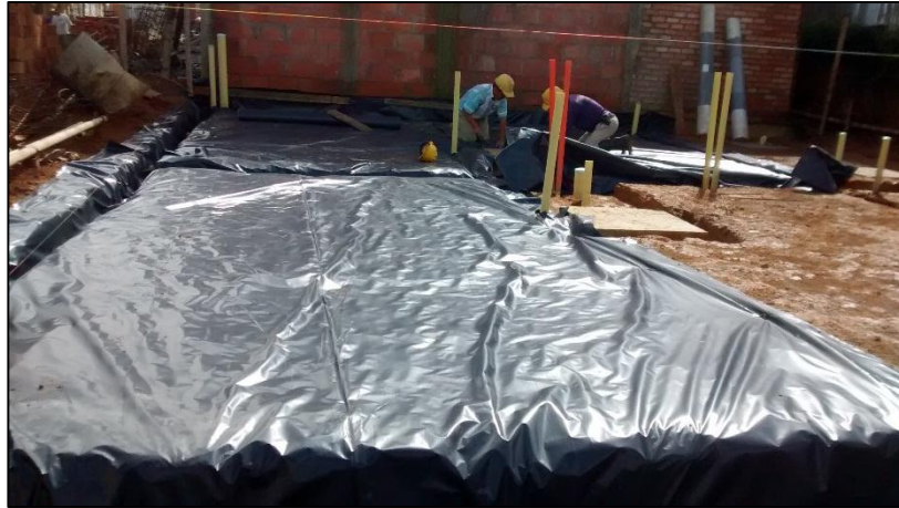
Figura No. 17 Ubicación del plástico negro polisecc.
