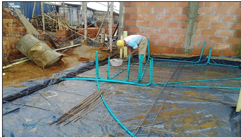
Figura No. 20 Instalación de acero de refuerzo para cimentación.
