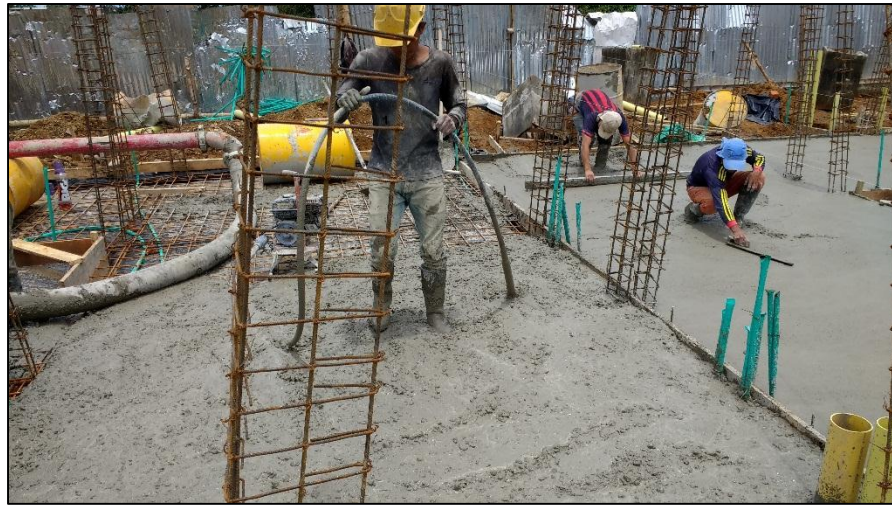
Figura No. 36 Uso de vibrador en fundición.
