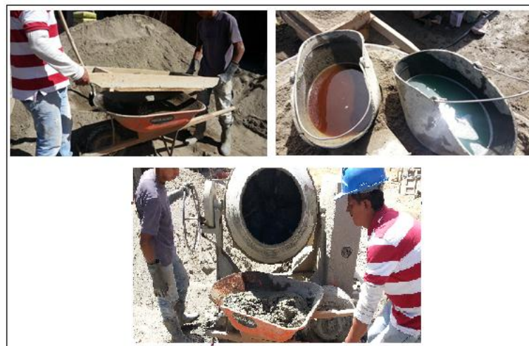
Figura No.45 Preparación del mortero de pega.
