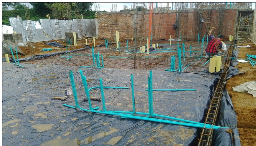
Figura No.23 Localización del acero estructural e instalación de tubería para sistema Eléctrico
