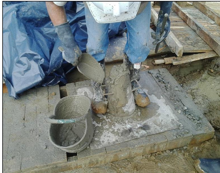
Figura No. 39 Ensayo in situ asentamiento de concreto.
