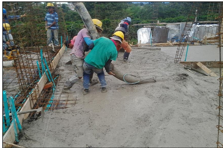
Figura No. 35 Colocación del concreto
