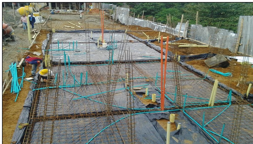
Figura No. 26 Localización del acero de estructural.
