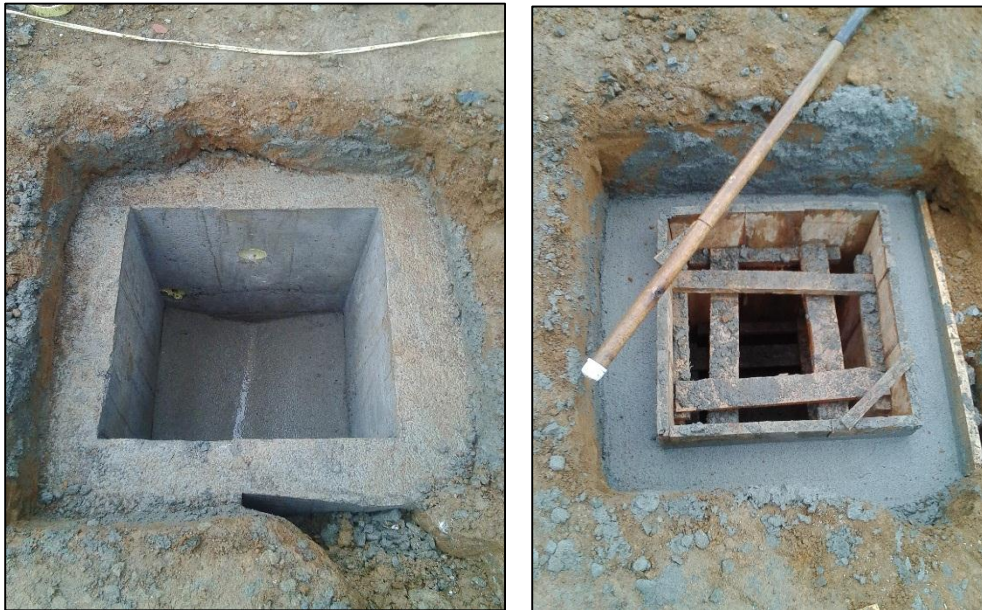
Figura No.14 Encofrado y Fundición de cajas de inspección. Fuente: propia
