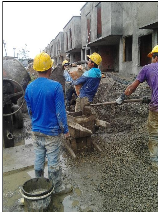
Figura No. 34 Preparación concreto en mezcladora de 1 bulto de cemento.
