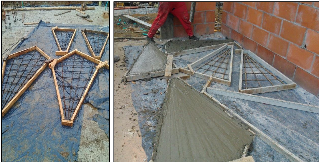
Figura No. 49 Formaleta y refuerzo en peldaños de gradas.
