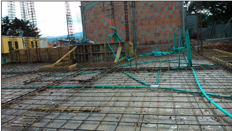
Figura No. 53 Colocación de acero de losa de entrepiso y de estructura
