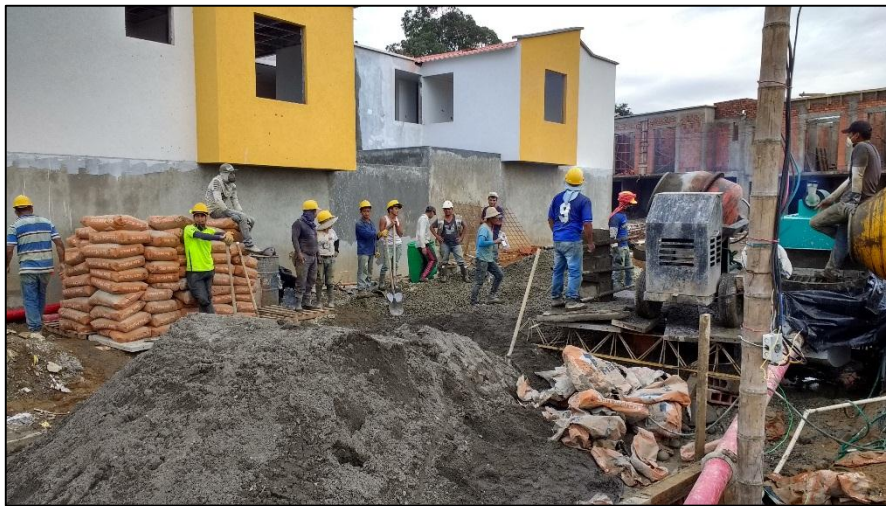
Figura No. 29 Acopio de materiales para fundición.
