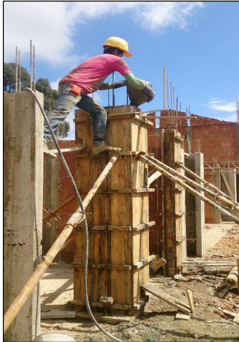
Figura No. 48 Apuntalamiento y vaciado de concreto
