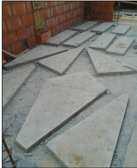
Figura No. 50 fundición de peldaños para grada
