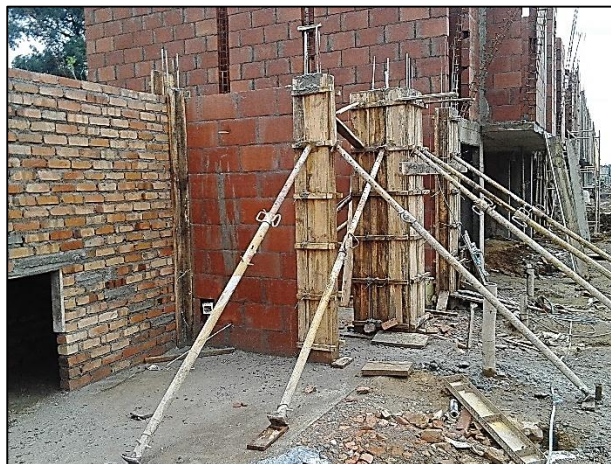
Figura No. 47 Formaleta de columnetas
