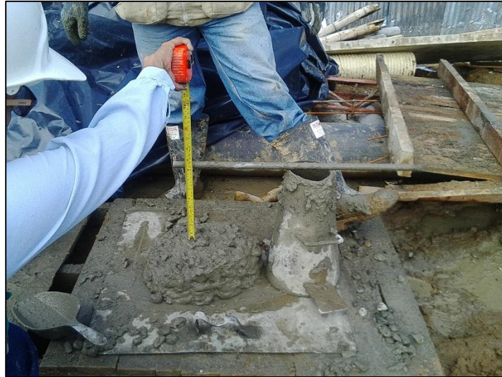
Figura No. 40 Ensayo in situ asentamiento de concreto
