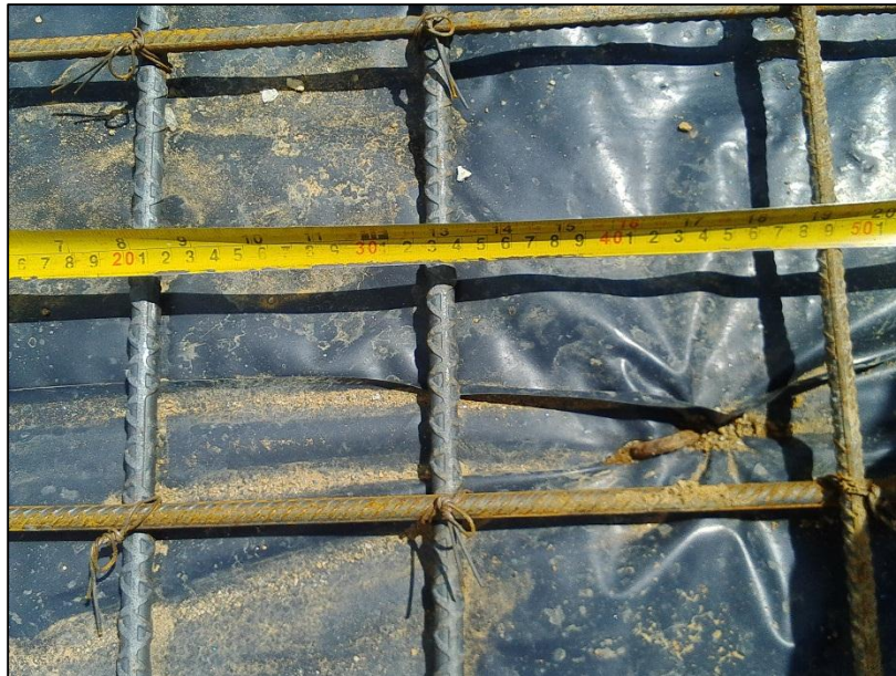
Figura No. 22 Verificación de instalación de acero para cimentación
