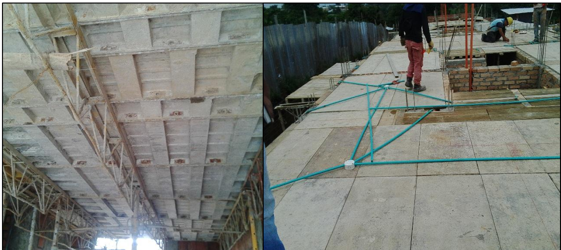
Figura No. 52 Instalación de formaleta para losa de entrepiso.
