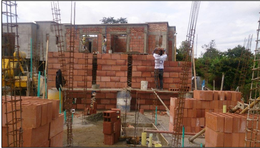
Figura No. 44 Localización de niveles mampostería
