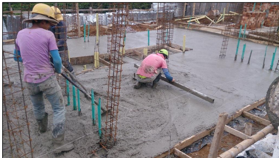
Figura No. 37 Fundición placas de cimentación.
