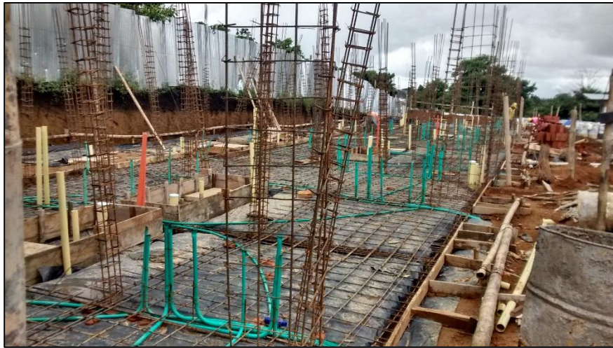
Figura No.24 Localización del acero estructural.
