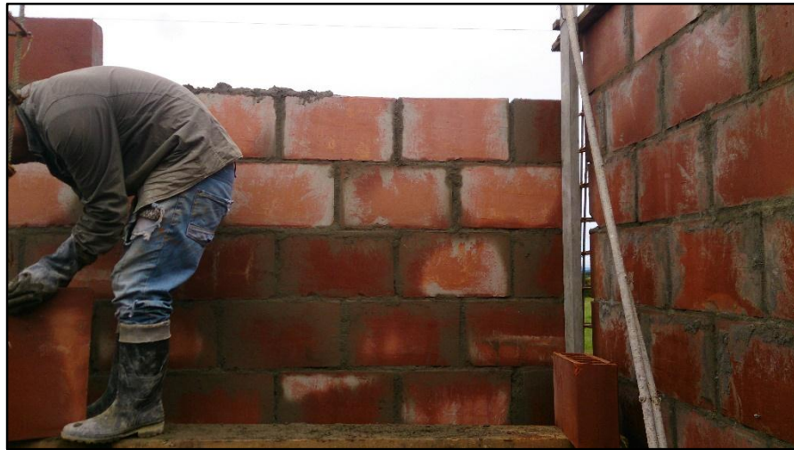
Figura No. 46 Pega de mampostería.
