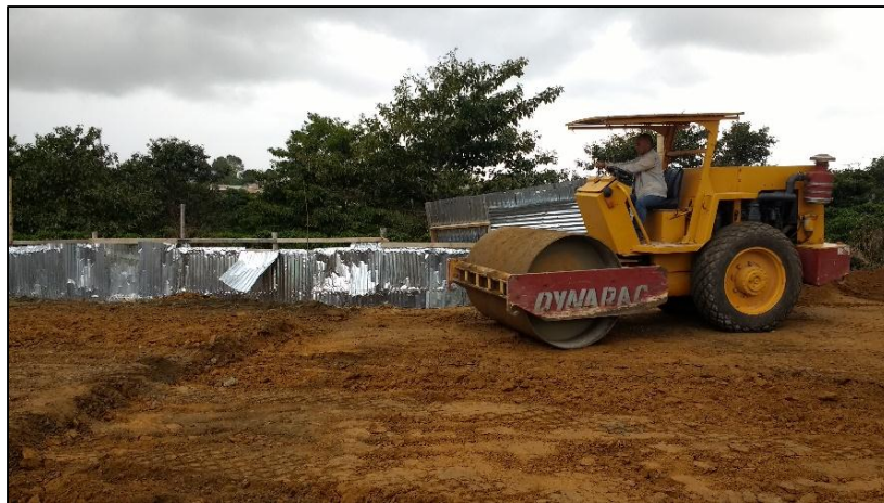
Figura No.11 Adecuación de terreno con vibrocompactador Dynapac para inicio de construcción - Fuente: propia
