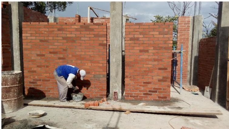
**Foto 14: Construcción de muro**
