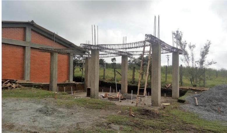
**Foto 21: Columnas y avance construcción vigas**
