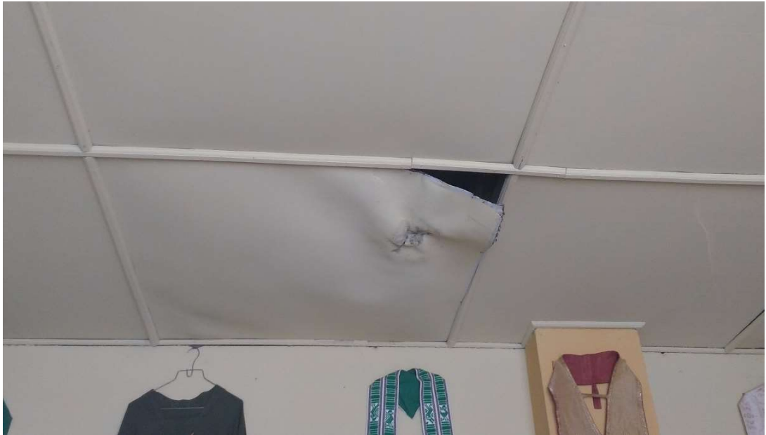
Figura 5. Deterioro en el cielo falso #2. Fuente Propia
