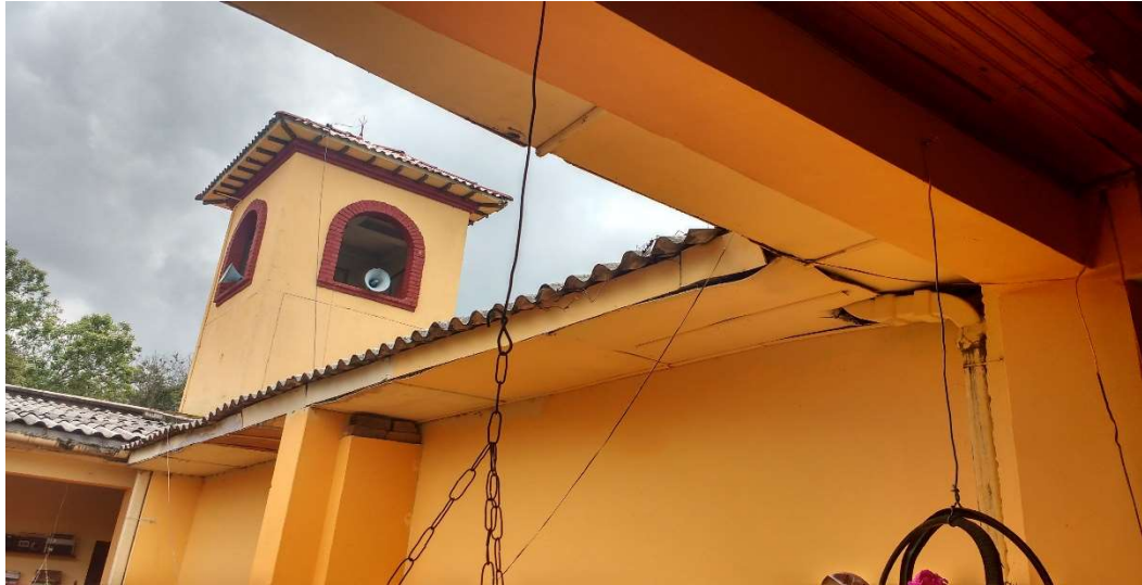
Figura 9. Problemas de humedad en el primer piso. Fuente propia
