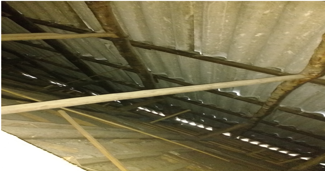
Figura 3. Estado actual de la cubierta. Fuente propia.
