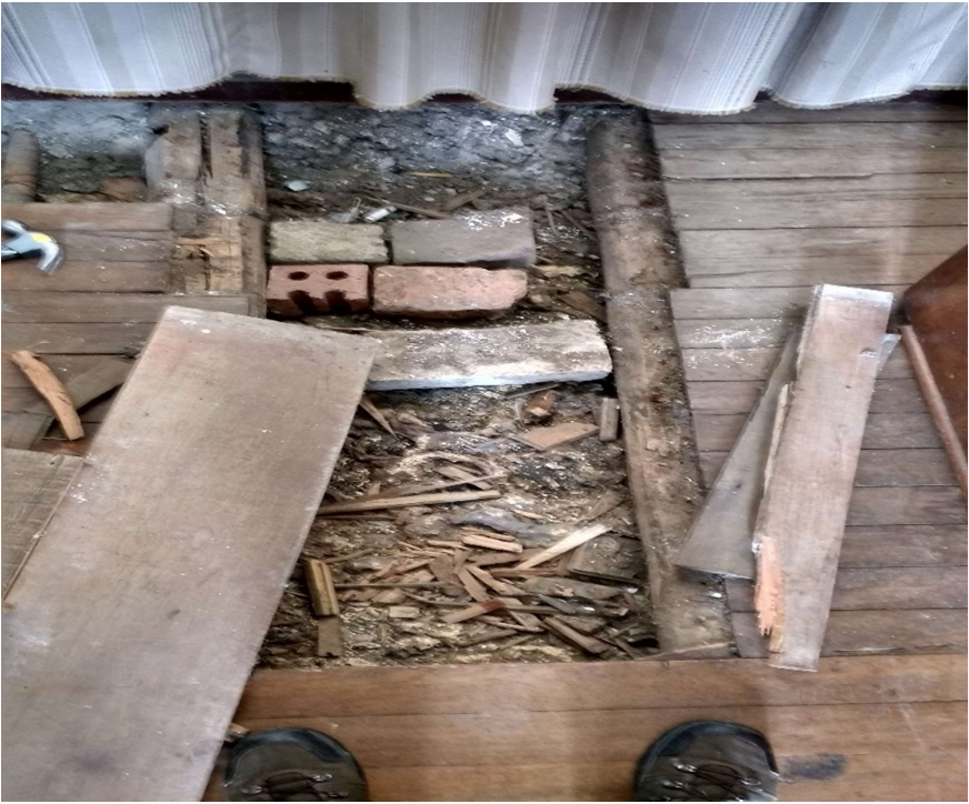
Figura 12. Retiro del piso de madera #3. Fuente propia.
