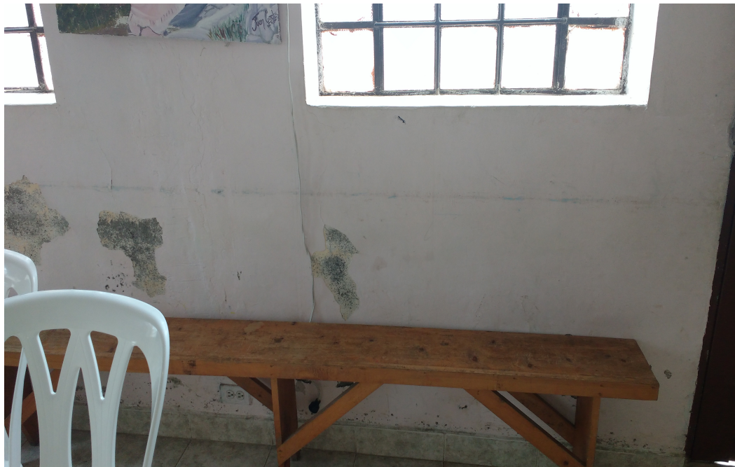
Figura 9. Problemas de humedad en el primer piso. Fuente propia
