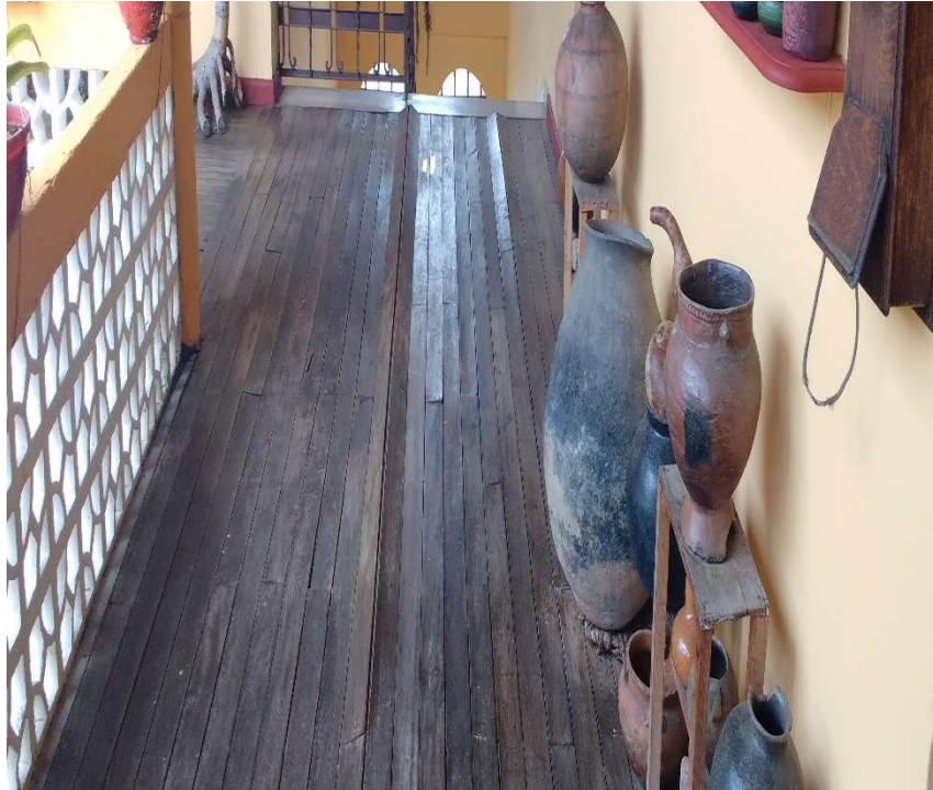
Figura 7. Deterioro en el piso de madera #2. Fuente Propia.
