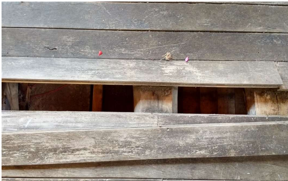
Figura 14. Vigas de madera en el entrepiso actual. Fuente Propia.
