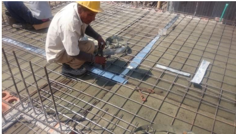
Imagen 23: Sellado de juntas entre tableros
