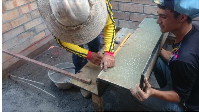
Imagen32: formaletia y armada de aceros de las escaleras.
