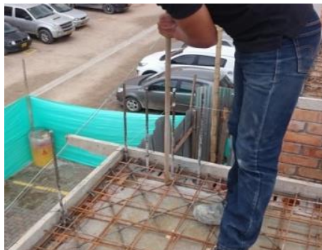
Imagen 26: Chequeo de niveles y liberación de losa.
