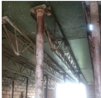
Imagen22: Encofrada de losa de entrepiso.
