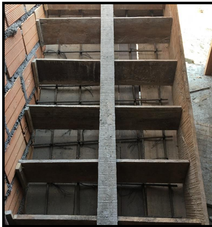
Figura 56. Instalación de la formaleta para las escaleras Fuente: Propia
