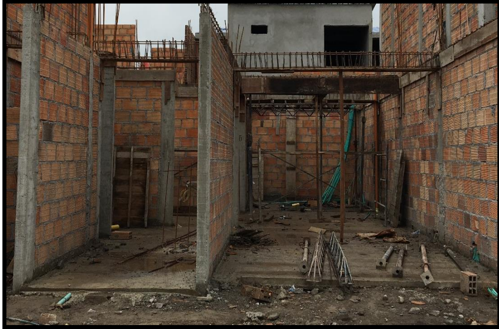
Figura 33. Casa después de fundido el piso primario Fuente: Propia
