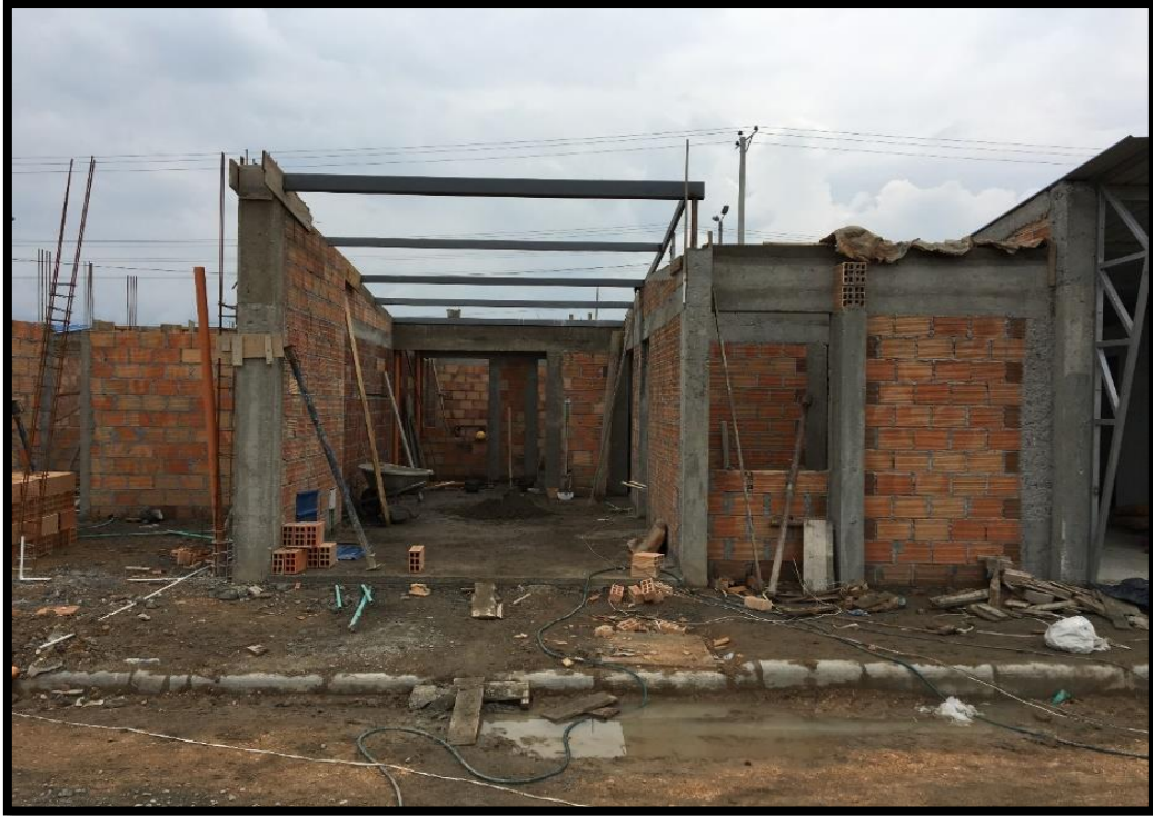
Figura 45. Casa antes de poner la cubierta Fuente: Propia
