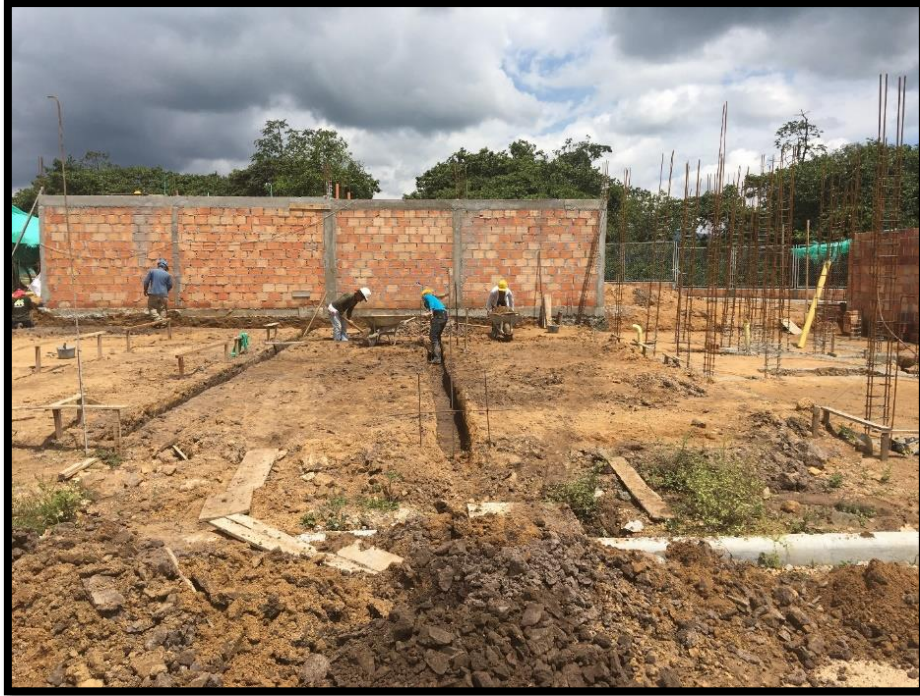
Figura 12. Excavación manual Fuente: Propia
