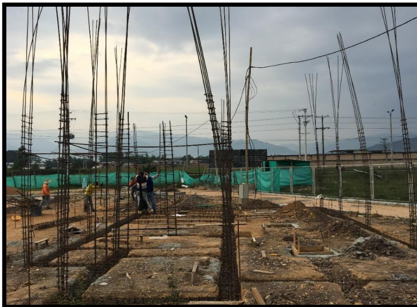
Figura 25. Instalación de los castillos de columnas
