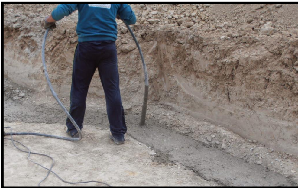
Figura 18. Vibrado de la cimentación Fuente: Propia
