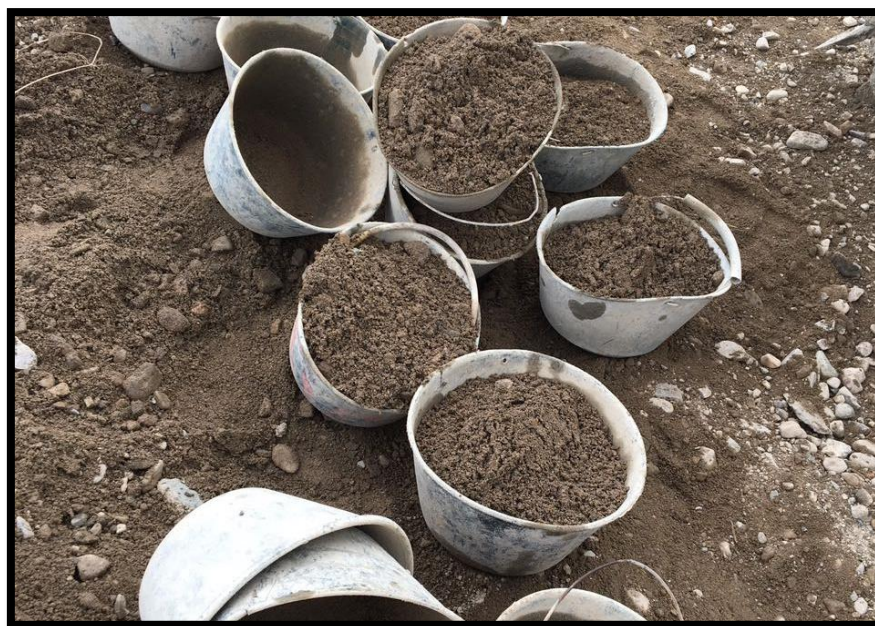
Figura 30. Cuñetes con el material para fundir el piso primario
