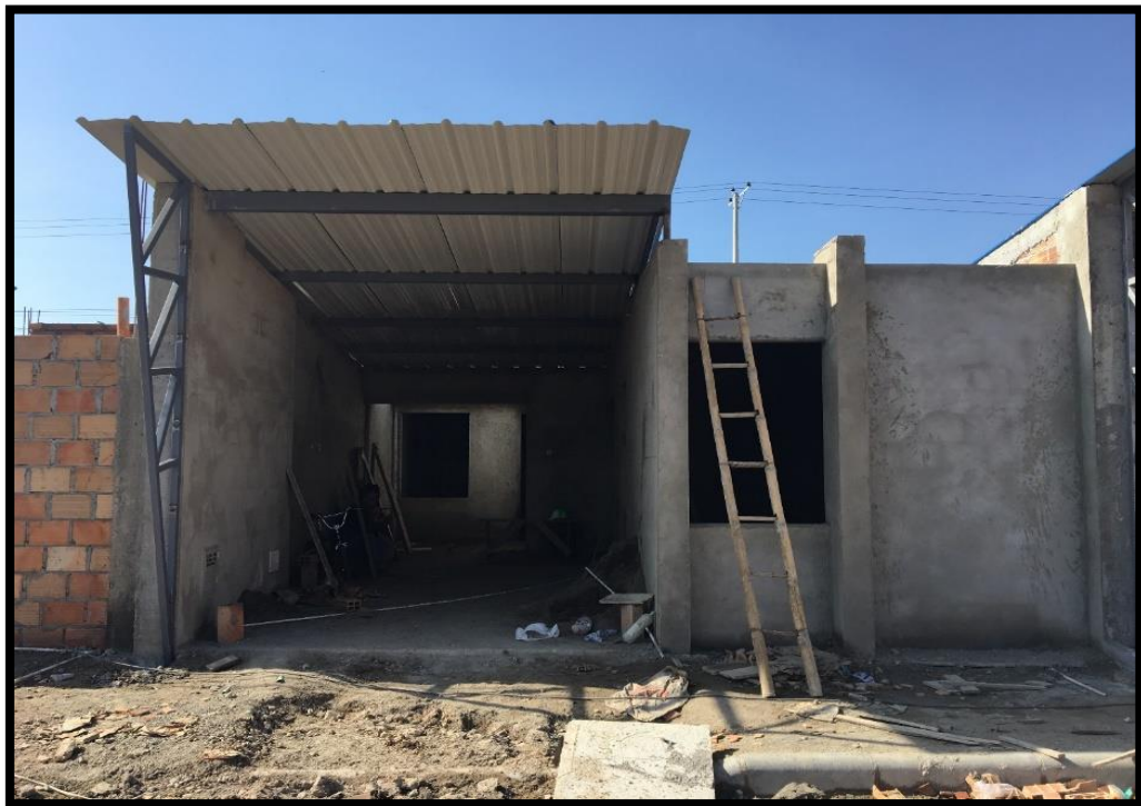
Figura 46. Casa después de poner la cubierta Fuente: Propia
