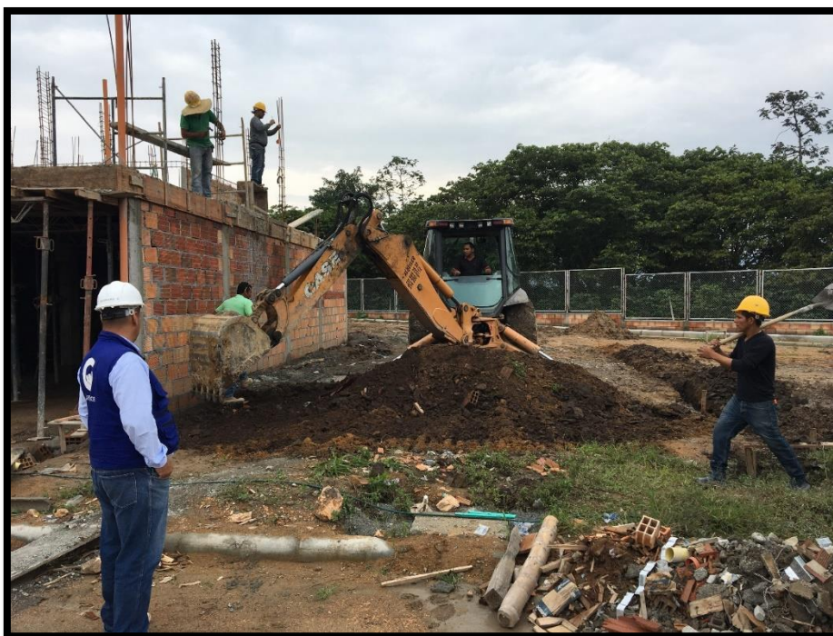
Figura 10. Explanación con maquinaria Fuente: Propia
