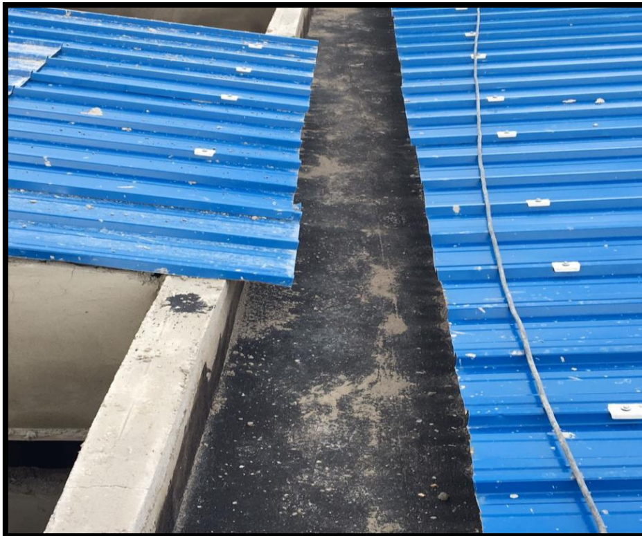
Figura 37. Viga canal recubierta con impermeabilizante Fuente: Propia
