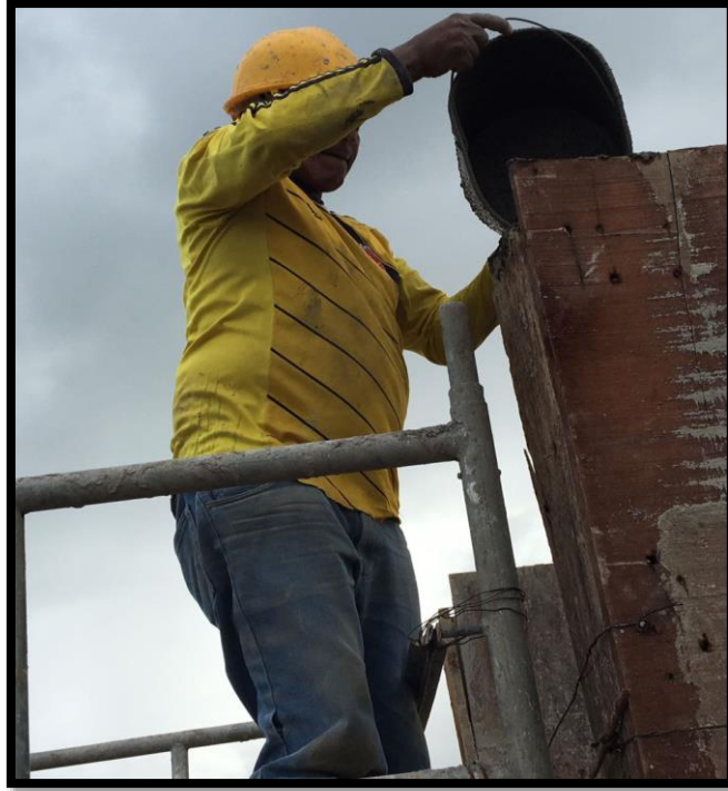
Figura 26. Vaciado de las columnas Fuente: Propia
