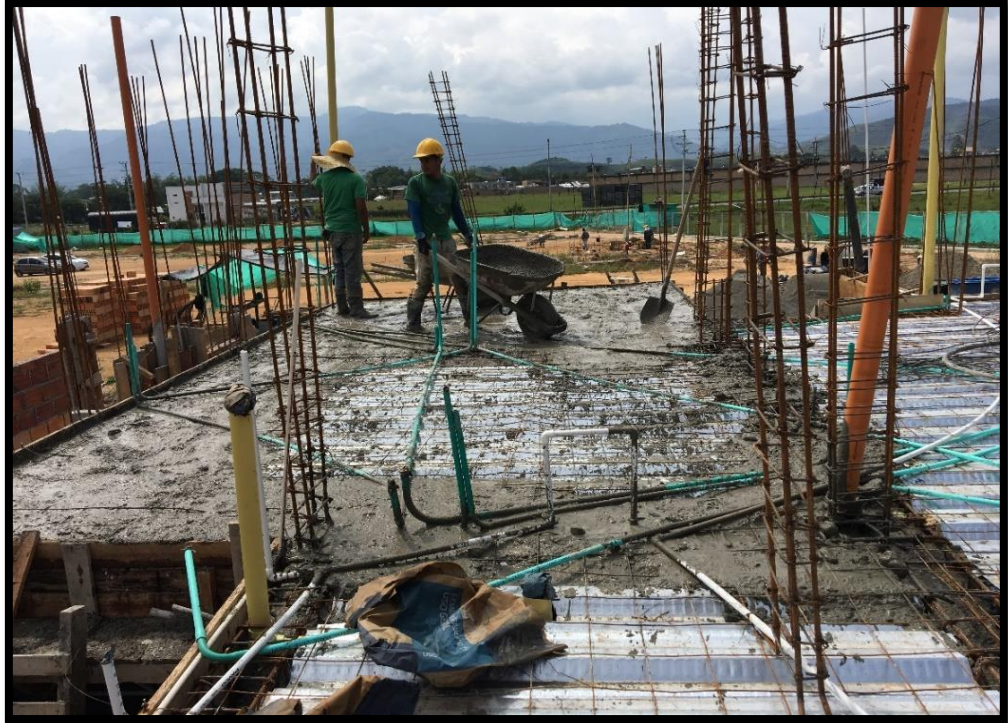
Figura 54. Fundición de la losa de entrepiso Fuente: Propia
