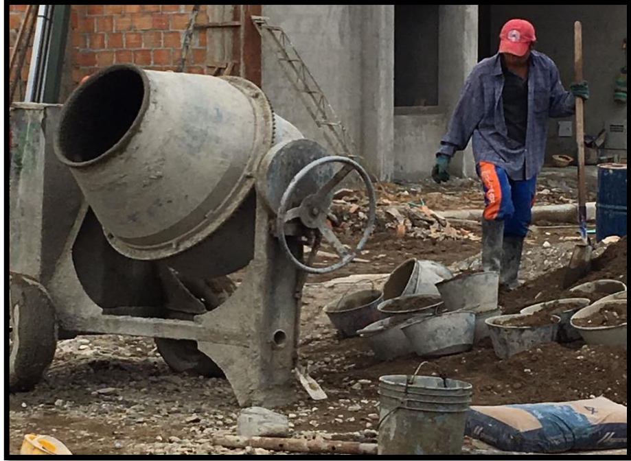
Figura 31. Cuñetes con el material para fundir el piso primario Fuente: Propia
