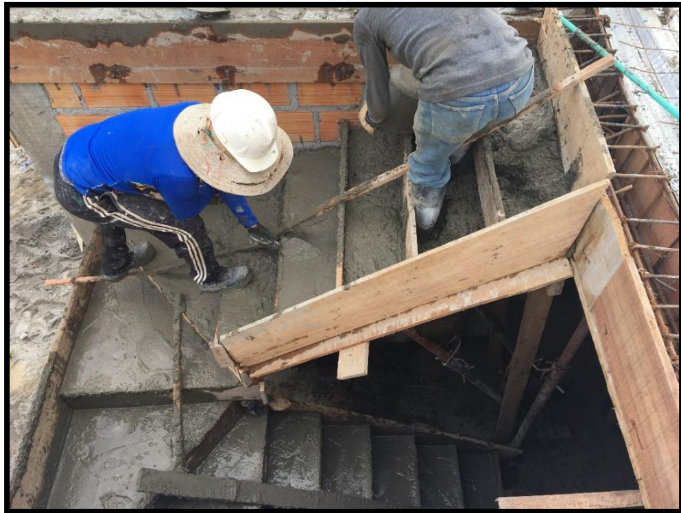
Figura 58. Fundición de las escaleras Fuente: Propia
