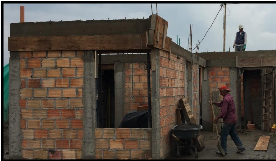
Figura 29. Instalación de las formaletas de vigas Fuente: Propia
