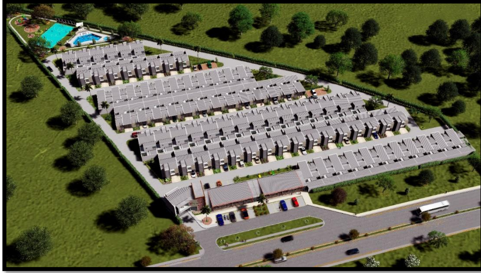
Figura 4. Diseño final del proyecto Fuente: Archivo de Administración Construimos del Huila
