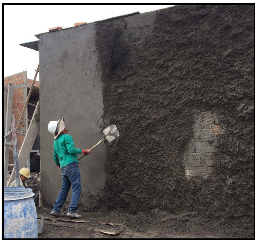
Figura 47. Maestro pañetando la parte exterior Fuente: Propia
