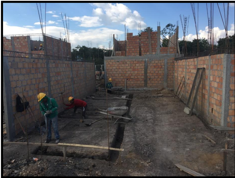
Figura 13. Excavación manual Fuente: Propia
