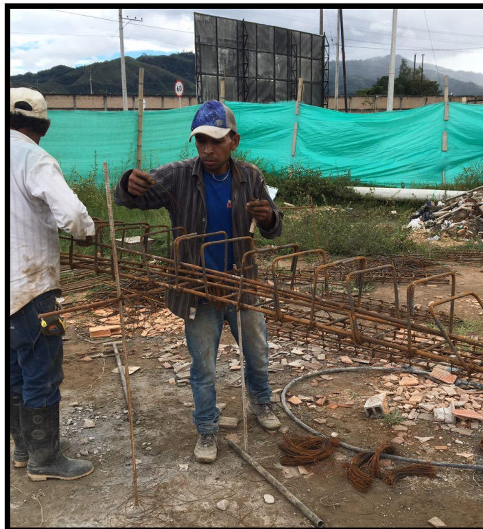
Figura 16. Armado de los castillos de acero previos a instalar Fuente: Propia
