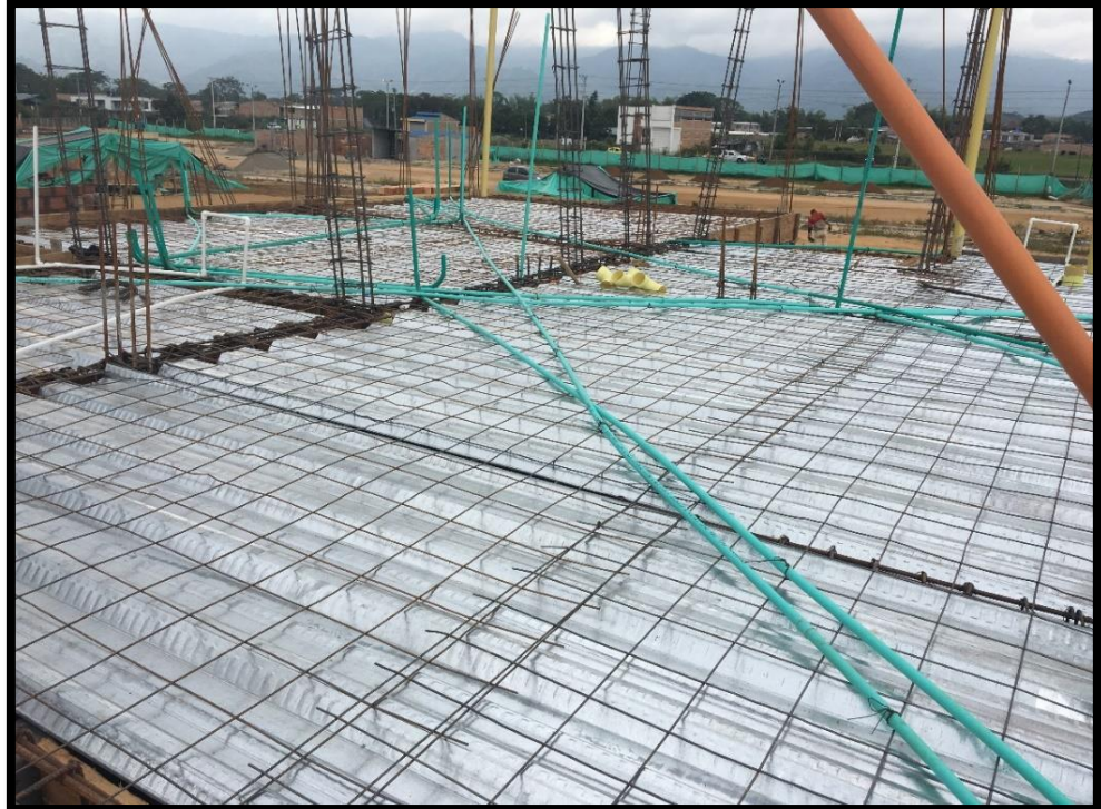
Figura 52. Instalación de la corpalosa, malla electrosoldada y conducciones Fuente: Propia
