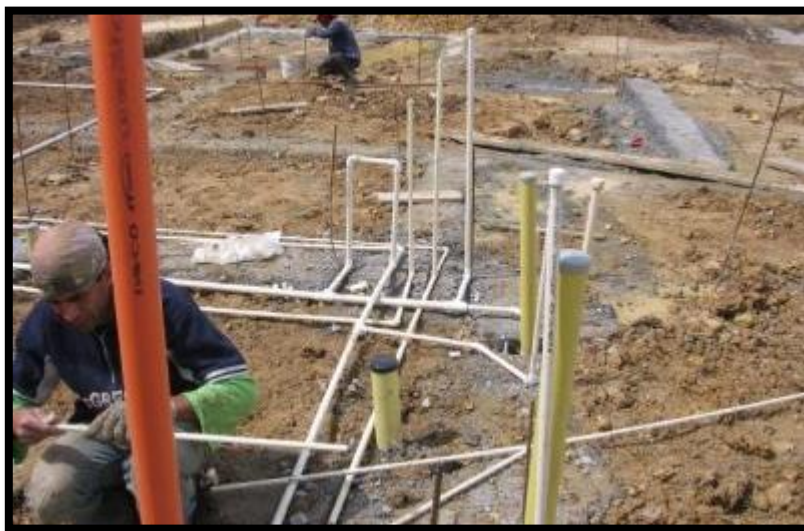
Figura 20. Oficial instalando las conducciones
