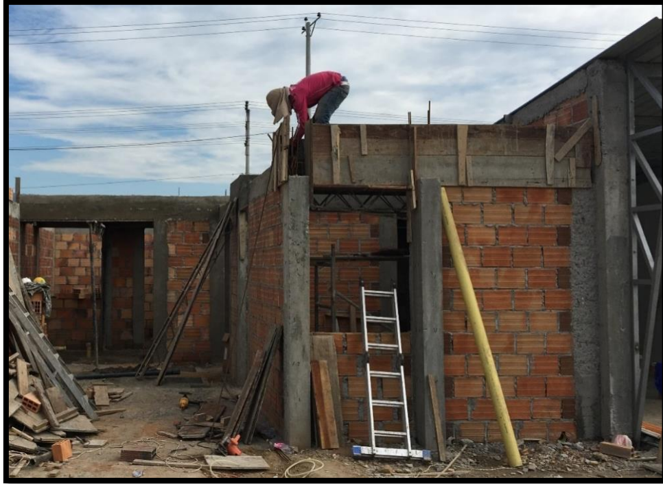
Figura 36. Instalación de la formaleta para vigas canales Fuente: Propia
