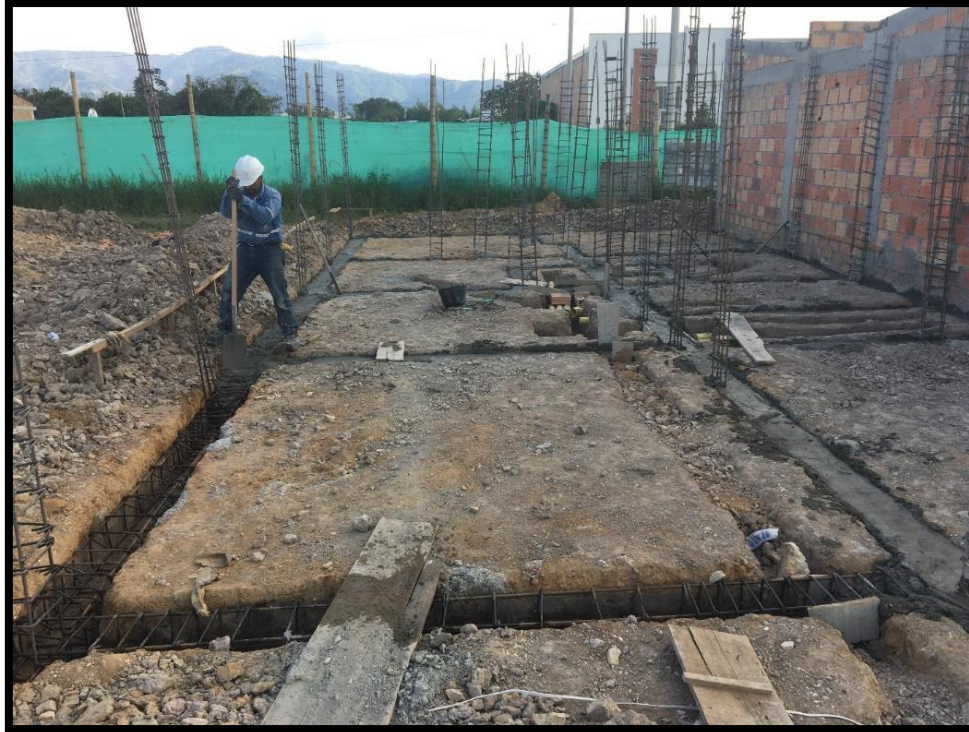
Figura 17. Fundición de la cimentación en proceso Fuente: Propia
