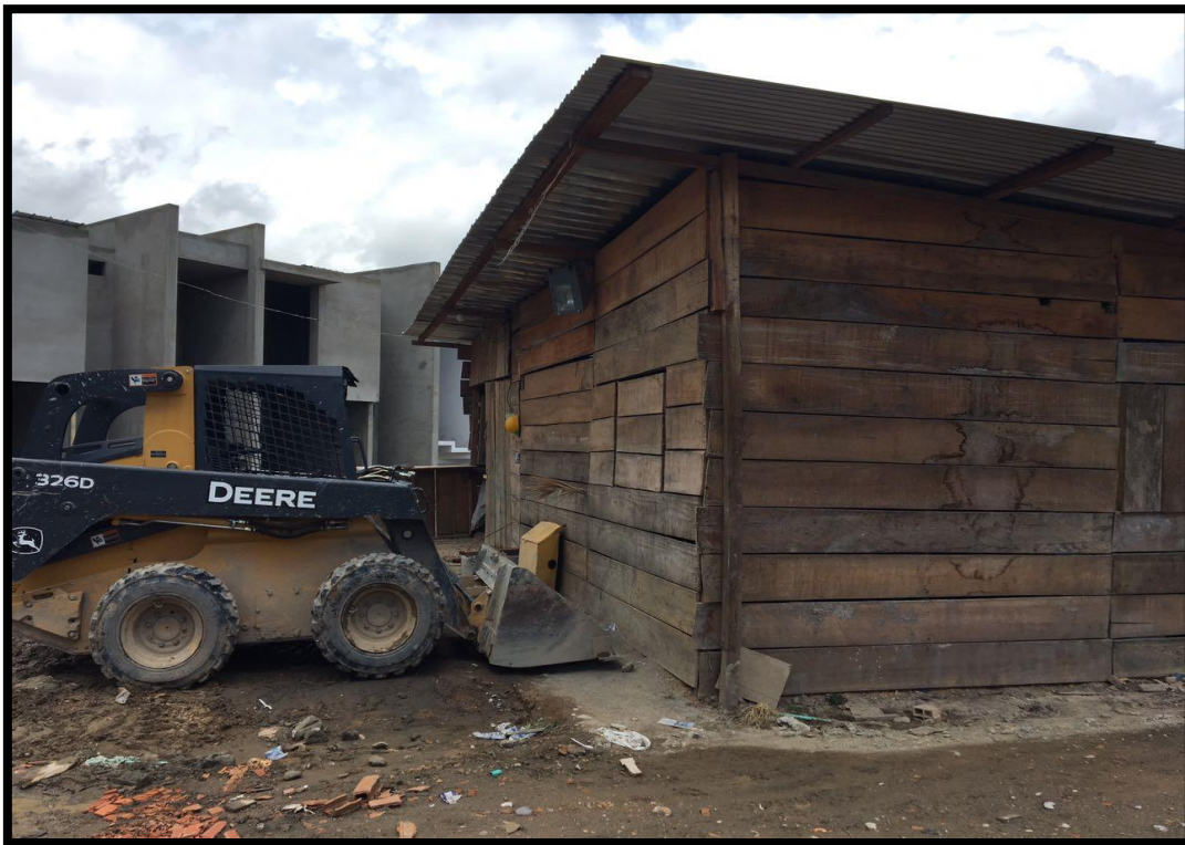
Figura 59. Almacén de la obra Fuente: Propia
