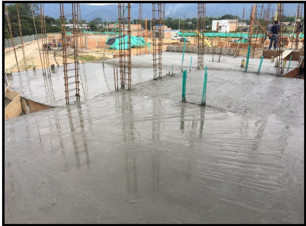
Figura 55. Losa de entrepiso fundida Fuente: Propia
