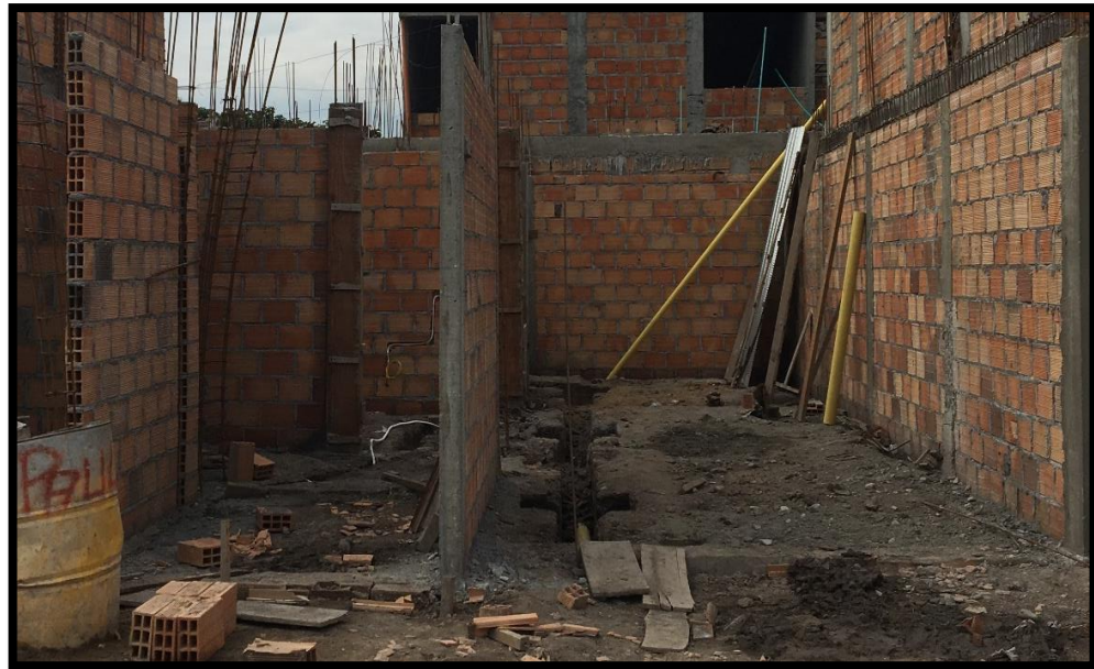
Figura 32. Casa en preparación para el piso primario Fuente: Propia
