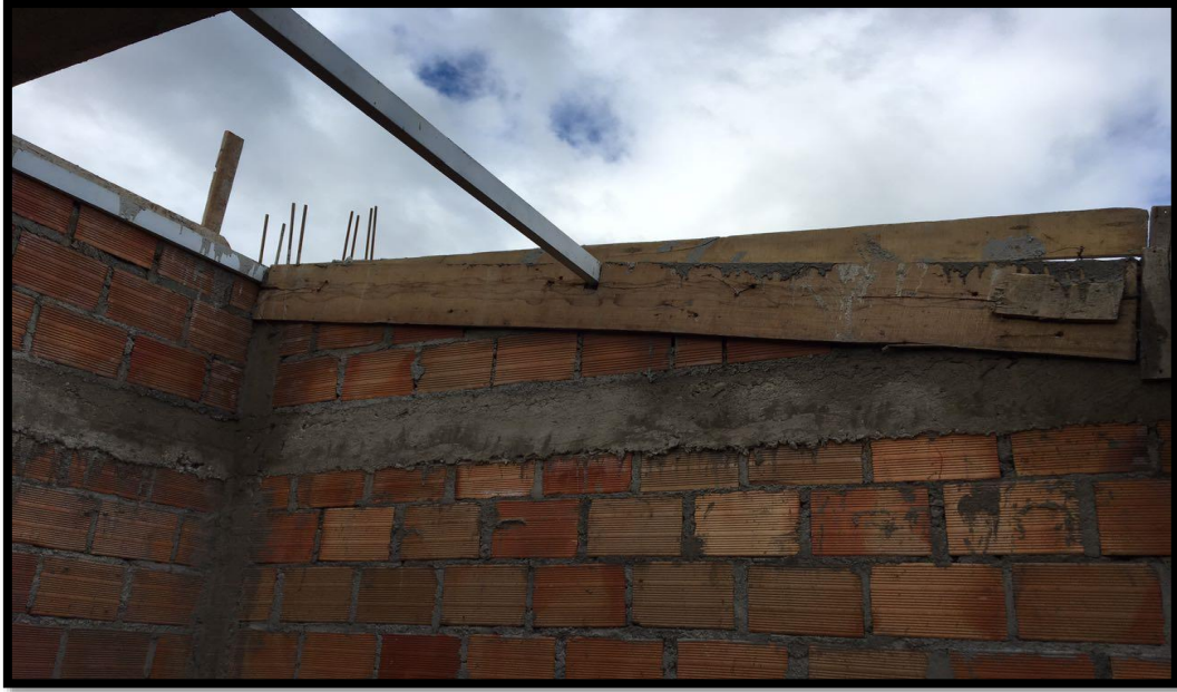
Figura 41. Viga cinta fundida y amarrada a los perfiles de acero Fuente: Propia
