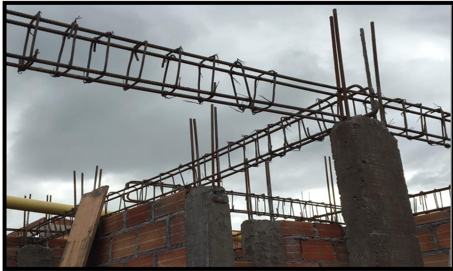
Figura 28. Acero de las vigas instaladas Fuente: Propia
