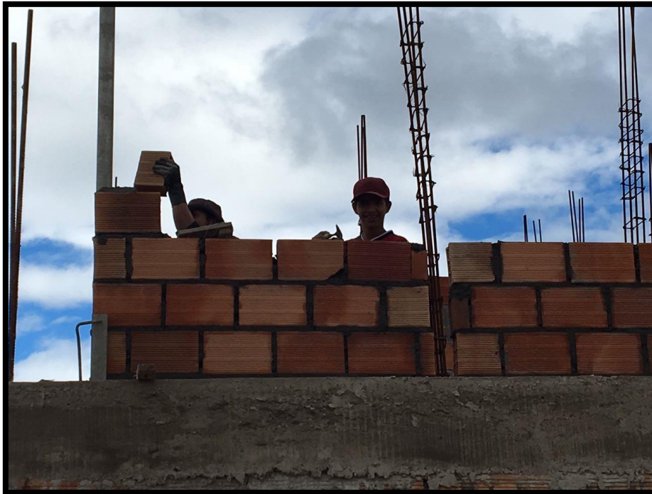
Figura 23. Maestro y obrero en la pega de bloque Fuente: Propia
