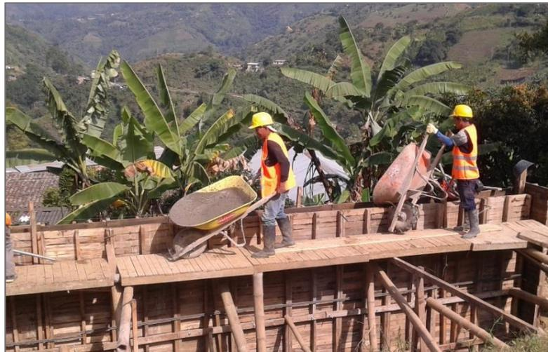
**Figura 47:** vaciado del concreto
