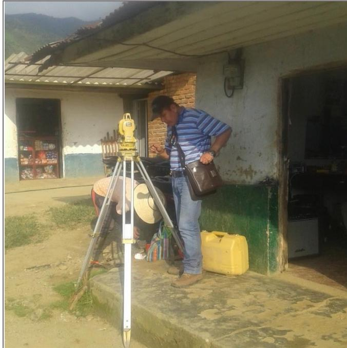
**Figura 12:** Delta No 2, Replanteo topográfico
