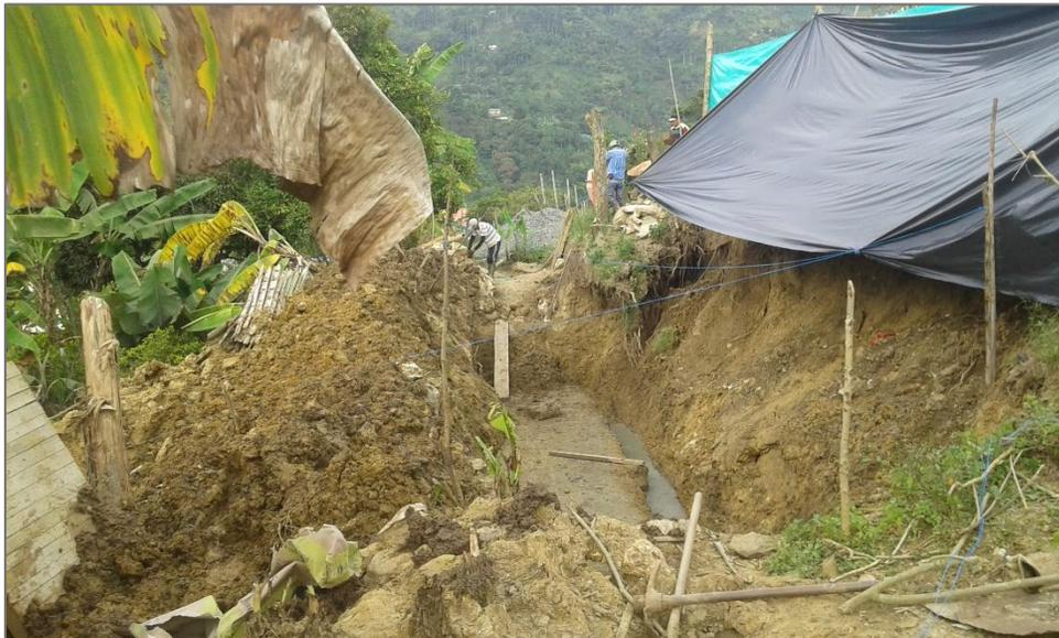
**Figura 34:** Excavación a mano muro en concreto reforzado
