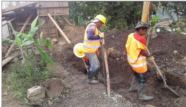
**Figura 36:** Excavación a mano
