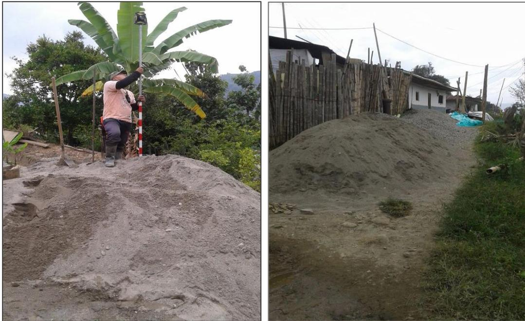
**Figura 16:** Material granular del concreto, Arena Lavada de Rio
