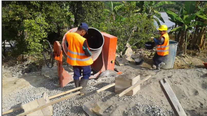
**Figura 26:** Mezclado del concreto
