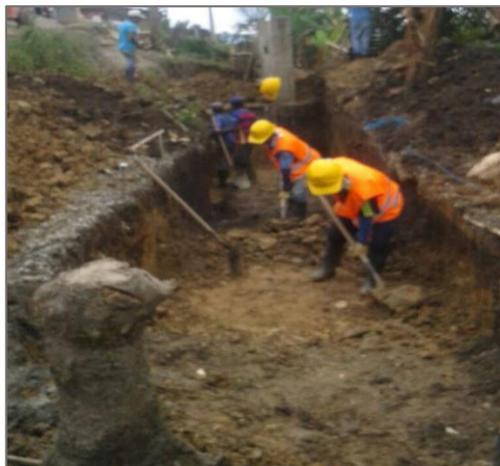
**Figura 37:** Excavación a mano
