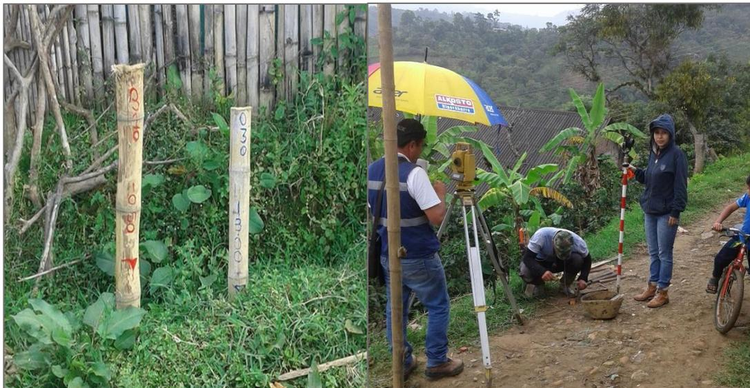
**Figura 13:** Delta No 3, Replanteo topográfico y esterillas de nivelación
