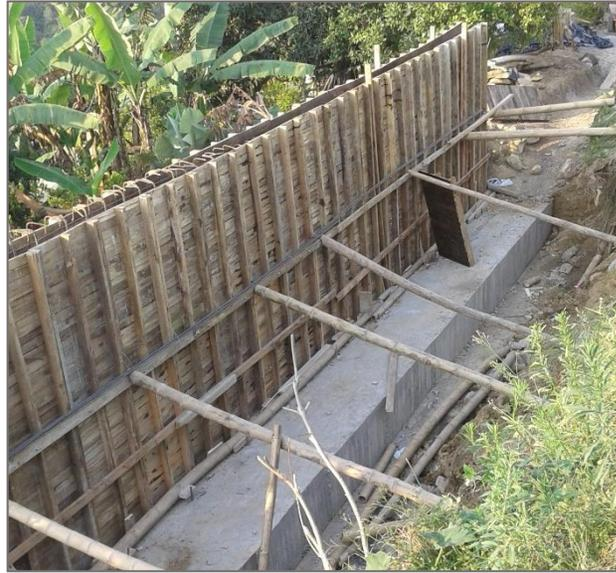
**Figura 45:** conформación de la formaleta, muro tipo 1
