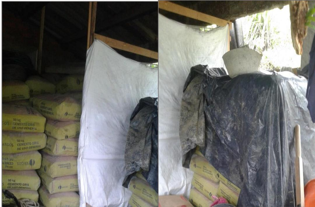
**Figura 14:** Almacenamiento del cemento en la obra
