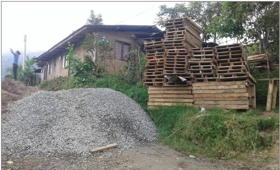
**Figura 15:** Material granular del concreto, Triturado 3/4
