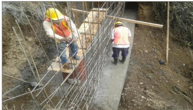
**Figura 43:** Detalle amarre de acero longitudinal
