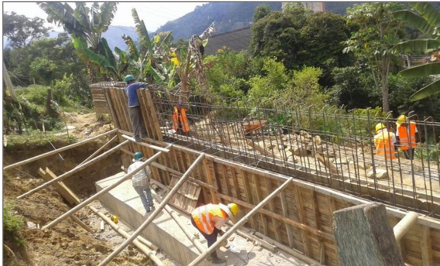
**Figura 44:** Instalación de la formaleta
