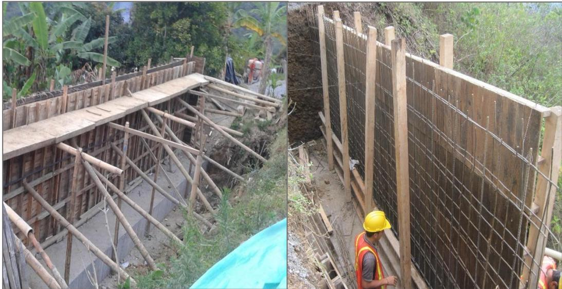
**Figura 46:** conформación de la formaleta, muro tipo 2
