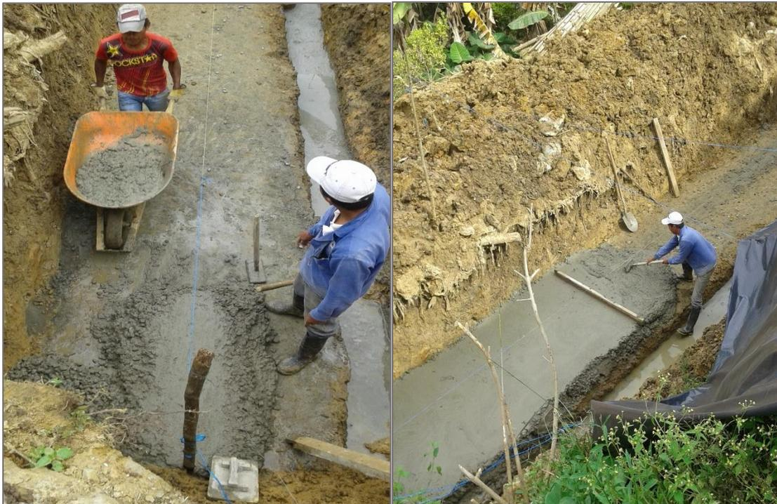
**Figura 39:** Fundición de solado para la zapata
