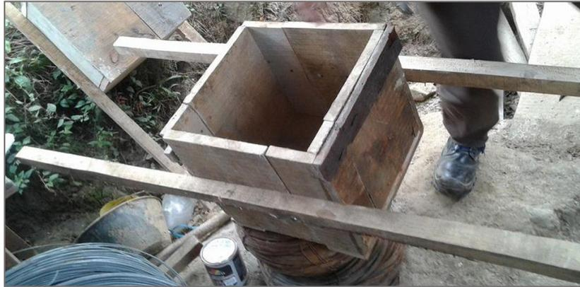
**Figura 21:** Construcción de cajones para agregados
