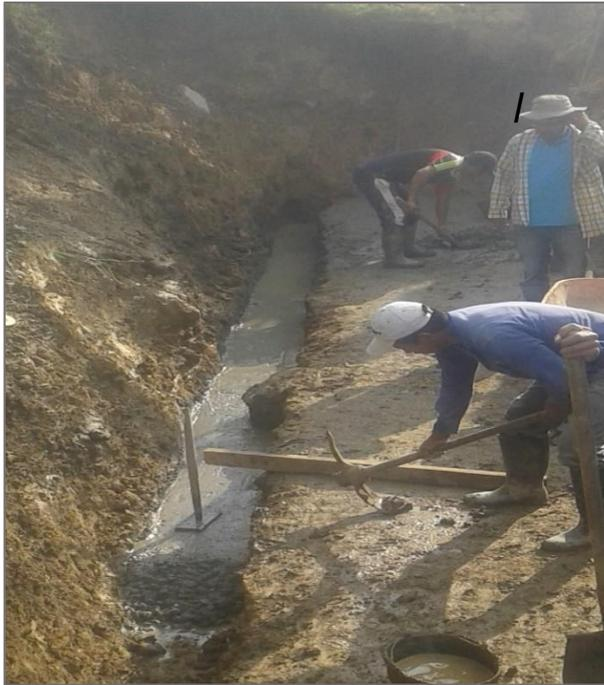
**Figura 38:** Fundición de Solado para dentellón
