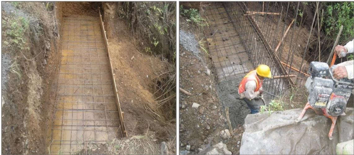
**Figura 42:** Detalle de parrilla para la zapata y el vástago, vaciado de concreto
