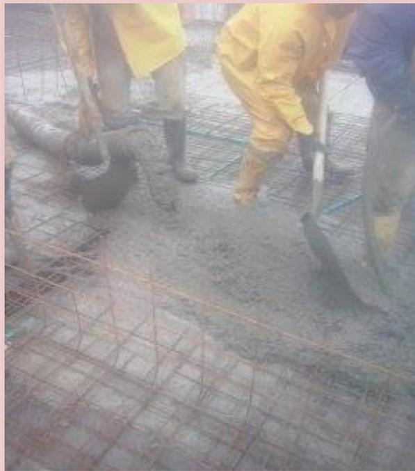
*Figura 33: Vaciado del concreto con el “moco” o “trompa de elefante”. Fuente: Elaboración propia.*
