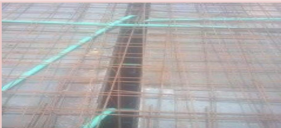
Figura 13: Malla superior e inferior de losa. Fuente: Elaboración propia
