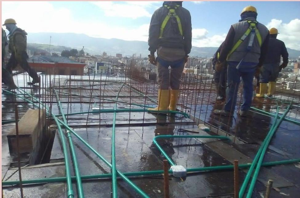
*Figura 23: Instalación red eléctrica. Fuente: Elaboración propia*
