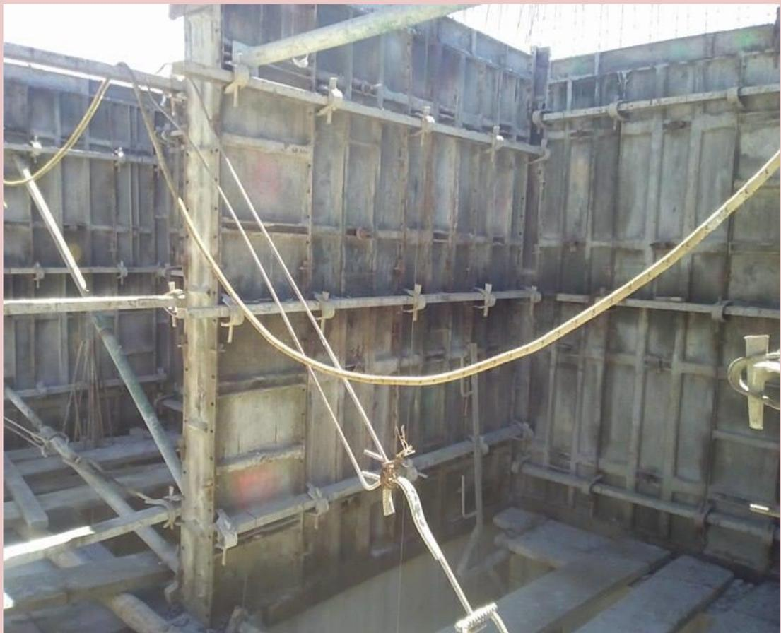
*Figura 26: Formaleta con todos sus elementos. Fuente Propia*
