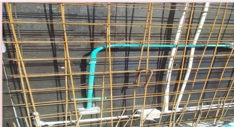
*Figura 21: Red hidráulica y sanitaria. Fuente: Elaboración propia*
