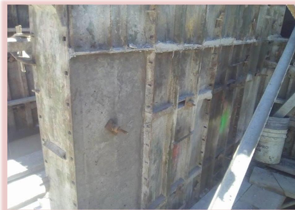
*Figura 24: Sistema CON-TECH, formaleta metálica. Fuente: Elaboración propia*
