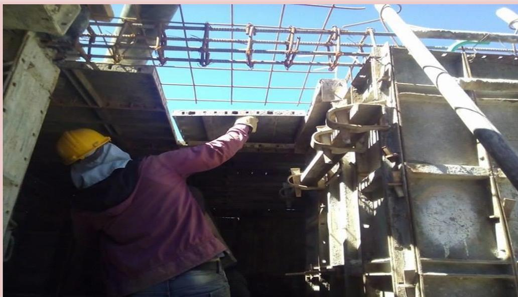
Figura 18: Estribos y distancias uniformes de dinteles. Fuente: Elaboración propia.
