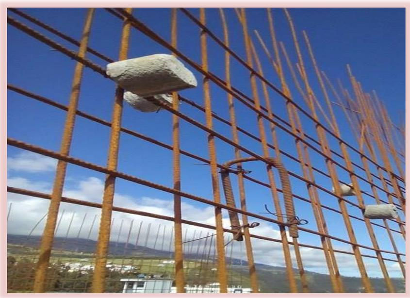
*Figura 19: Separadores y panelas de la malla. Fuente: Elaboración propia*
