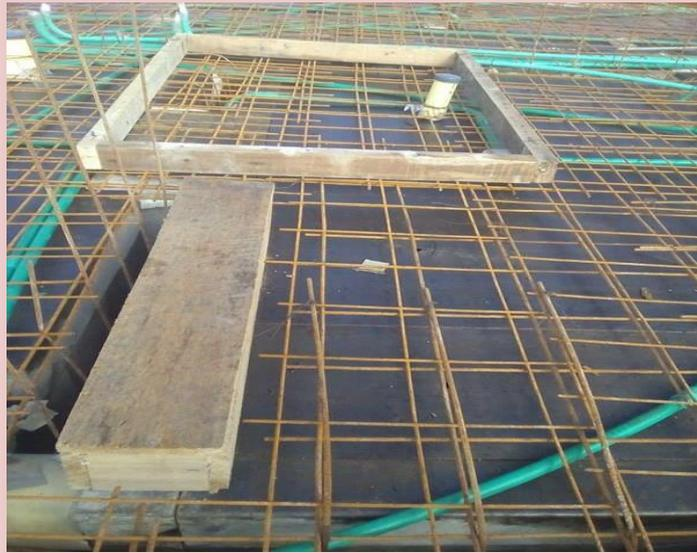
*Figura 20: Paso de tubería y puntos de ducha. Fuente: Elaboración propia*
