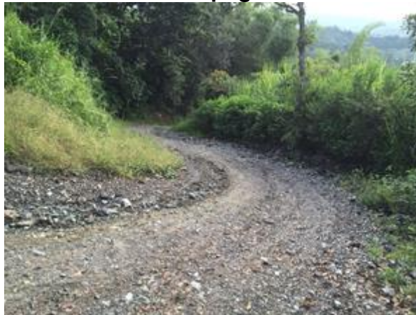
Figura 6. Levantamiento topográfico. Tramos de la vía
