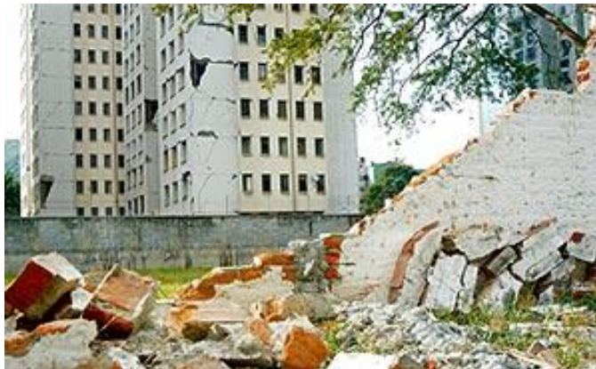
Figura 4. Daños causados en el sismo de Pizarro en Cali Fuente: Diario el país, 2004
