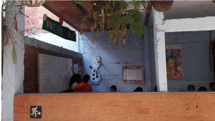
Figura 15. Evidencia de la inspección.
