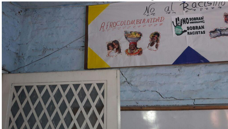
Figura 16. Evidencia de Inspección.
