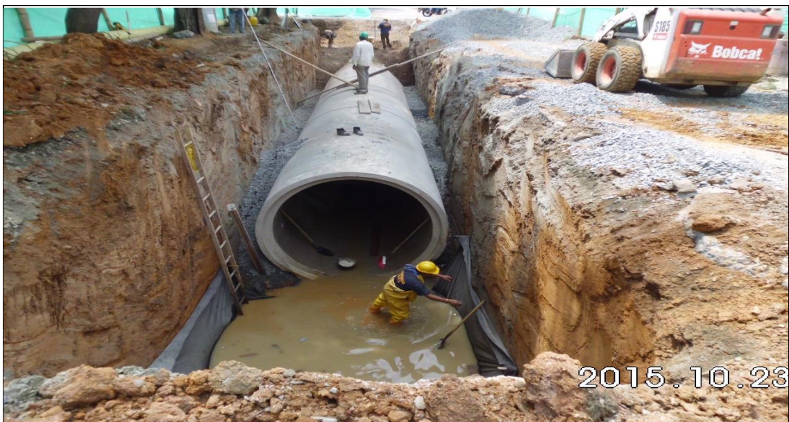
Imagen 16. Instalación tubería de 2.3m, calle 11 entre carrera 20 y 19.
