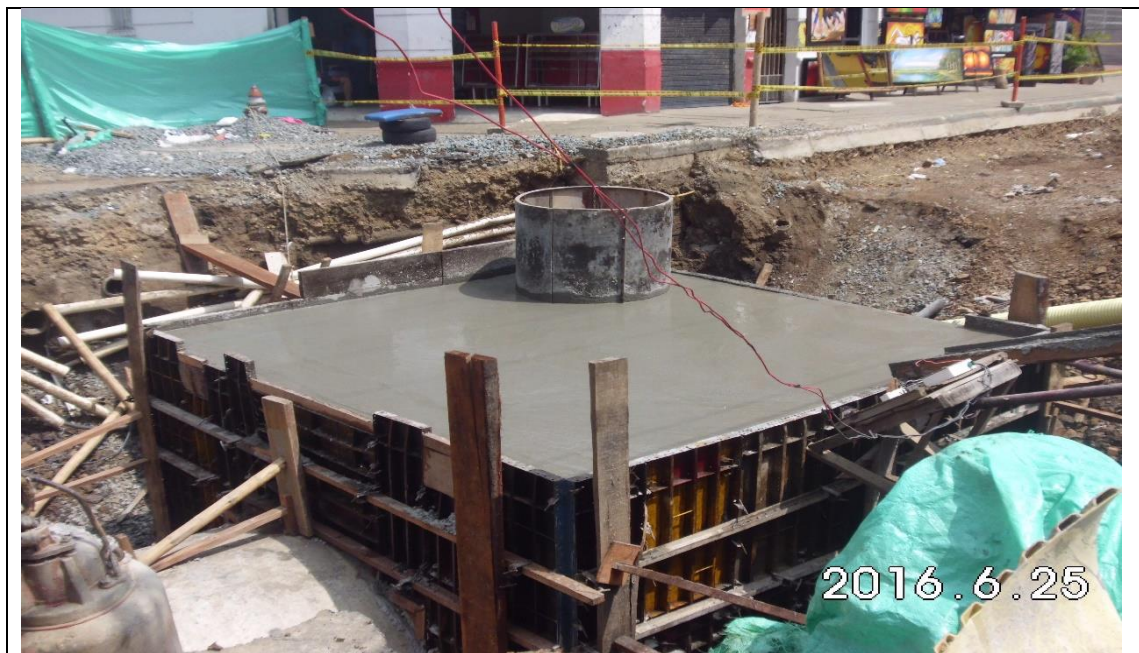
Imagen 36. Construcción cámara especial CN3, calle 9 con carrera 16
