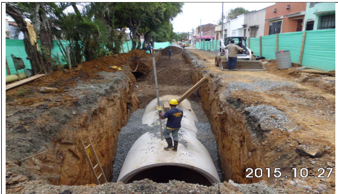
Imagen 20. Relleno con material importado (roca muerta)
