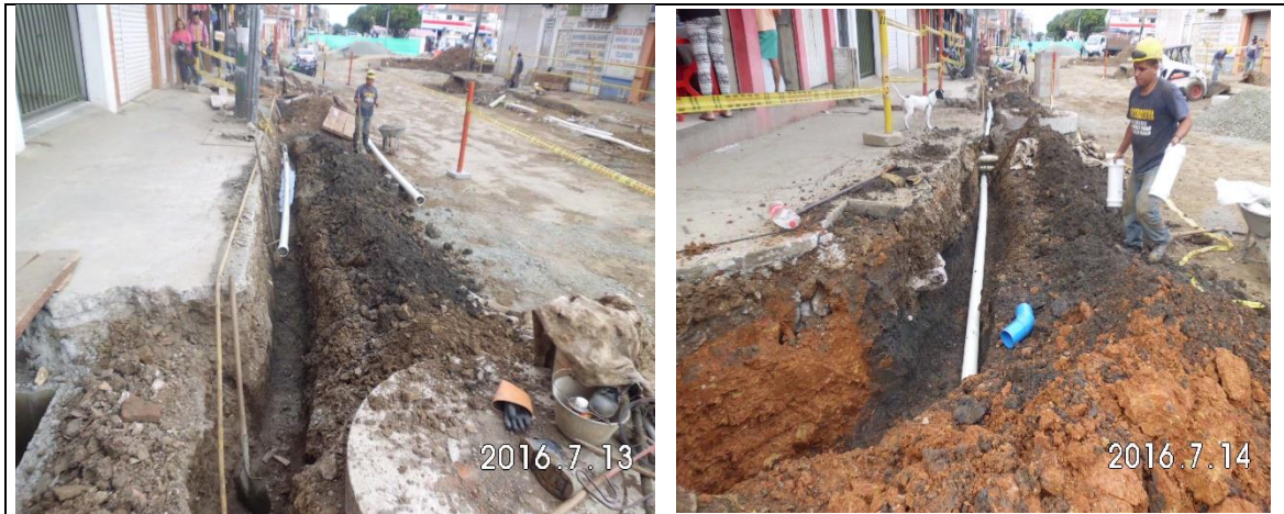
Imagen 106. Tubería de acueducto de 4" calle 9 entre carrera 16 y 15 costado oriental y occidental.
