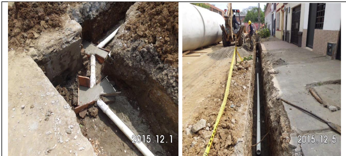
Imagen 92. Instalación de anclajes y tubería de 4" calle 11 con carrera 17
