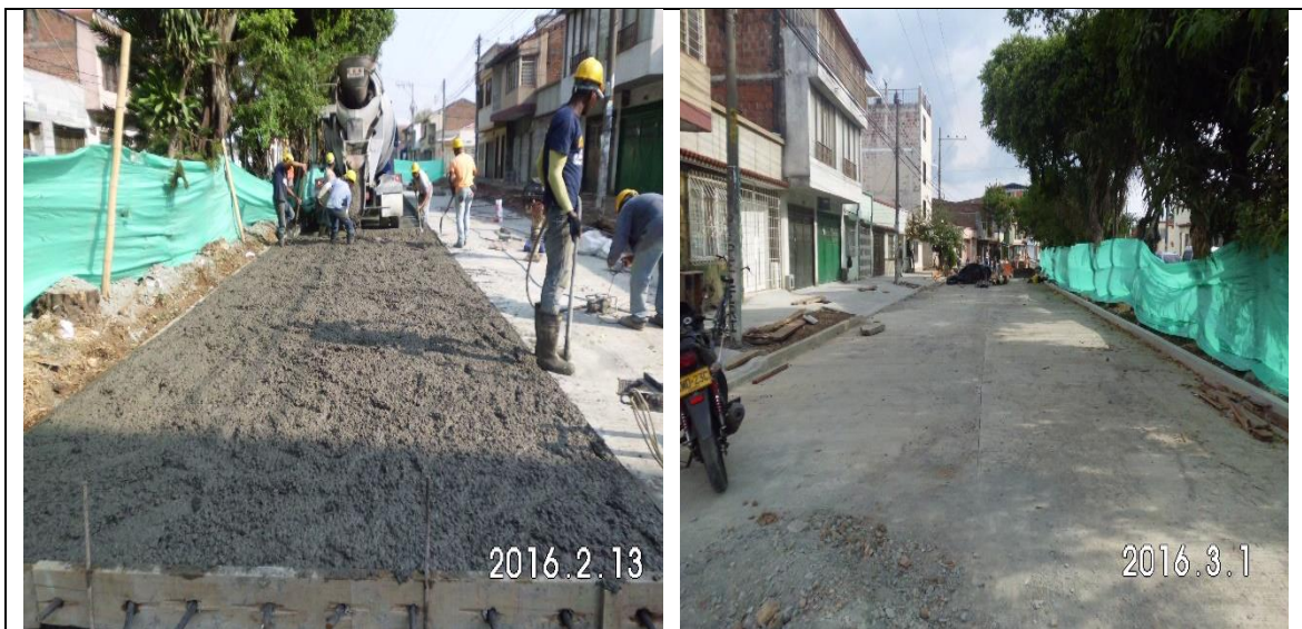
Imagen 113. Pavimentación en la calle 11 entre carrera 22 y 20.
