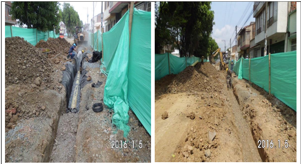
Imagen 59. Tubería de 10" (CN36A-CN35) Calle 11 entre carrera 22 y 21
