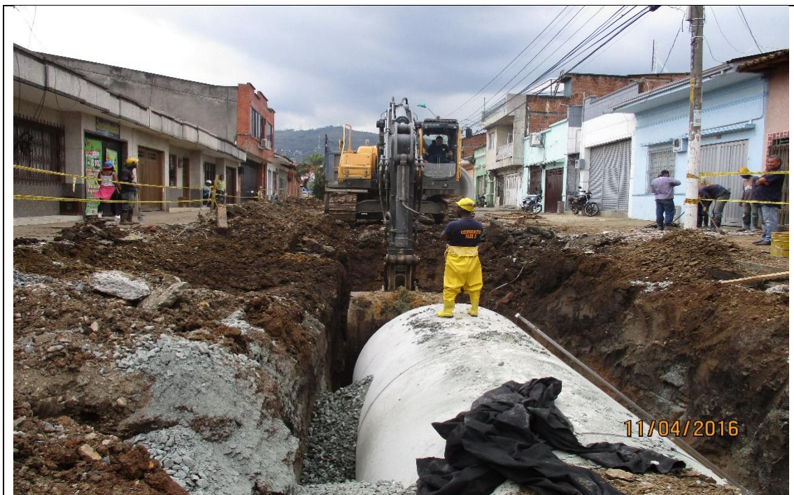
Imagen 23. Instalación de tubería 2.3m carrera 17 entre calle 10 y 9
