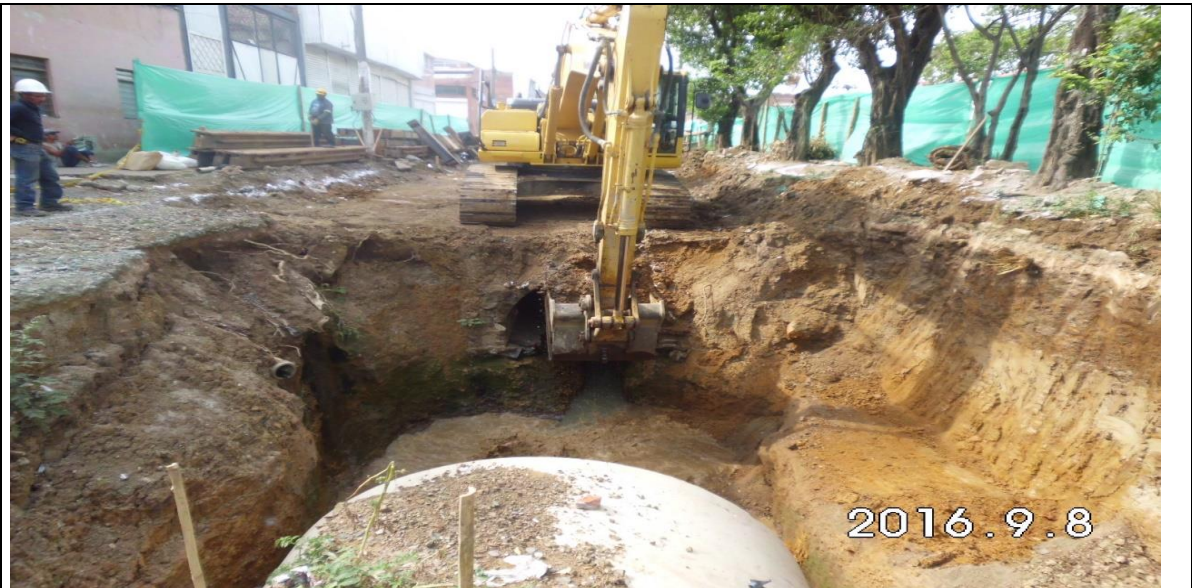
Imagen 41. Se inicia la excavación para instalación del primer módulo del entibado metálico en la calle 11 entre carrera 18 y 17 margen occidental
