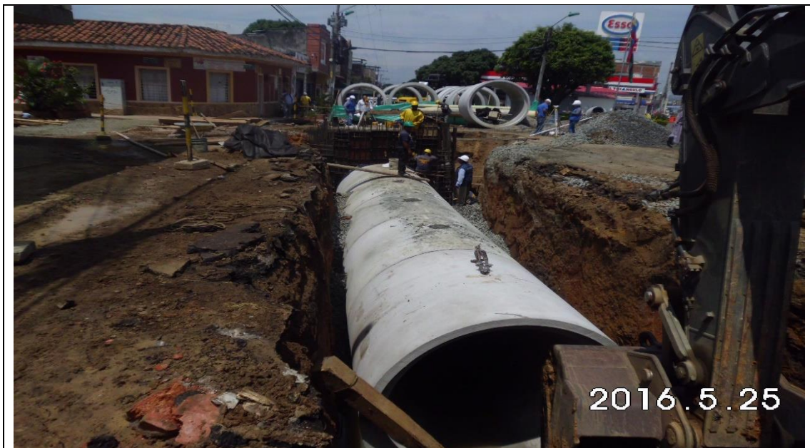
Imagen 24. Instalación primer tubo de 2.3m, calle 9 entre carrera 17 y 15
