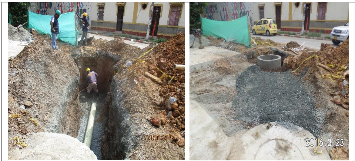
Imagen 75. Instalación tubería de 12” entre cámaras tipo B CN24A y CN19 calle 11 con carrera 19.
