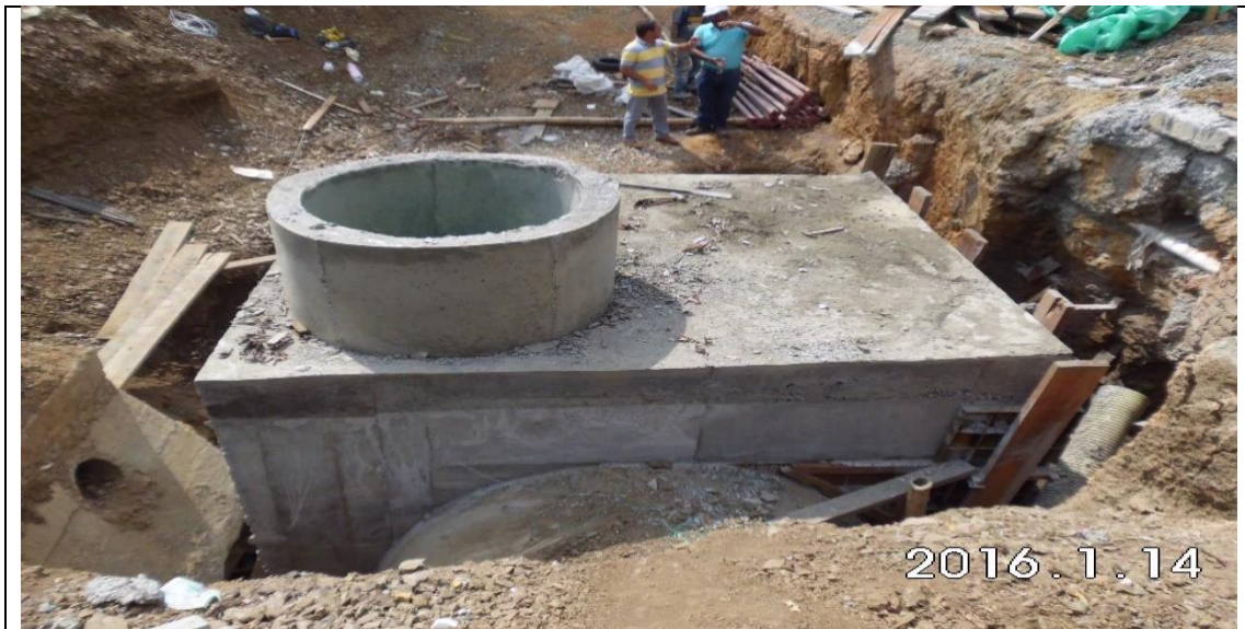
Imagen 30. Construcción cámara especial CN19, calle 11 con carrera 19
