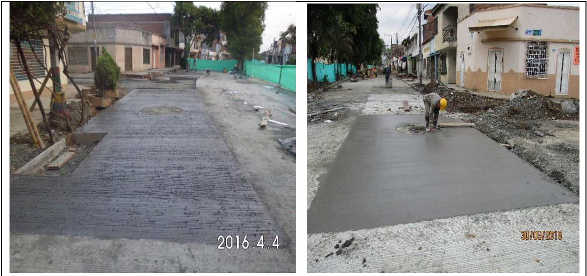
Imagen 114. Pavimentación en la calle 11 entre carrera 22 y 20.
