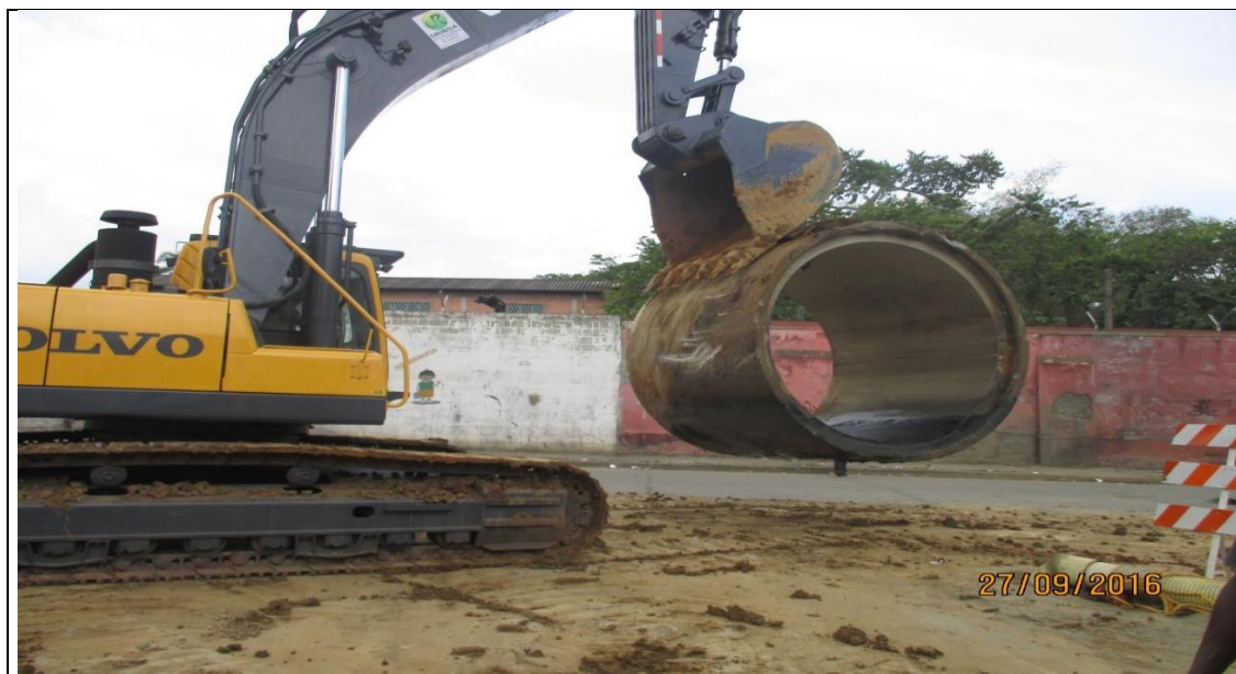
Imagen 44. Desinstalación del tubo de 2,3m American pipe en la calle 11 entre carrera 18 y 17 margen occidental.
