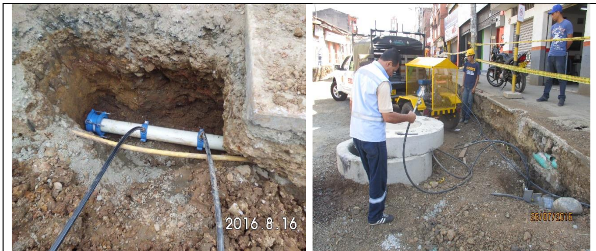
Imagen 109. Acometidas domiciliarias (collarines) y prueba hidrostática.
