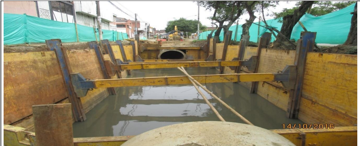
Imagen 48. Se suspenden la construcción del desarenador por parte del CF3
