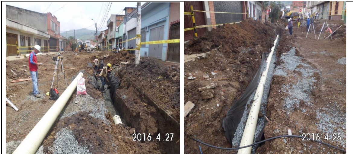
Imagen 84. Instalación tubería de 10" en la carrera 17 entre calle 10 y 9E. (CN6A-CN6B-CN6C) Costado sur.
