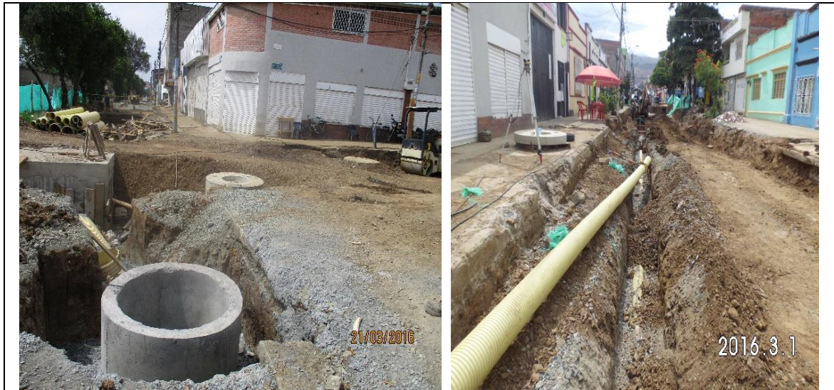
Imagen 80. Cámara tipo B CN13 e Instalación tubería de 10" en la carrera 17 entre calle 11 y 10 costado norte.
