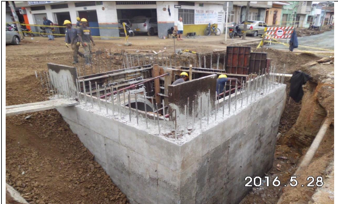
Imagen 35. Construcción cámara especial CN5, carrera 17 con calle 9
