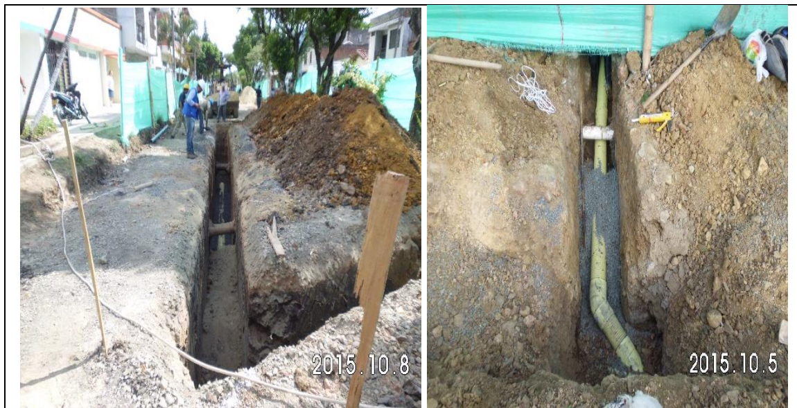
Imagen 55. Instalación tubería de 10" entre cámaras tipo B (CN36A-CN35) e Instalaciones domiciliarias en la calle 11 entre carrera 23 y 22
