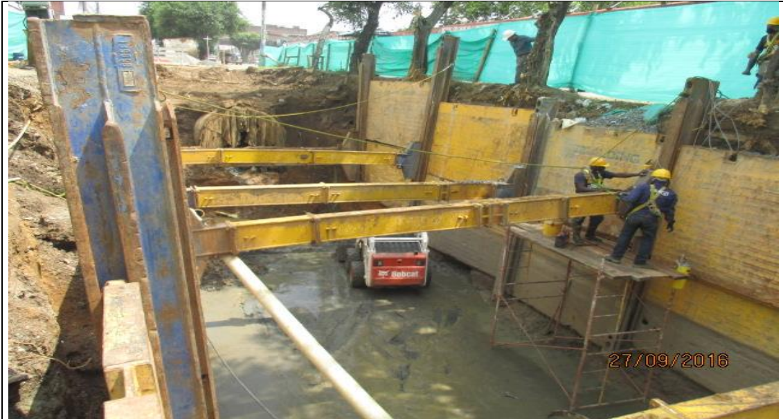
Imagen 46. Arreglo de distanciadores (puntales) de entibado metálico
