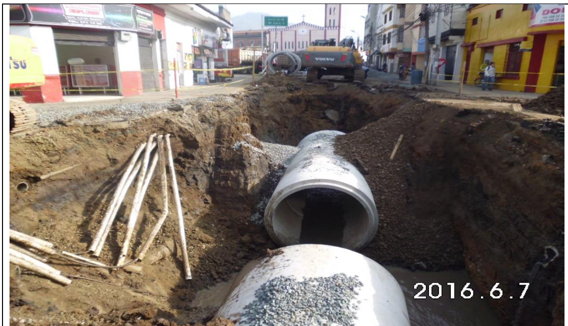
Imagen 25. Instalación tubería de 2.3m, en la calle 9 entre carrera 16 y 15
