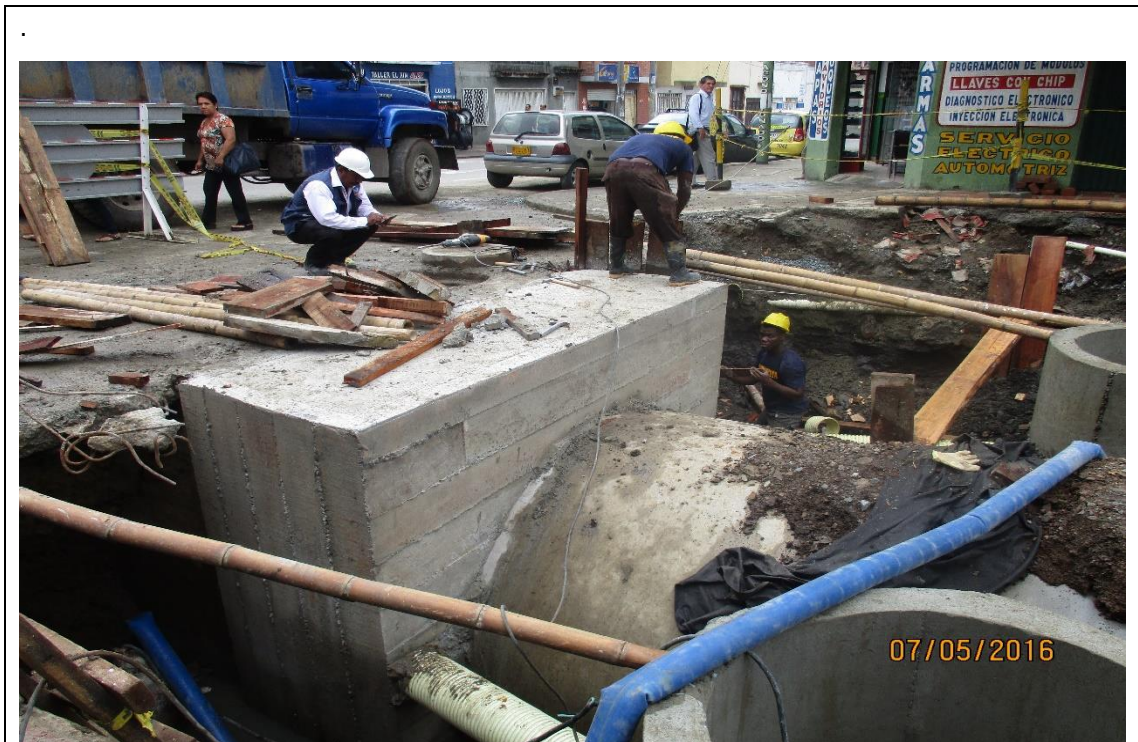
Imagen 34. Construcción cámara especial CN7, carrera 17 con calle 10.
