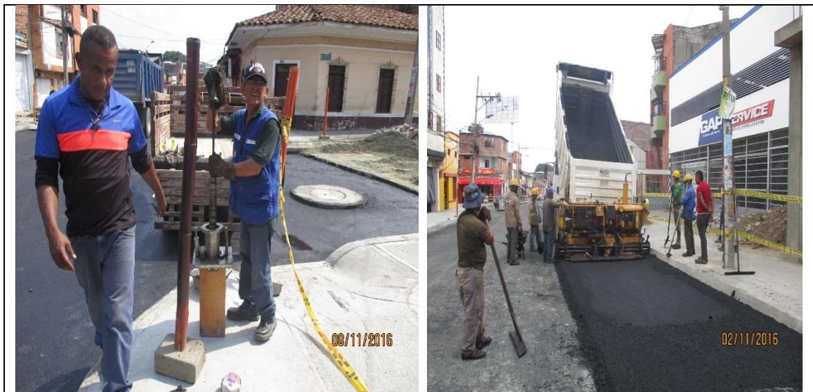
Imagen 133. Extensión, conformación y compactación e instalación de la carpeta asfáltica espesor e=15\text{cm} en la calle 9 entre carrera 16 y 15.
