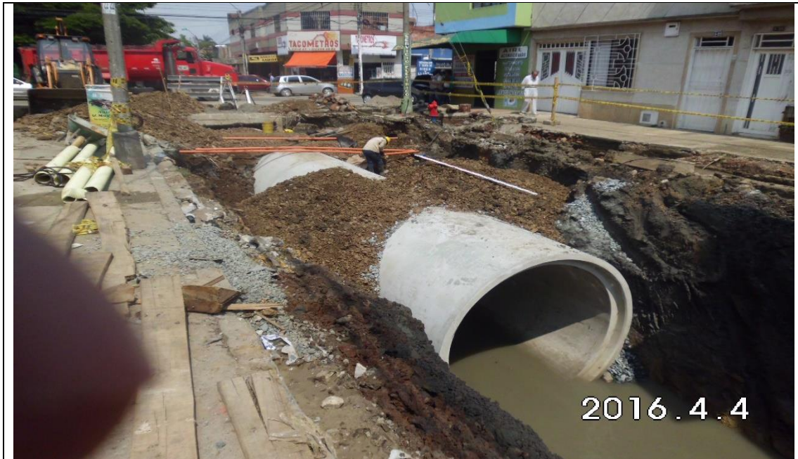
Imagen 22. Instalación de tubería 2.3m carrera 17 entre calle 10 y 9
