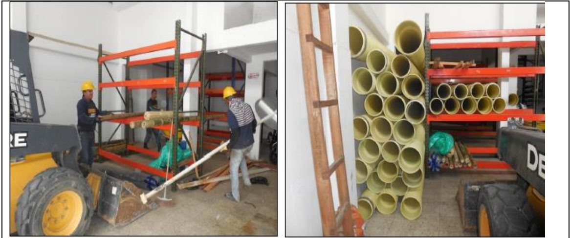
Imagen 8. Almacén de tubería de pvc de diámetro 10” y 12”
