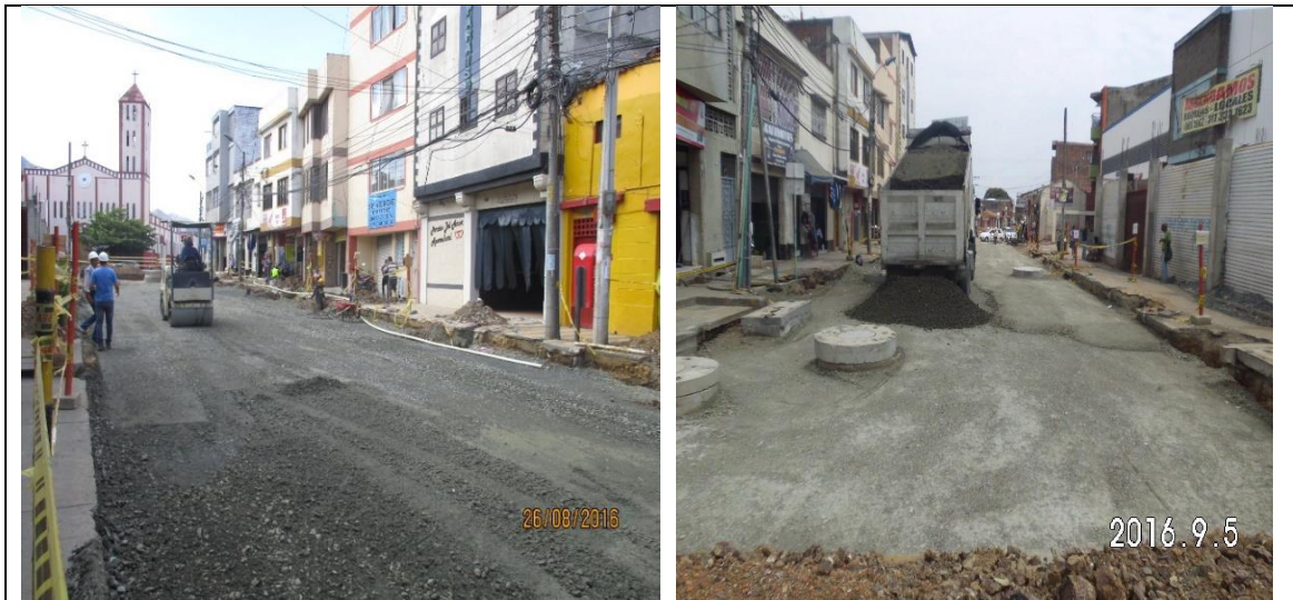
Imagen 131. Extensión, conformación y compactación Sub-base calle 9 entre carrera 17 y 15.
