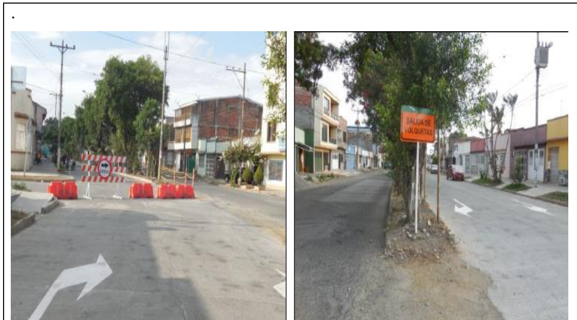
Imagen 11. Instalación de señalización horizontal y vertical
