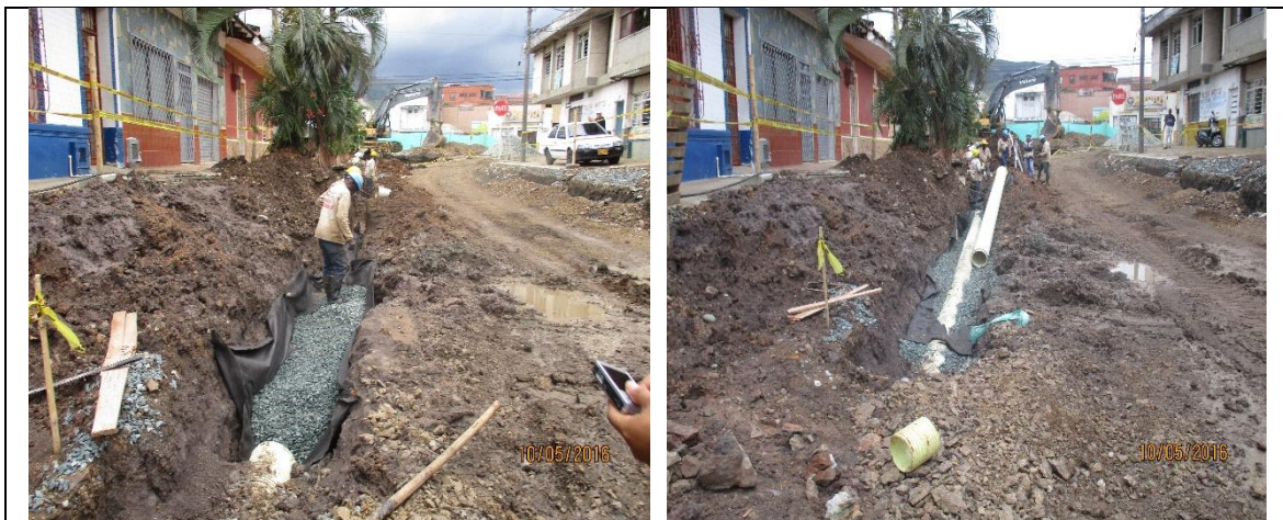
Imagen 83. Instalación tubería de 10” en la carrera 17 entre calle 10 y 9E. (CN5A-CN5B-CN5C) Costado norte.
