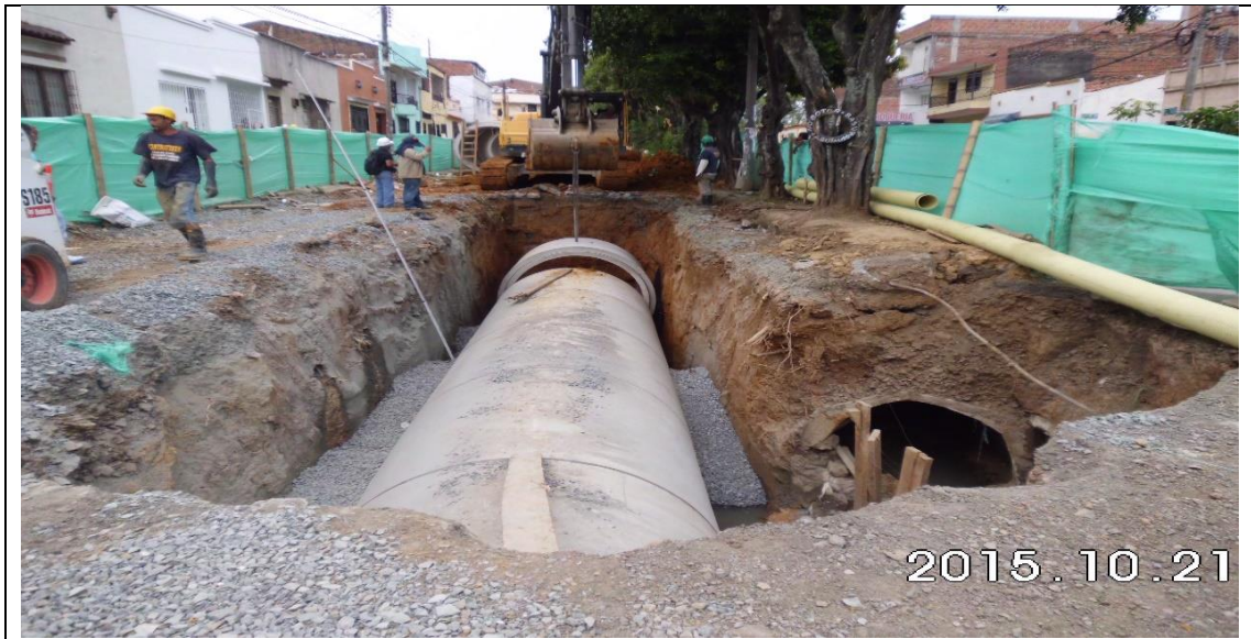
Imagen 19. Instalación y suministro de grava relleno medio tubo
