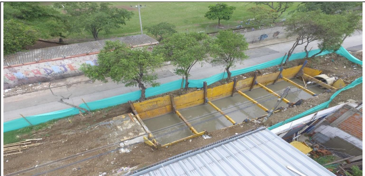
Imagen 49. Imagen área de la construcción del desarenador calle 11 entre carrera 18 y 17
