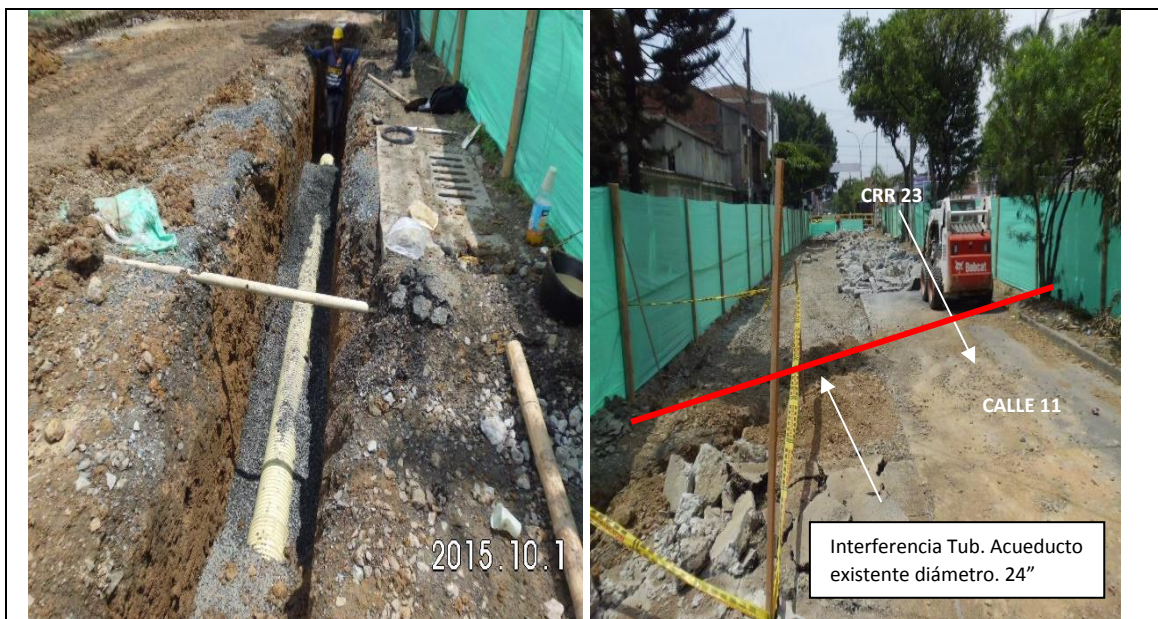
Imagen 54. Instalación tubería de 10" entre cámaras tipo B CN37-CN36, Interferencia tubería de acueducto existente 24" en la calle 11 entre carrera 23 y 22
