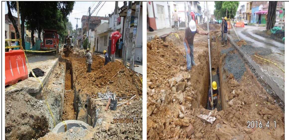
Imagen 67. Instalación tubería de 10” entre las cámaras tipo B CN25 y CN27 en la calle 11 entre carrera 20 y 19.
