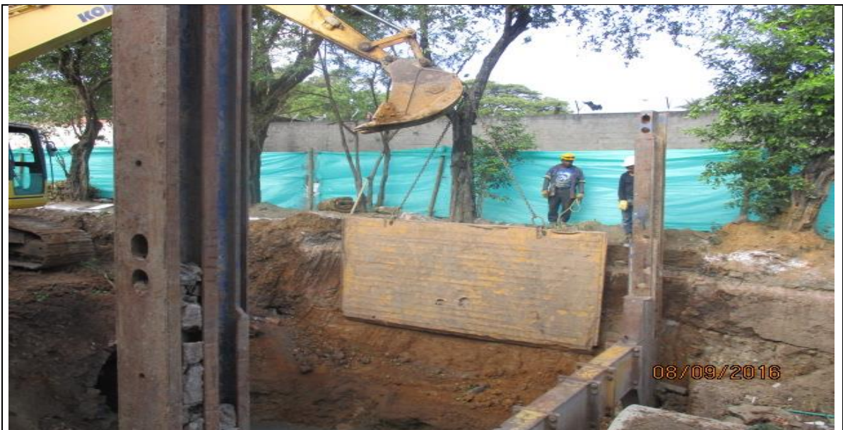
Imagen 42. Primer módulo del entibado metálico en la calle 11 entre carrera 18 y 17 margen occidental.
