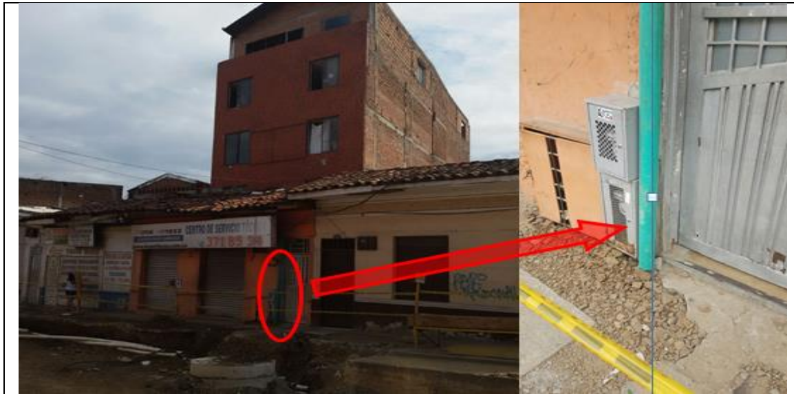
Imagen 128. Restitución de acometida eléctrica trifásica en baja tensión cable de cobre 3#1/0+1#1/0+1#4 en calle 9 entre carrera 17 y 16.
