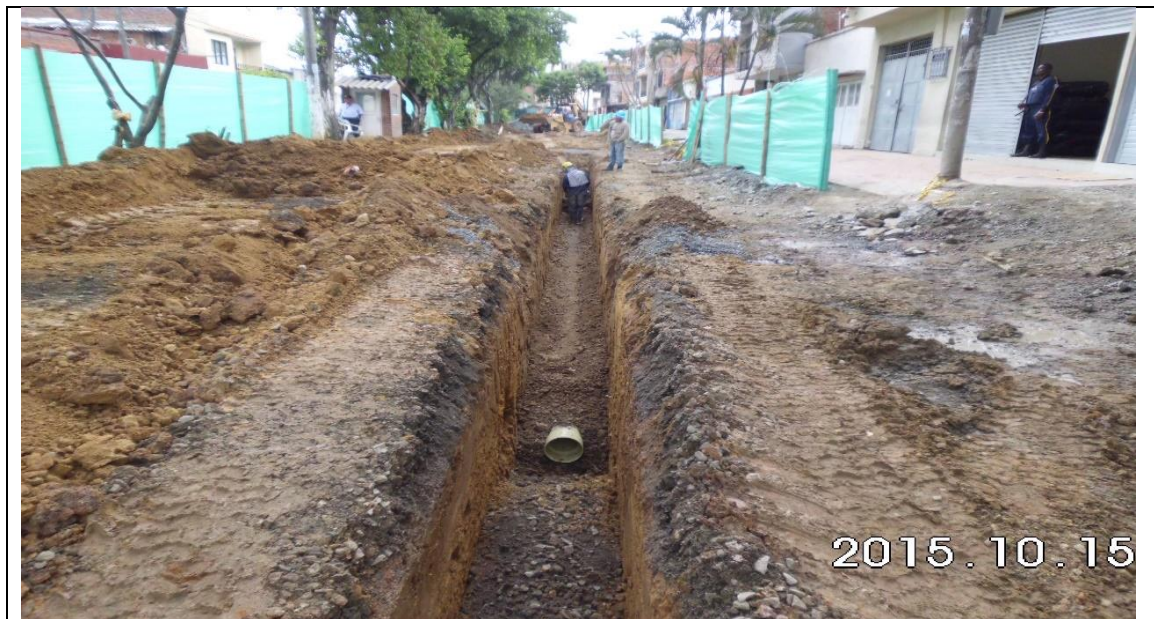
Imagen 56. Instalación tubería de 10" en la calle 11 entre carrera 23 y 22.
