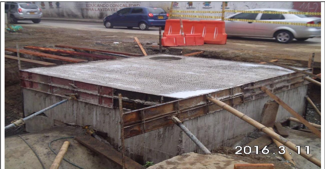
Imagen 32. Construcción cámara especial CN13, calle 11 con carrera 17
