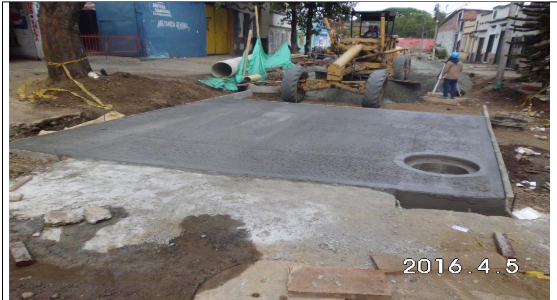
Imagen 33. Construcción cámara especial CN11, carrera 17 con calle 10
