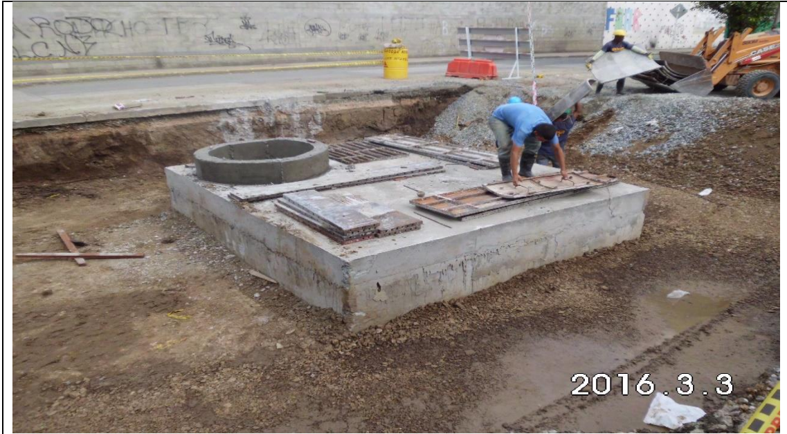
Imagen 31. Construcción cámara especial CN16, calle 11 con carrera 18
