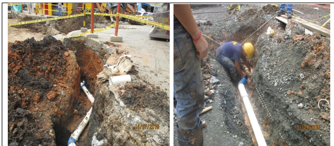
Imagen 129. Instalación de tubería 4" calle 9 entre carrera 17 y 15.
