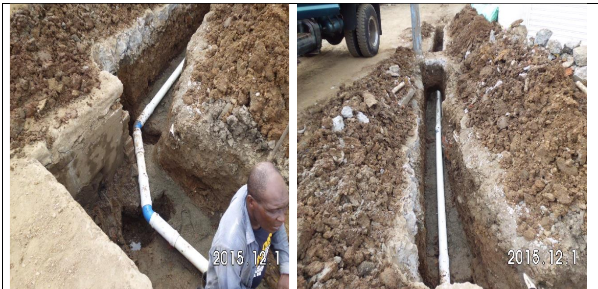
Imagen 90. Instalación de accesorios de tubería de 4” en la calle 11 entre carrera 18 y 17.
