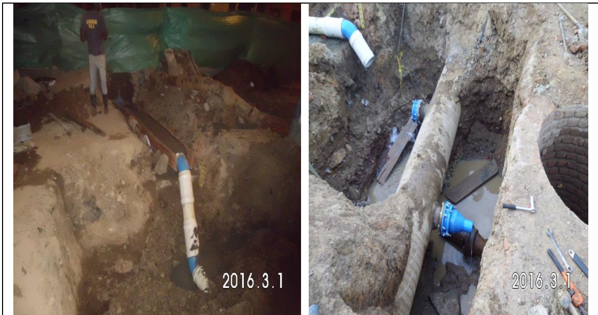
Imagen 97. Instalación brida 20"x8" con reducción a 4" en la calle 11 con carrera 22.
