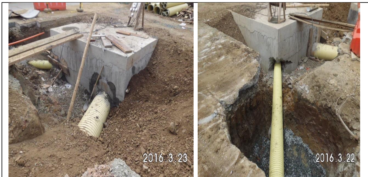
Imagen 81. Instalación tubería de 12" y 24" calle 11 con carrera 17.
