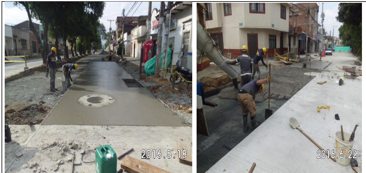
Imagen 116. Pavimentación en la calle 11 entre carrera 22 y 20.
