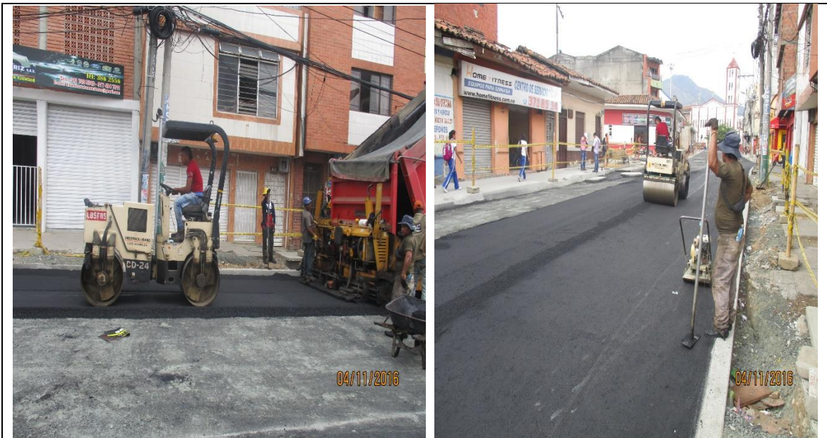
Imagen 134. Extensión, conformación y compactación espesor carpeta asfáltica e=15\text{cm} en la calle 9 entre carrera 17 y 16.
