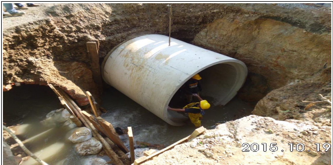
Imagen 15. Instalación primer tubo de 2.3m, calle 11 con carrera 20.
