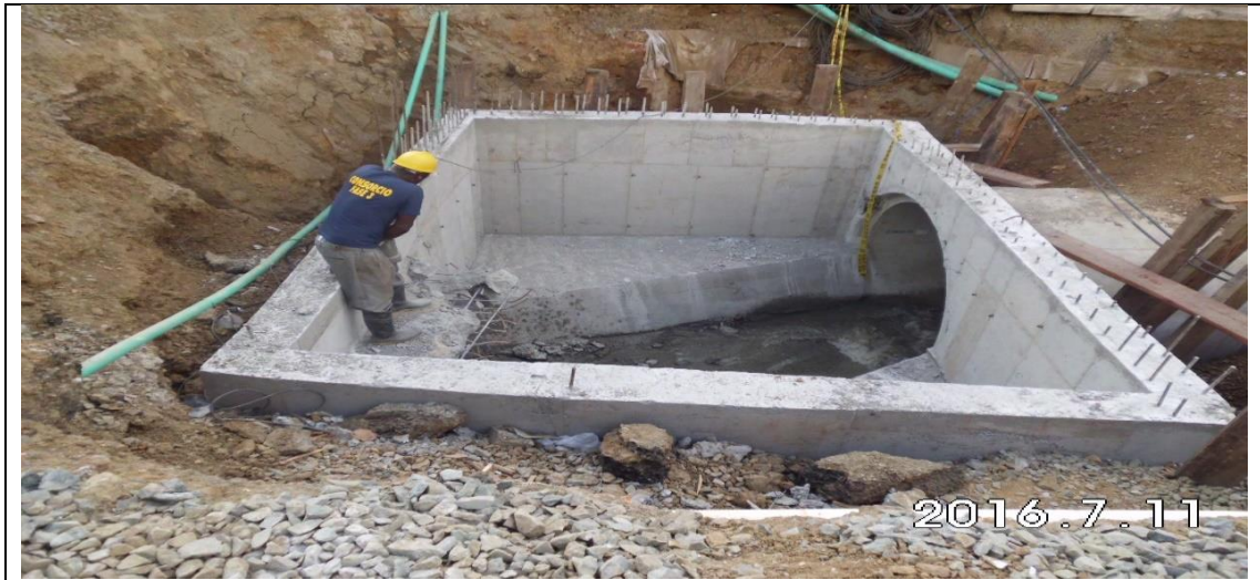
Imagen 37. Construcción cámara especial CN2, calle 9 con carrera 15
