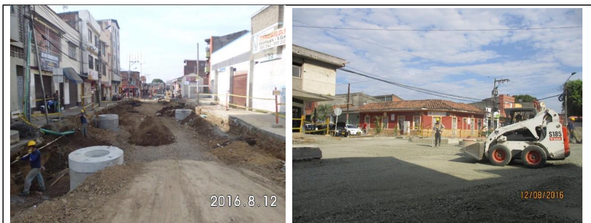
Imagen 130. Extensión, conformación y compactación sub-rasante.
