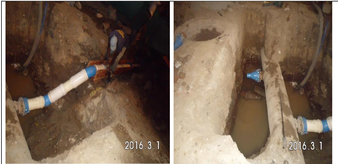
Imagen 96. Instalación tubería de 8" a tubería acueducto existente 20" calle 11 con carrera 22.
