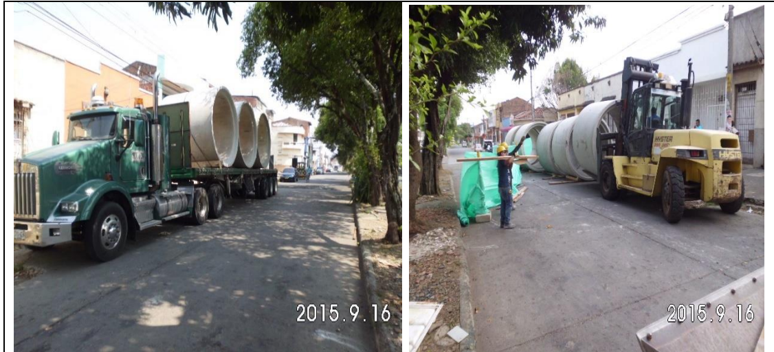
Imagen 12. Llegada de tubería de hormigón de 2.30m American Pipe
