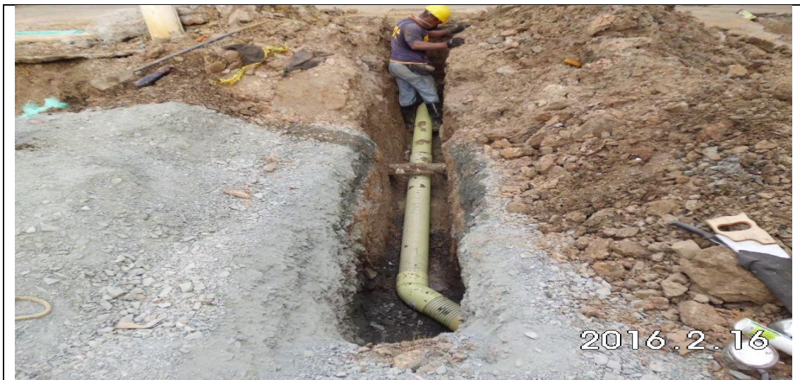
Imagen 62. Tubería de alcantarillado de 10" entre la cámara tipo B CN 28A y 26A. Calle 11 entre carrera 21 y 20.
