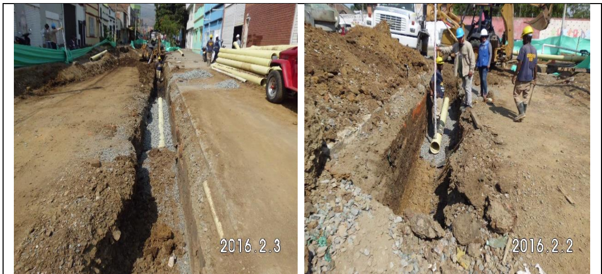
Imagen 79. Instalación tubería de 10” en la carrera 17 entre calle 11 y 10 costado norte.
