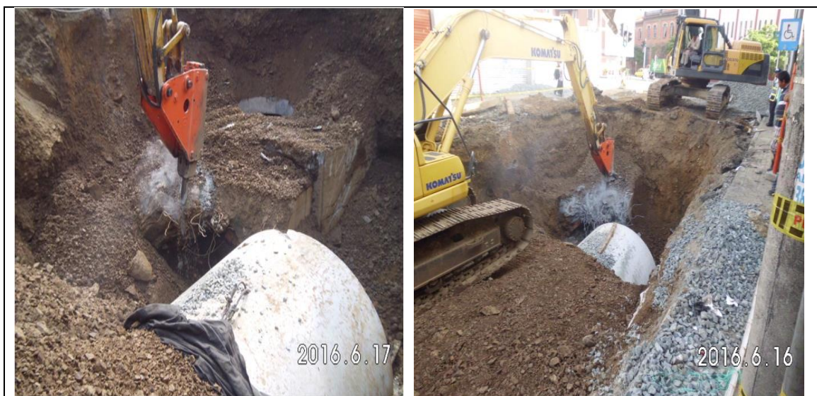
Imagen 125. Recubrimiento en concreto reforzado en la calle 9 entre carrera 17 y 15.
