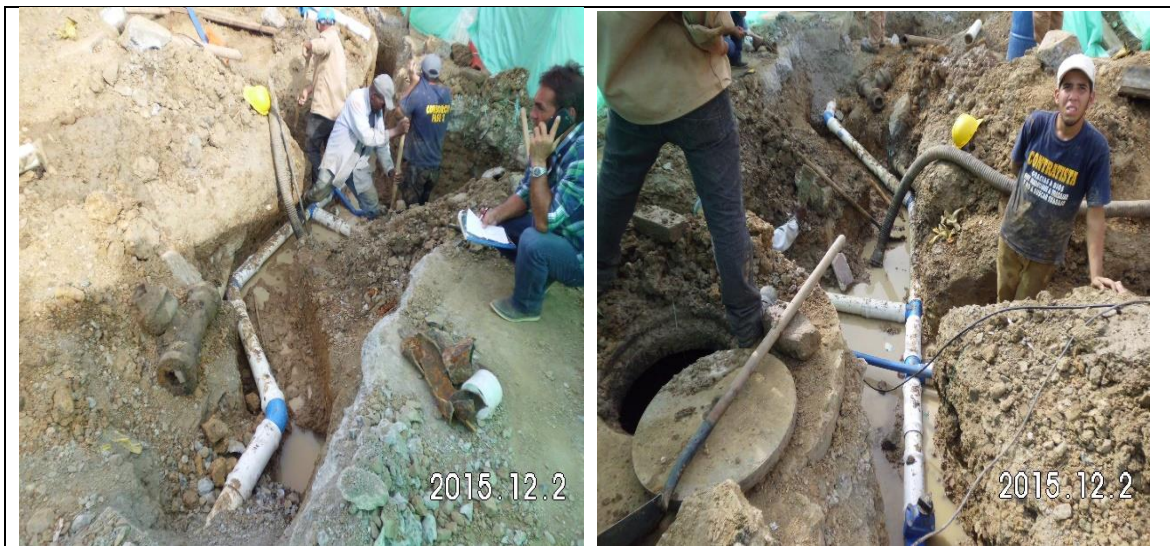
Imagen 94. Instalación de la tubería PVC de acueducto de 4" en la calle 11 con carrera 23 margen oriental.
