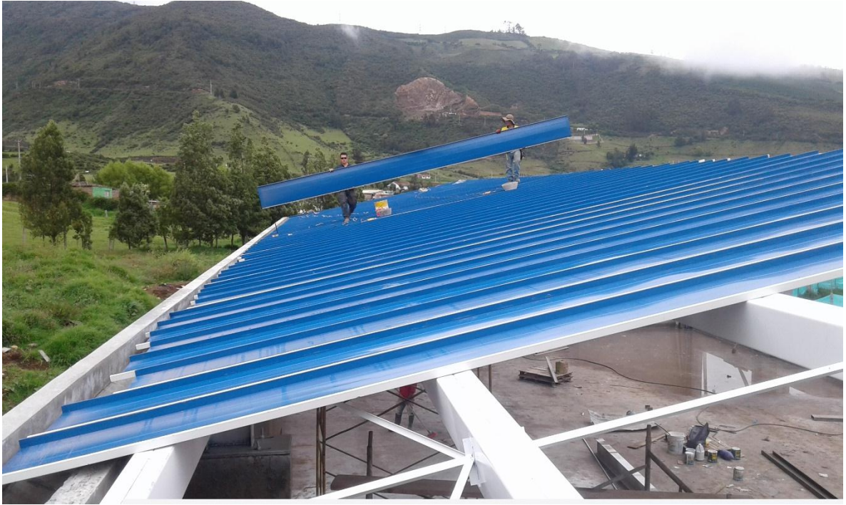
27. Instalacion de cubierta.
