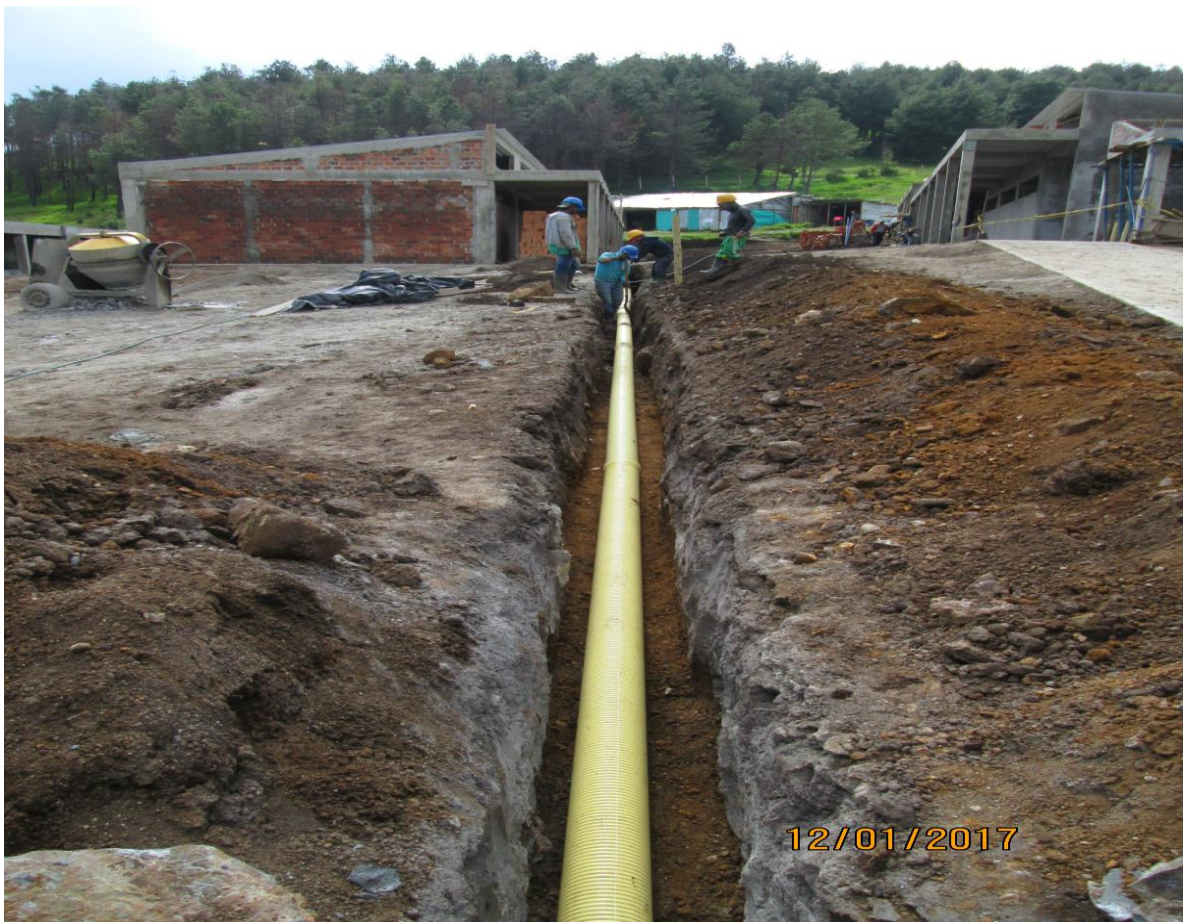
17. Instalacion tuberia corrugada sanitaria 4"
