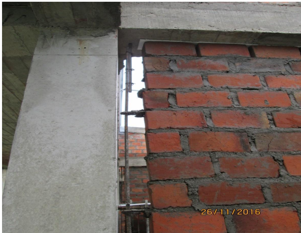
10. Refuerzo de muros
