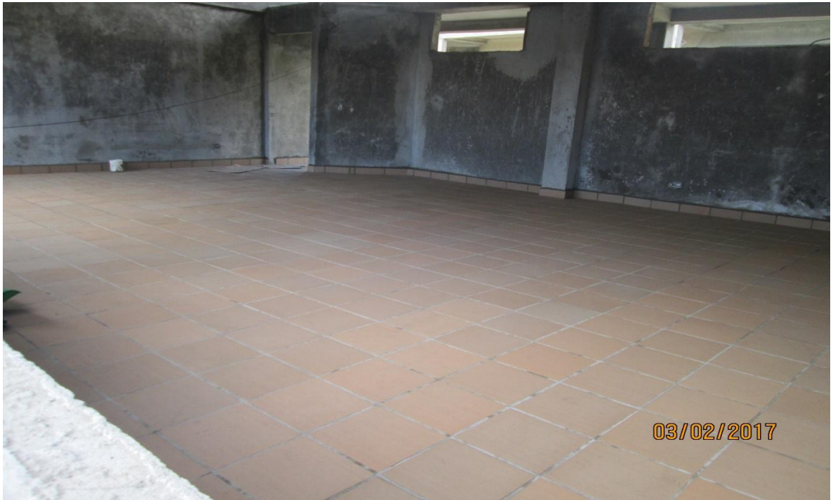
21. Enchape de pisos aulas
