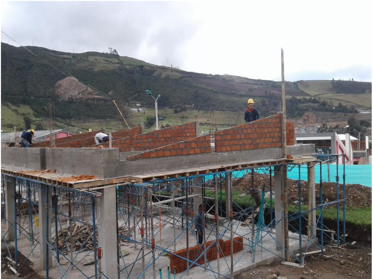
12. Mampostería de cubierta
