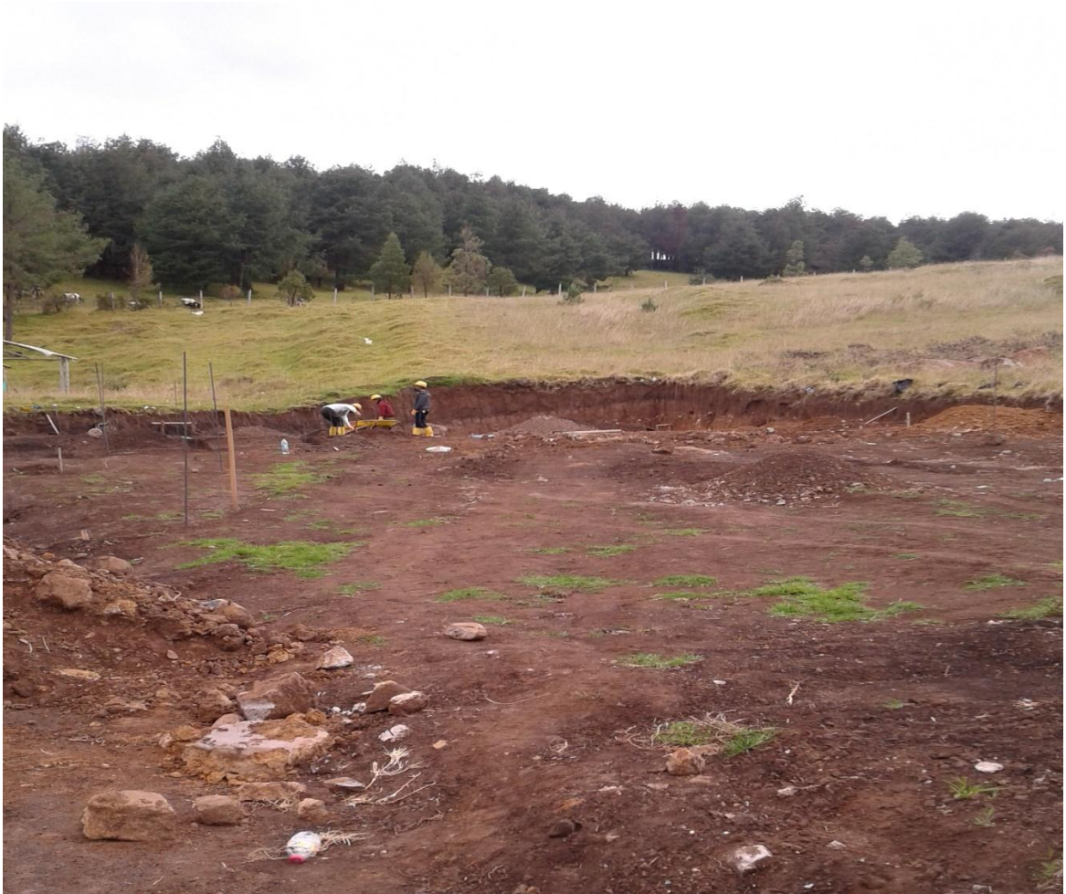
8.Adecuacion del terreno
