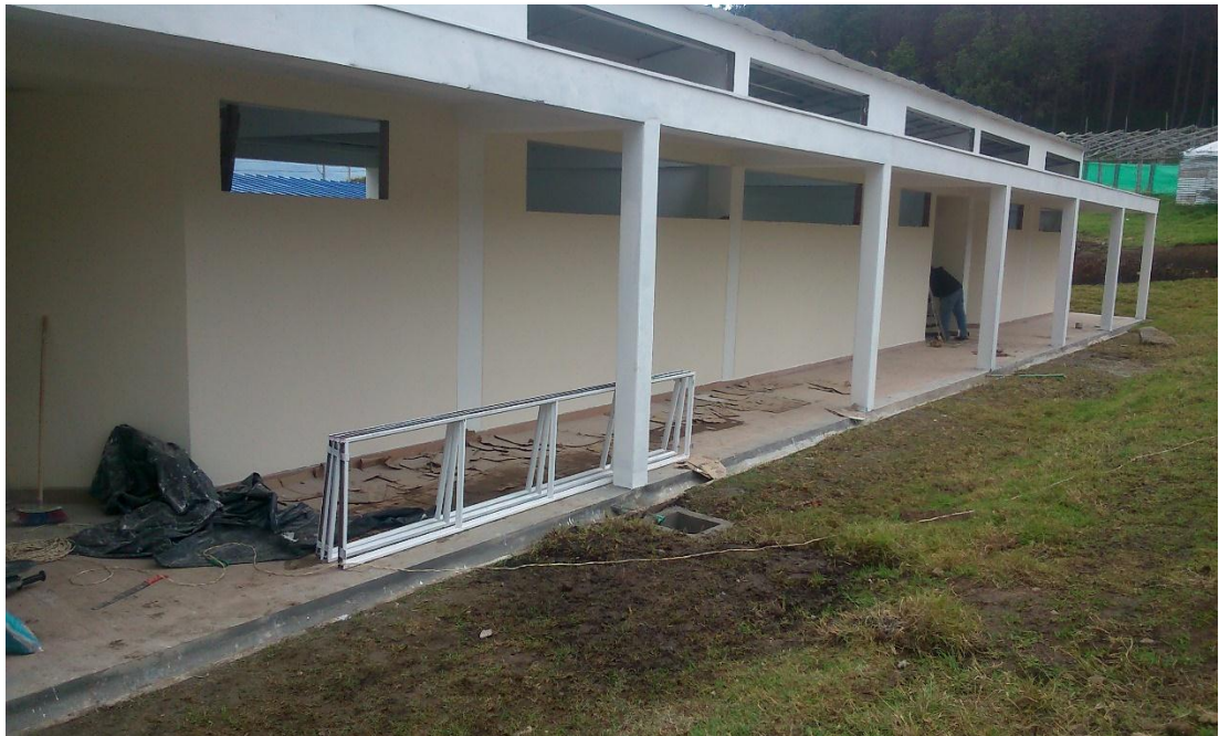
14.Muros con primera mano de pintura
