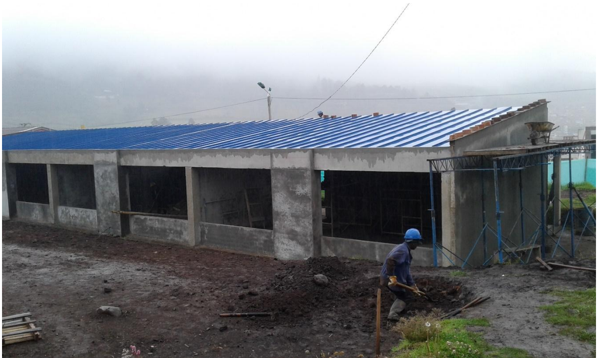
13. Muros repellados
