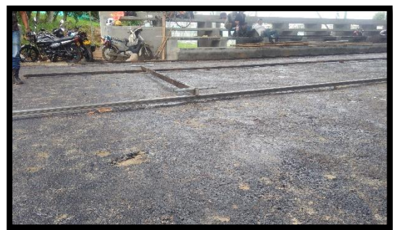
Figura 56. Colocación del Concreto Asfáltico – Primera Parte
