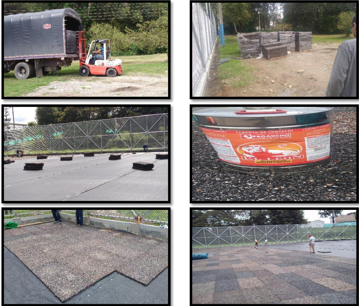
Figura 31. Instalación de shockPad
