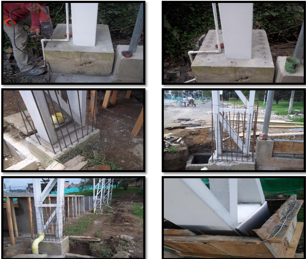
Figura 61. Recubrimiento para Pórtico Estructura Metálica – Primera Parte
