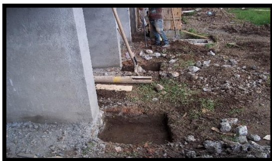
Figura 67. Construcción Zapatas y Columnas para Refuerzo Gradería – Primera Parte
