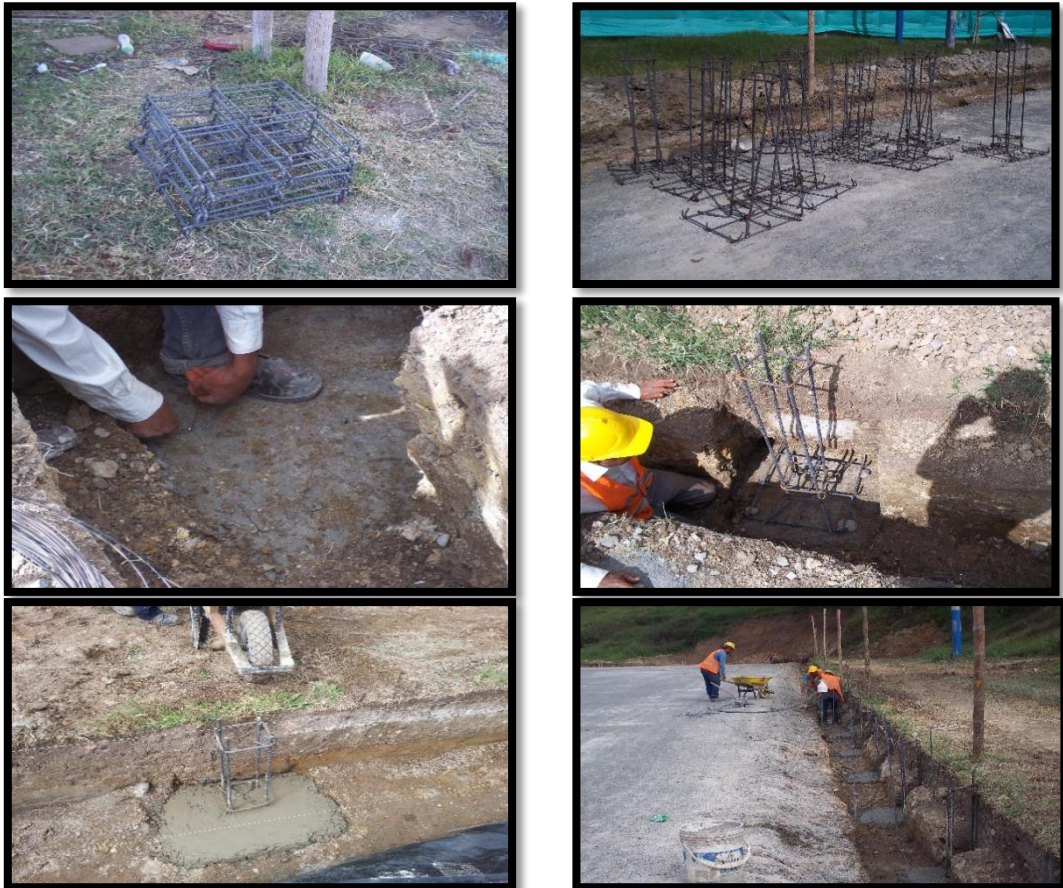
Figura 42. Pedestales o Columnas Estructura de Cerramiento
