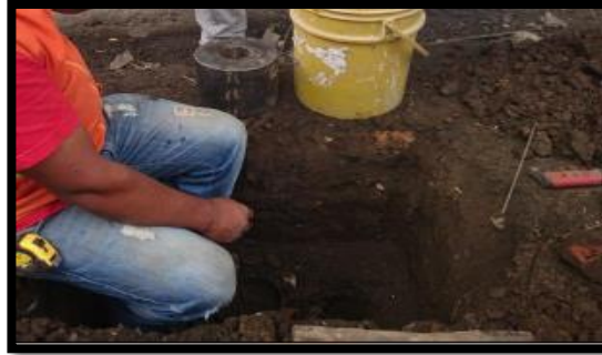
Figura 7. Apique para Extracción de Muestra de CBR Inalterada
