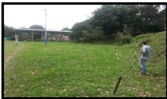
Figura 6. Replanteo Cancha de Futbol
