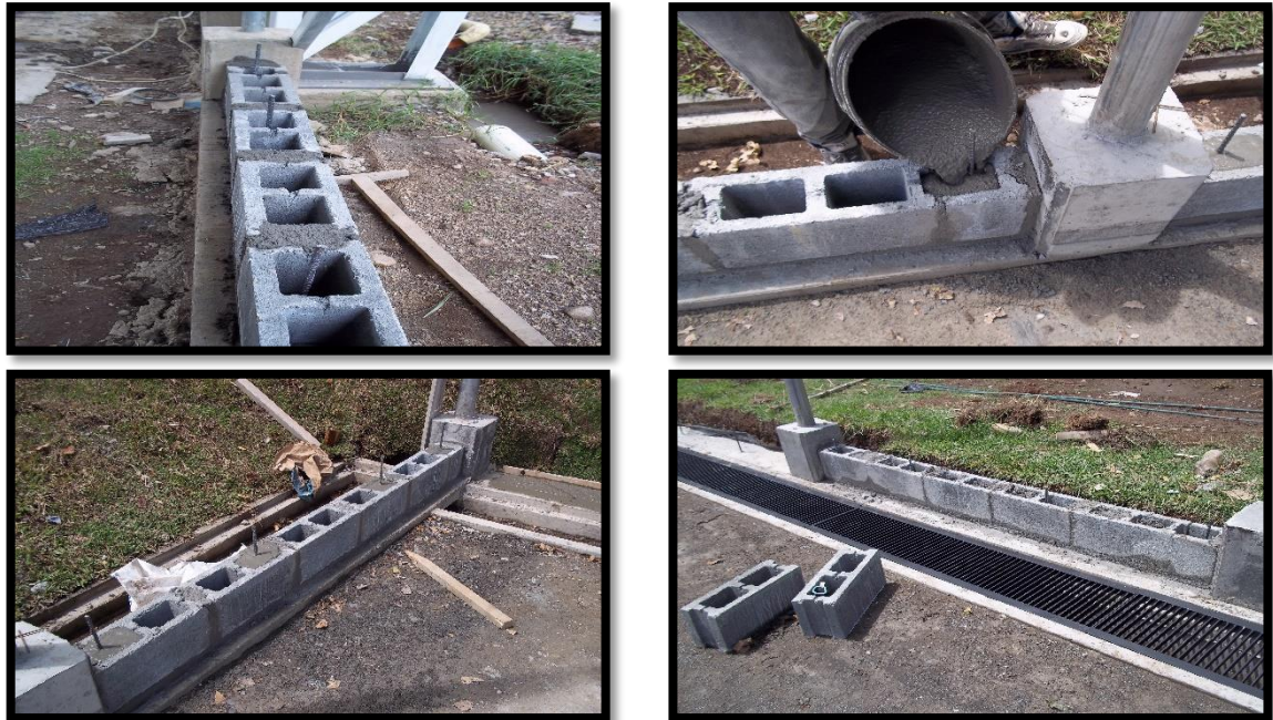
Figura 49. Anclaje y Pega de Bloques – Segunda Parte
