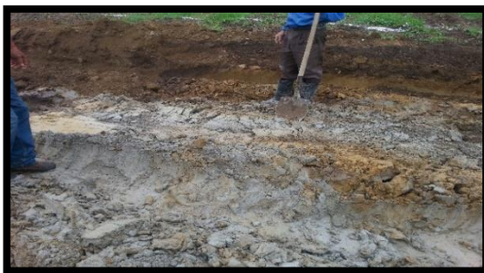
Figura 11. Mejoramiento de Fallas de Subrasante
