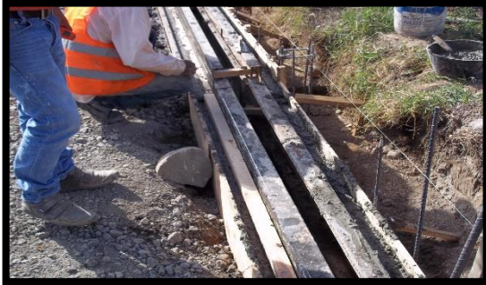
Figura 24. Paredes del Canal
