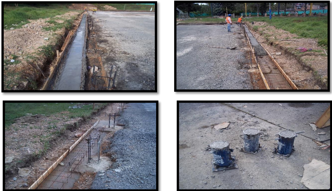
Figura 23. Piso de Canal y Cilindros de Prueba
