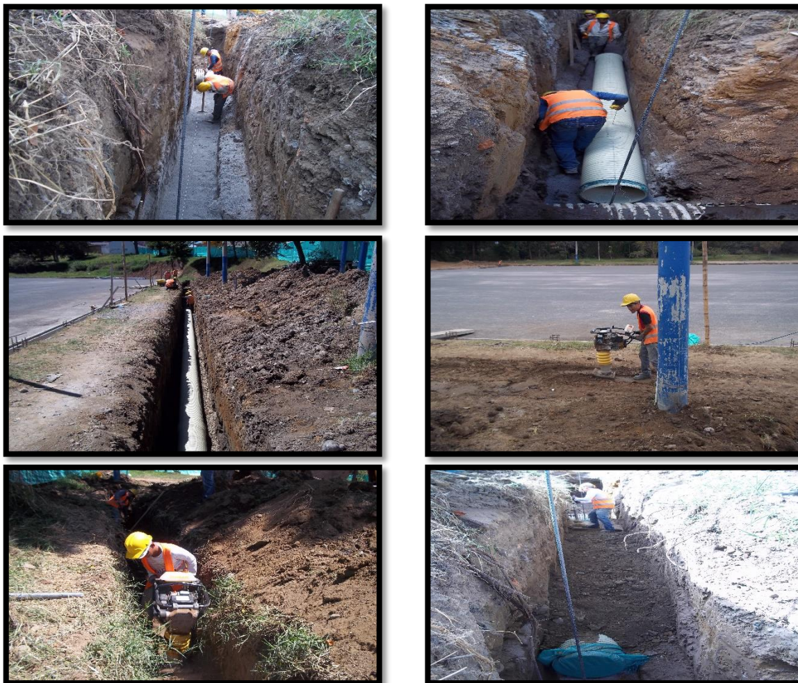
Figura 36. Instalación Tubería Sanitaria de 16” – Segunda Parte
