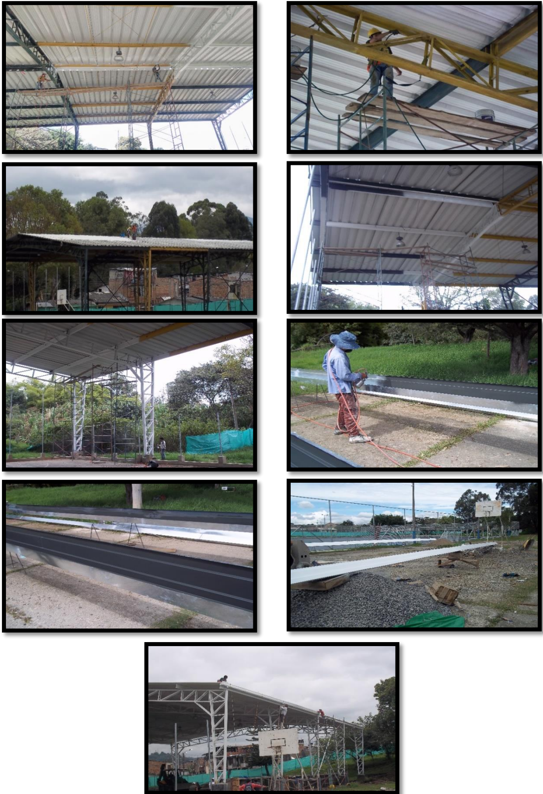
Figura 74. Adecuación de la Estructura Metálica del Coliseo – Segunda Parte
