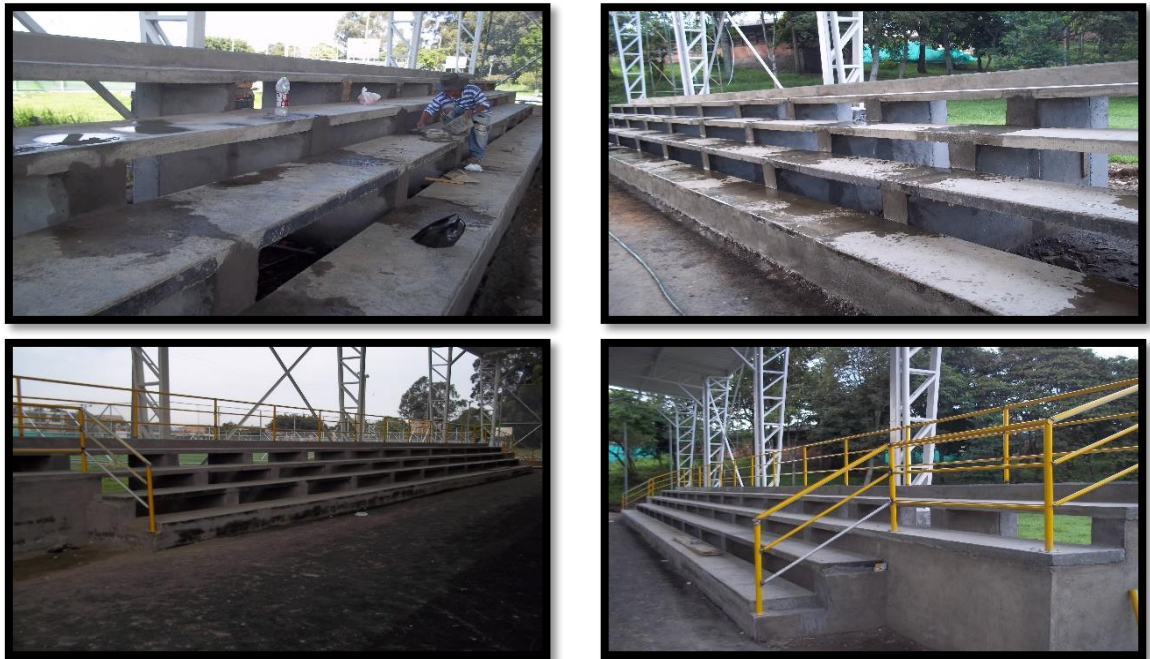
Figura 71. Viga de Amarre, Repello y Baranda Metálica para Gradería – Segunda Parte
