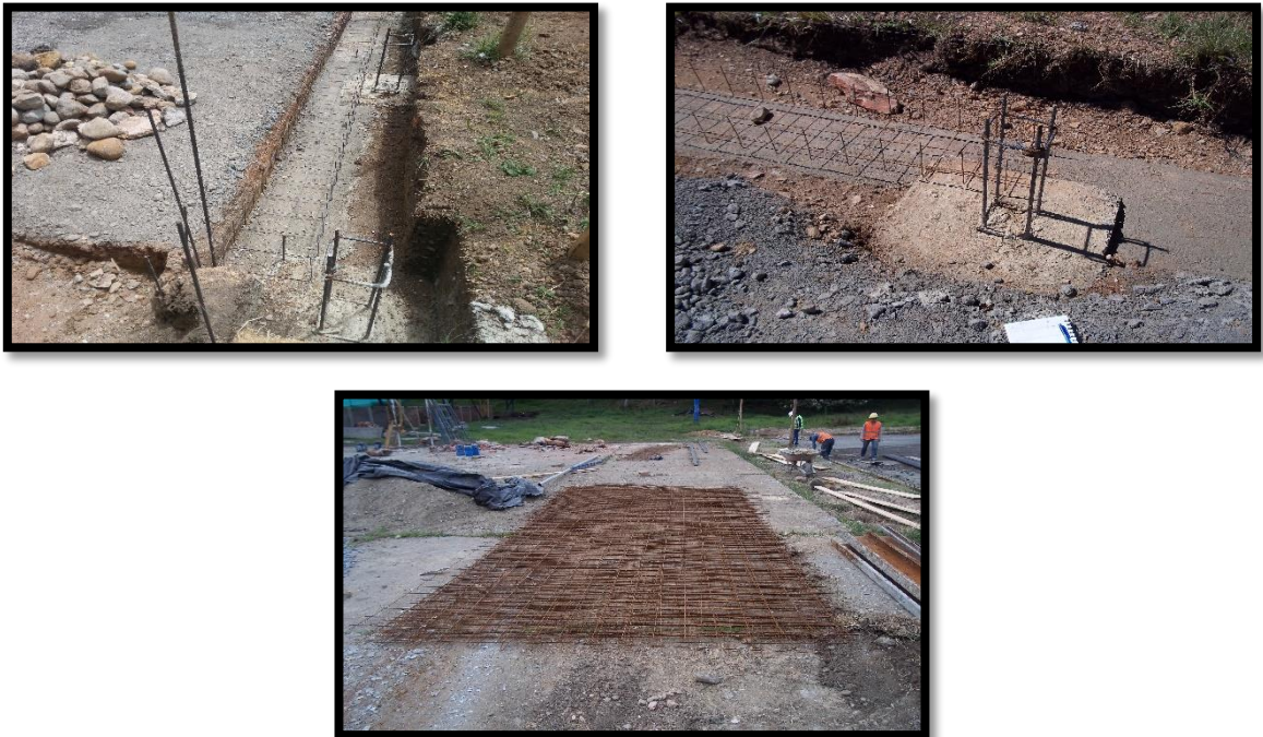
Figura 22. Malla Electro Soldada
