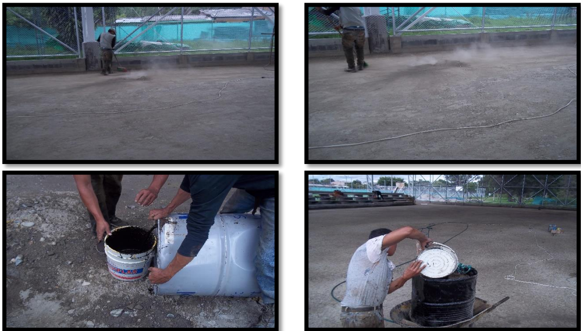
Figura 54. Riego de Imprimación – Primera Parte
