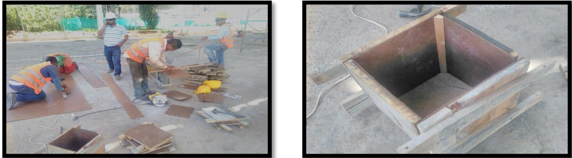
Figura 47. Fundición Viga Amarre y Pedestales de Estructura de Cerramiento – Segunda Parte
