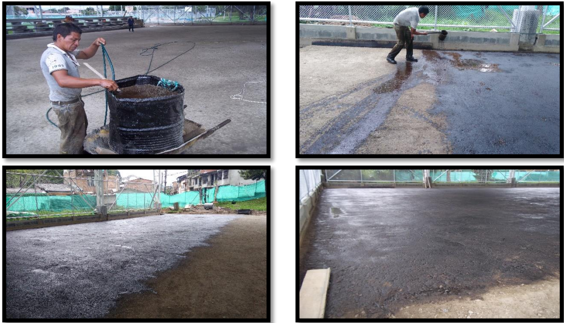
Figura 55. Riego de Imprimación – Segunda Parte
