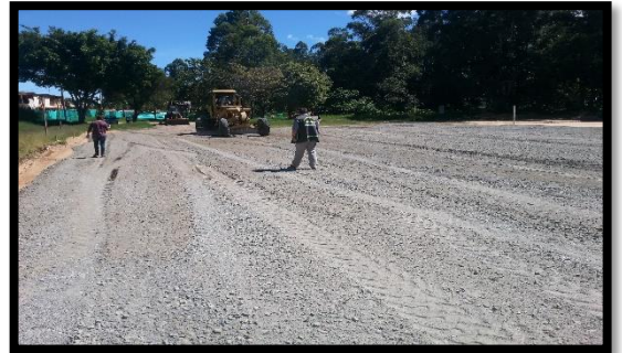
Figura 18. Relleno Base Angula
