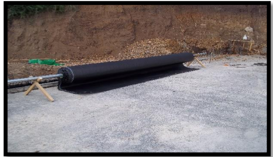
Figura 29. Colocación Geotextil Tejido
