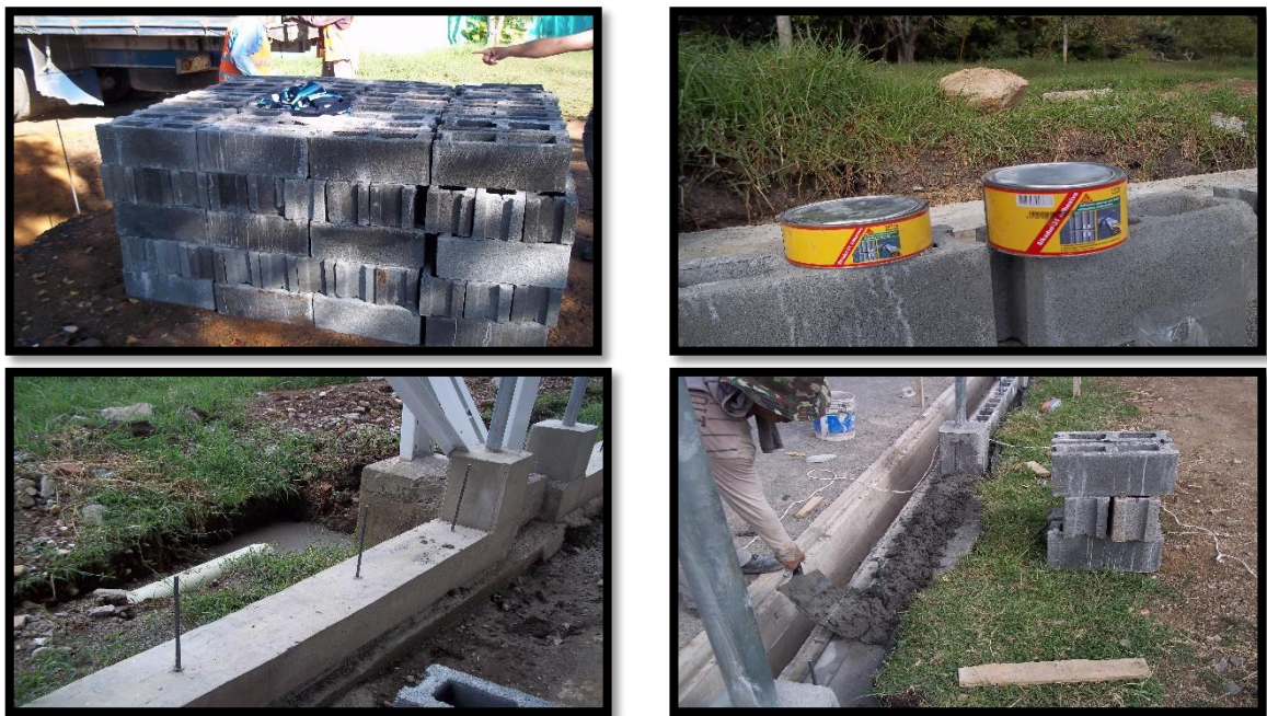
Figura 48. Anclaje y Pega de Bloques – Primera Parte
