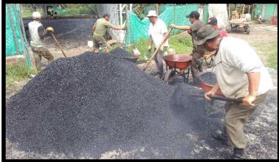
Figura 57. Colocación del Concreto Asfáltico – Segunda Parte
