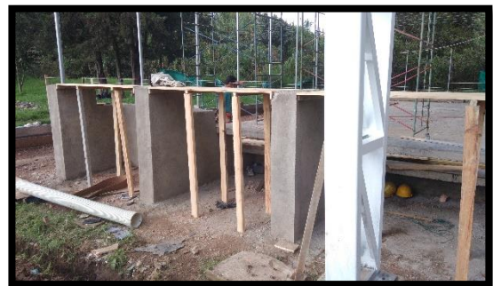
Figura 64. Fundición de Bancas para Reforzar la Gradería del Coliseo – Primera Parte
