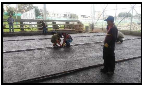
Figura 56. Colocación del Concreto Asfáltico – Primera Parte
