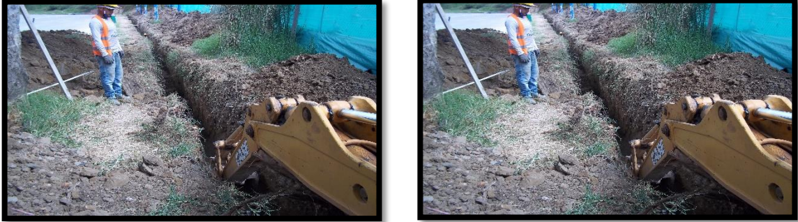
Figura 34. Excavación Desvío de Tubería
