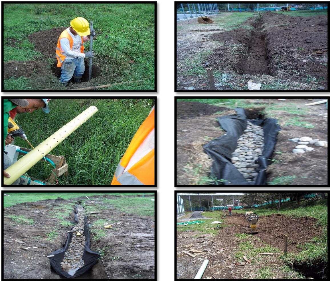
Figura 40. Instalación Tubería PVC 4" para filtro – Primera Parte
