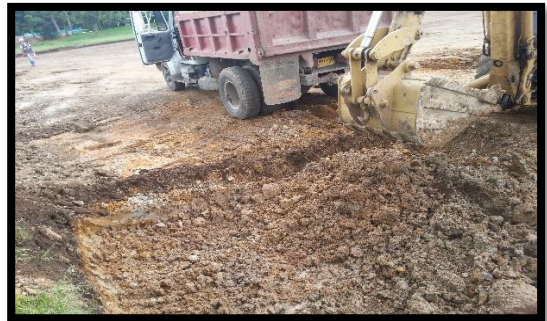
Figura 11. Mejoramiento de Fallas de Subrasante
