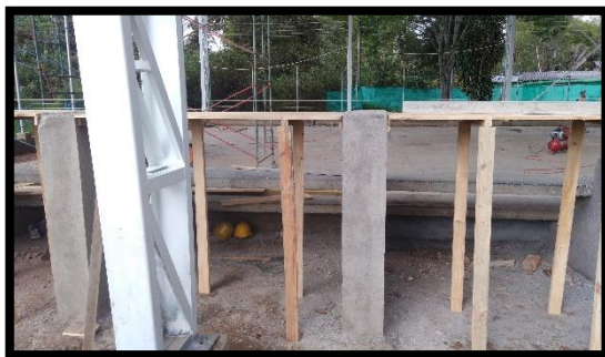
Figura 64. Fundición de Bancas para Reforzar la Gradería del Coliseo – Primera Parte
