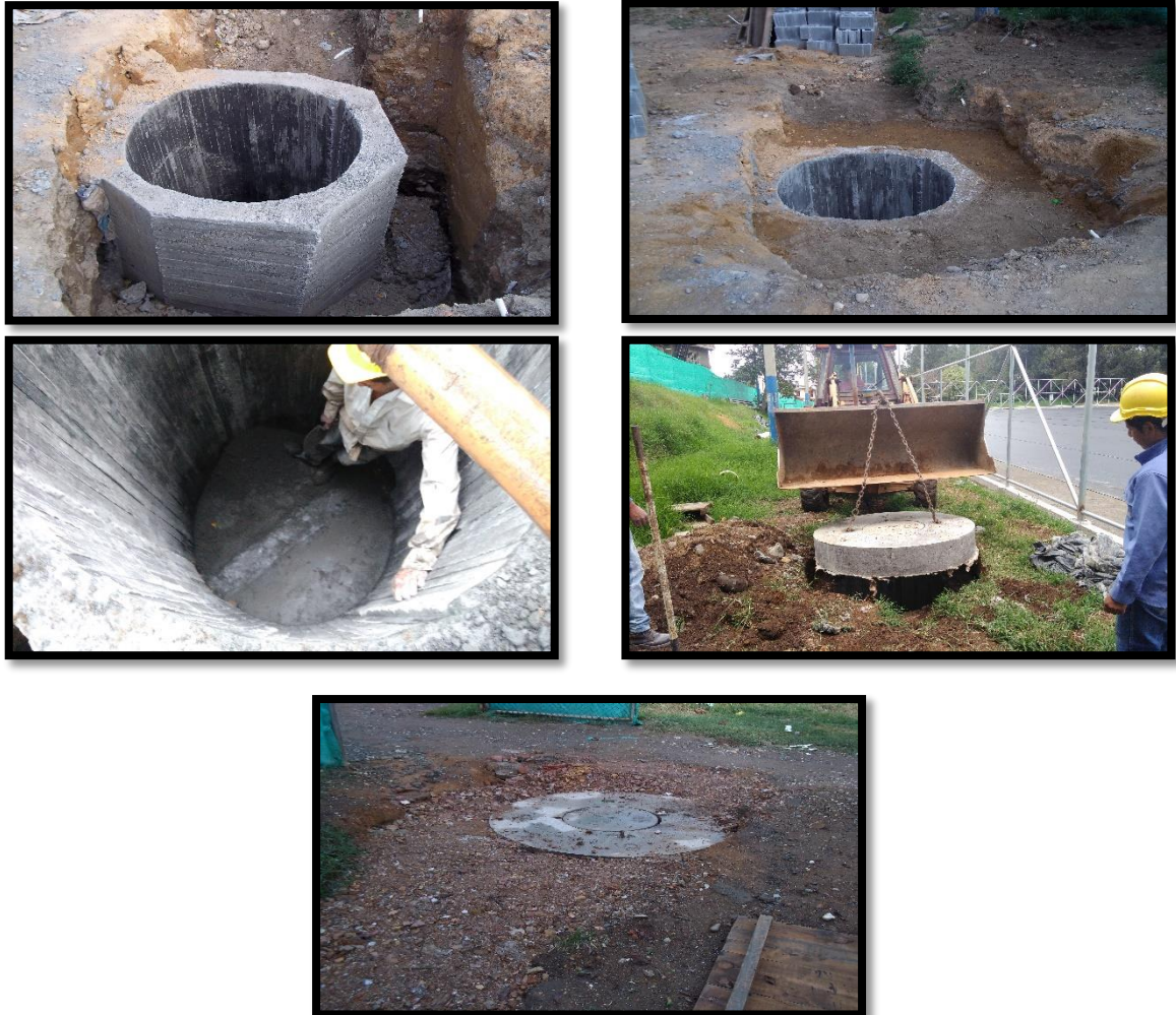
Figura 38. Construcción de Recamaras – Segunda Parte
