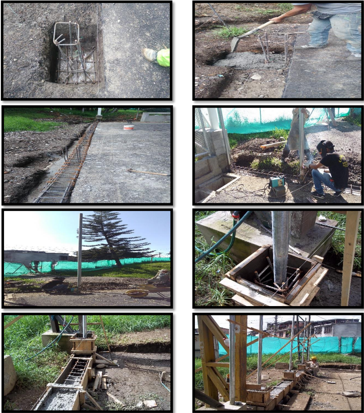
Figura 59. Estructura de Cerramiento Malla Eslabonada Coliseo – Primera Parte
