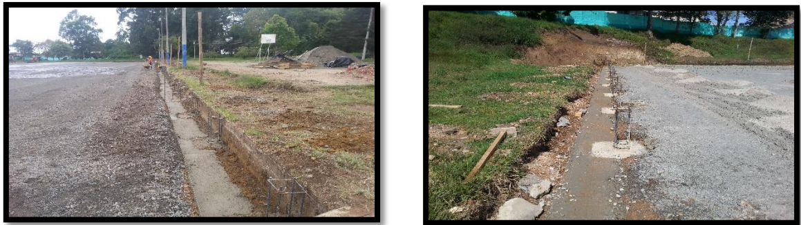
Figura 21. Solados de Limpieza
