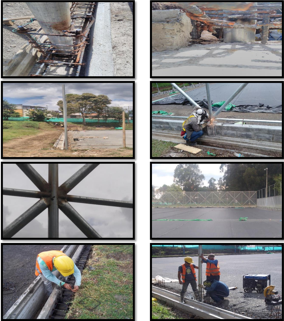
Figura 44. Instalación Malla Eslabonada – Primera Parte
