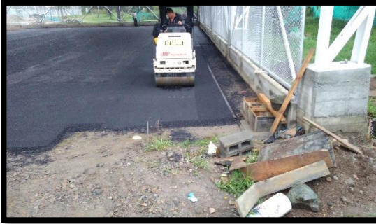
Figura 58. Colocación del Concreto Asfáltico – Tercera Parte
