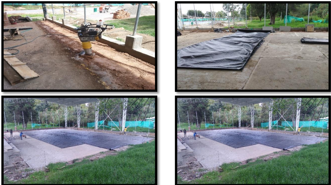
Figura 52. Conformación y Compactación Base Coliseo – Primera Parte
