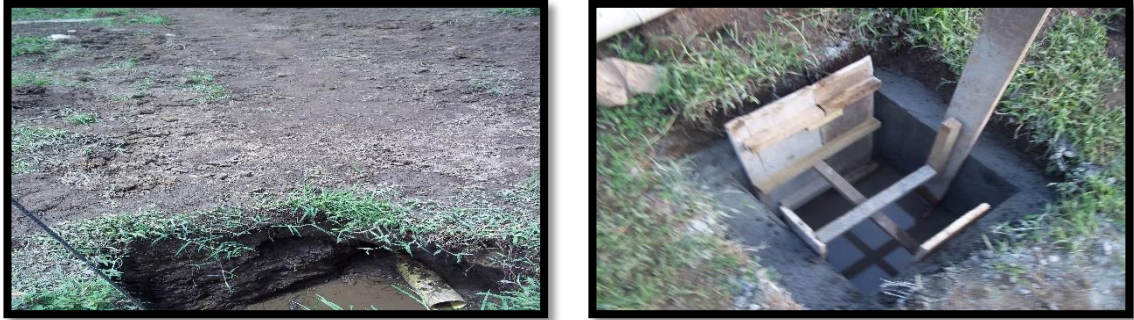
Figura 41. Instalación Tubería PVC 4" para filtro- Segunda Parte
