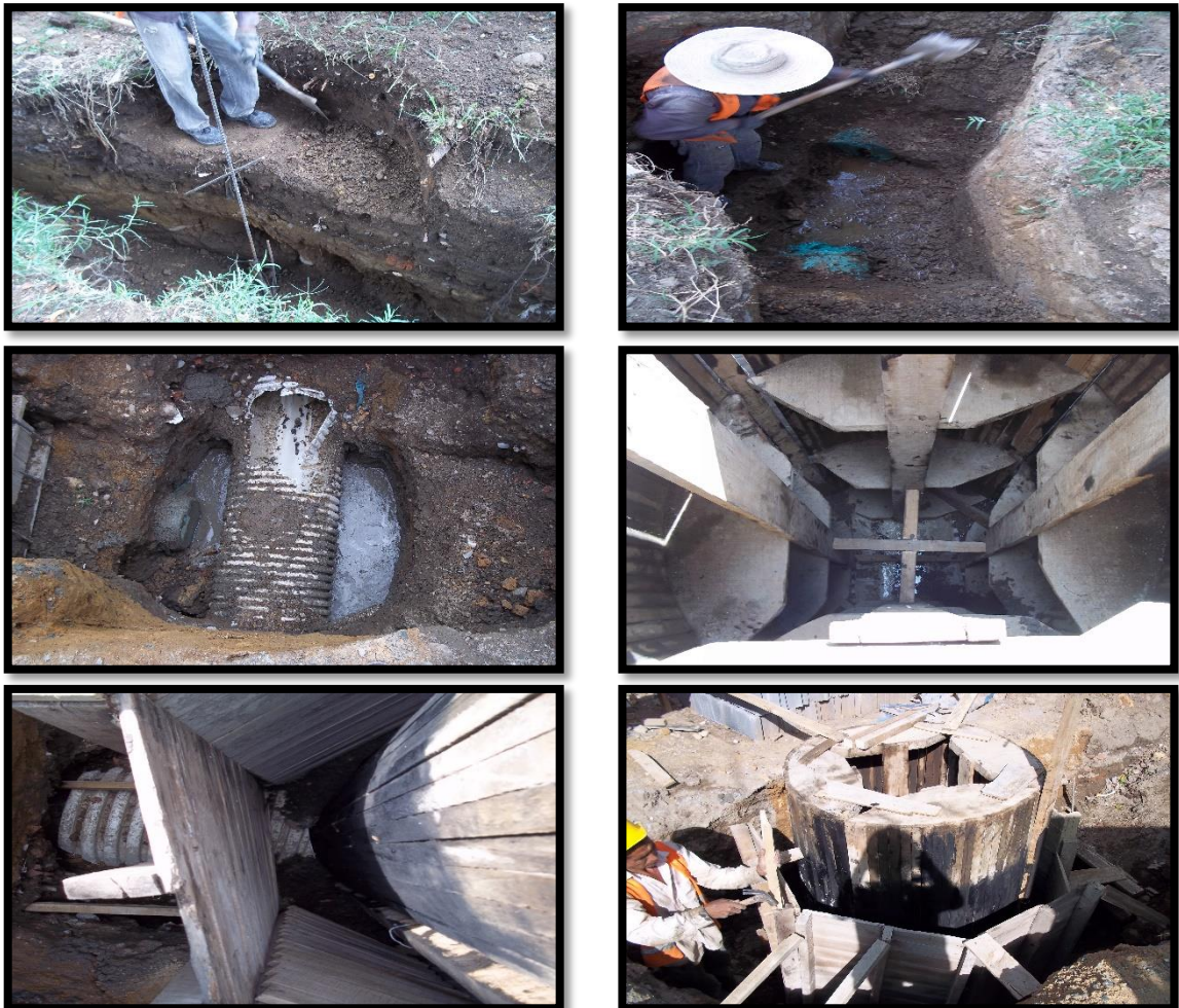
Figura 37. Construcción de Recamaras – Primera Parte
