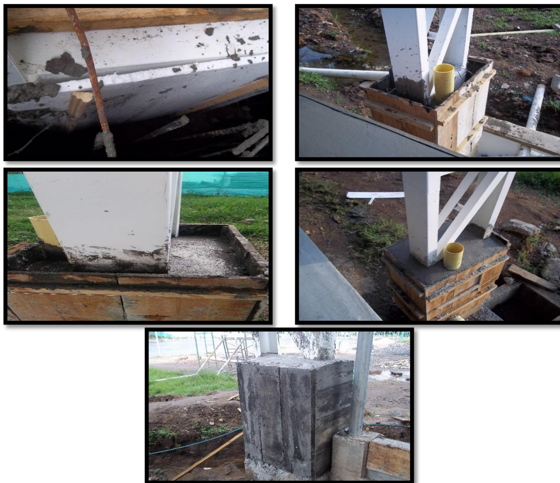
Figura 62. Recubrimiento para Pórtico Estructura Metálica – Segunda Parte
