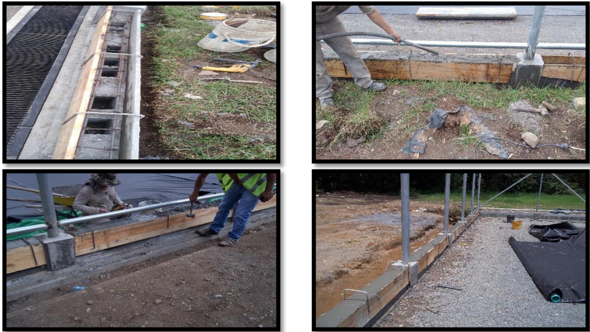
Figura 51. Construcción Viga Cinta – Segunda Parte
