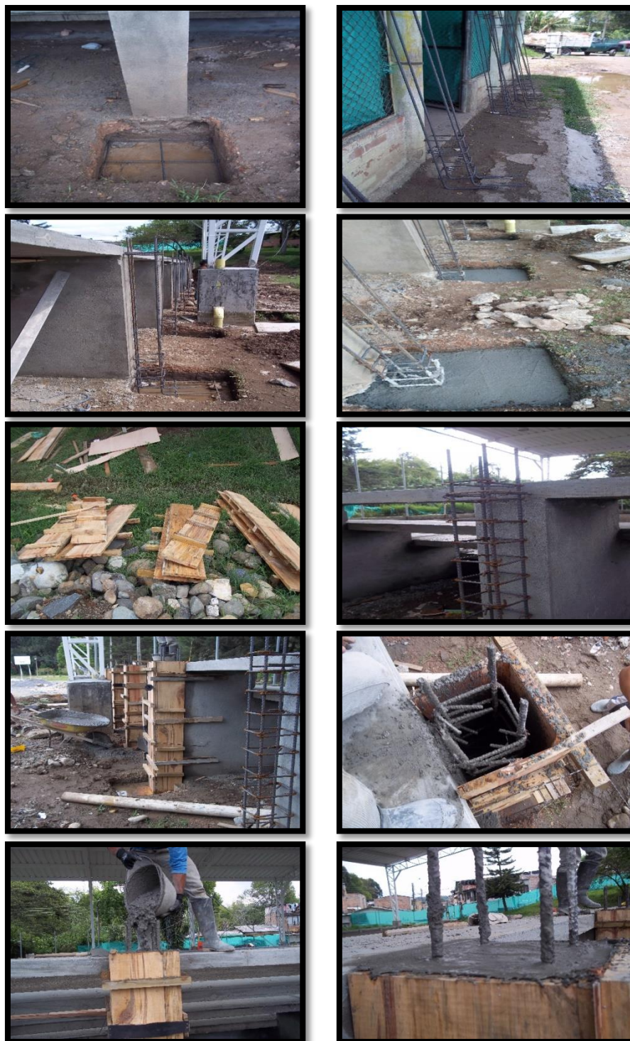
Figura 68. Construcción Zapatas y Columnas para Refuerzo Gradería – Segunda Parte
