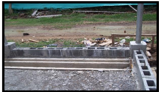
Figura 50. Construcción Viga Cinta – Primera Parte
