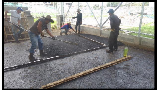
Figura 57. Colocación del Concreto Asfáltico – Segunda Parte
