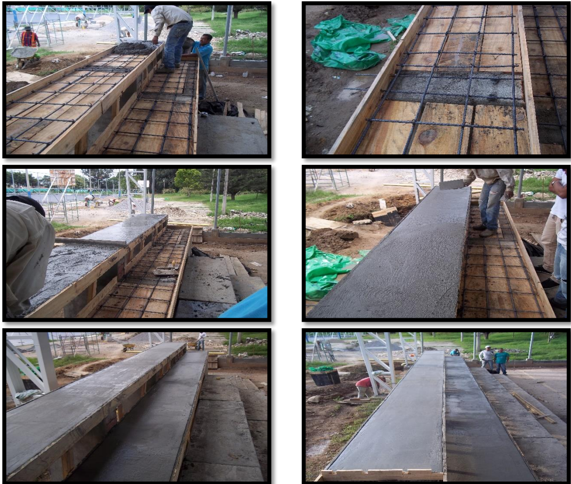
Figura 66. Fundición de Bancas para Reforzar la Gradería del Coliseo
