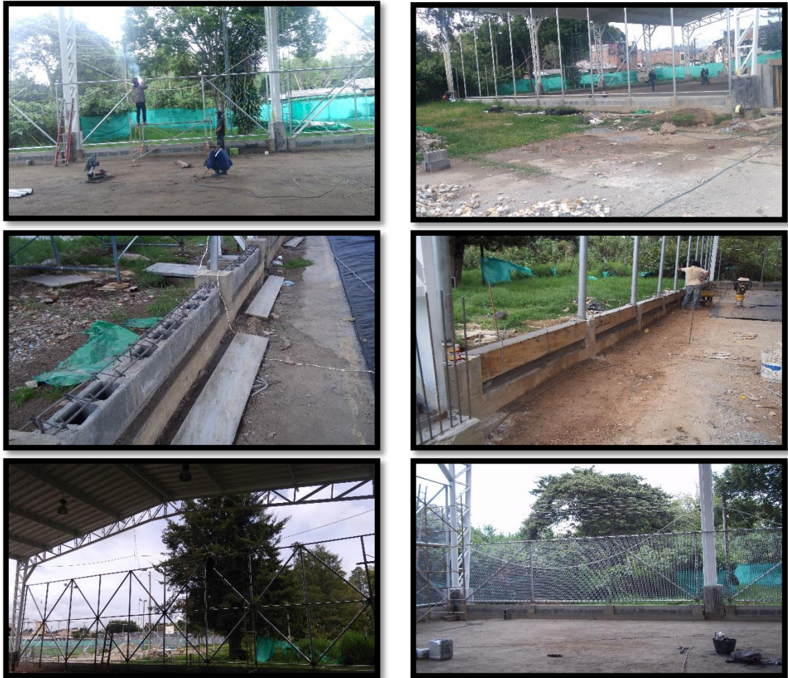
Figura 60. Estructura de Cerramiento Malla Eslabonada Coliseo – Segunda Parte
