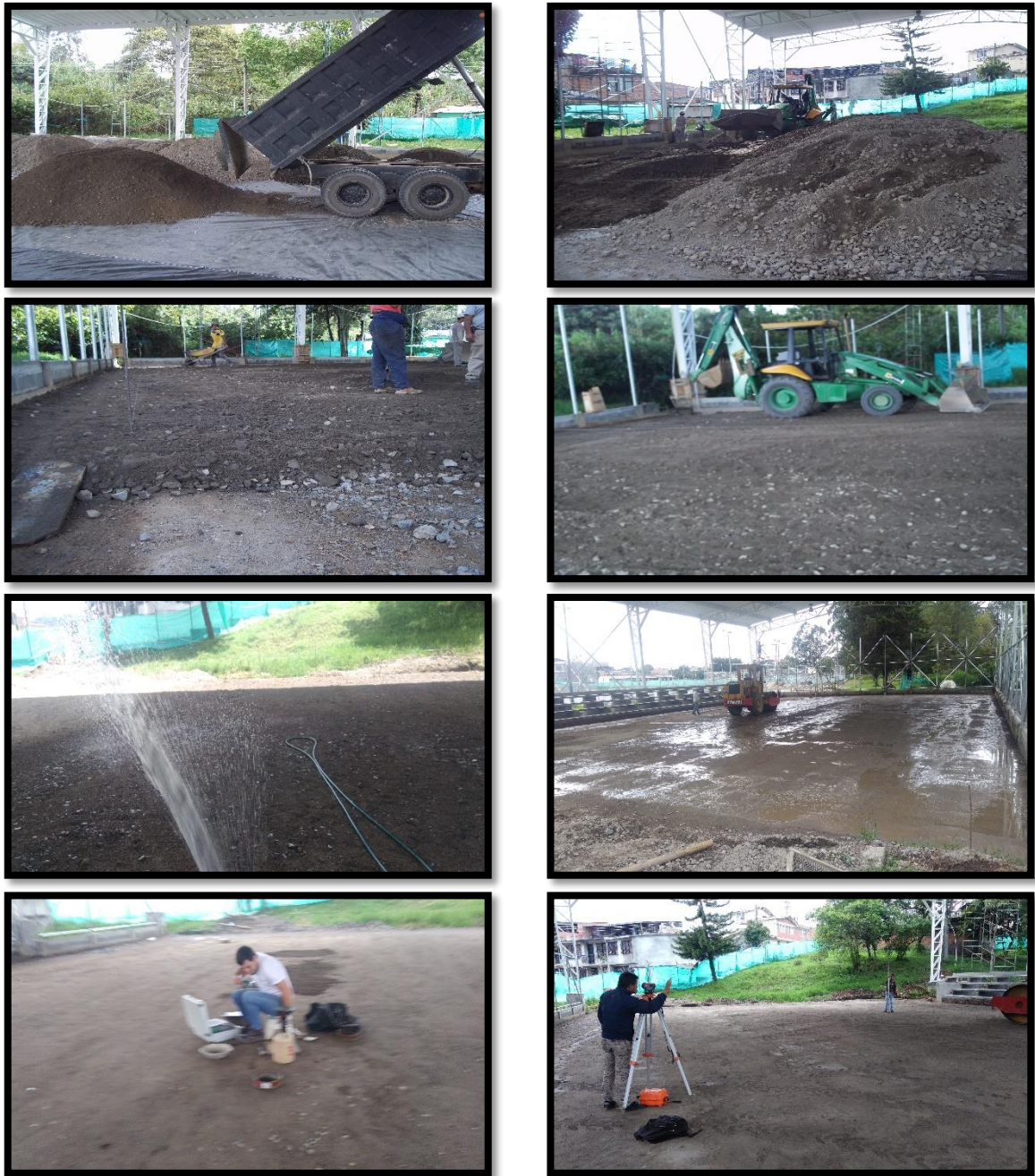
Figura 45: conformación y compactación base coliseo
