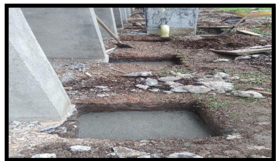
Figura 67. Construcción Zapatas y Columnas para Refuerzo Gradería – Primera Parte
