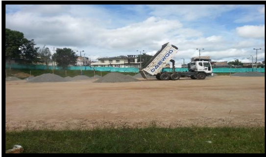
Figura 18. Relleno Base Angula
