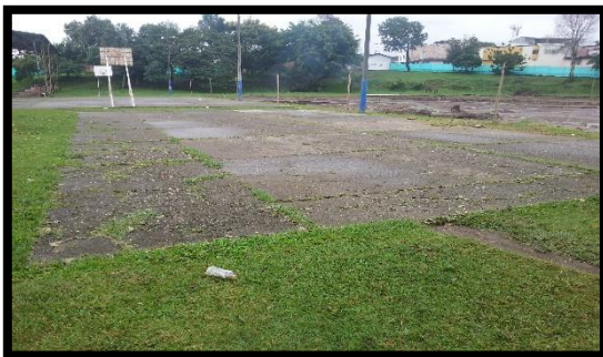
Figura 5. Demolición Placas Existentes
