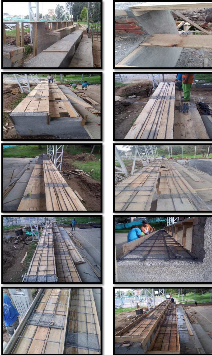
Figura 65. Fundición de Bancas para Reforzar la Gradería del Coliseo – Segunda Parte
