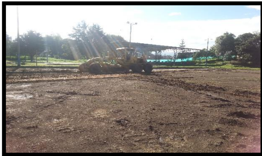
Figura 11. Mejoramiento de Fallas de Subrasante
