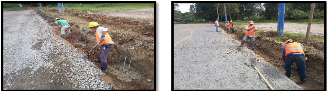
Figura 14. Excavación a mano
