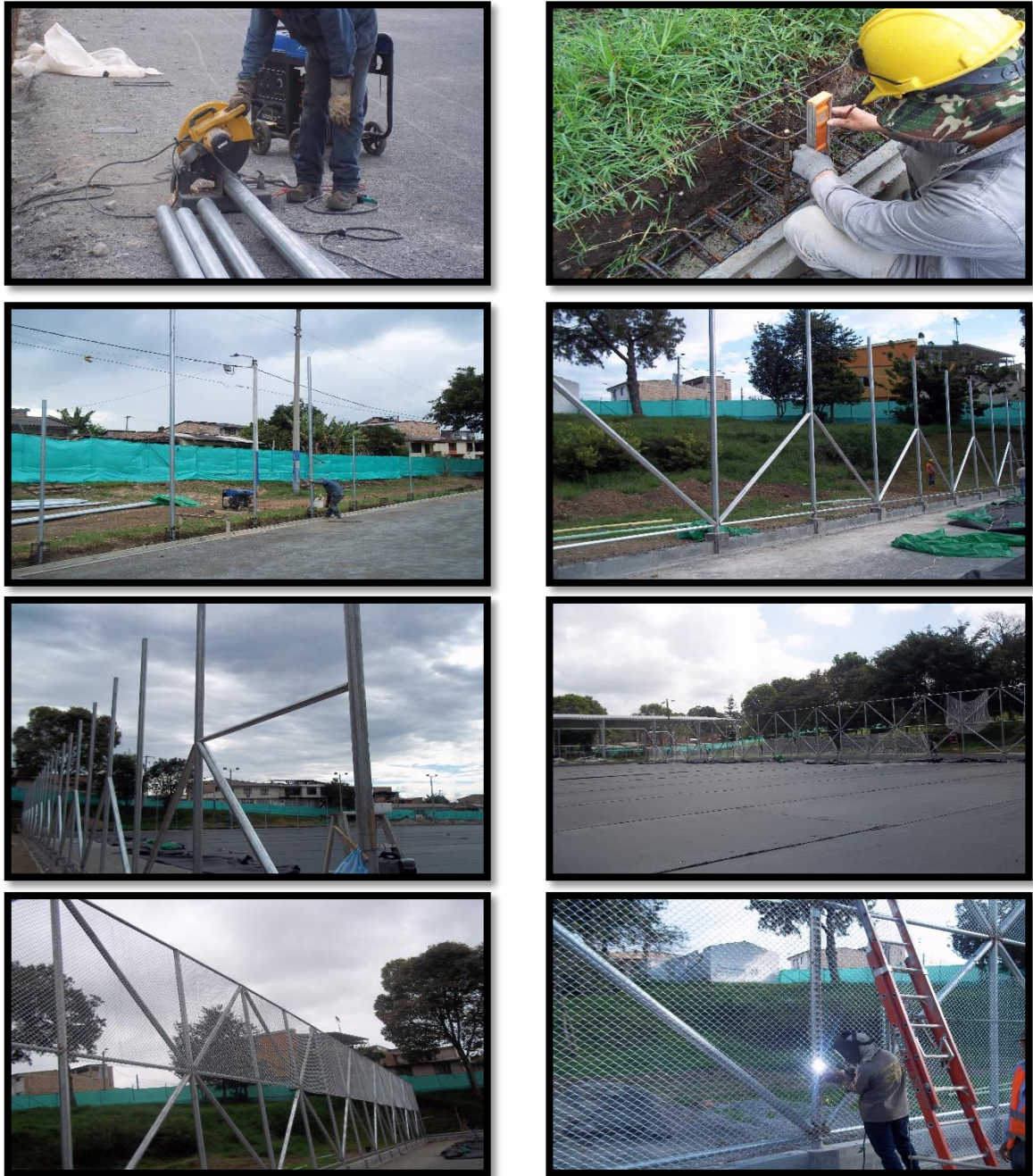
Figura 41: instalación malla eslabonada
