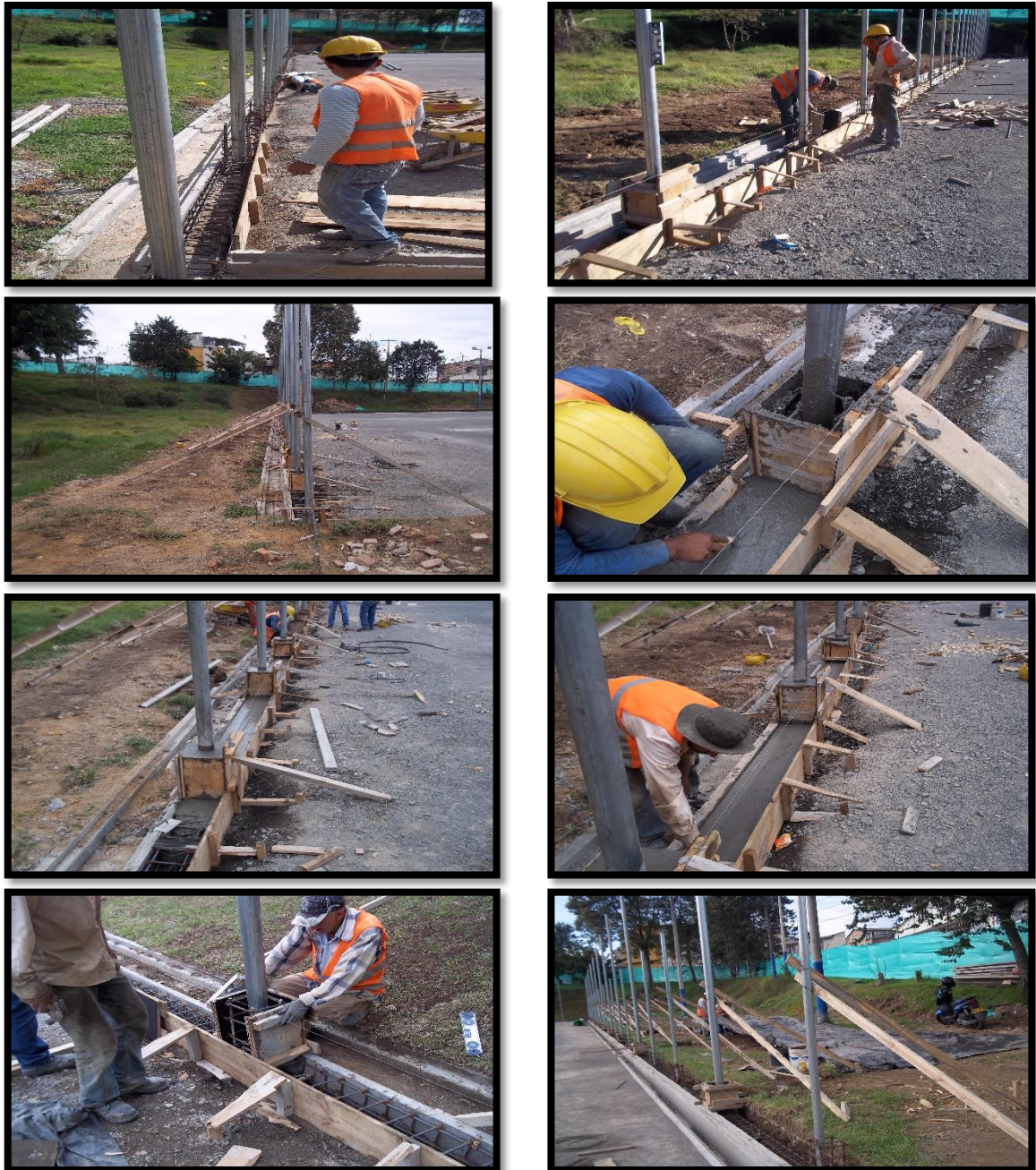
Figura 46. Fundición de Vigas de Amarre y Pedestales de Estructura de Cerramiento – Primera Parte
