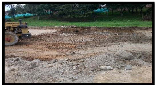
Figura 11. Mejoramiento de Fallas de Subrasante
