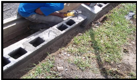
Figura 50. Construcción Viga Cinta – Primera Parte
