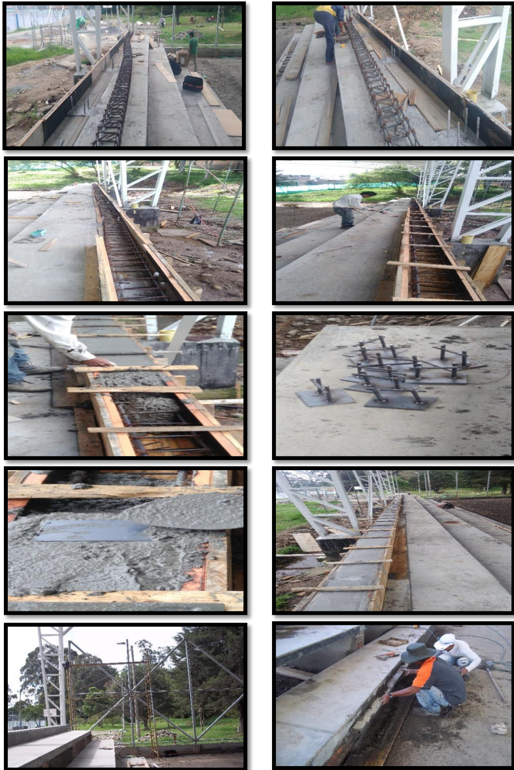
Figura 70. Viga de Amarre, Repello y Baranda Metálica para Gradería – Primera Parte
