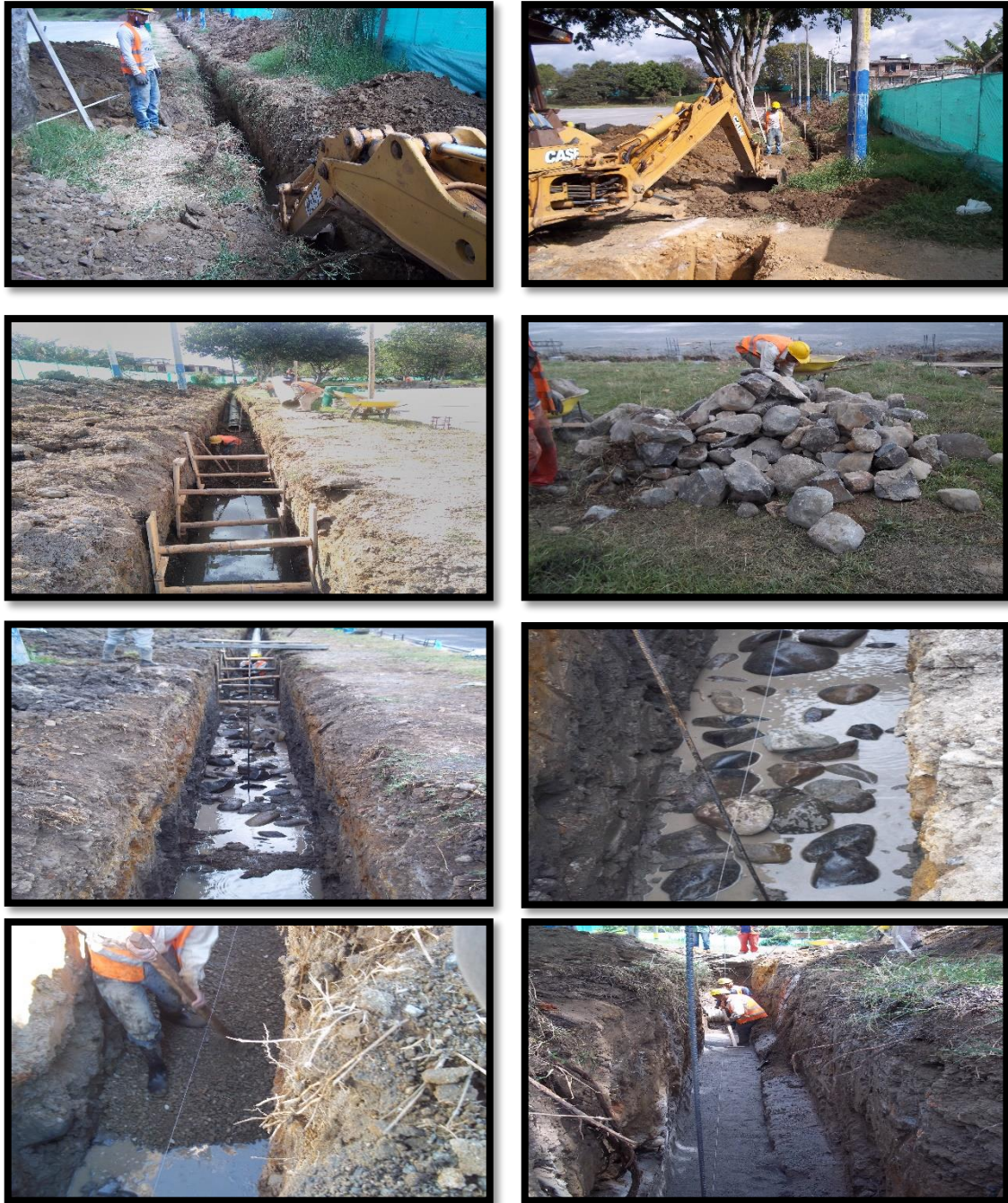
Figura 35. Instalación Tubería Sanitaria de 16" Primera Parte
