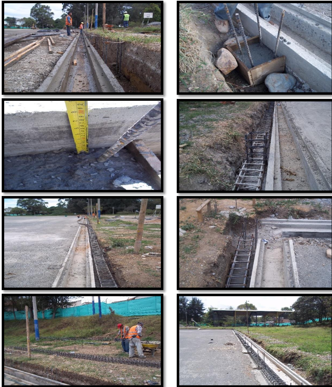
Figura 43. Instalación Viga Estructura de Cerramiento
