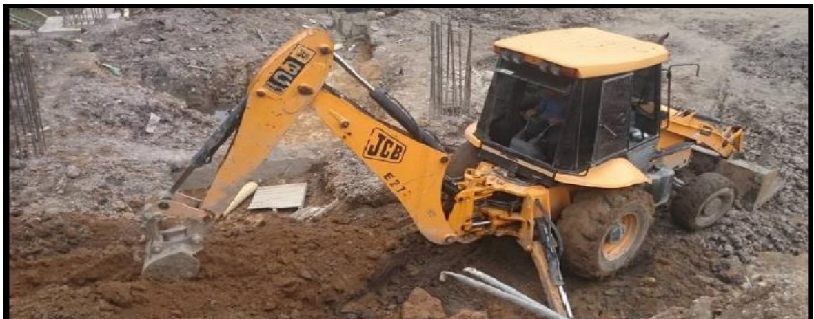
Figura 33. Retroexcavadora trabajando en la excavación. (Fuente: Propia)
