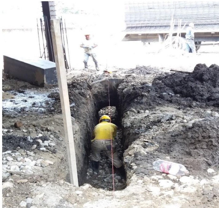
Figura 22. Colocación de cama de piedra sucia. (Fuente: Propia)
