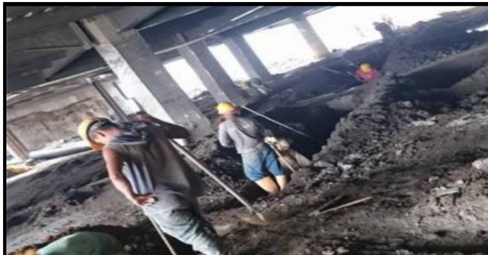
Figura 34. Cuadrilla trabajando en la excavación para las redes de desagüe. (Fuente: Propia)
