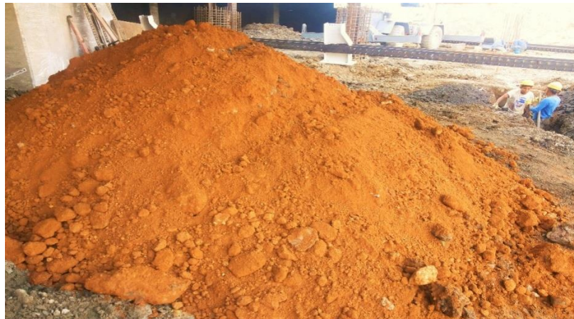
Figura 28. Material de relleno, tierra amarilla utilizada para la compactación. (Fuente: Propia)
