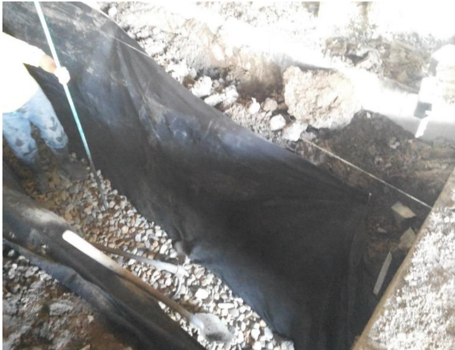
Figura 24. Colocación del material de filtro en la zanja (Fuente: Propia)
