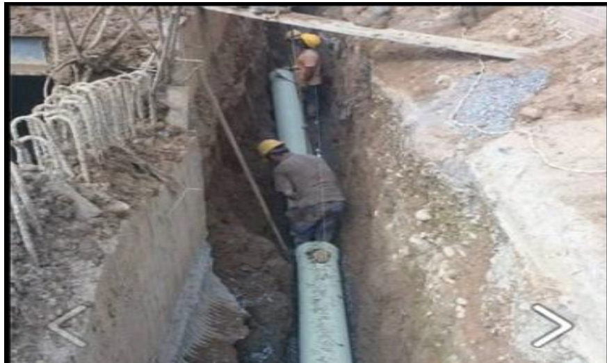
Figura 36. Instalación de tubería. (Fuente: Propia)
