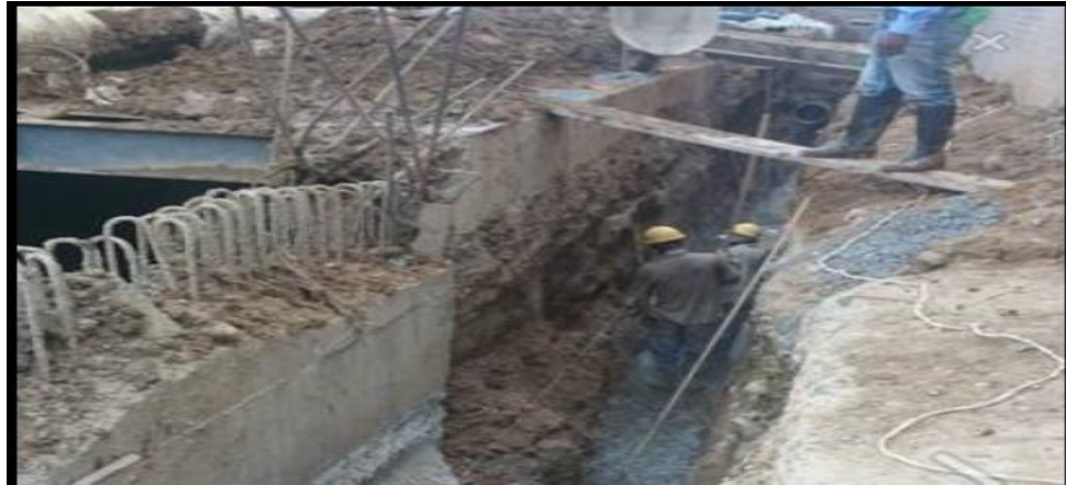
Figura 35. Instalación del colchón de arena o mixto para la tubería. (Fuente: Propia)
