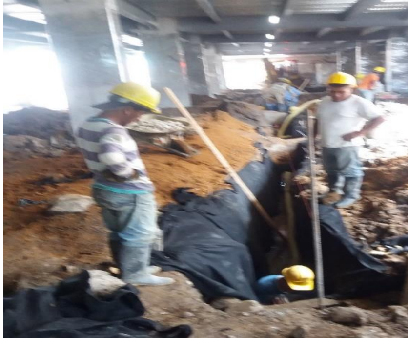
Figura 23. Geotextil drenante no tejido instalado (Fuente: Propia).
