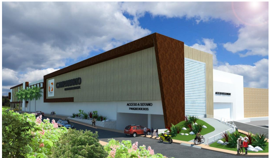
Figura 2. Fachada calle 20 (Fuente: Diseño Arquitectónico ARINSA)
