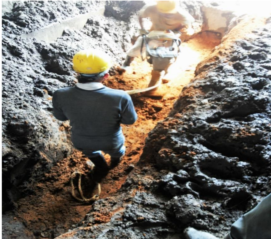
Figura 29. Compactación del material de relleno con el saltarín. (Fuente: Propia)
