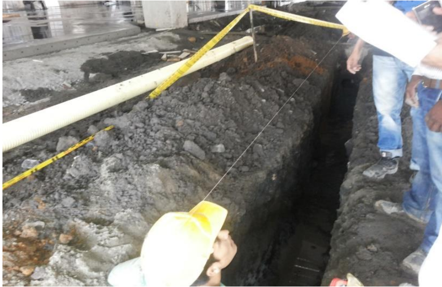
Figura 21. Utilización de hilo para la perfilación. (Fuente: Propia)
