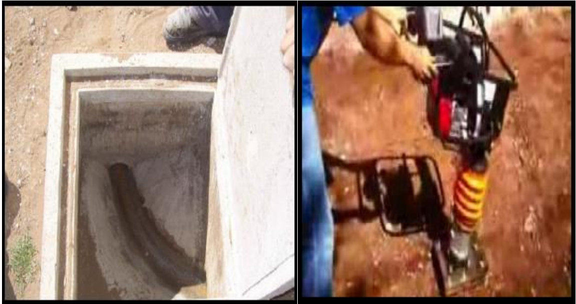
Figura 37. Terminado de cajas de inspección. (Fuente: Propia)
