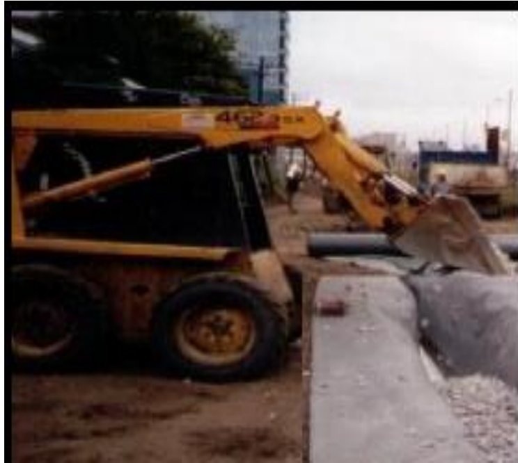
Figura 25. Colocación del material de filtro con el Bobcat. (Fuente: Propia)
