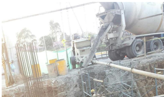
Fotografía 57. Bomba estacionaria de concreto. Fuente: Tomada por el pasante
