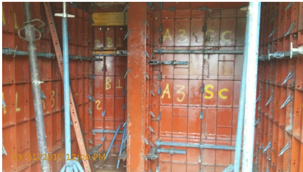
Fotografía 20. Armado completo de alcoba del apartamento. Fuente: Tomada por el pasante
