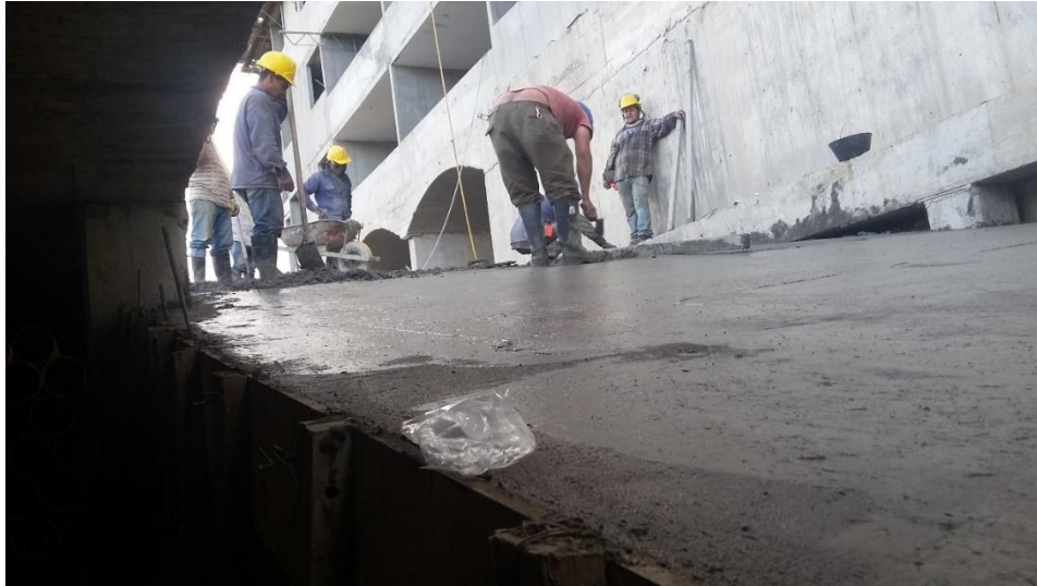
Fotografía 52. Nivelación de la rampa después de vaciar el concreto en su totalidad Fuente: Tomada por el pasante
