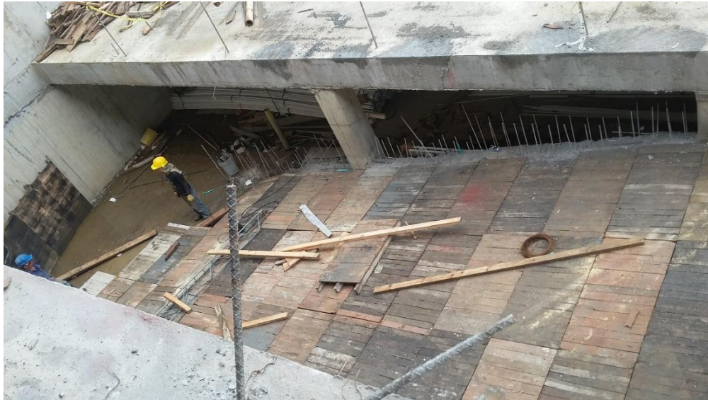
Fotografía 46. Toma de peraltes en la rampa de acceso al parqueadero posterior Fuente: Tomada por el pasante
