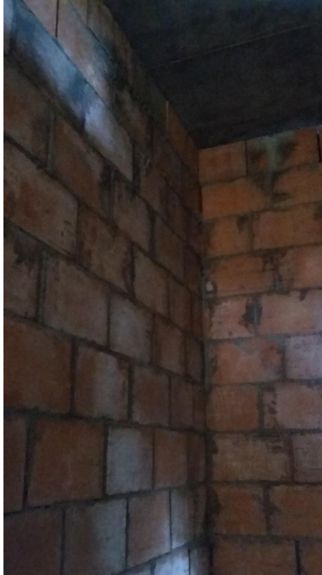
Fotografía 42. Construcción de muros en primer piso. Fuente: Tomada por el pasante
