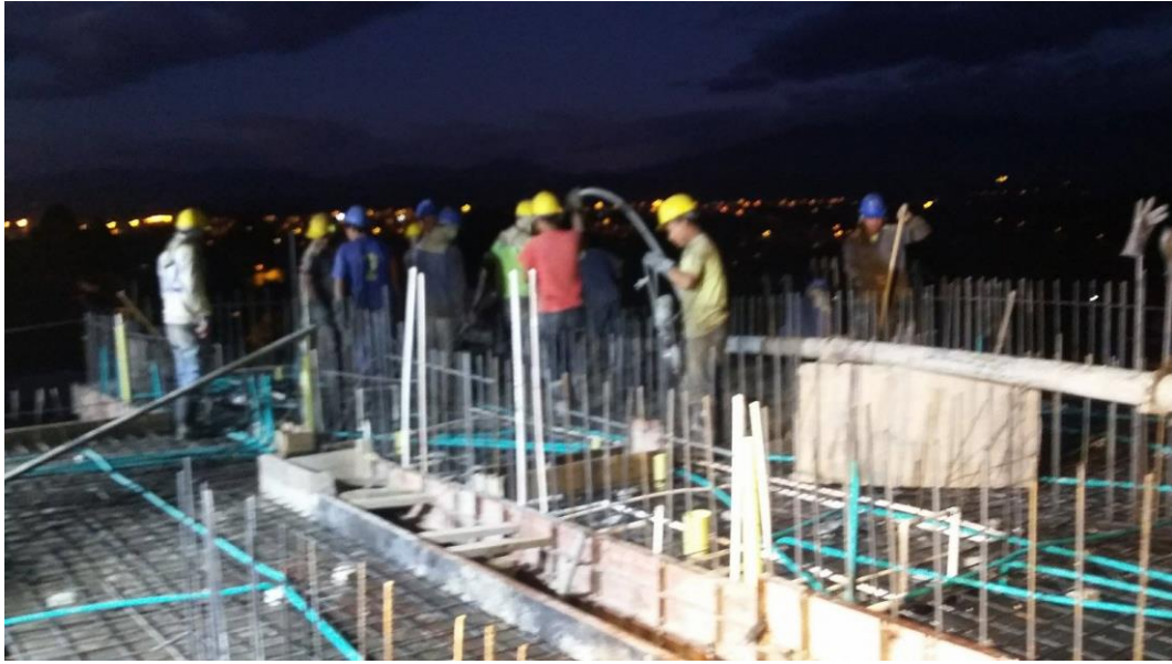
Fotografía 58. Fundición del apto 3 del 5to piso. Fuente: Tomada por el pasante
