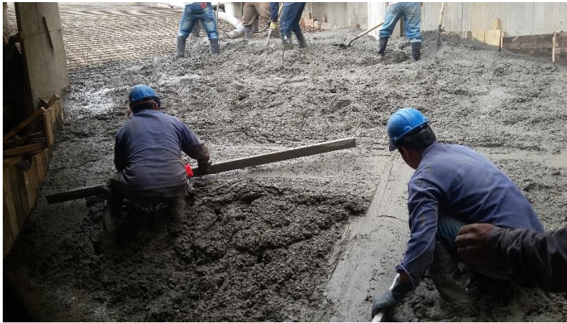
Fotografía 49. Vaciado del concreto en la rampa Fuente: Tomada por el pasante
