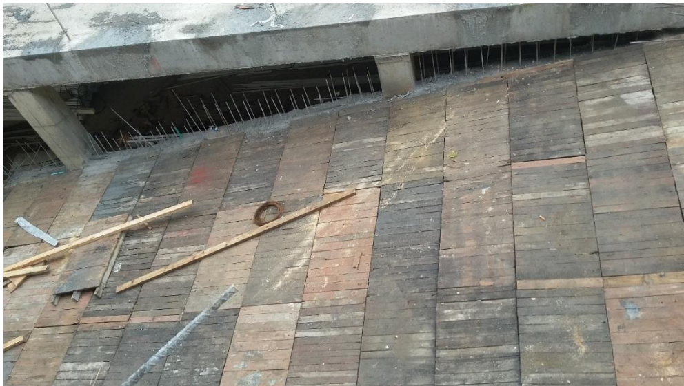
Fotografía 45. Formaleta de rampa del sótano Fuente: Tomada por el pasante
