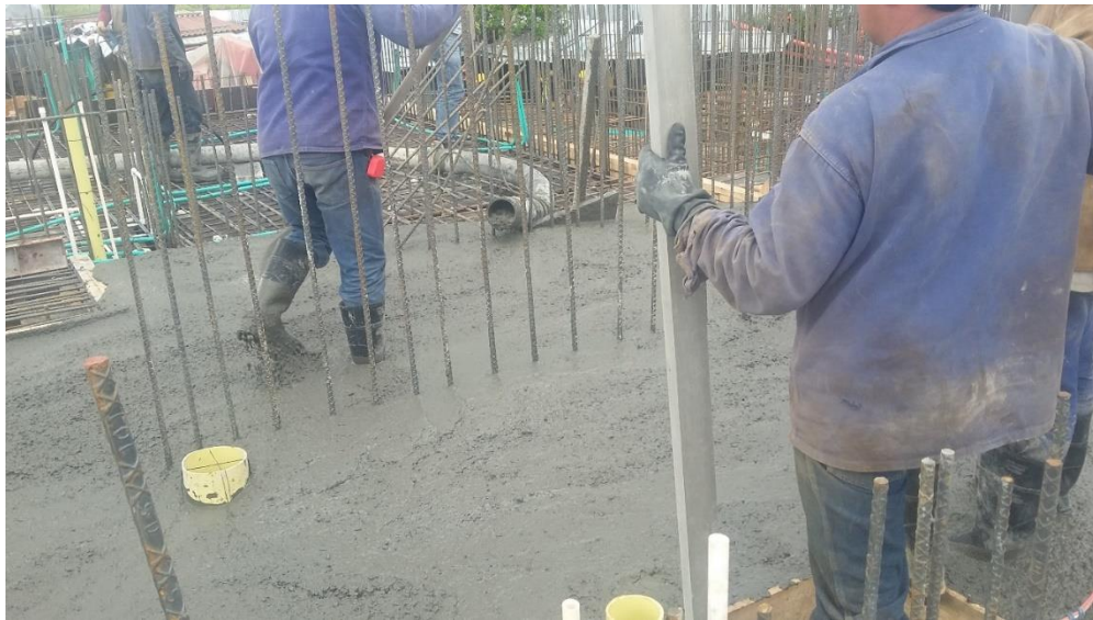
Fotografía 28. Fundición del apto 2. Fuente: Tomada por el pasante
