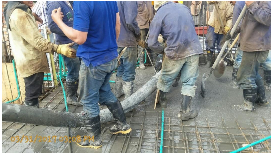
Fotografía 25. Fundición del primer apartamento. Fuente: Tomada por el pasante
