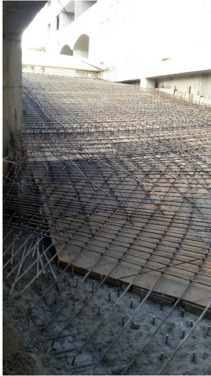
Fotografía 48. Rampa completamente armada para fundir Fuente: Tomada por el pasante
