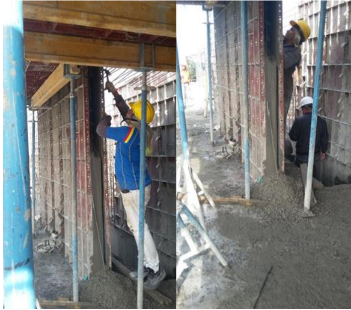
Fotografía 59. Desencofrado de uno de los muros del apto fundido. Fuente: Tomada por el pasante
