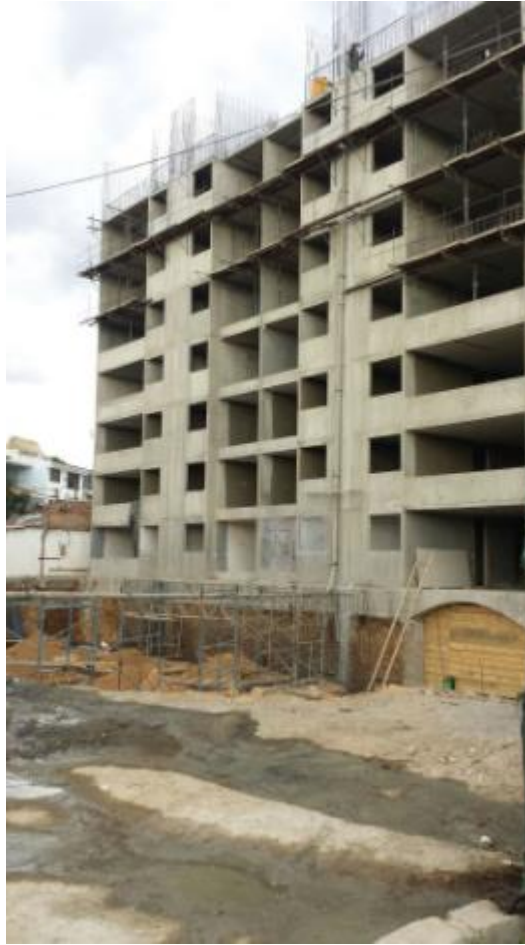
Fotografía 64. Séptimo piso fundido en su totalidad. Fuente: Tomada por el pasante
