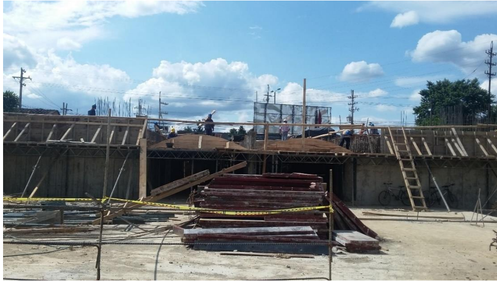
Fotografía 8. Vista posterior del armado de la formaleta. Fuente: Tomada por el pasante
