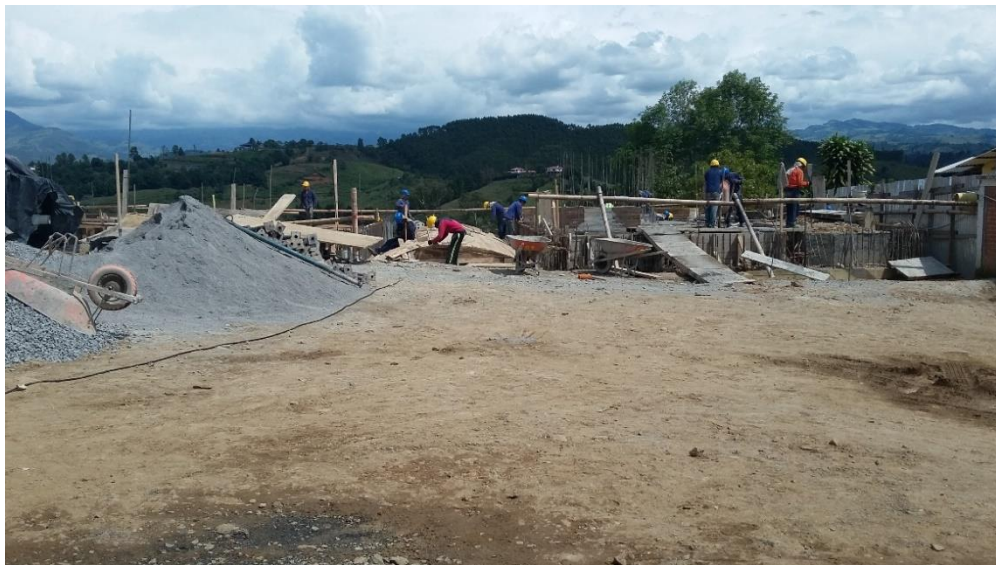
Fotografía 7. Ubicación y amarre de la formaleta. Fuente: Tomada por el pasante
