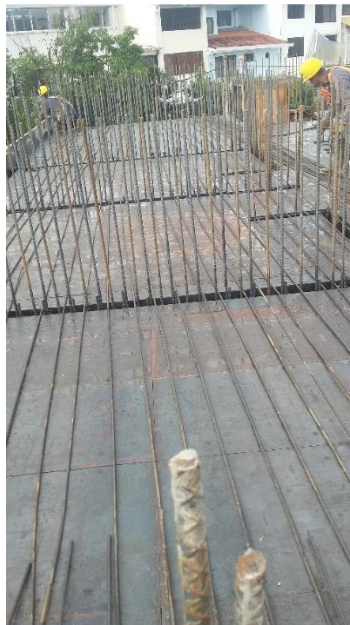
Fotografía 26. Formaleta de losa lista para extender el refuerzo del apto 2. Fuente: Tomada por el pasante
