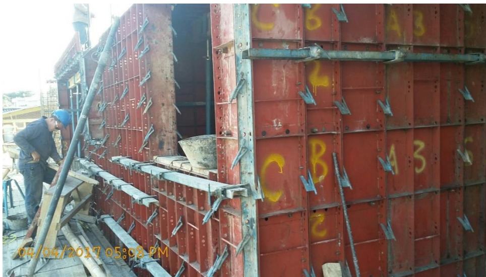
Fotografía 22. Vista frontal de la formaleta armada totalmente Fuente: Tomada por el pasante
