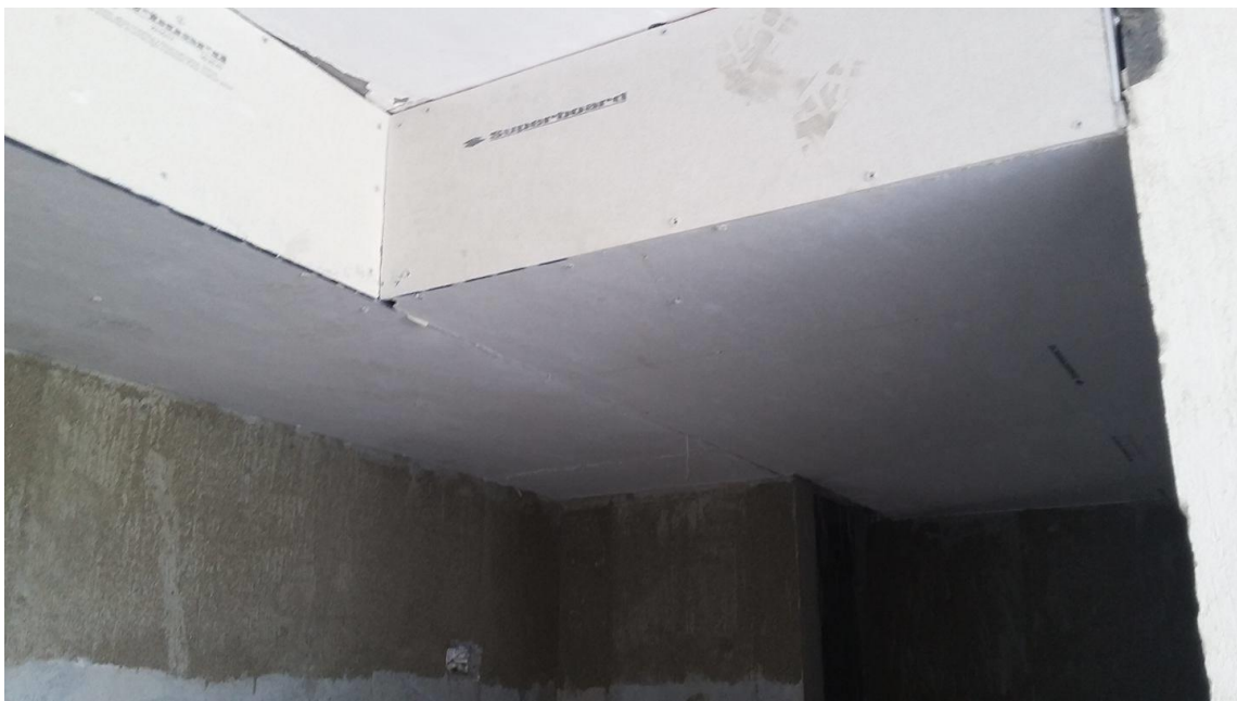
Fotografía 63. Superboard instalado sobre la cocina. Fuente: Tomada por el pasante
