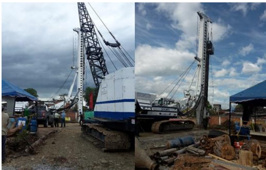
Fotografía 1. Maquina piloteadora en obra. Fuente: Tomada por el ingeniero residente
