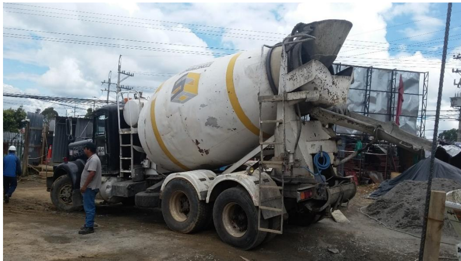
Fotografía 14. Llegada del concreto a la obra. Fuente: Tomada por el pasante
