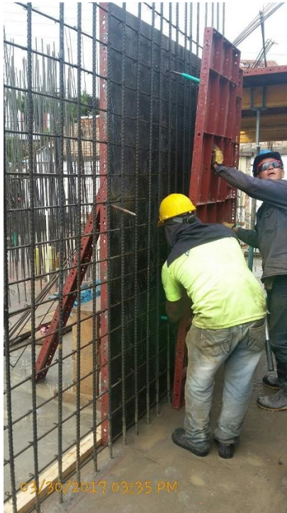
Fotografía 18. Ubicación de formaleta del apartamento1. Fuente: Tomada por el pasante
