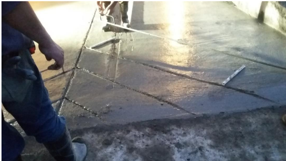
Fotografía 53. Demarcación de la rampa una vez nivelada totalmente Fuente: Tomada por el pasante
