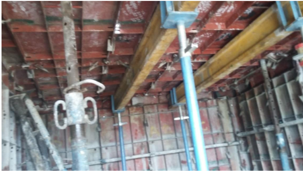
Fotografía 38. Vista inferior de formaleta de losa. Fuente: Tomada por el pasante
