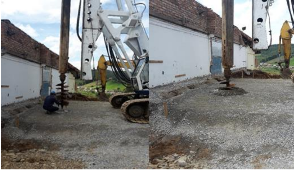
Fotografía 2. Maquina piloteadora empieza a perforar. Fuente: Tomada por el ingeniero residente
