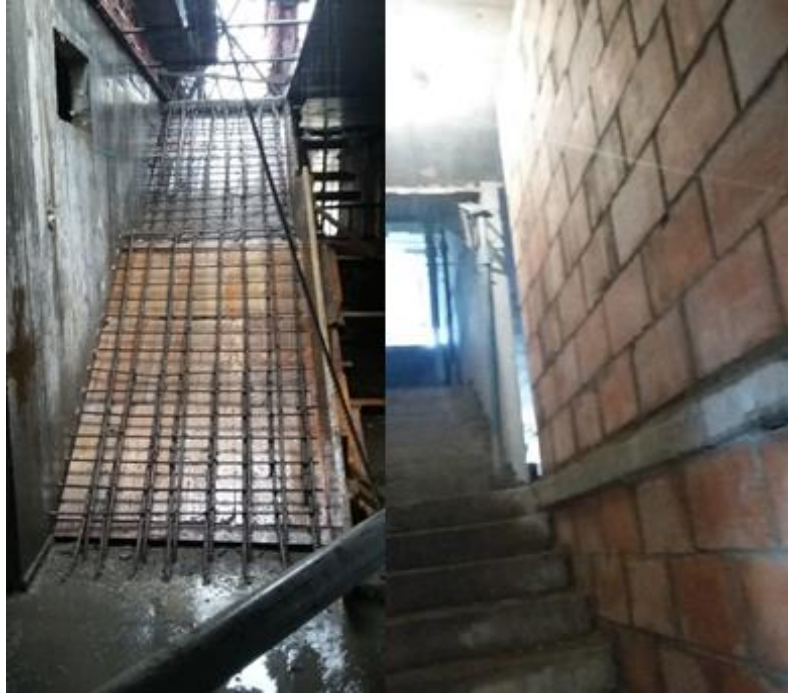
Fotografía 43. Escaleras fundidas con muros. Fuente: Tomada por el pasante
