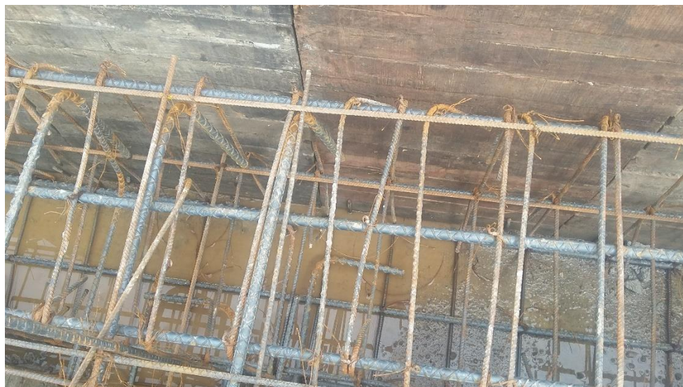
Fotografía 13. Armado del refuerzo de una de las vigas. Fuente: Tomada por el pasante
