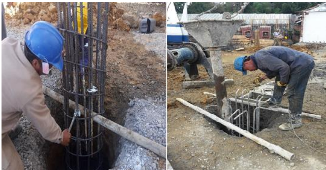
Fotografía 5. Armado de los pilotes. Fuente: Tomada por el ingeniero residente
