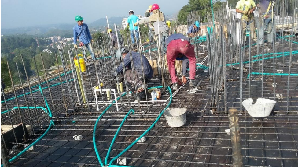
Fotografía 40. Instalaciones hidráulicas y eléctricas para la fundición del 4to piso. Fuente: Tomada por el pasante
