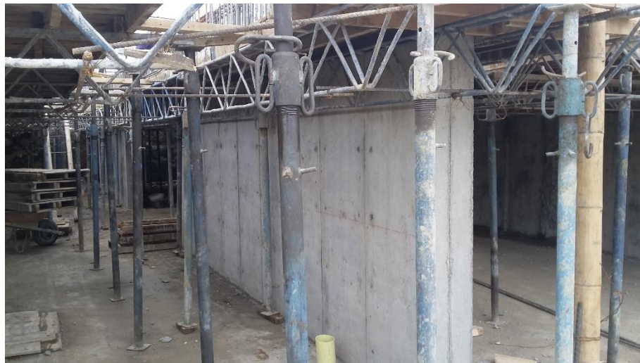
Fotografía 9. Vista interior de la ubicación de tacos, cerchas y tableros. Fuente: Tomada por el pasante
