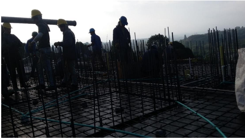
Fotografía 35. Instalación de la tubería para el vaciado del concreto. Fuente: Tomada por el pasante
