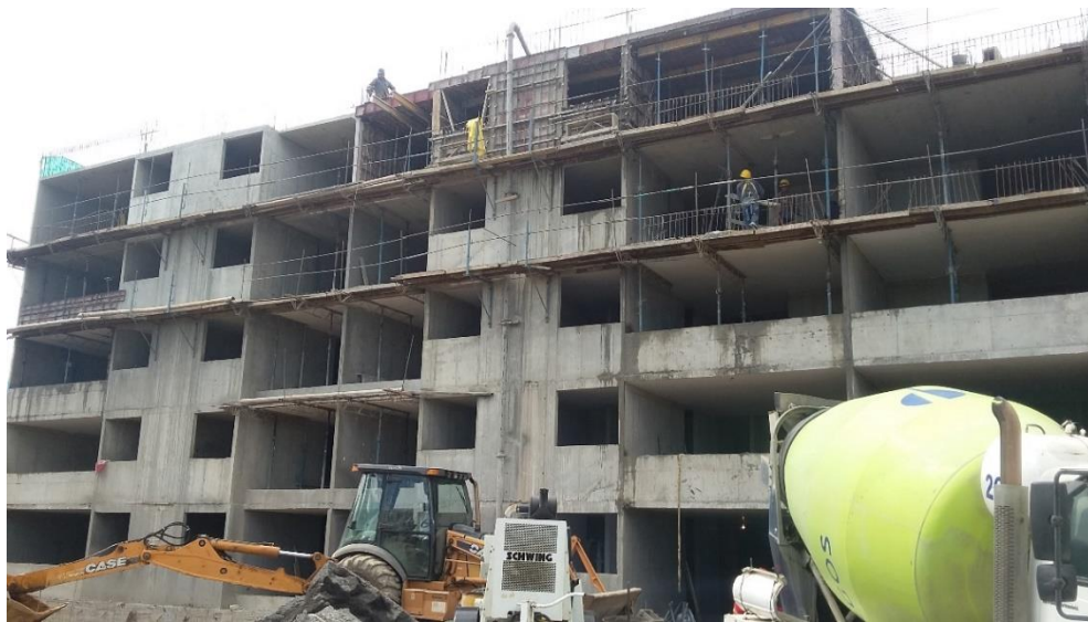
Fotografía 55. Vista frontal del edificio (5to piso). Fuente: Tomada por el pasante
