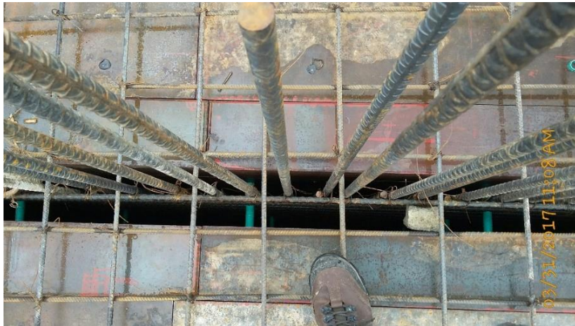
Fotografía 24. Ubicación del refuerzo sobre el muro antes de la fundición. Fuente: Tomada por el pasante.
