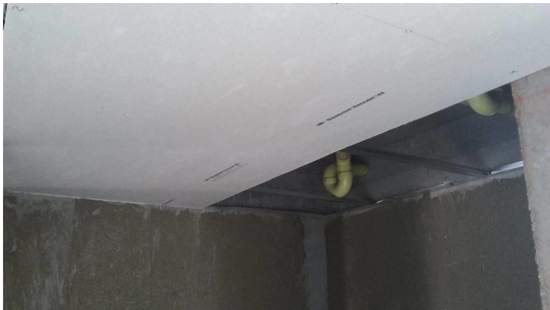
Fotografía 62. Instalación de superboard como cielo de los baños y cocina. Fuente: Tomada por el pasante
