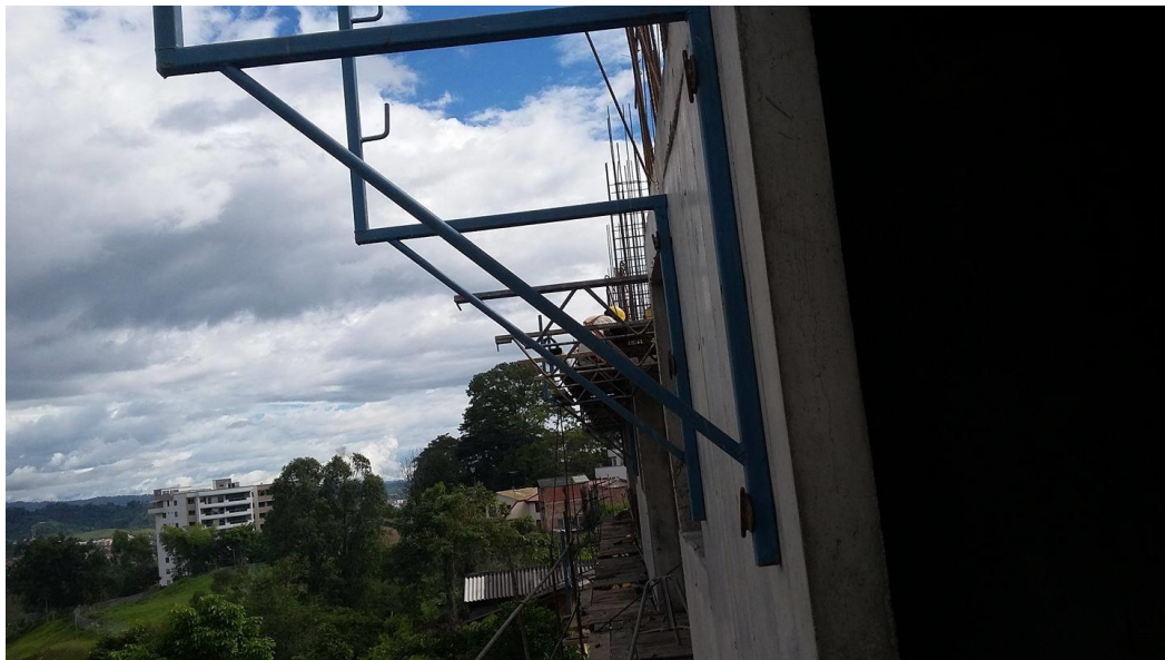
Fotografía 29. Vista de palomeras amarradas al apto1. Fuente: Tomada por el pasante
