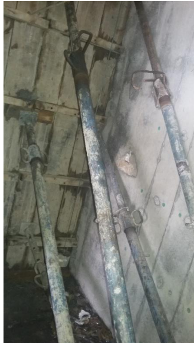
Fotografía 32. Vista inferior de la formaleta de escaleras. Fuente: Tomada por el pasante
