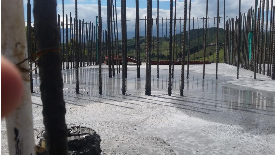
Fotografía 16. Vista de la losa fundida. Fuente: Tomada por el pasante
