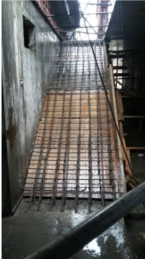
Fotografía 31. Refuerzo de las escaleras. Fuente: Tomada por el pasante
