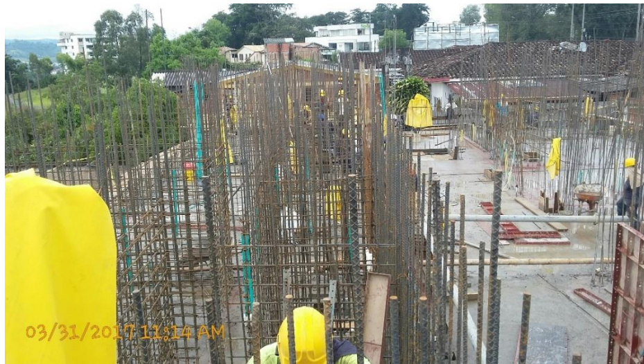
Fotografía 17. Armado de refuerzo del apartamento1. Fuente: Tomada por el pasante
