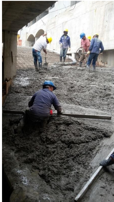
Fotografía 50. Vibrado de la concreto en la rampa Fuente: Tomada por el pasante
