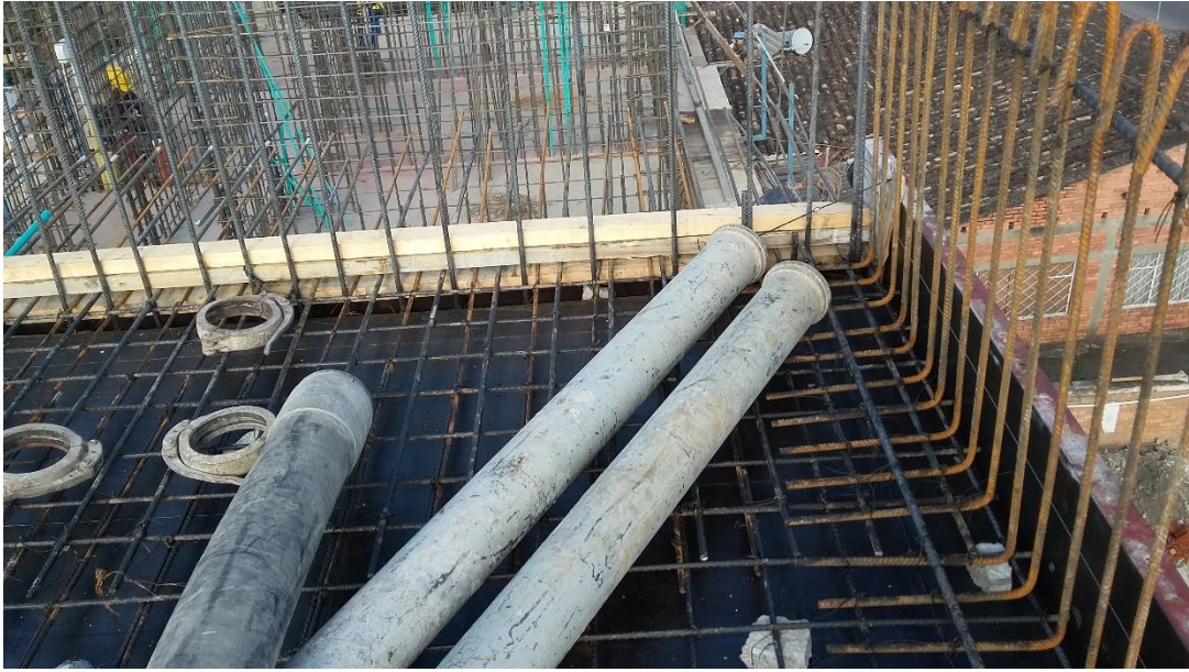
Fotografía 34. Tubería para el vaciado del concreto. Fuente: Tomada por el pasante
