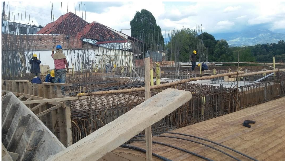
Fotografía 11. Armado del refuerzo. Fuente: Tomada por el pasante
