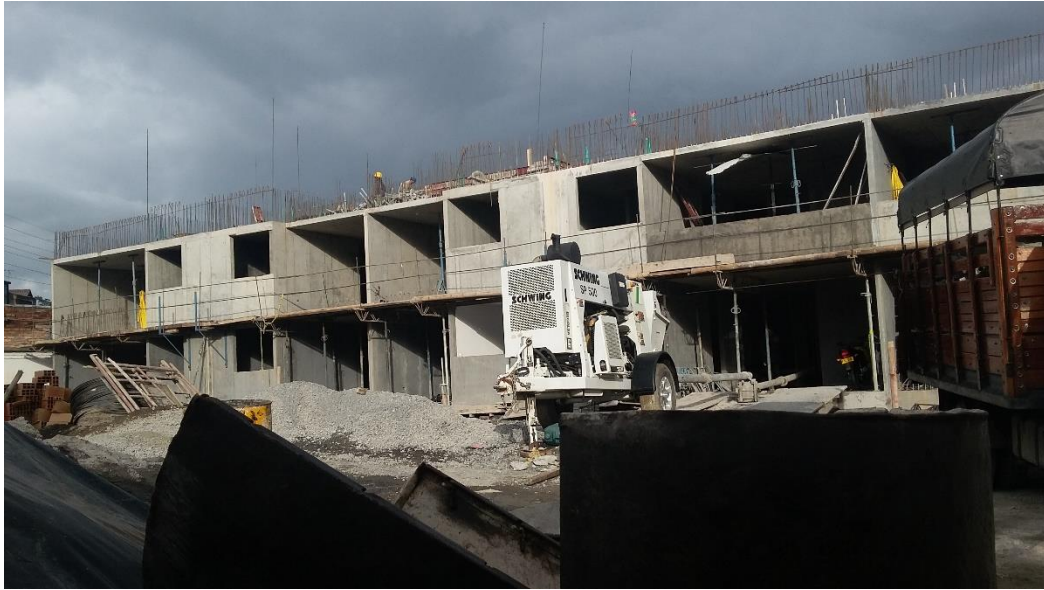
Fotografía 36. Vista frontal de dos pisos fundidos en su totalidad. Fuente: Tomada por el pasante
