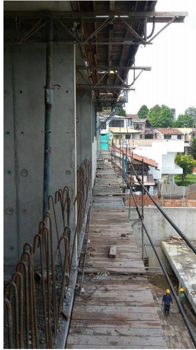
Fotografía 30. Tableros usados sobre las palomeras. Fuente: Tomada por el pasante
