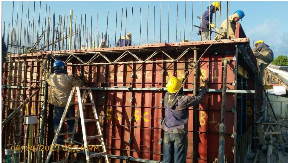
Fotografía 21. Vista posterior del Armado de la formaleta. Fuente: Tomada por el pasante
