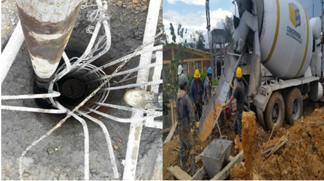
Fotografía 6. Vaciado del concreto en los pilotes. Fuente: Tomada por el ingeniero residente
