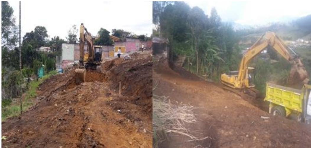
Fotografía 3. Se procede a la excavación de material. Fuente: Tomada por el ingeniero residente
